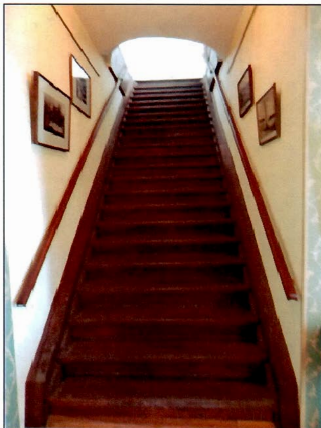
43. Внутрискенная деревянная лестница в уровне четвертого этажа.
