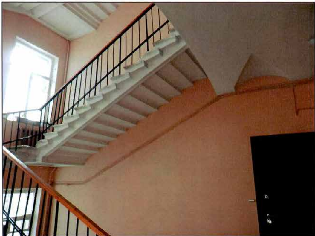
34. Подъезд № 7. Лестница. Общий вид.
