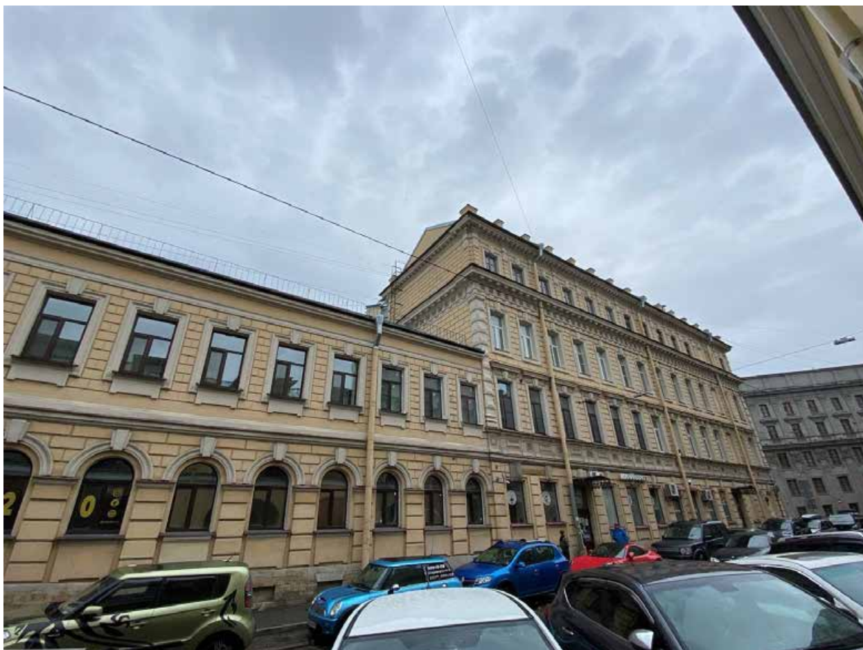
8. Здание по адресу: Санкт-Петербург, Биржевой переулок, д. 1/10, Лит. А. Фрагмент лицевого фасада со стороны Биржевого переуллка
