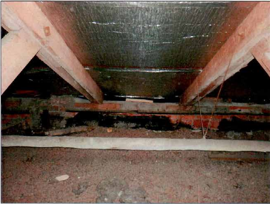
26. Стропильная система. Фрагмент.
