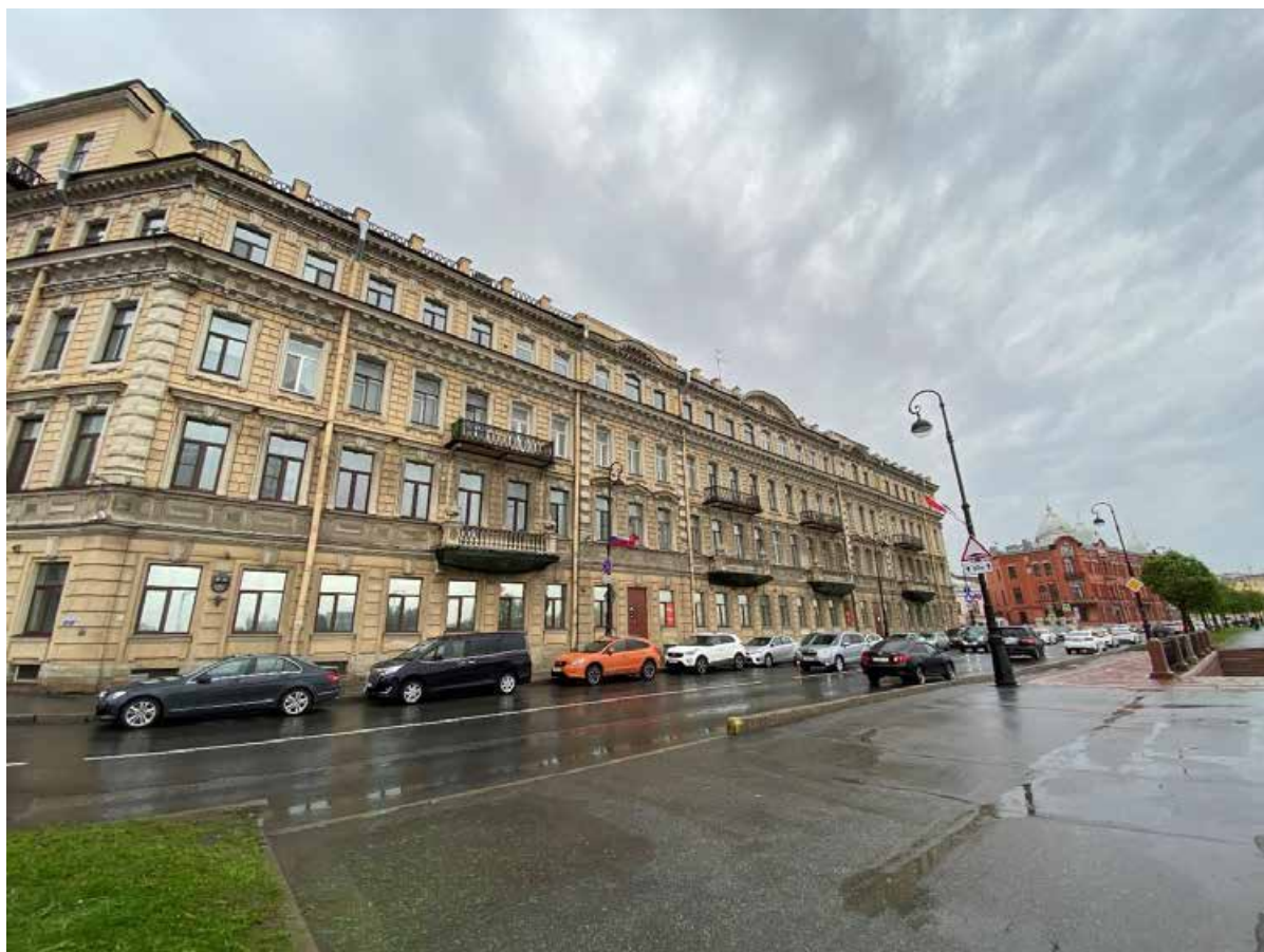
4. Здание по адресу: Санкт-Петербург, Биржевой переулок, д. 1/10, Лит. А. Общий вид лицевого фасада со стороны набережной Макарова
