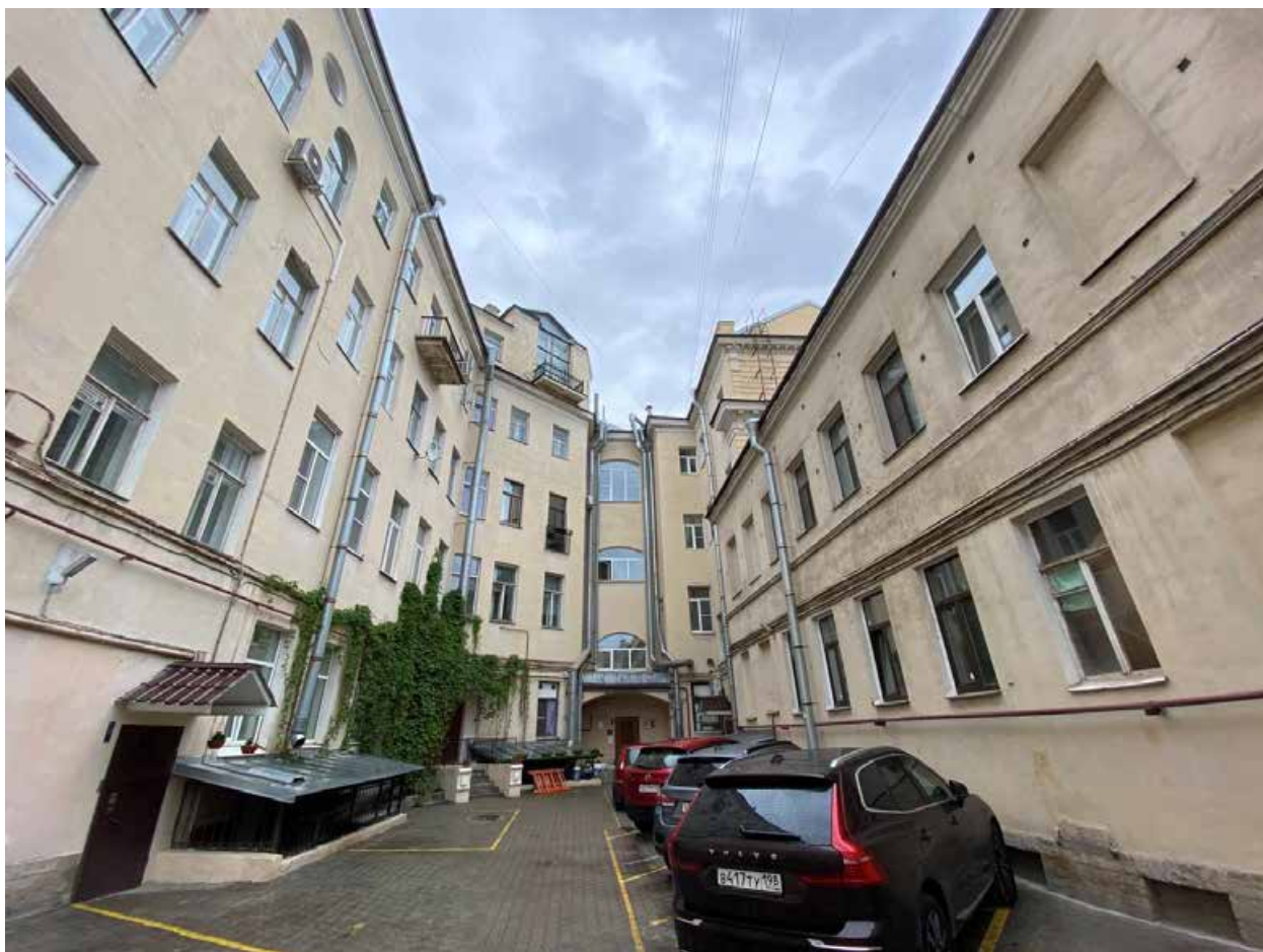
9. Здание по адресу: Санкт-Петербург, Биржевой переулок, д. 1/10, Лит. А. Общий вид дворовых фасадов
