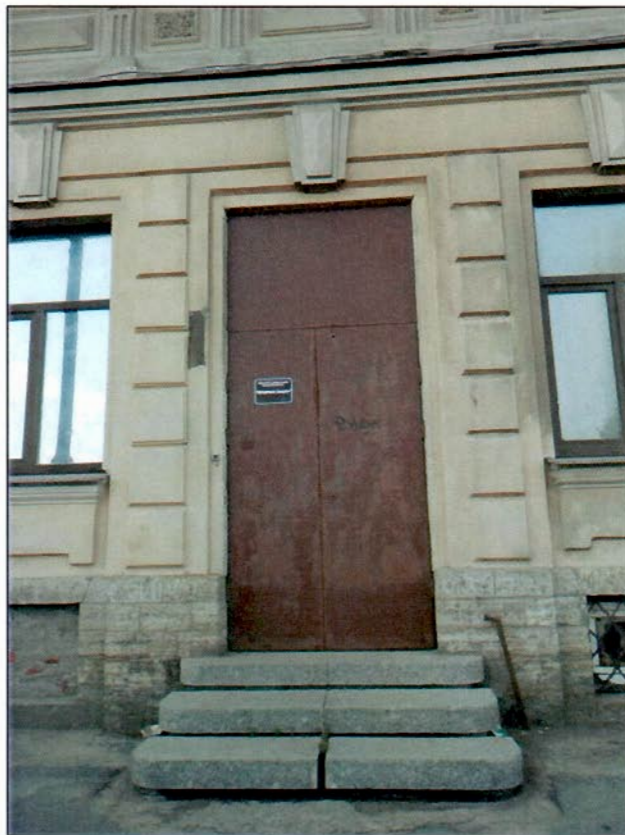
9. Северный фасад. Оформление дверного проема.
