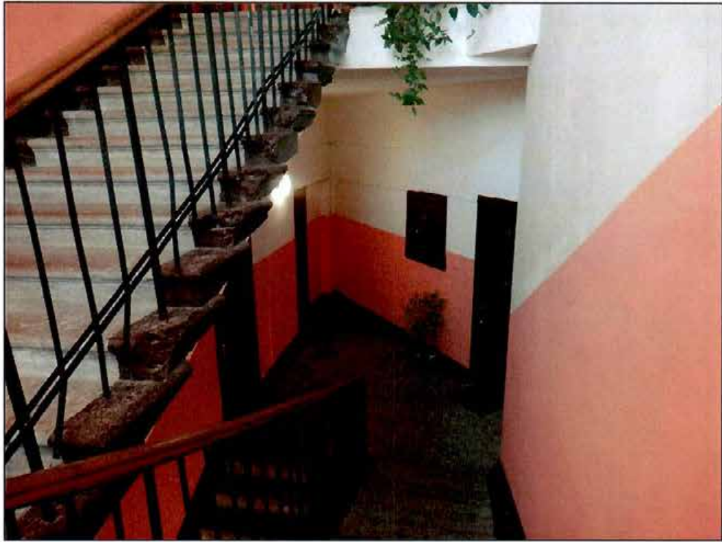
33. Подъезд № 6. Лестница. Общий вид.
