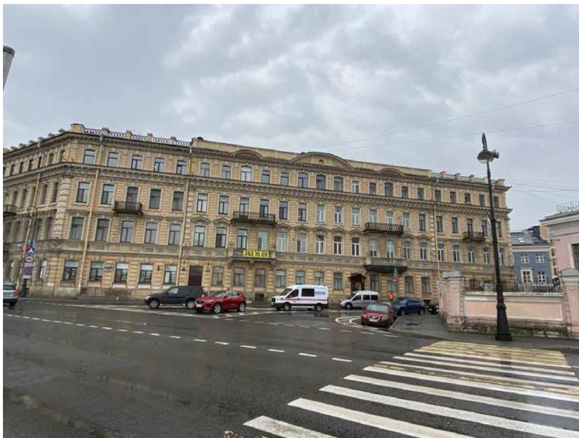
5. Здание по адресу: Санкт-Петербург, Биржевой переулок, д. 1/10, Лит. А. Общий вид лицевого фасада со стороны набережной Макарова
