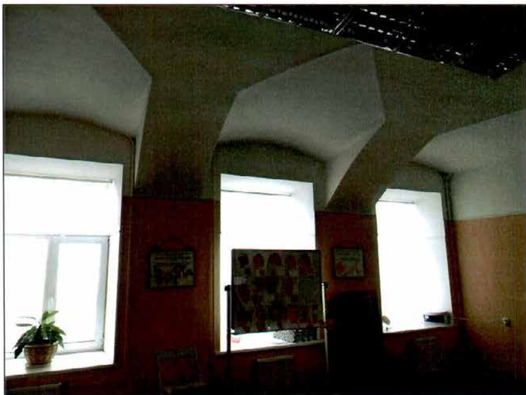
41. Помещение в уровне первого этажа.
