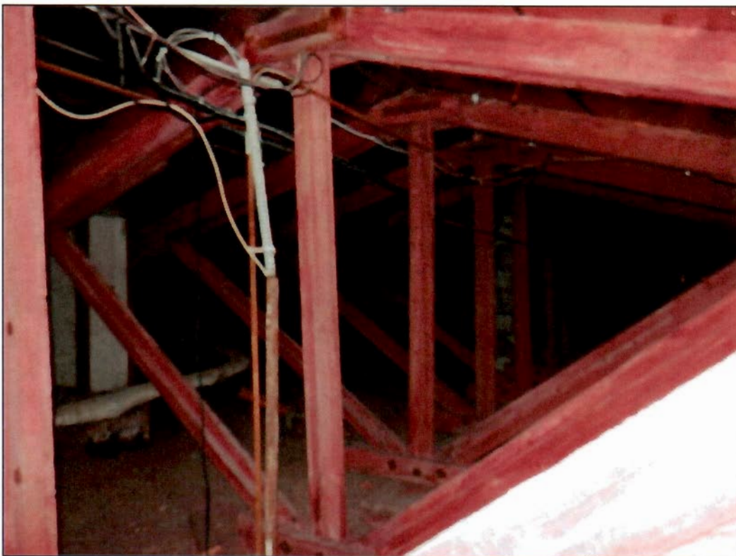
25. Стропильная система. Общий вид.
