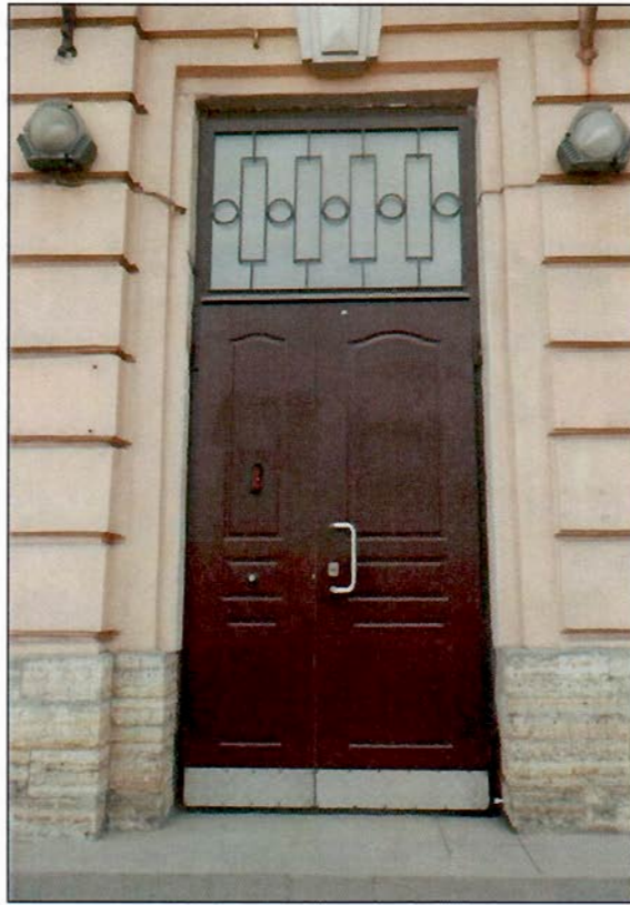
8. Северный фасад. Оформление дверного проема.
