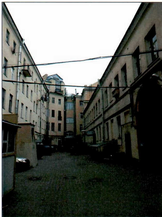
14. Внутренний двор. Вид с запада на восток.
