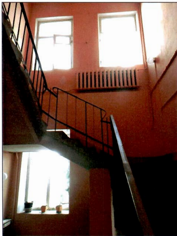
30. Подъезд № 3. Лестница. Общий вид.
