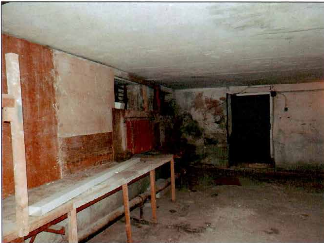
27. Помещение в уровне подвального этажа.
