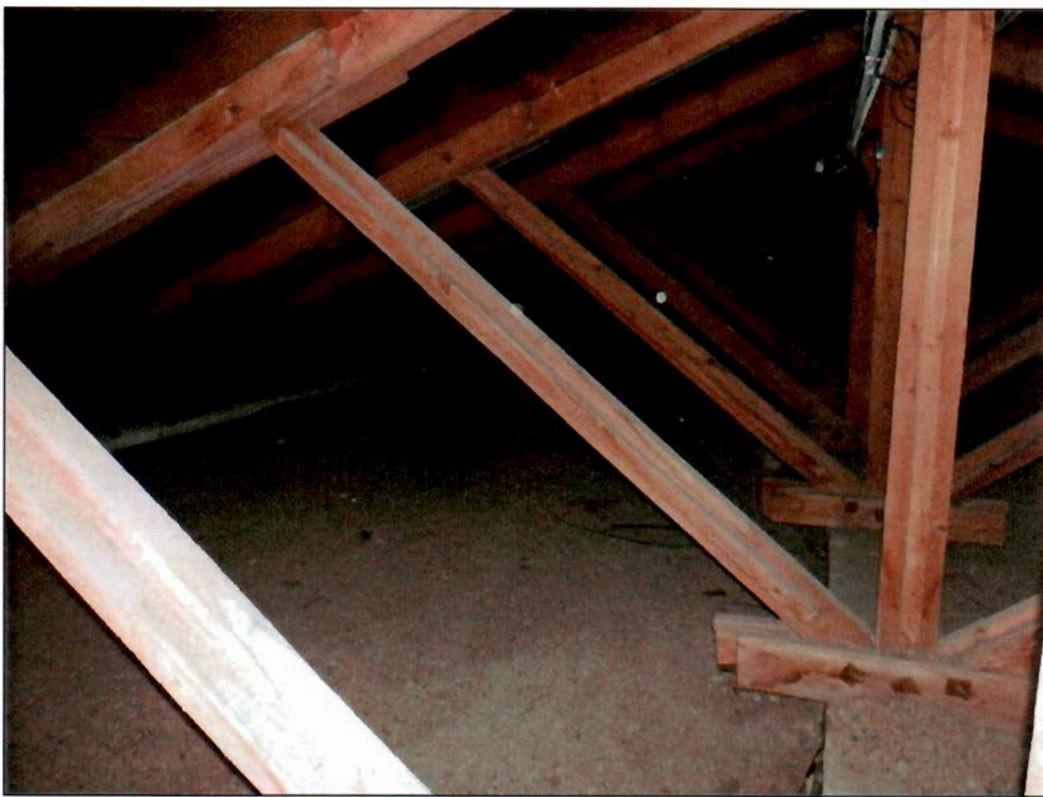
24. Стропильная система. Общий вид.
