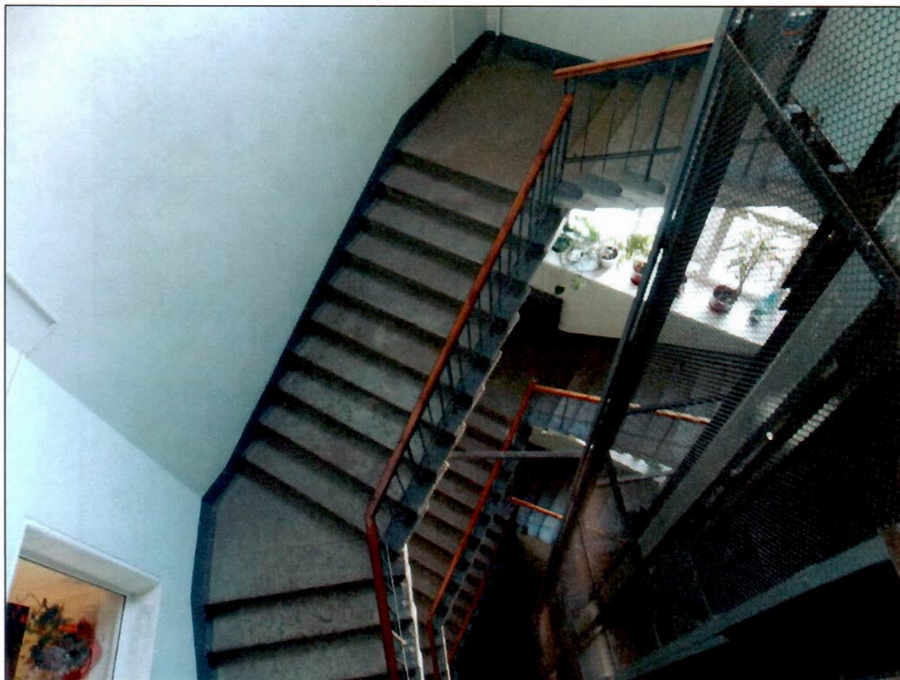
28. Подъезд № 1. Лестница. Общий вид.
