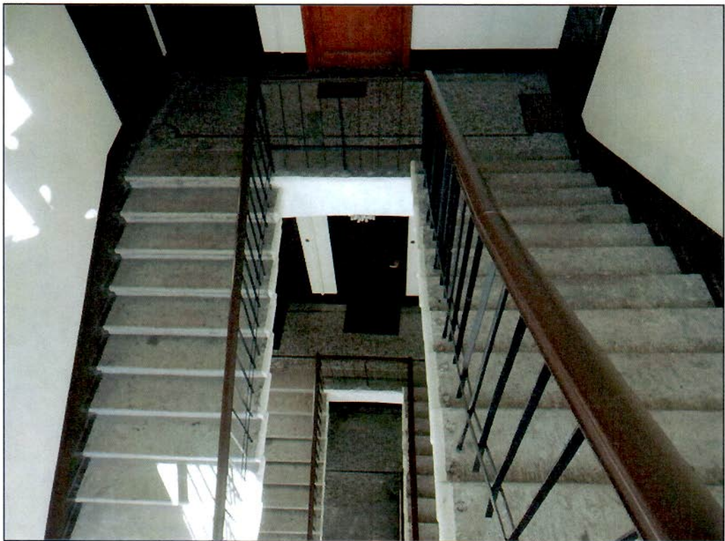
36. Подъезд № 8. Лестница. Общий вид.
