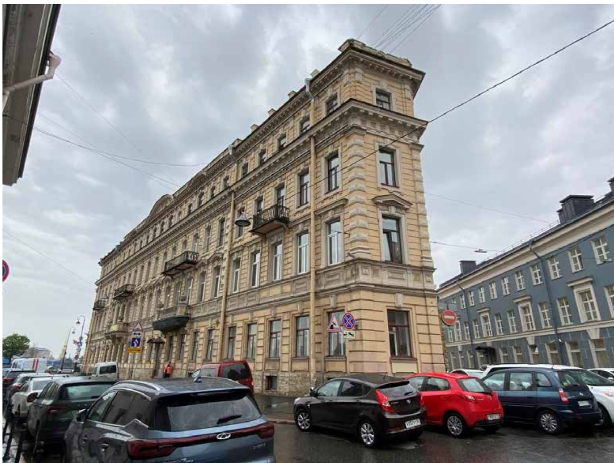
3. Здание по адресу: Санкт-Петербург, Биржевой переулок, д. 1/10, Лит. А. Общий вид лицевого фасада со стороны Волховского переуллка
