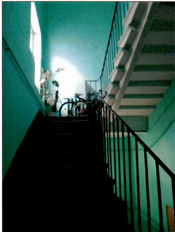
29. Подъезд № 2. Лестница. Общий вид.
