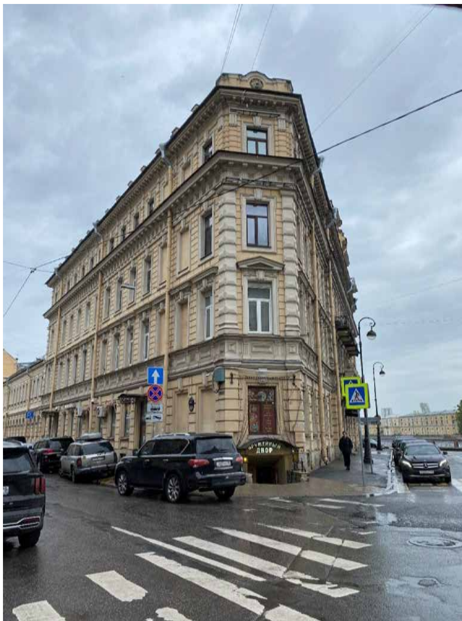
2. Здание по адресу: Санкт-Петербург, Биржевой переулок, д. 1/10, Лит. А. Общий вид дома со стороны Биржевого переуллка
