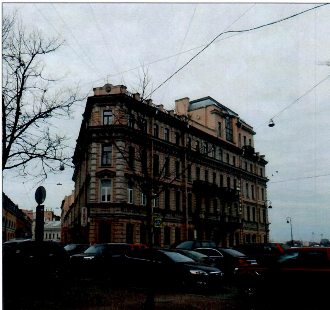
1. Общий вид с востока.
