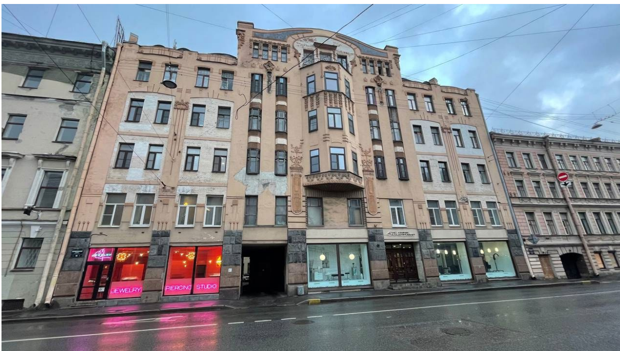
1. Вид на главный фасад;
