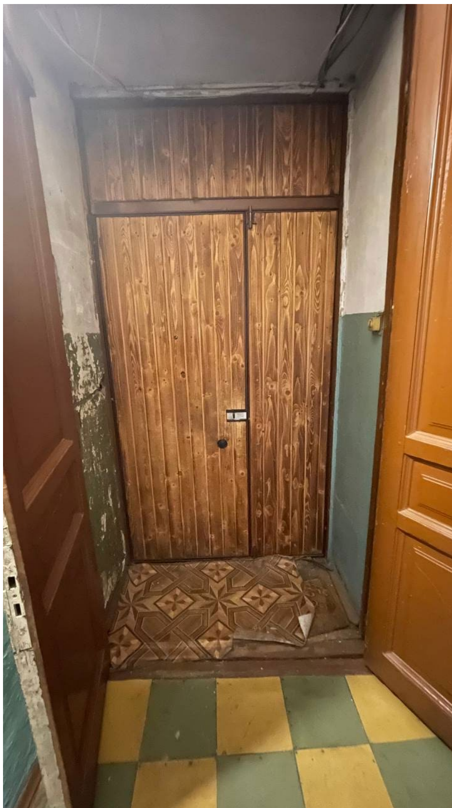
6. Вид на входную дверь в квартире;
