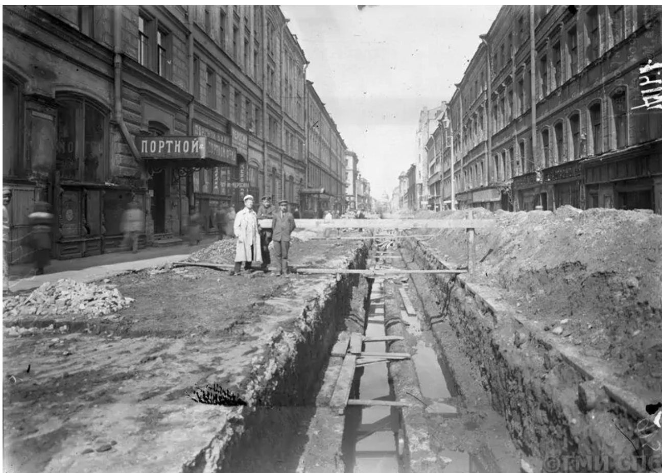
6. Канализационные работы на проспекте Майорова, 1983 // Интернет-ресурс URL: https://pastvu.com/ ;
