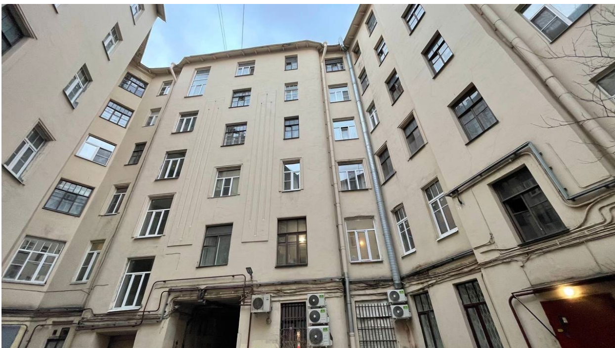
2. Вид на дворовые фасады;
