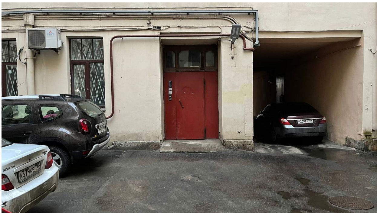
3. Входная дверь на восточном дворовом фасаде;
