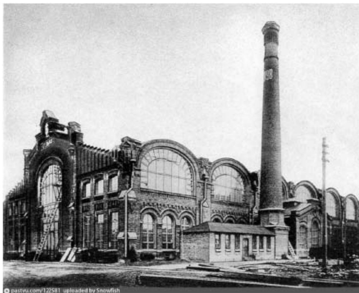
Илл. 11. Котельная мастерская Балтийского завода. 1908 г. // Штиглиц М.С., Промышленная архитектура Петербурга. СПб.: Журнал
