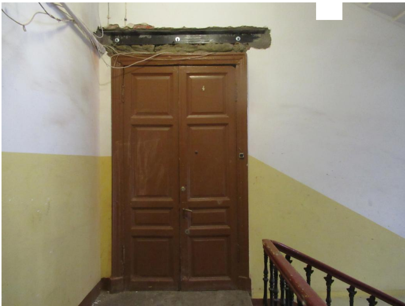
5. Входная дверь в квартиру № 4.
