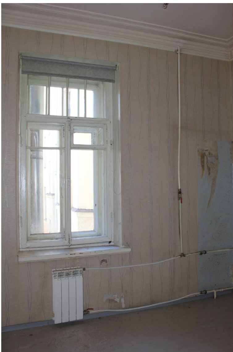
37. Выявленный объект культурного наследия «Дом И.И. Боргмана», по адресу: г. Санкт-Петербург, Съезжинская улица, дом 4, литера А. Квартира №4. Помещение 10. Общий вид помещения. Дата фотофиксации: 28 августа 2021 г.
