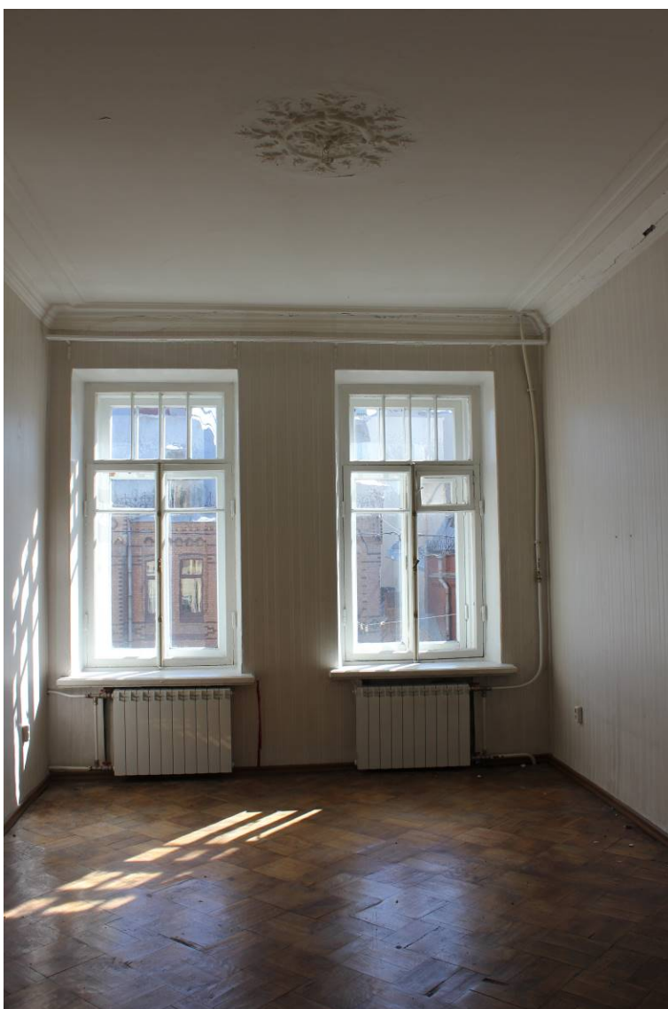
22. Выявленный объект культурного наследия «Дом И.И. Боргмана», по адресу: г. Санкт-Петербург, Съезжинская улица, дом 4, литера А. Квартира №4. Помещение 3. Общий вид помещения. Дата фотофиксации: 28 августа 2021 г.
