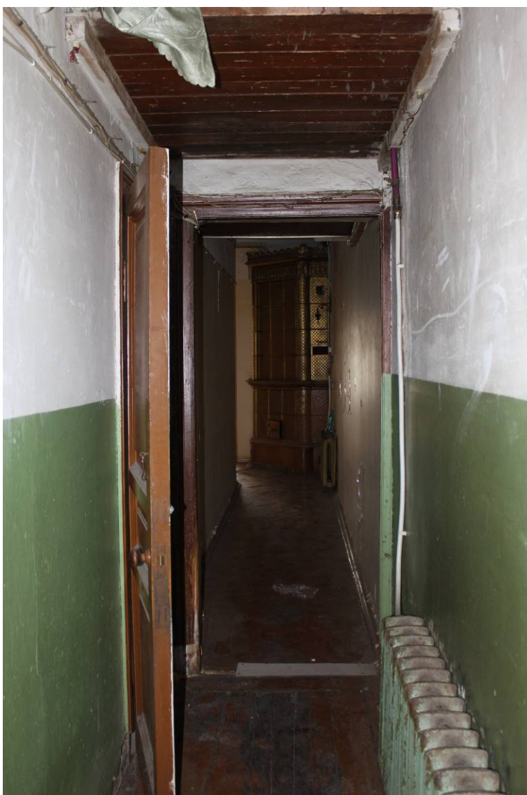
35. Выявленный объект культурного наследия «Дом И.И. Боргмана», по адресу: г. Санкт-Петербург, Съезжинская улица, дом 4, литера А. Квартира №4. Помещение 6. Общий вид помещения. Дата фотофиксации: 28 августа 2021 г.
