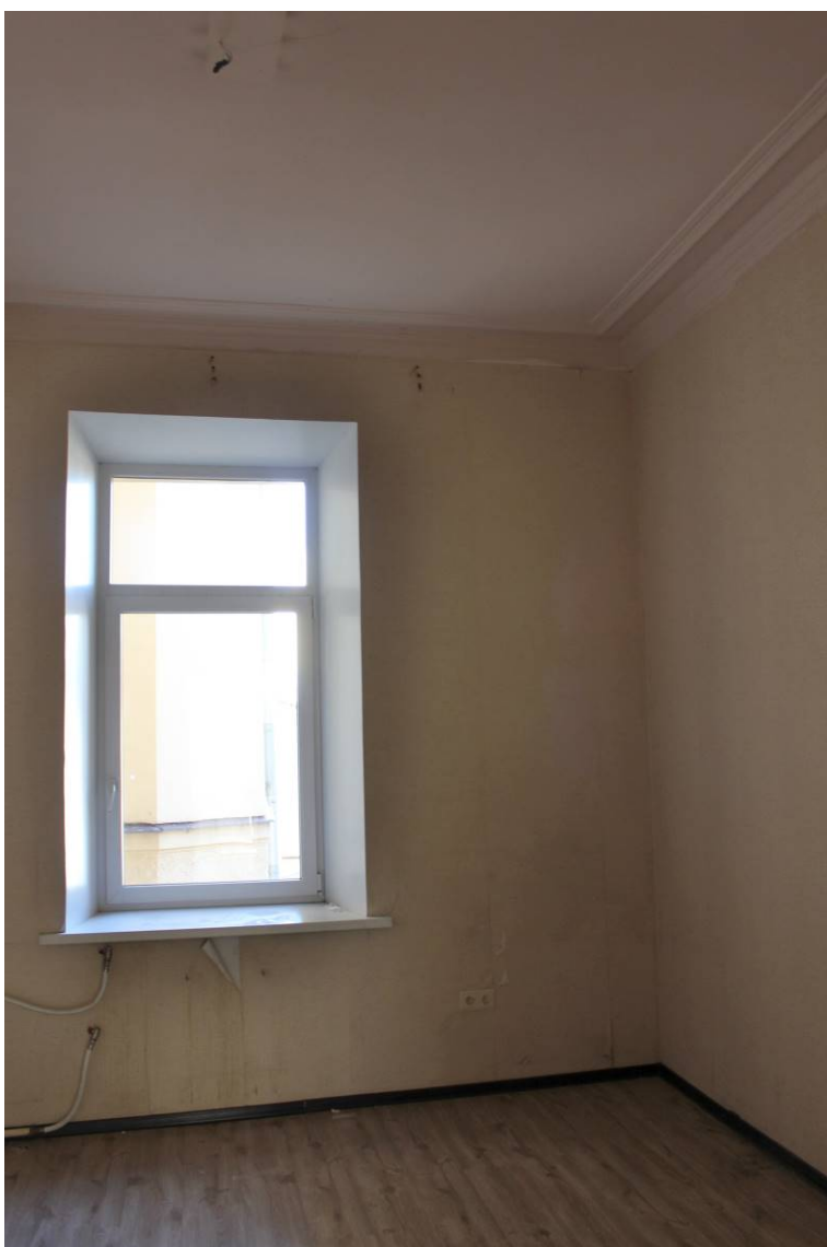
18. Выявленный объект культурного наследия «Дом И.И. Боргмана», по адресу: г. Санкт-Петербург, Съезжинская улица, дом 4, литера А. Квартира №4. Помещение 5. Общий вид помещения. Дата фотофиксации: 28 августа 2021 г.
