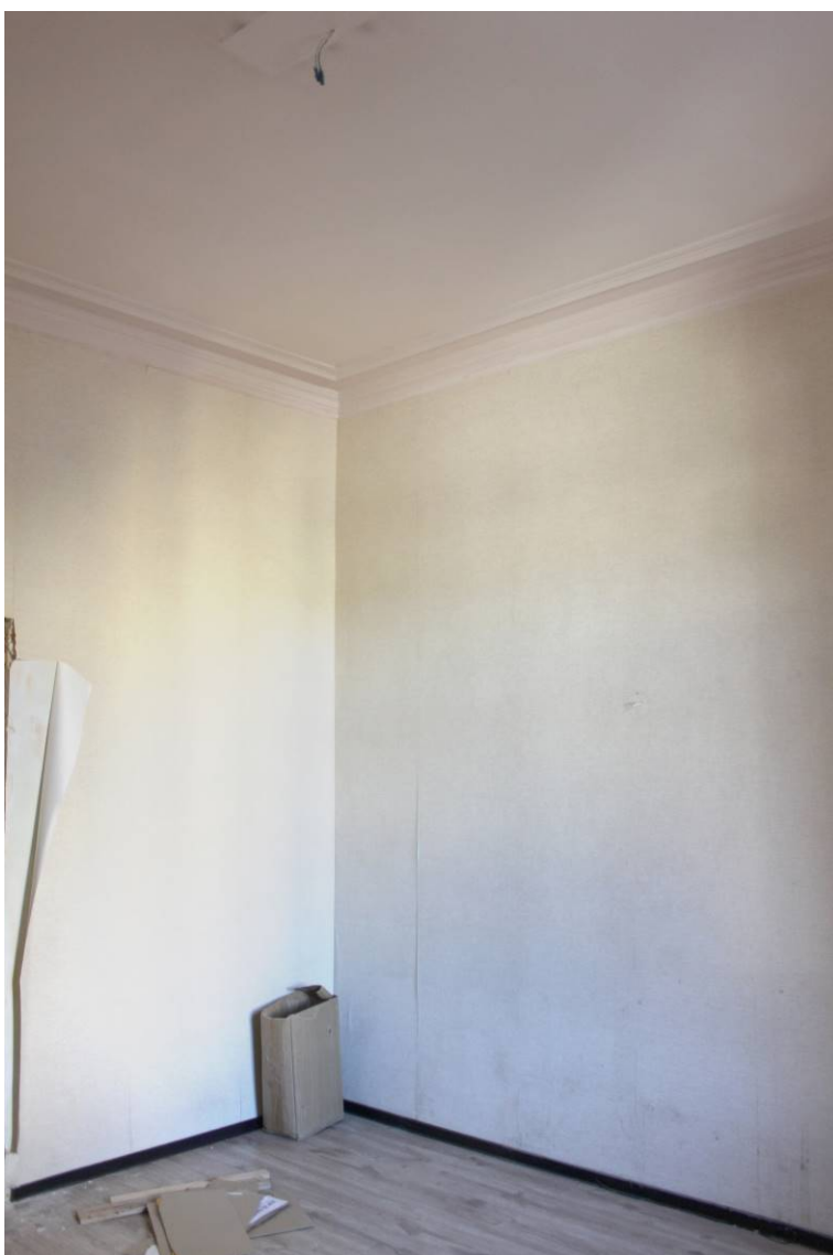
19. Выявленный объект культурного наследия «Дом И.И. Боргмана», по адресу: г. Санкт-Петербург, Съезжинская улица, дом 4, литера А. Квартира №4. Помещение 5. Общий вид помещения. Дата фотофиксации: 28 августа 2021 г.
