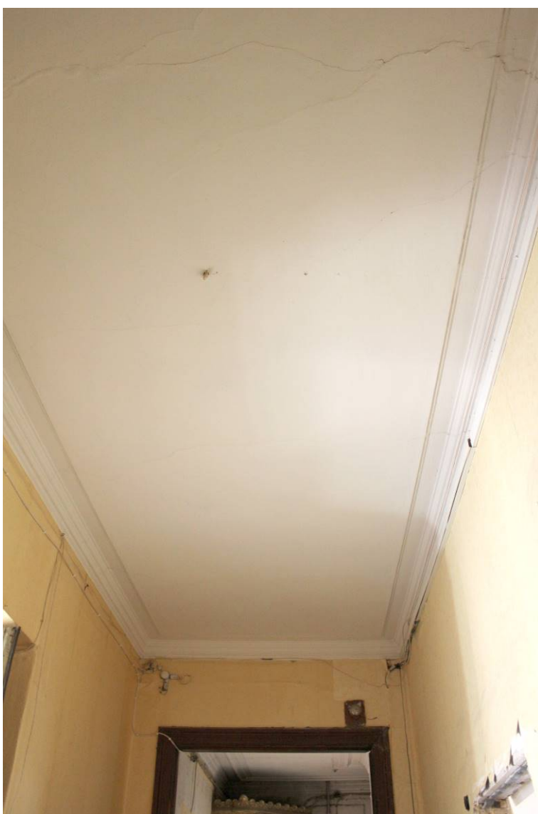
12. Выявленный объект культурного наследия «Дом И.И. Боргмана», по адресу: г. Санкт-Петербург, Съезжинская улица, дом 4, литера А. Квартира №4. Помещение 1. Фрагмент с показом оформления потолка. Дата фотофиксации: 28 августа 2021 г.
