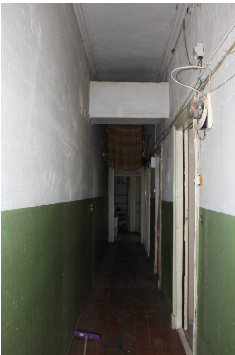
36. Выявленный объект культурного наследия «Дом И.И. Боргмана», по адресу: г. Санкт-Петербург, Съезжинская улица, дом 4, литера А. Квартира №4. Помещение 6. Общий вид помещения. Дата фотофиксации: 28 августа 2021 г.
