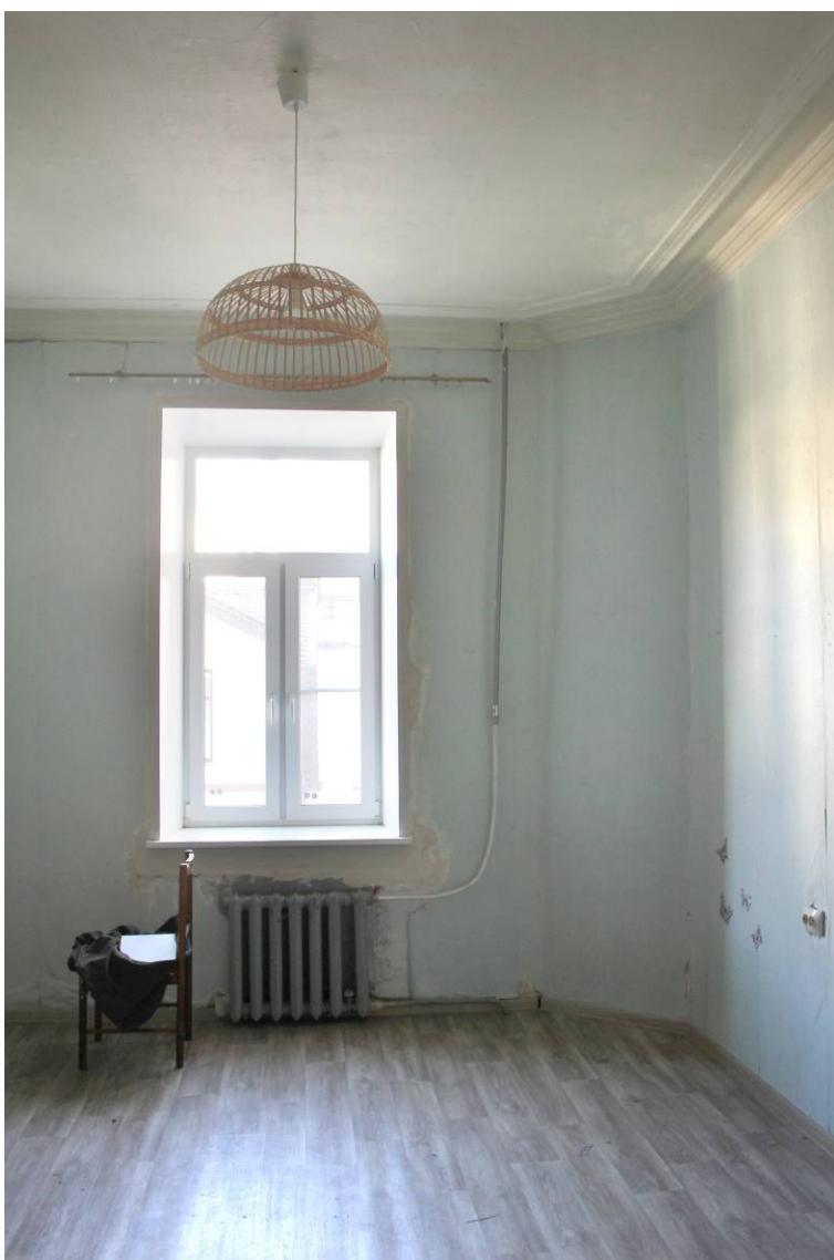
40. Выявленный объект культурного наследия «Дом И.И. Боргмана», по адресу: г. Санкт-Петербург, Съезжинская улица, дом 4, литера А. Квартира №4. Помещение 11. Общий вид помещения. Дата фотофиксации: 28 августа 2021 г.
