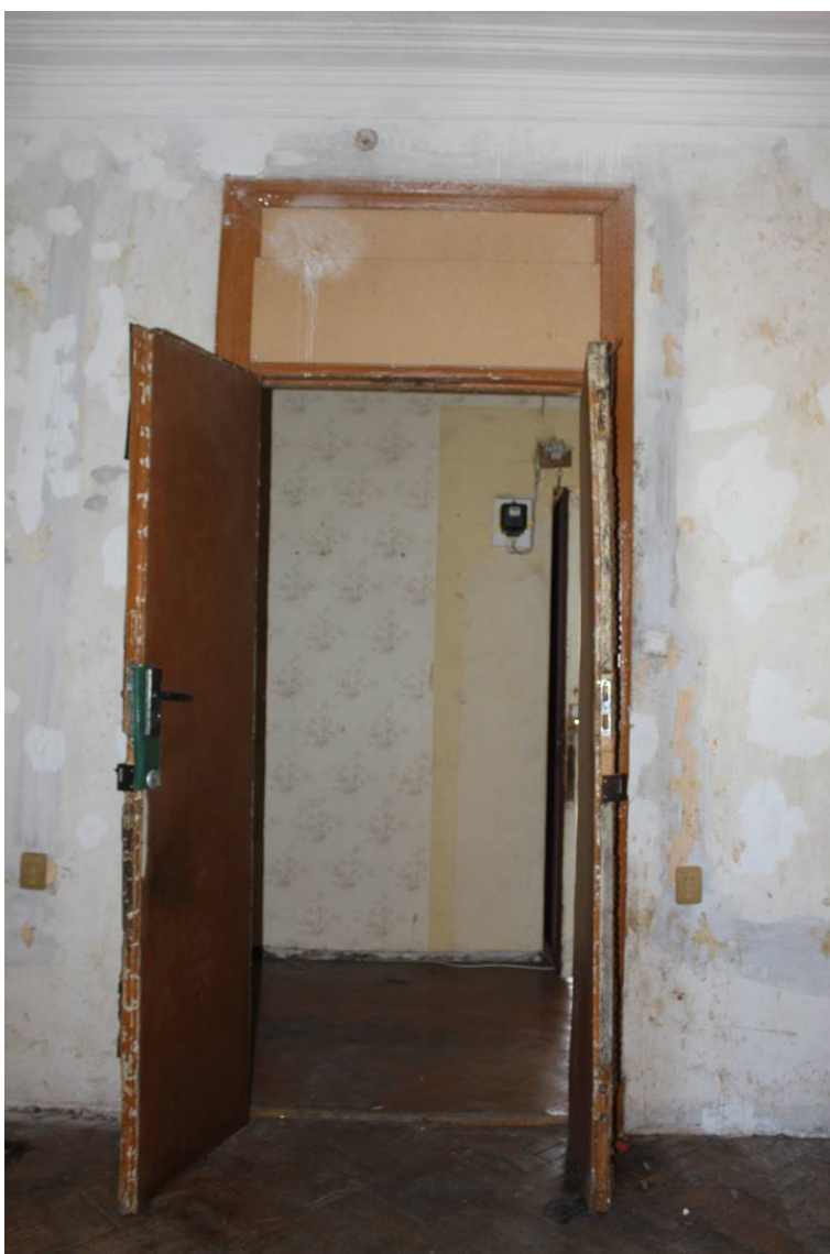
28. Выявленный объект культурного наследия «Дом И.И. Боргмана», по адресу: г. Санкт-Петербург, Съезжинская улица, дом 4, литера А. Квартира №4. Помещение 4. Фрагмент с показом дверного проема. Дата фотофиксации: 28 августа 2021 г.
