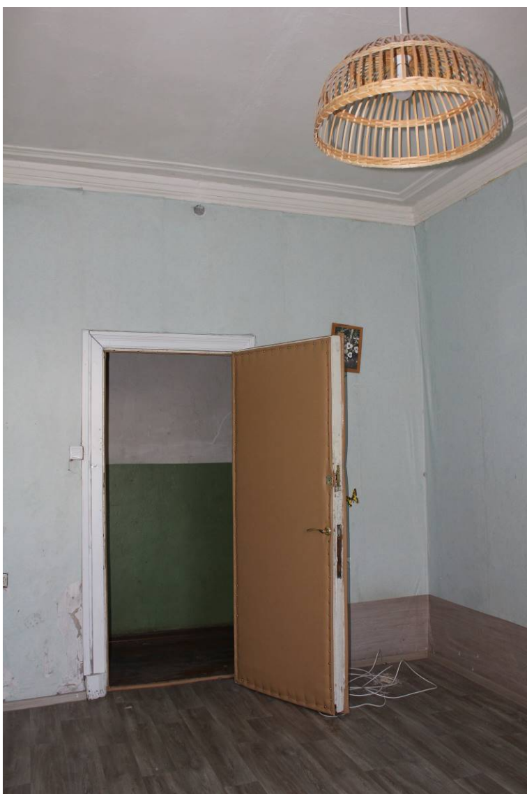
41. Выявленный объект культурного наследия «Дом И.И. Боргмана», по адресу: г. Санкт-Петербург, Съезжинская улица, дом 4, литера А. Квартира №4. Помещение 11. Общий вид помещения. Дата фотофиксации: 28 августа 2021 г.
