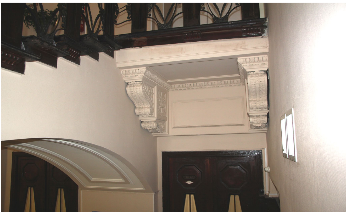
Фото 11. Помещение №43. Вид на кронштейны
