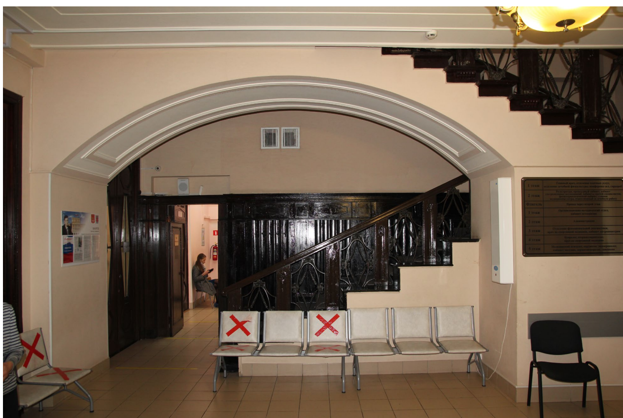
Фото 4. Общий вид помещения №43. Вид на лестничной ограждение и дверное заполнение ДВ-3
