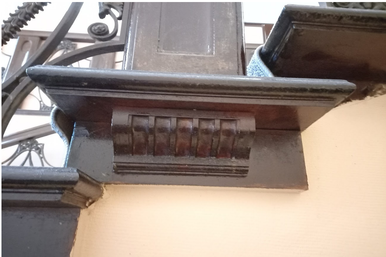
Фото 42. Фрагмент лестничной клетки. Кронштейн ступени. Фронтальный вид
