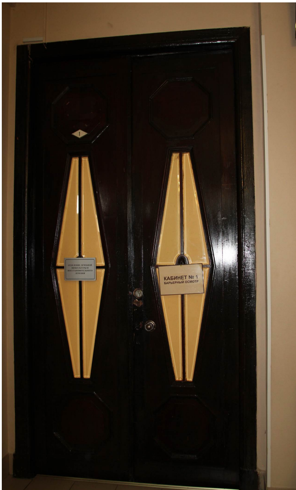
Фото 22. Помещение №4Э. Общий вид дверного заполнения ДВ-2а
