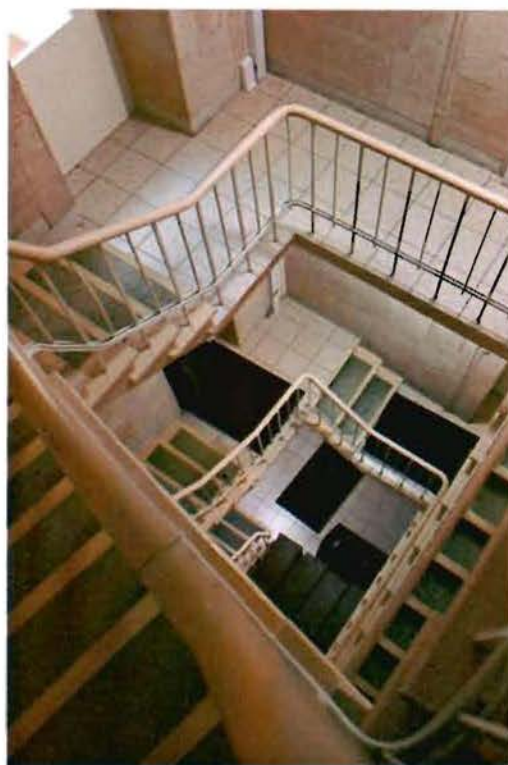
Фото №16. Трехмаршевая межэтажная лестница.
