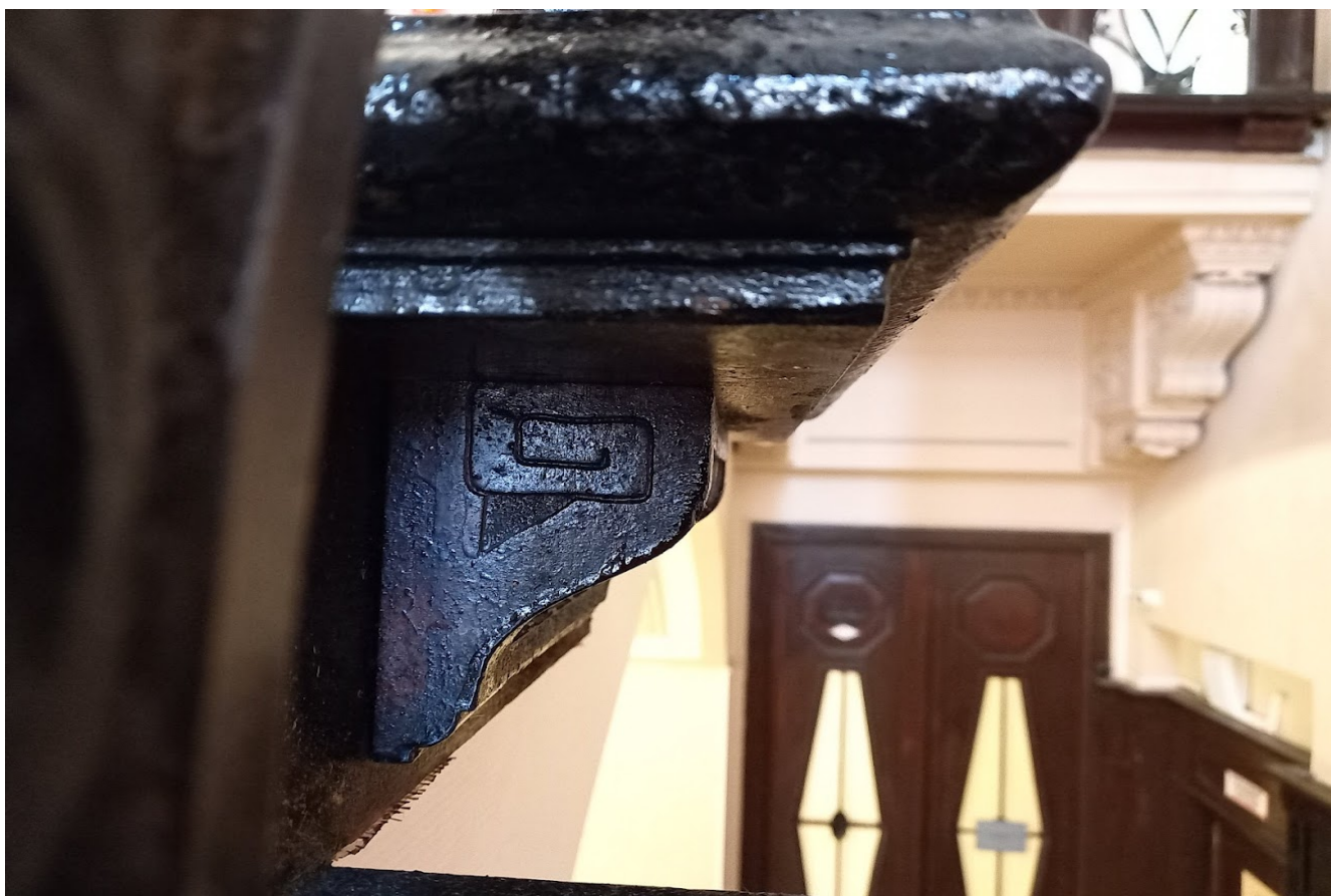
Фото 41. Фрагмент лестничной клетки. Кронштейн ступени. Вид сбоку
