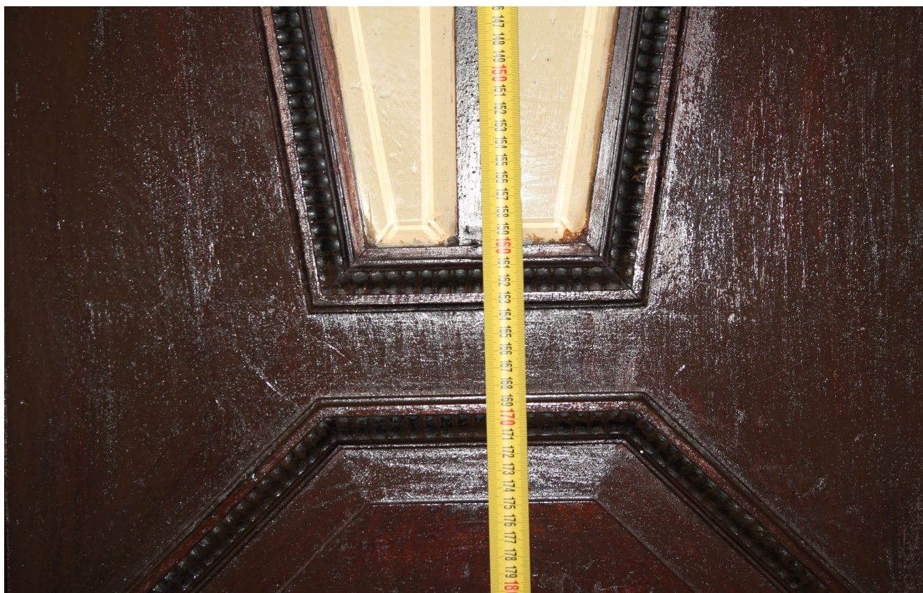
Фото 28. Фрагмент дверного заполнения ДВ-2б
