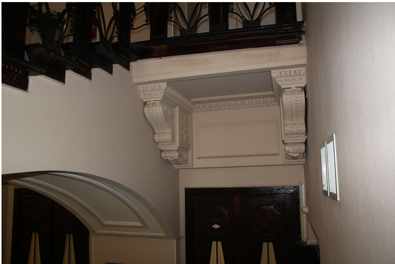
Фото 44. Кронштейны лестничная площадка второго этажа (помещение №68)
