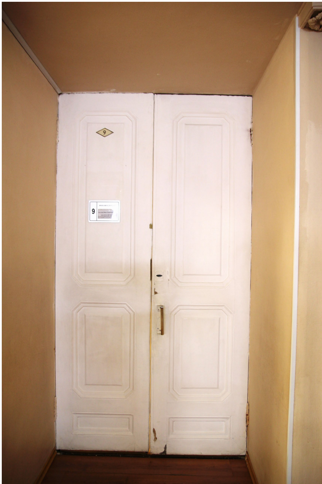
Фото 50. Помещение №68. Дверное заполнение ДВ-6 в помещение №76
