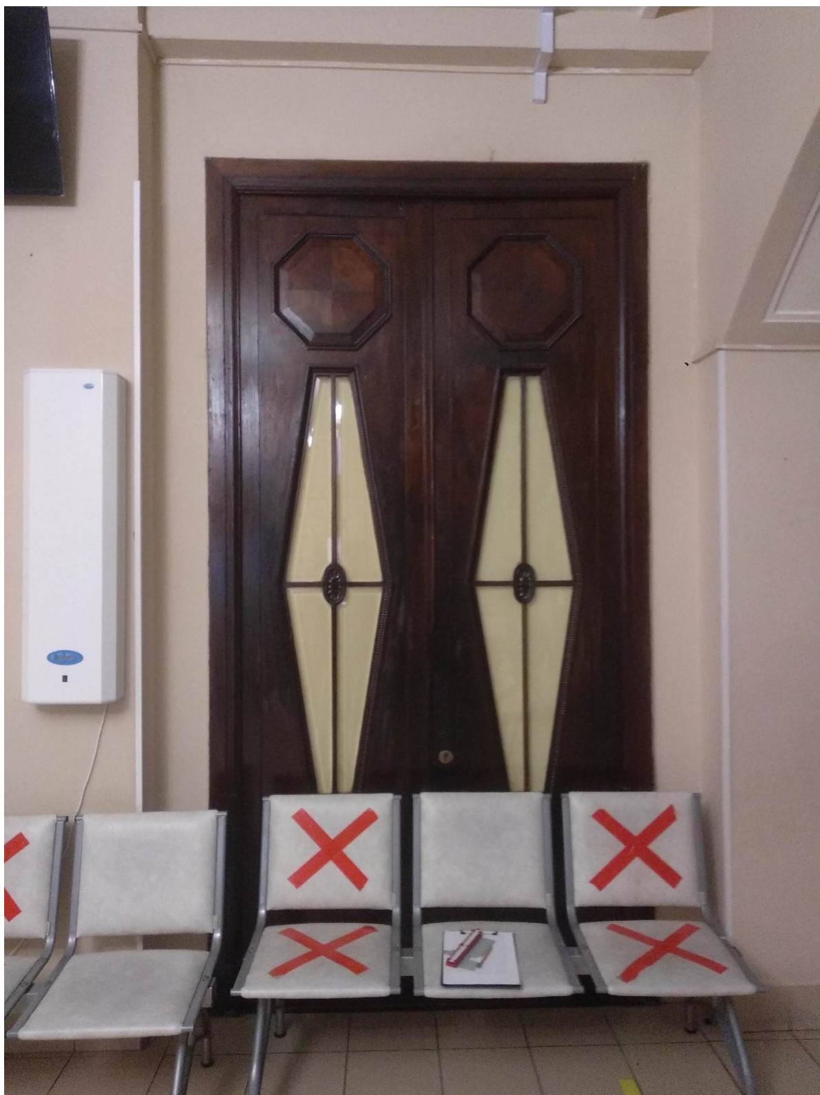
Фото 26. Помещение №43. Общий вид дверного заполнения ДВ-2б
