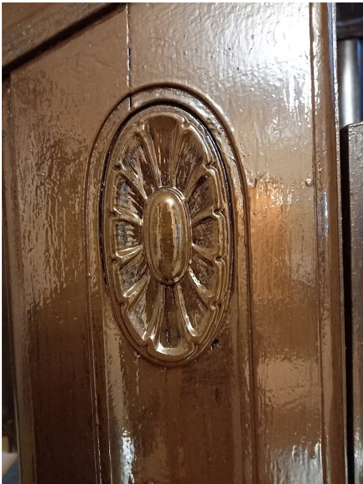
Фото 40. Декоративная розетка деревянных стоек ограждения
