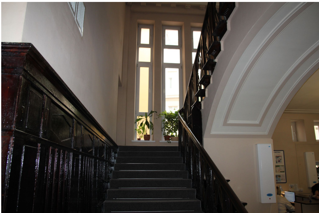
Фото 10. Фрагмент лестничной клетки, вид с уровня 1 этажа
