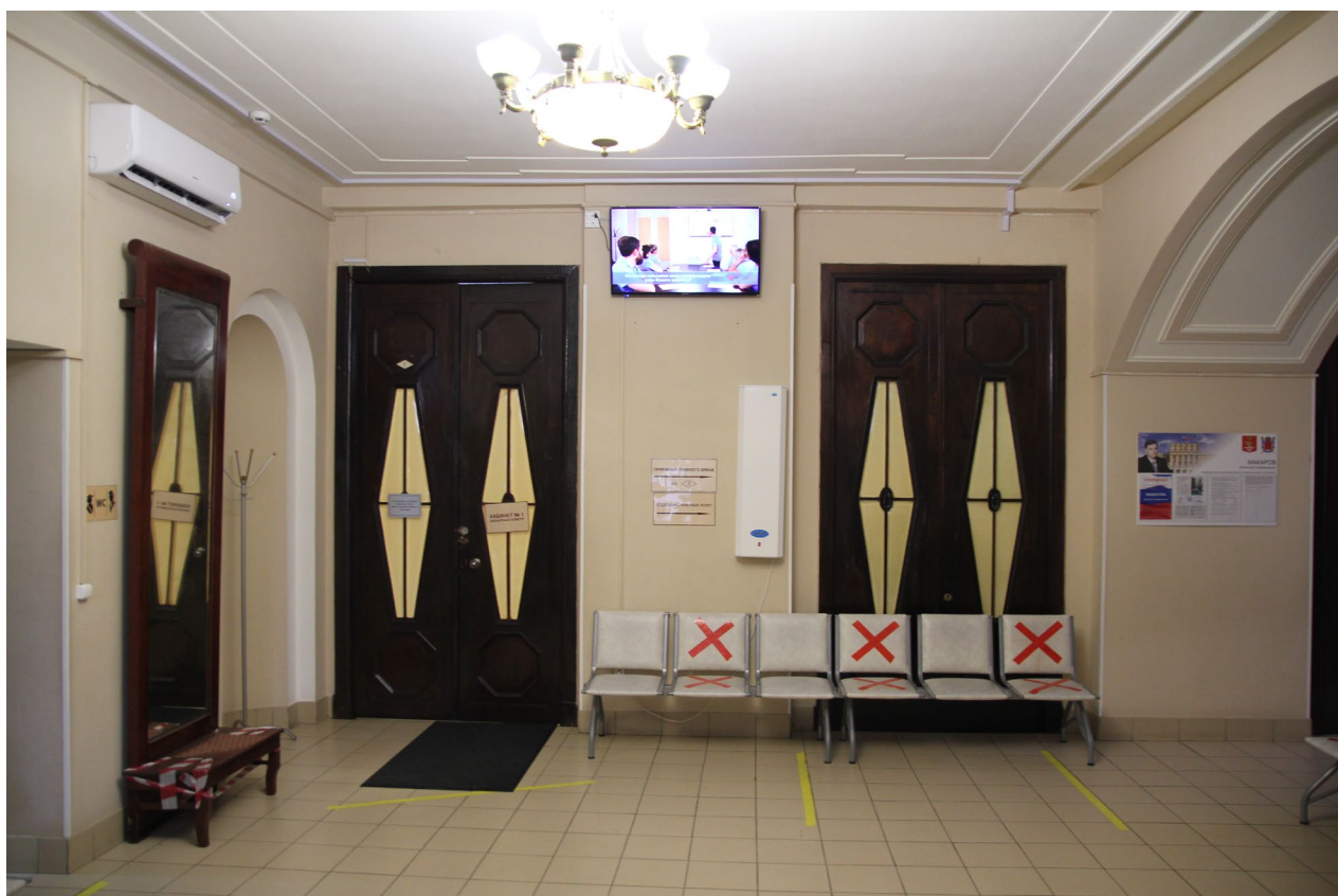
Фото 3. Общий вид помещения №43. Вид на дверные заполнения ДВ-2а, ДВ-2б
