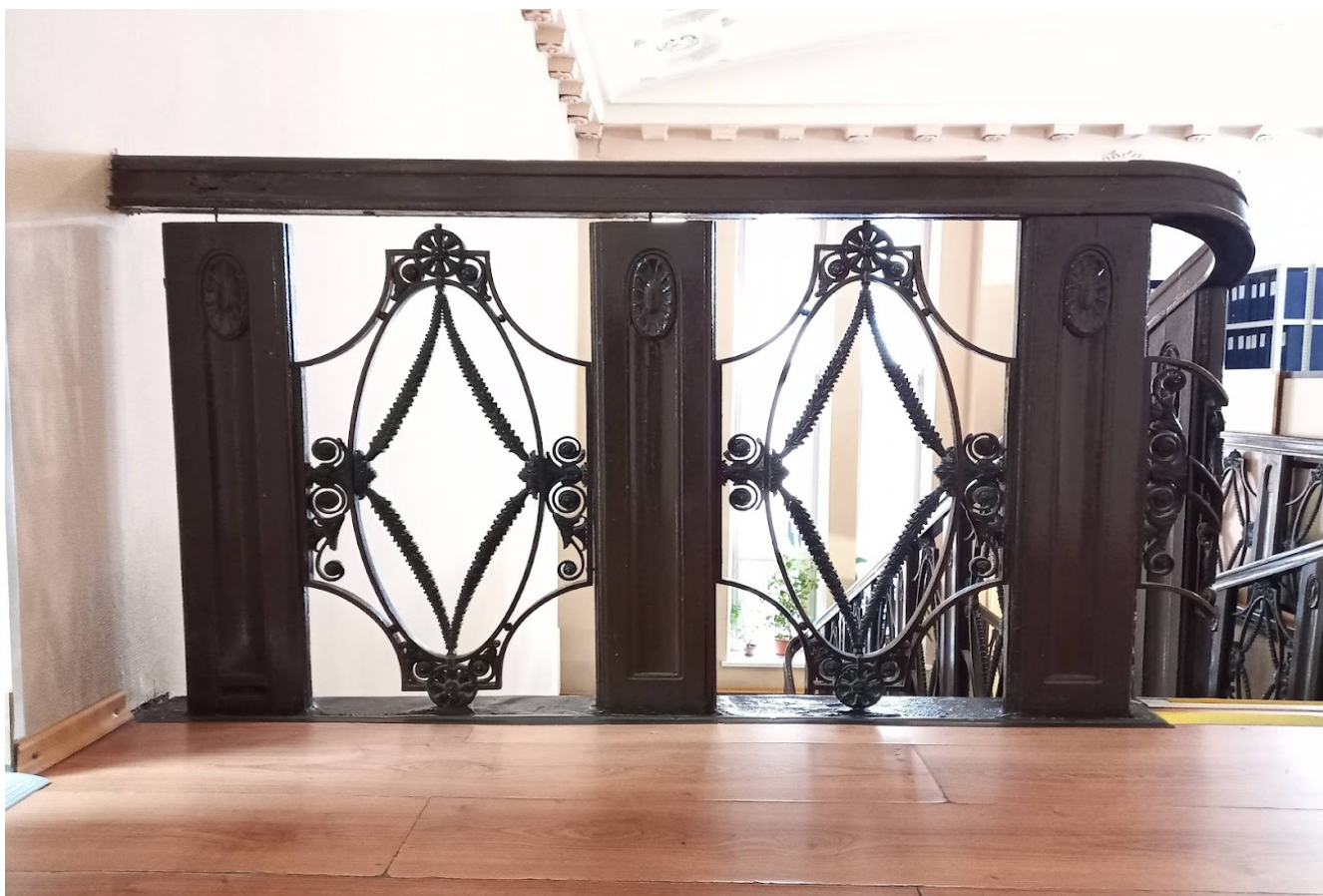
Фото 37. Помещение №68. Фрагмент ограждения лестницы
