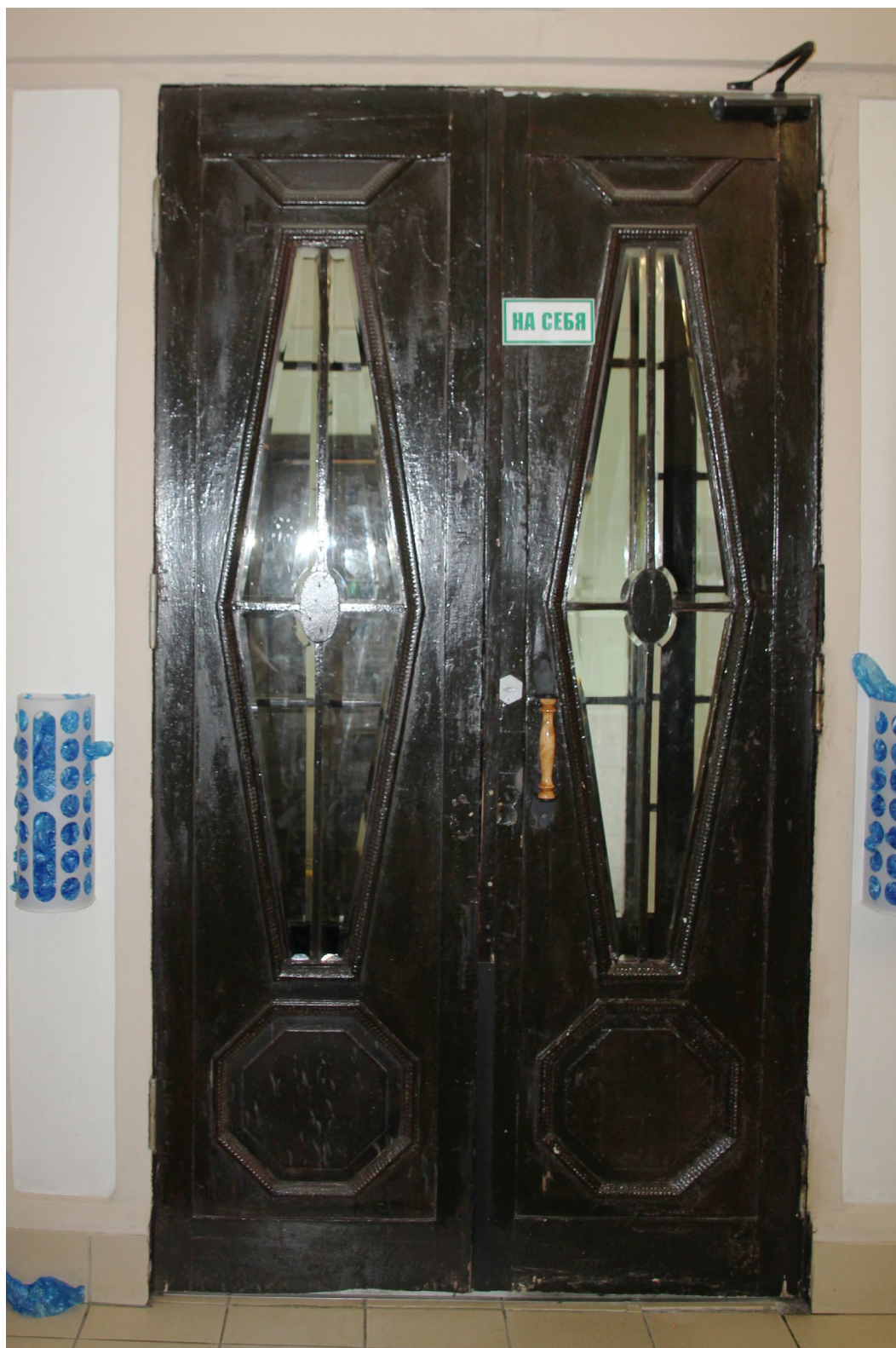
Фото 21. Помещение №43. Общий вид дверного заполнения ДВ-1
