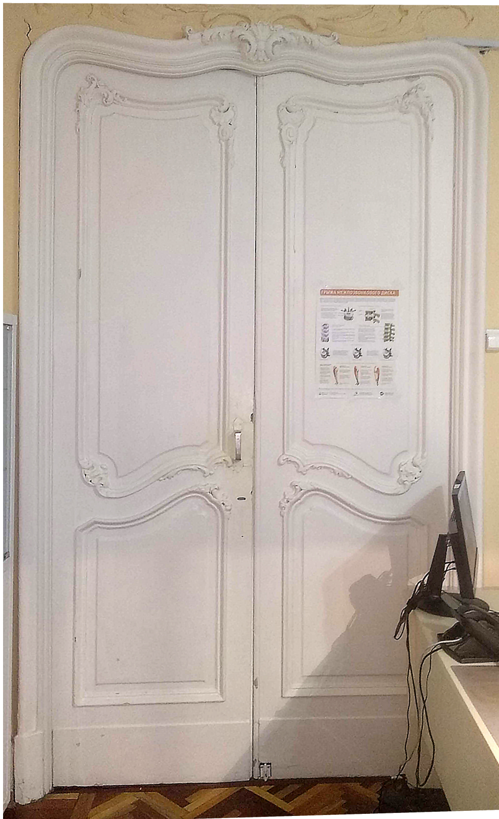
Фото 52. Дверное заполнение ДВ-6б. Общий вид из помещения №77
