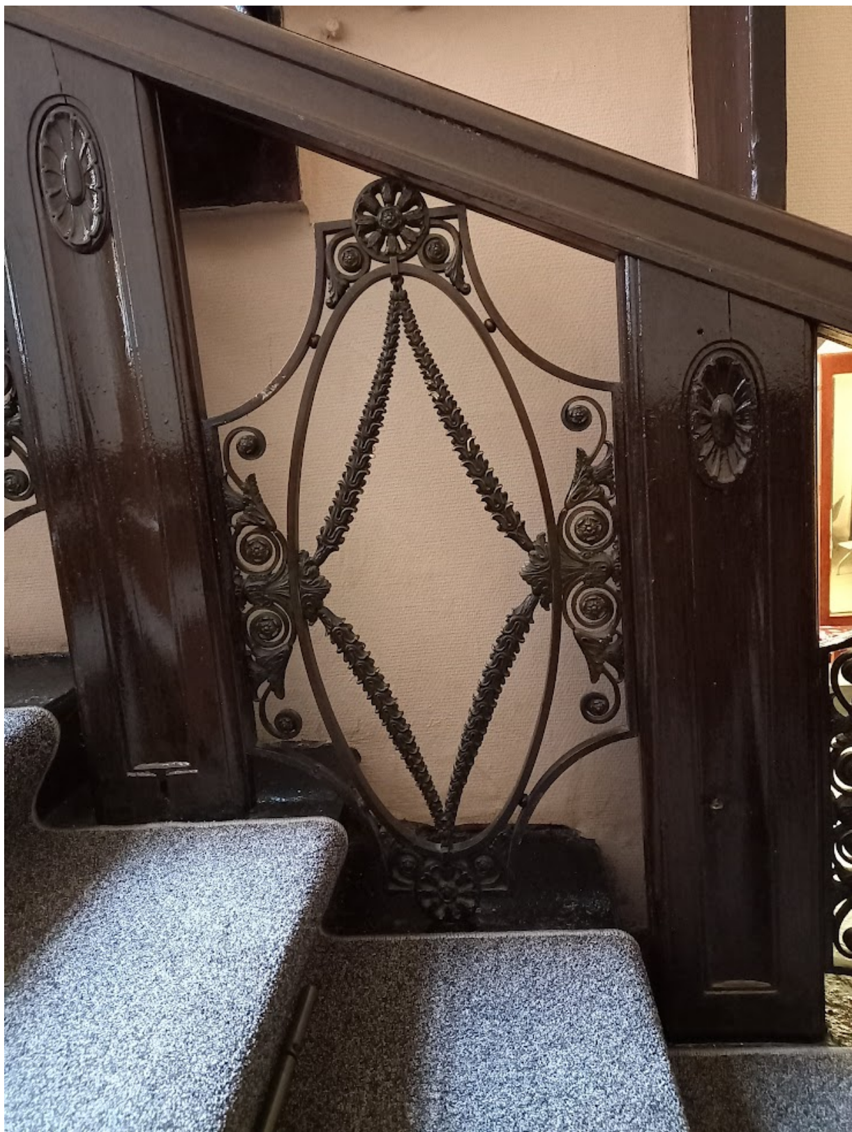
Фото 39. Фрагмент ограждения лестницы. Деревянные стойки и металлическая секция ограждения лестничной клетки
