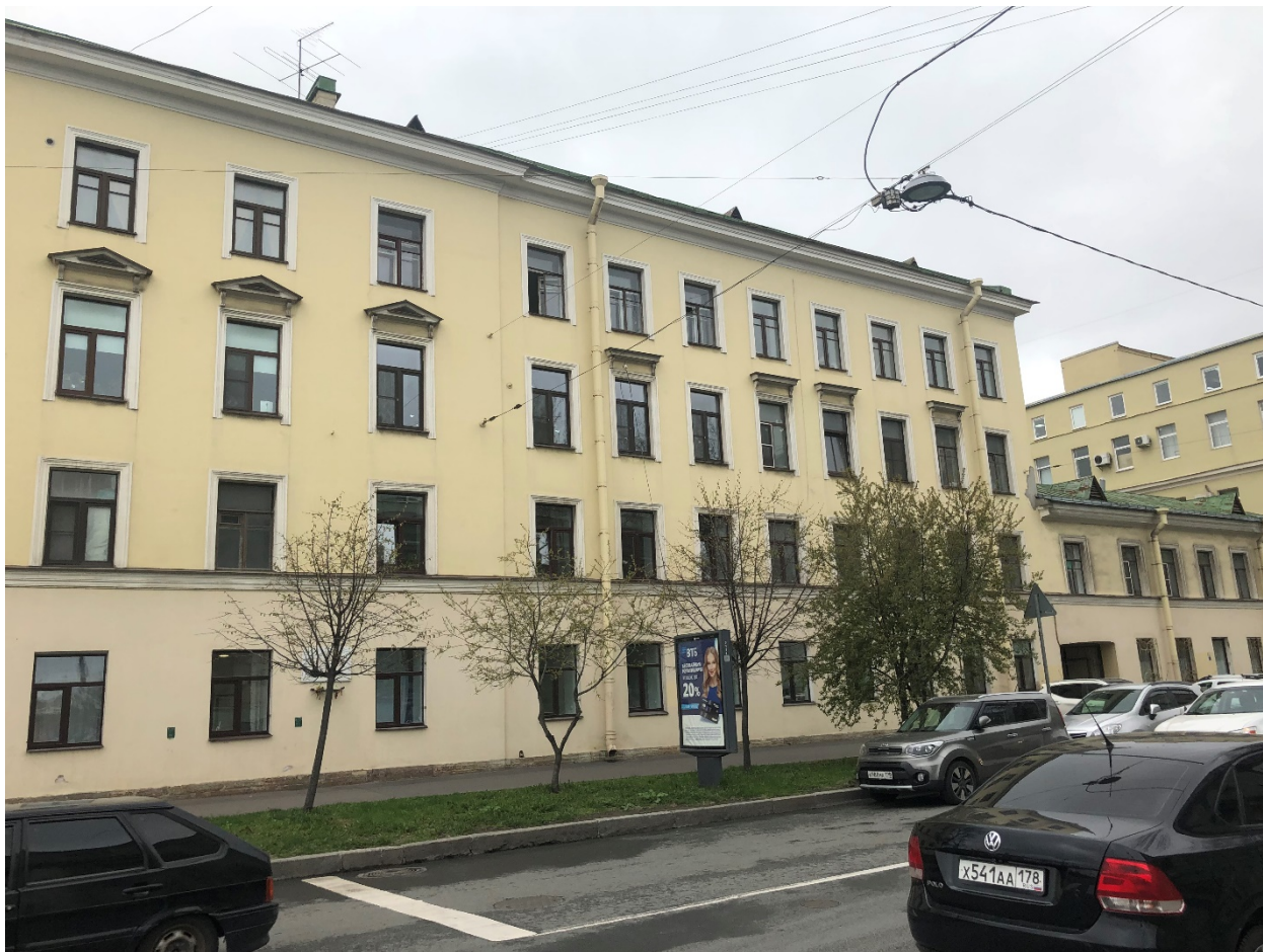
2. Вид на лицевой фасад с 17-ой линии Васильевского острова д. 2/35
