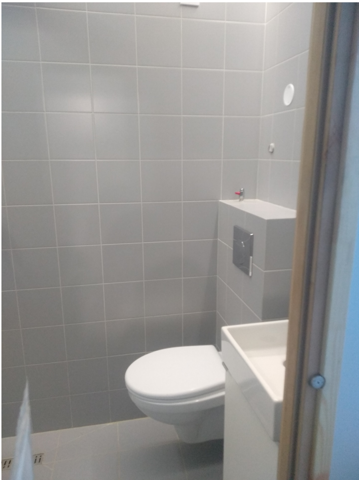
12. Фрагмент совмещенного санузла помещение (№13);
