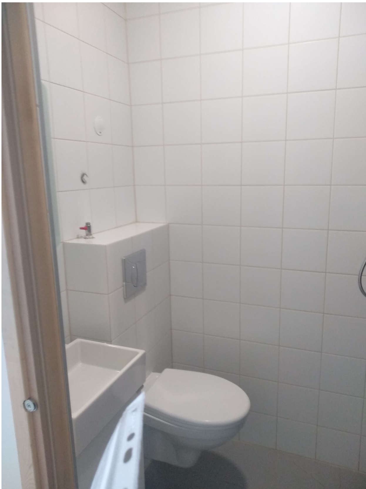
18.Фрагмент совмещенного санузла помещение (№7);
