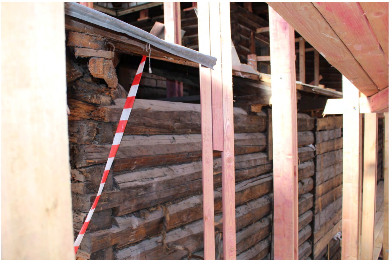
Фото 64. Вид на южную часть здания с юга.
