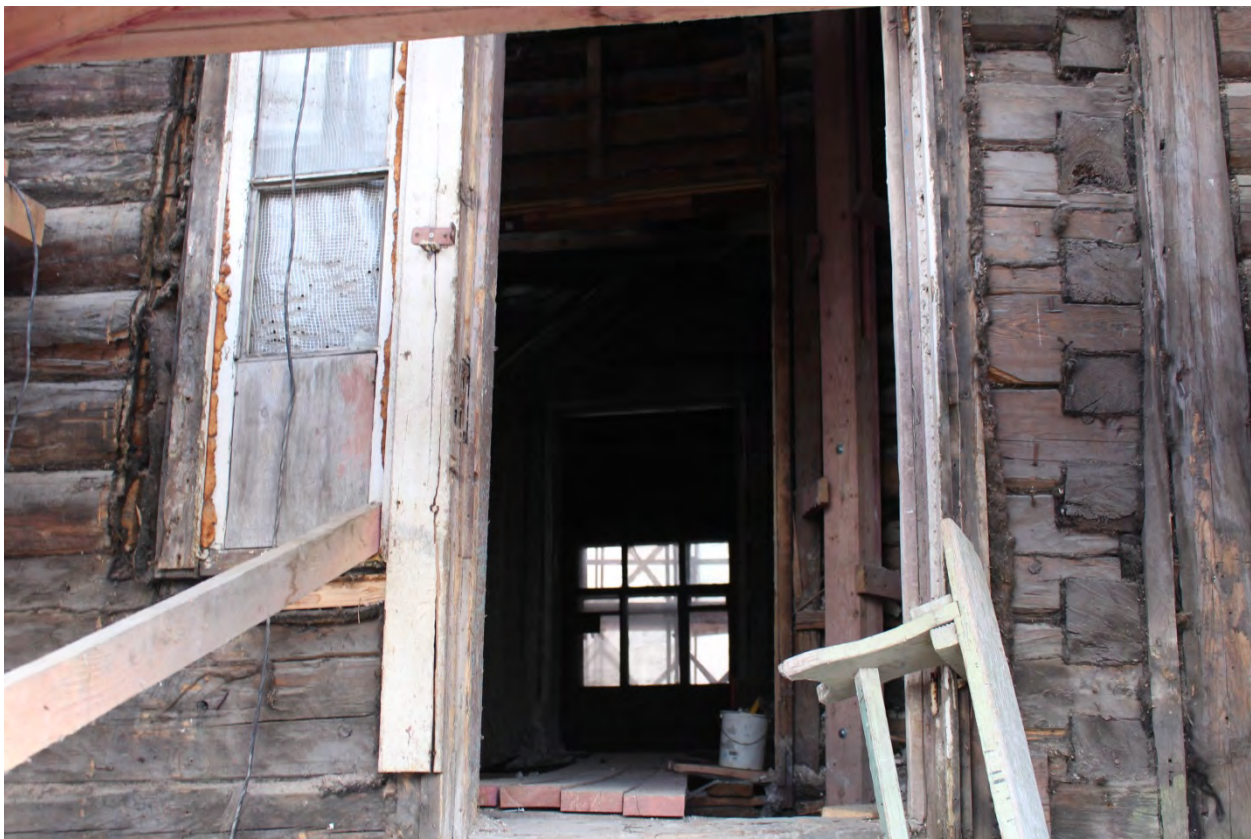
Фото 17. Вход со стороны северо-западного фасада.
