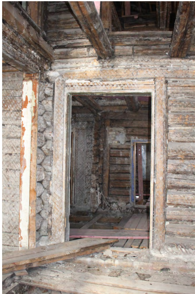
Фото 33. Проем в юге в коридор.
