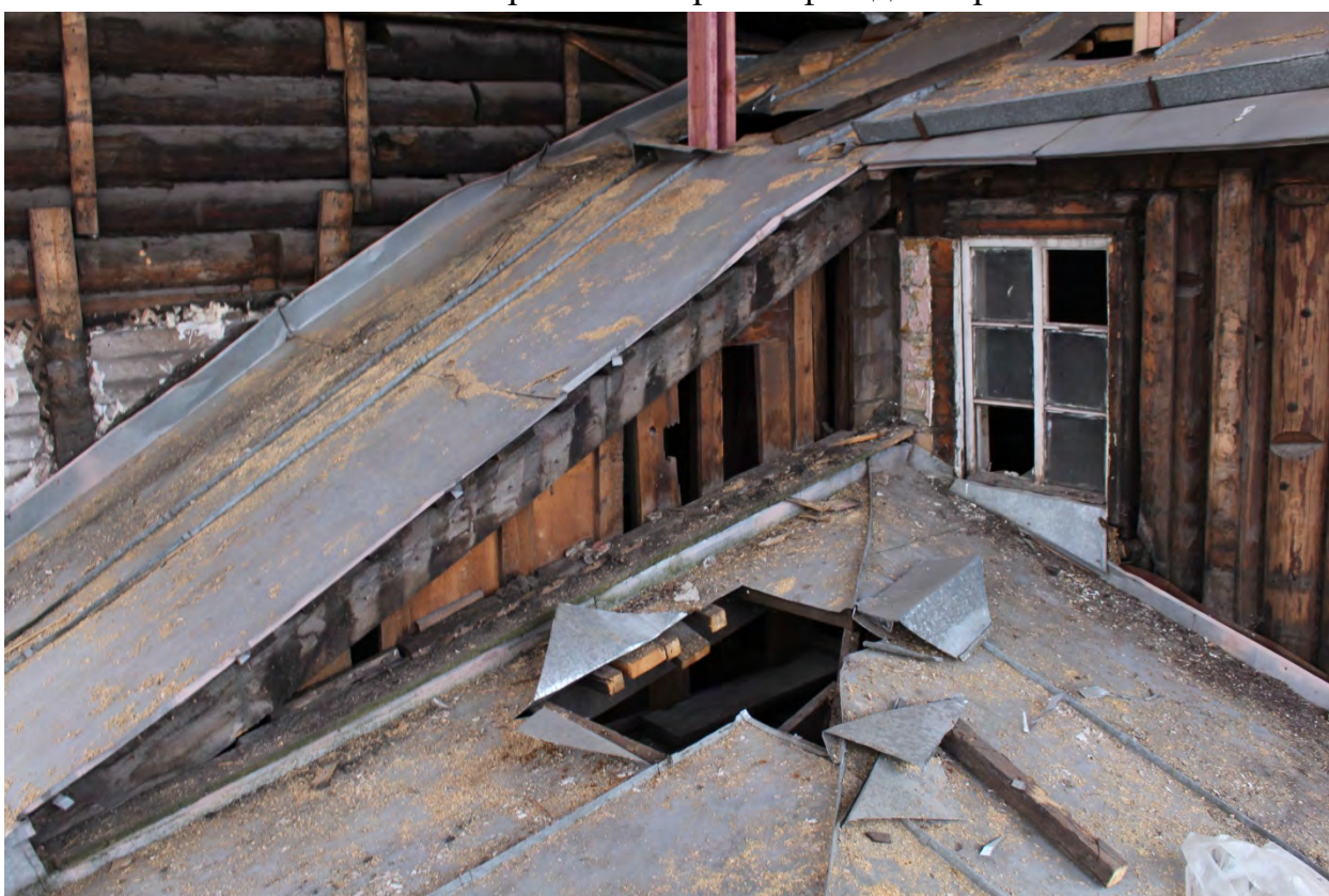
Фото 70. Вид на кровлю с севера.
