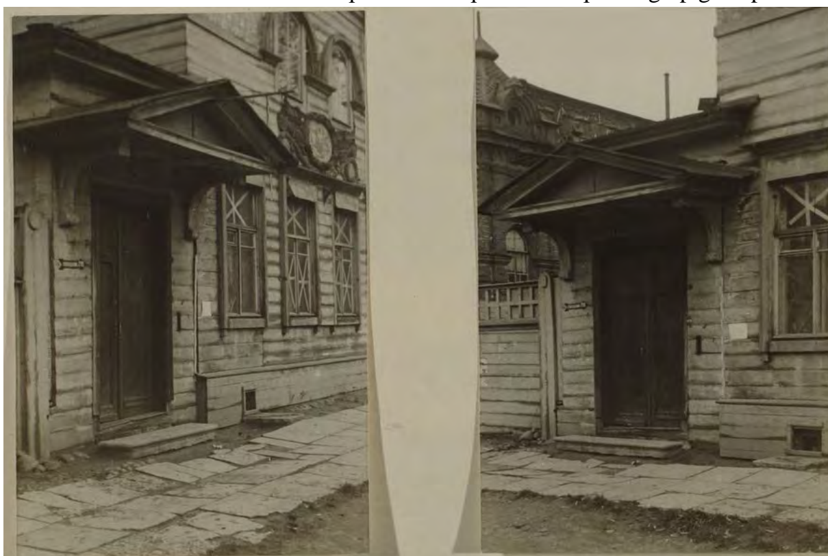
Илл. 48. Навес над гл. входом. Обмеры 1942 г. Кроки. Жилой дом № 37 по 12-й линии Васильевского Острова. Электронный портал kgior.gov.spb.ru .
