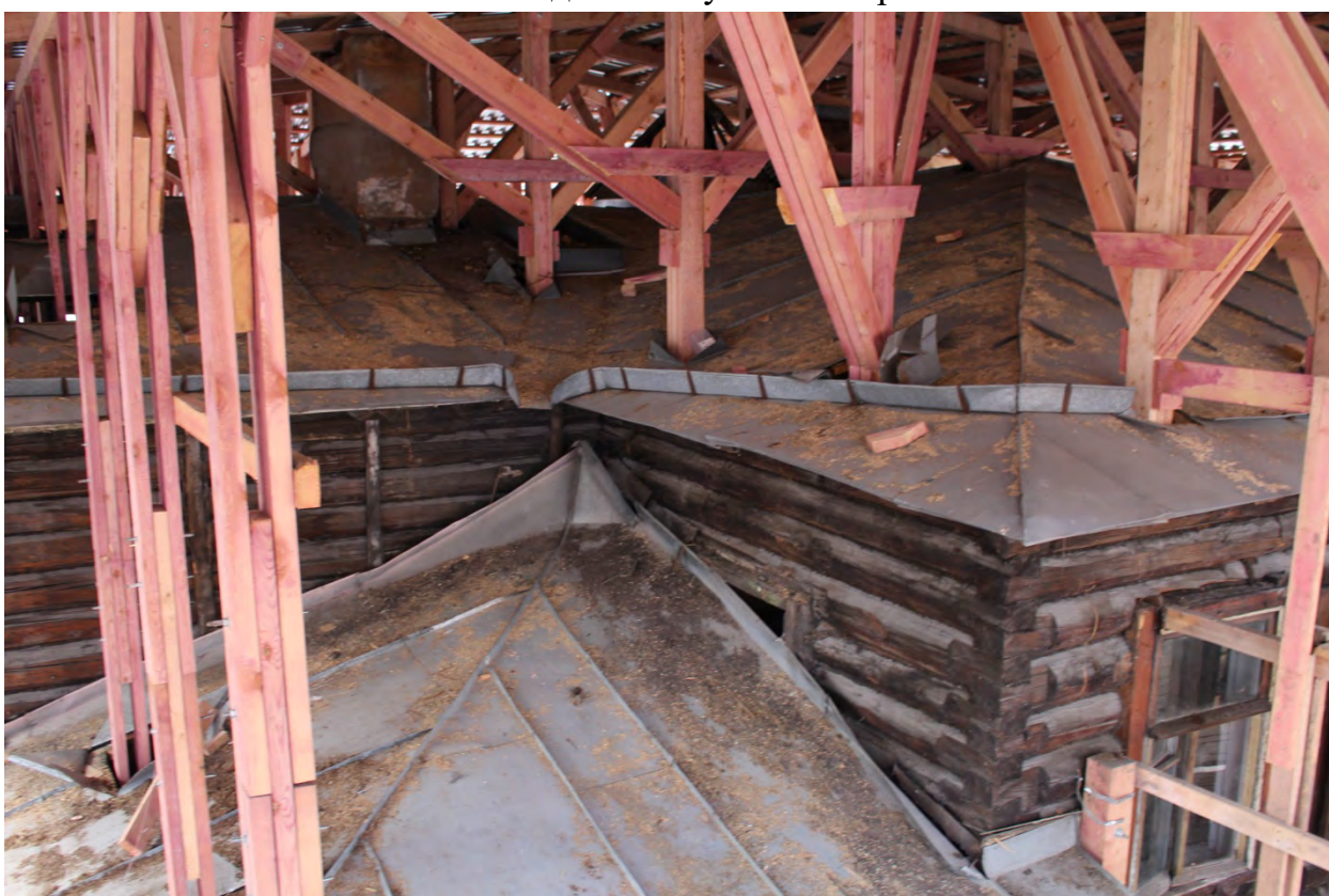
Фото74. Вид на кровлю основного объема с юга.
