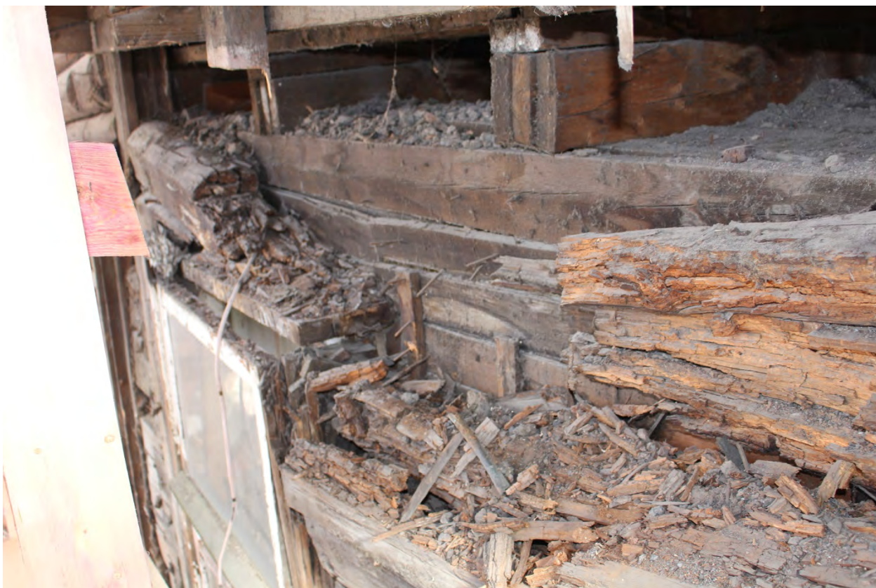
Фото 55. Фрагмент фасада в уровне второго этажа.
