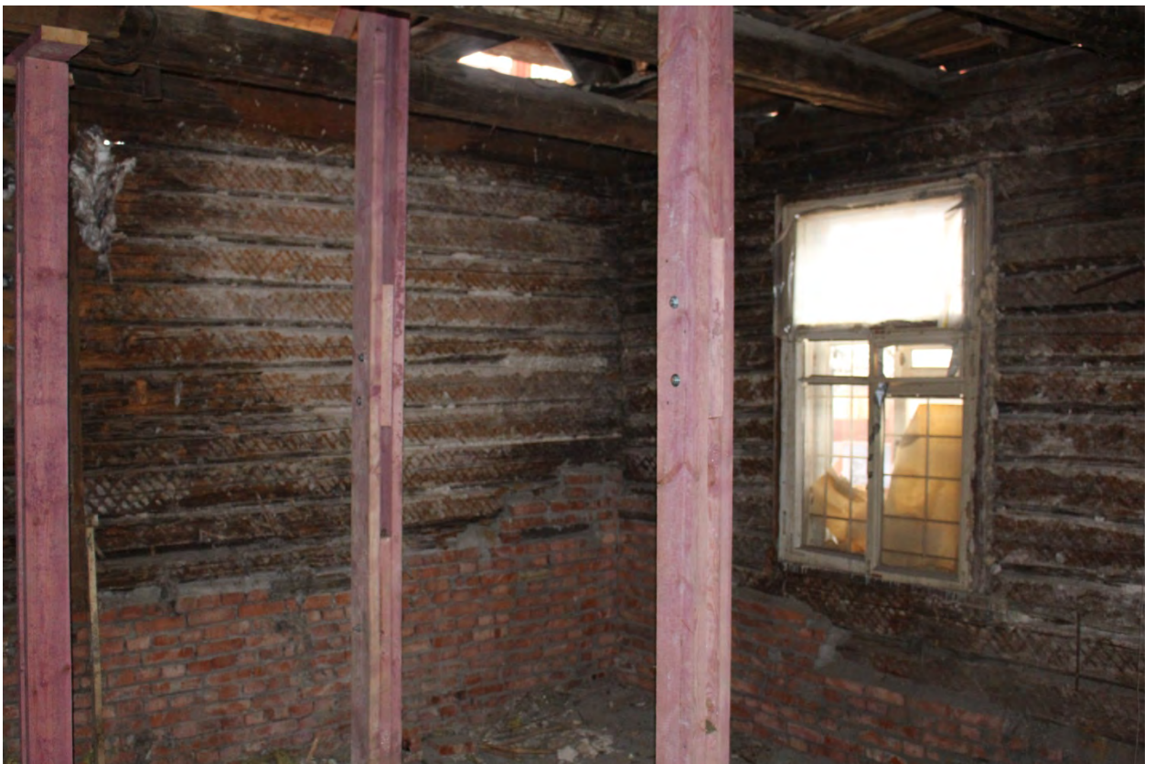
Фото 32. Южный угол здания.
