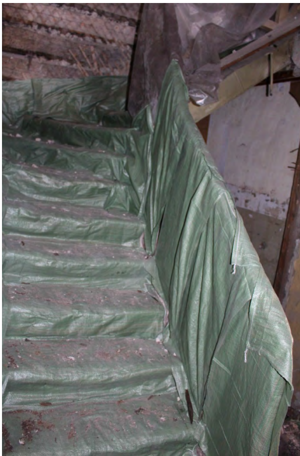
Фото 41. Лестница на второй этаж.
