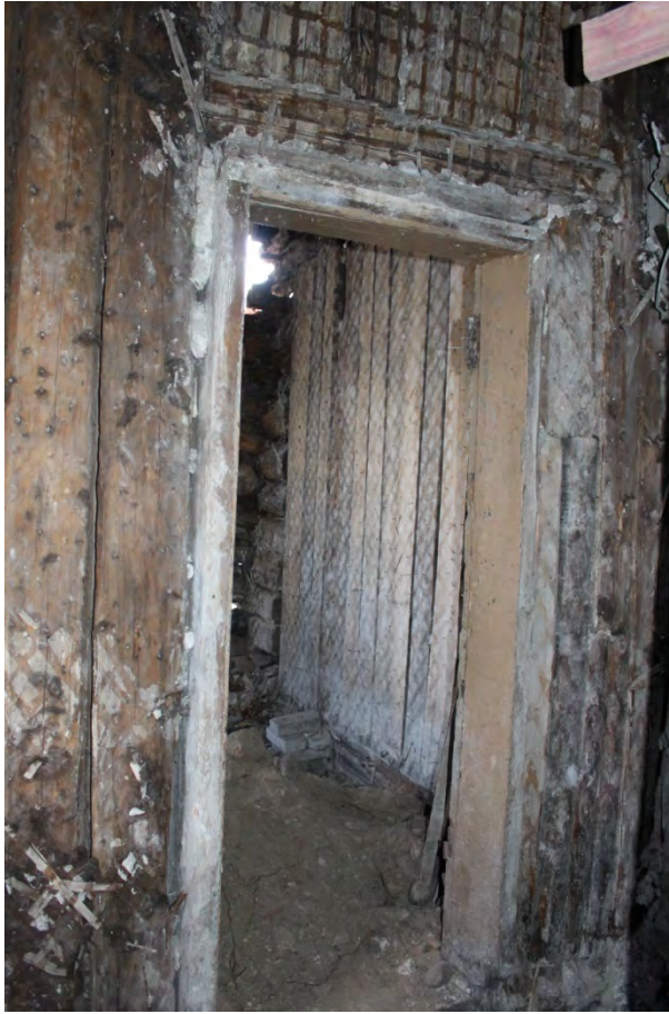
Фото 23. Вид в северное помещение.
