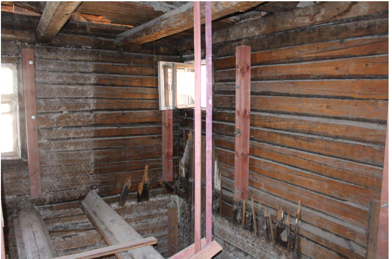
Фото 53. Помещения на востоке второго этажа.
