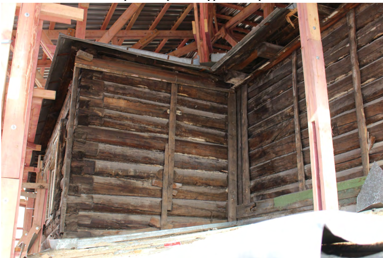
Фото 56. Вид на мезонин с северо-запада.
