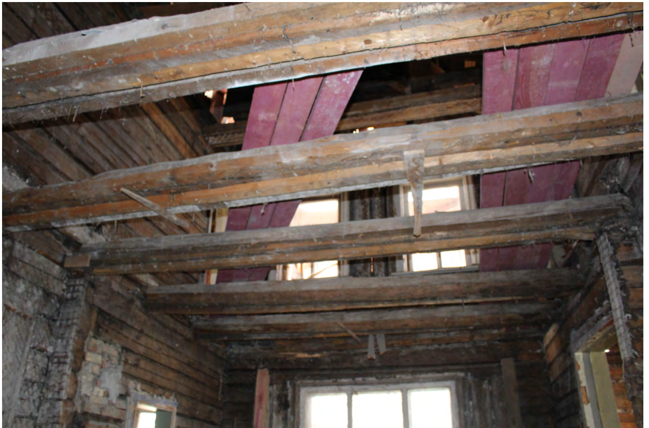
Фото 34. Элементы перекрытий над коридором.
