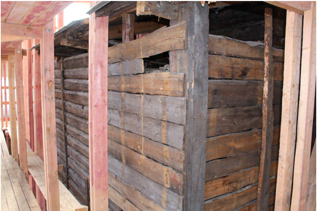
Фото 63. Вид на южную часть здания с востока.
