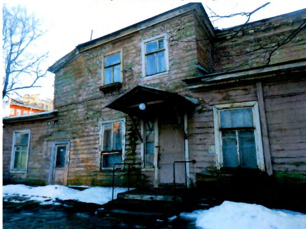
2. Северо-западный дворовый фасад
