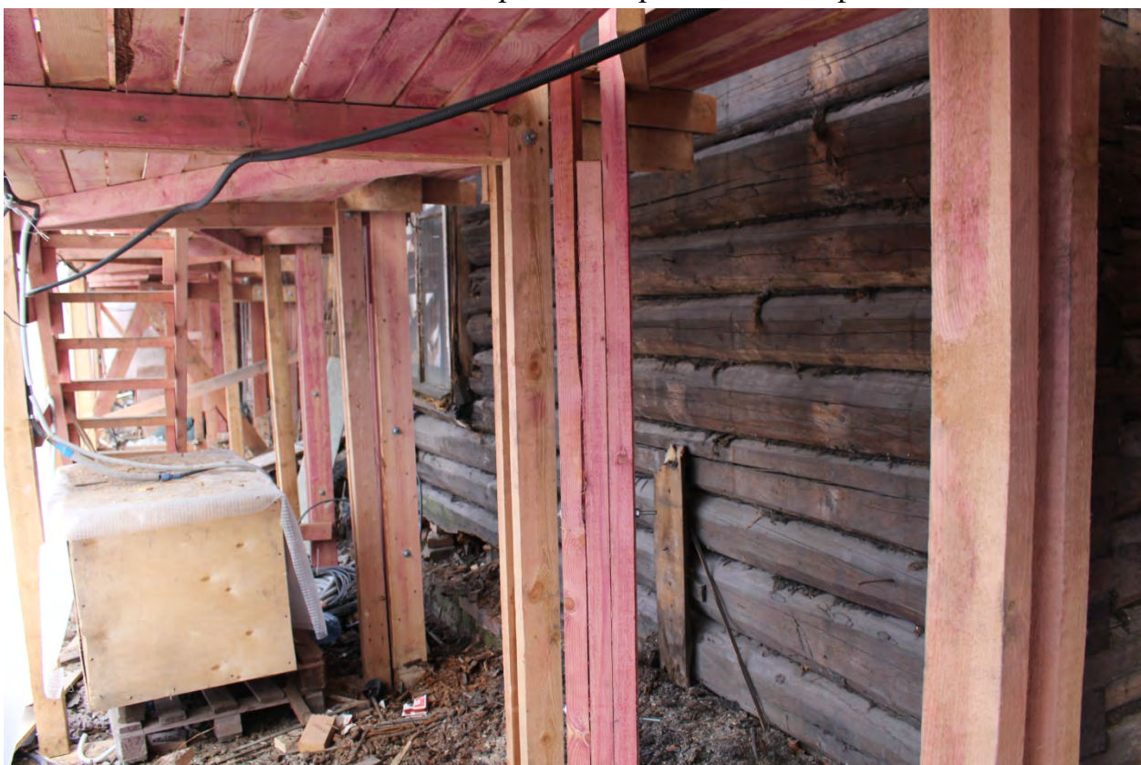
Фото 18. Вид вдоль северо-западного фасада.
