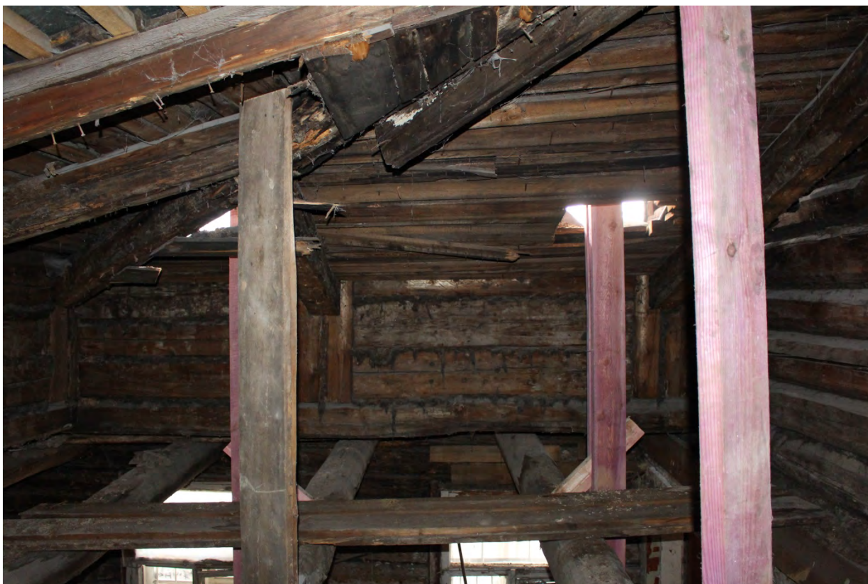
Фото 51. Чердак в южной части.
