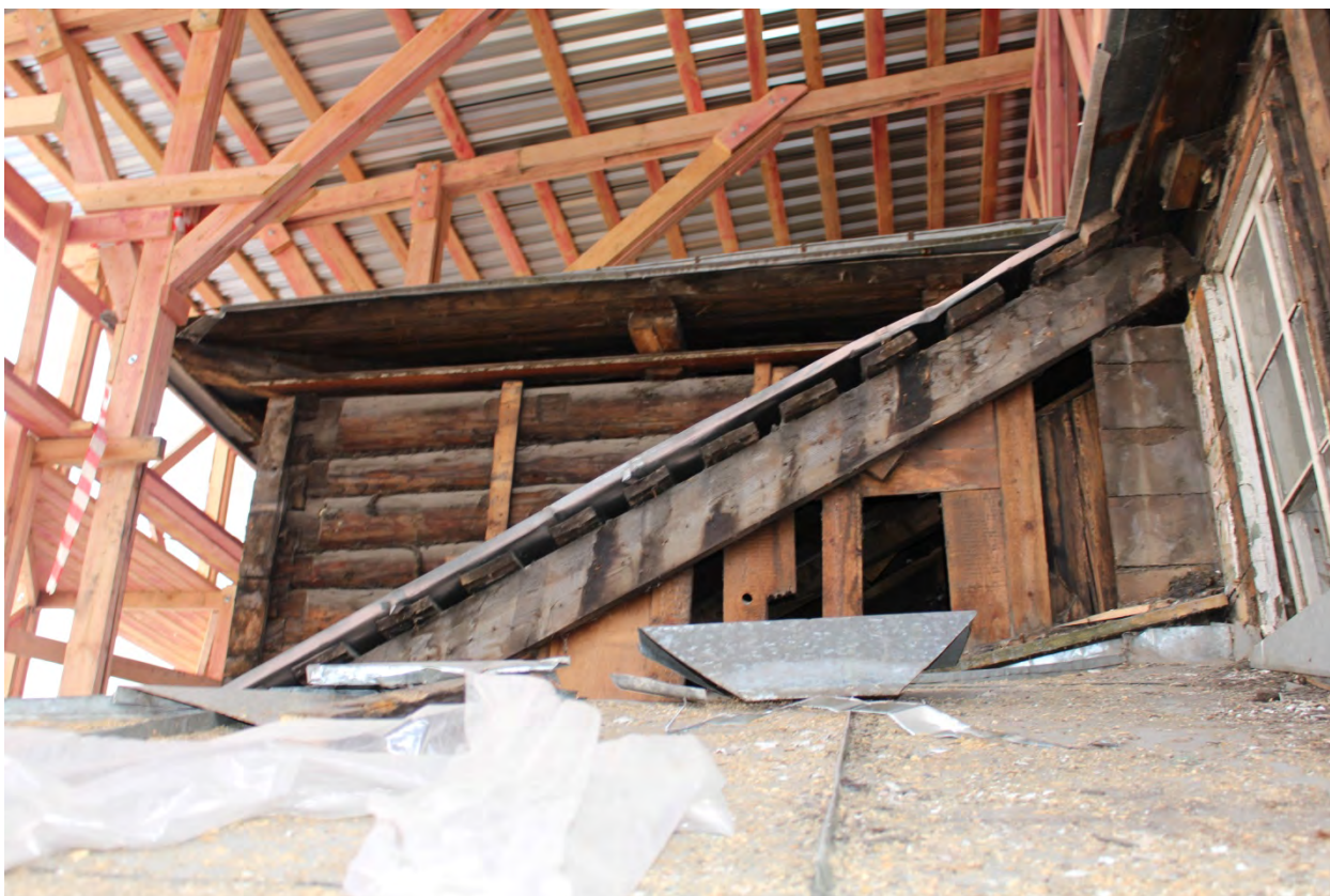
Фото 57. Вид на пристройку с северо-востока.
