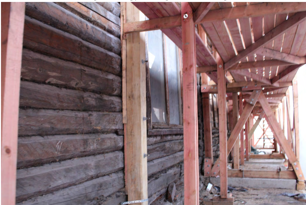
Фото 10. Вид северо-восточного фасада с юго-востока.
