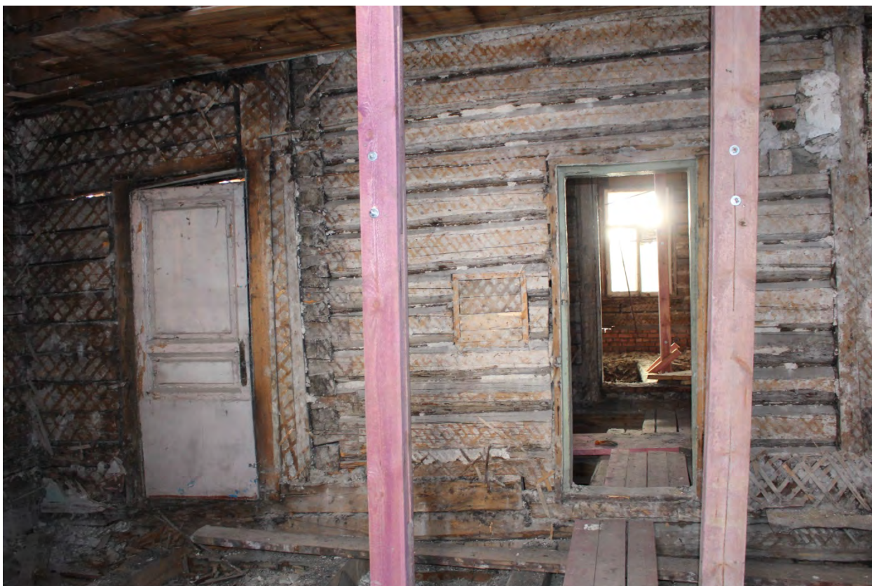
Фото 39. Проемы в стере между коридором и юго-восточными помещениями.
