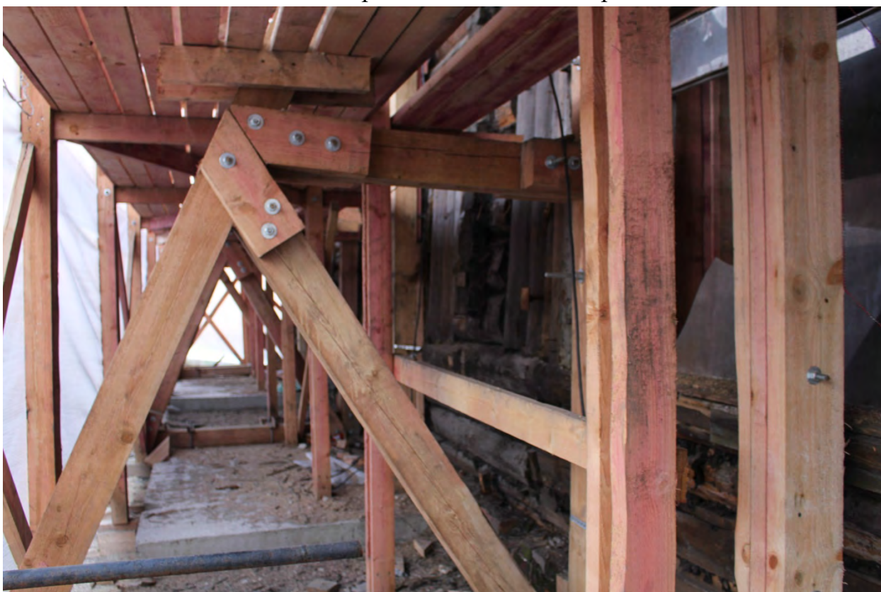
Фото 8. Вид вдоль северо-восточного фасада.
