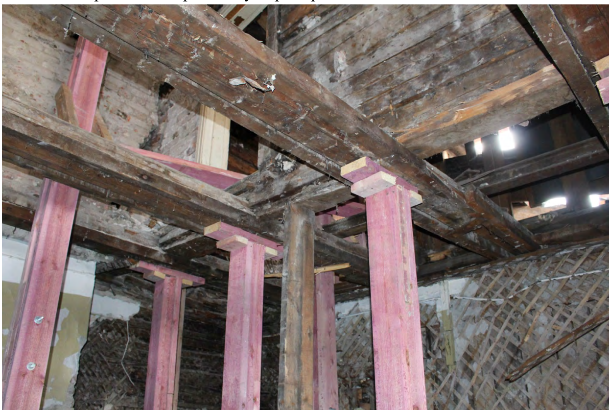
Фото 40. Фрагмент перекрытия в юго-восточной части.
