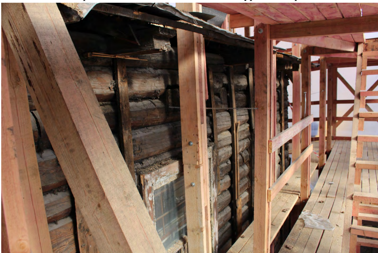
Фото 66. Вид вдоль восточной части здания в уровне второго этажа.
