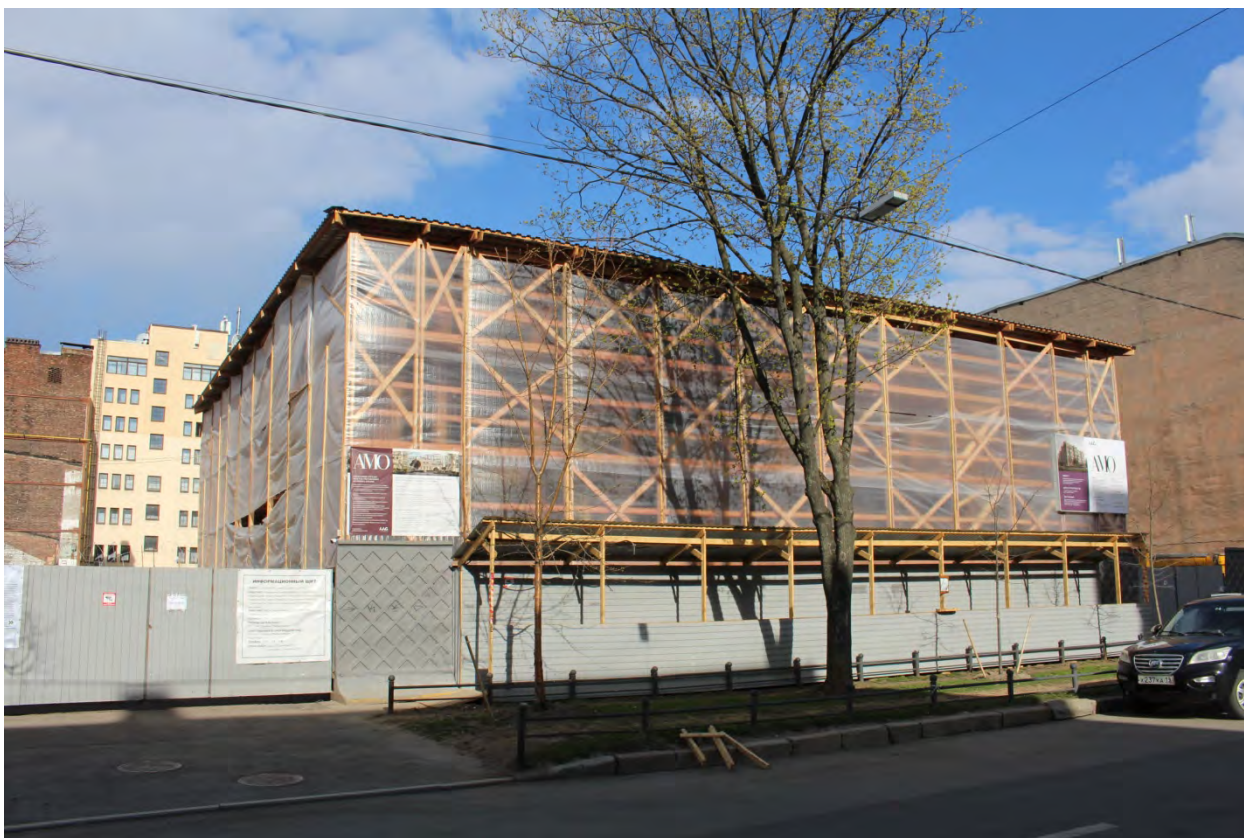
Фото 3. Общий вид с запада.
