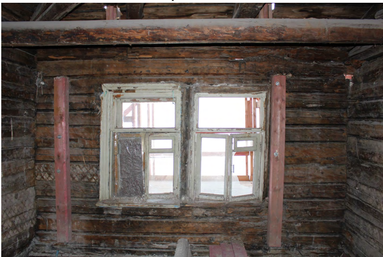
Фото 52. Проемы на северо-востоке второго этажа.
