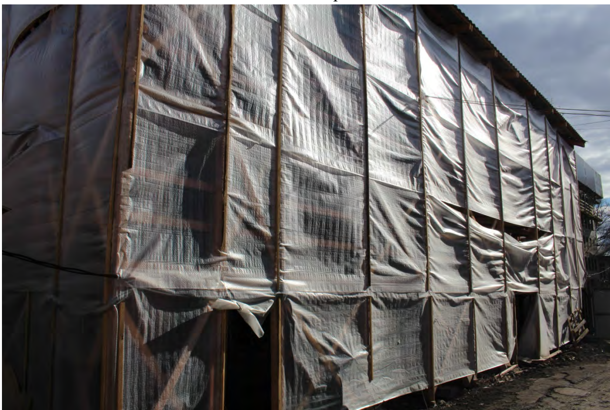
Фото 6. Вид с севера.
