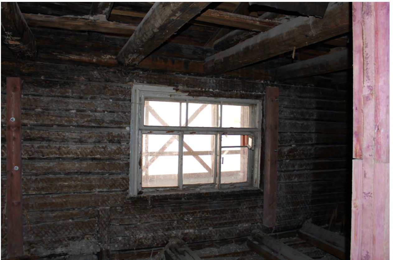
Фото 54. Проем на северо-восточном фасаде второго этажа.
