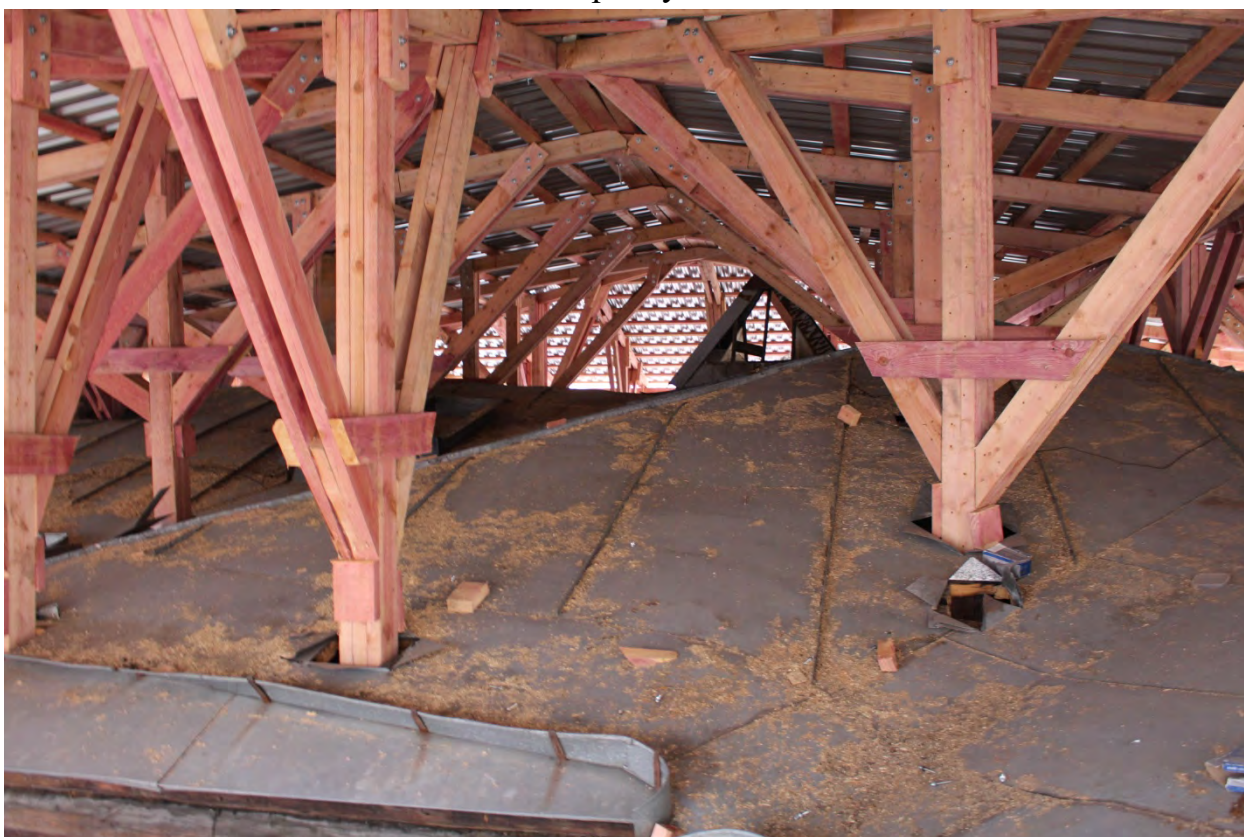
Фото 72. Вид на центральную часть кровли и фонарь.
