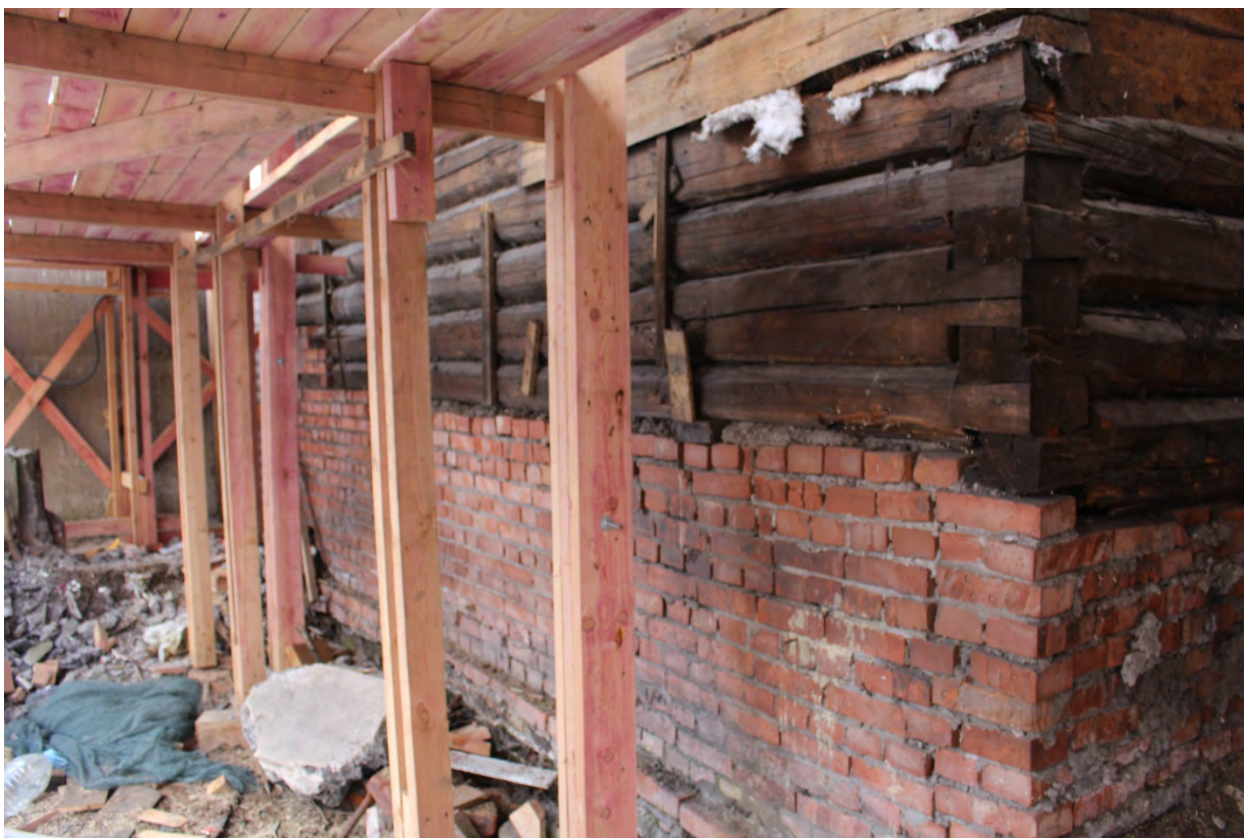
Фото 11. Фрагмент цоколя юго-восточного фасада.
