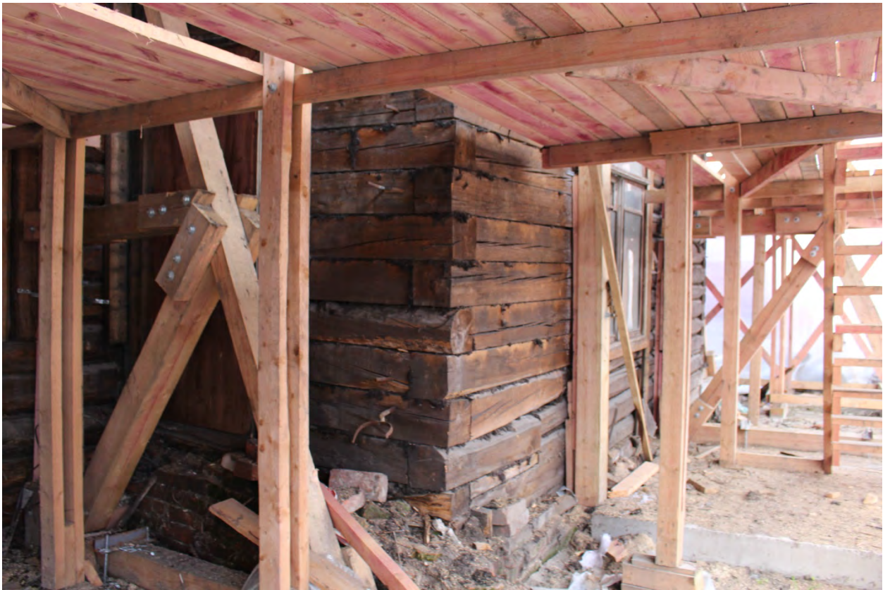
Фото 13. Угол юго-восточного фасада.
