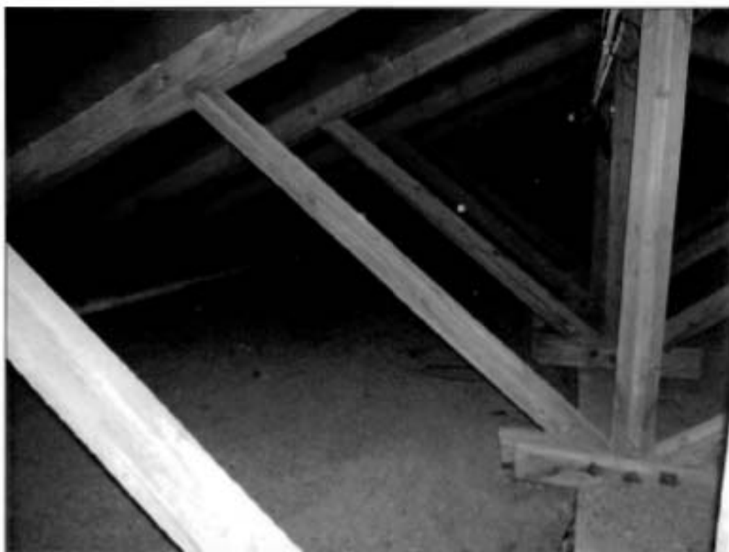
24. Стропильная система. Общий вид.
