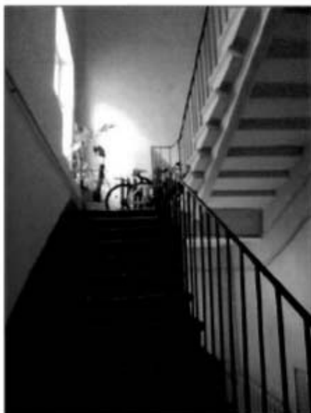
29. Подъезд № 2. Лестница. Общий вид.
