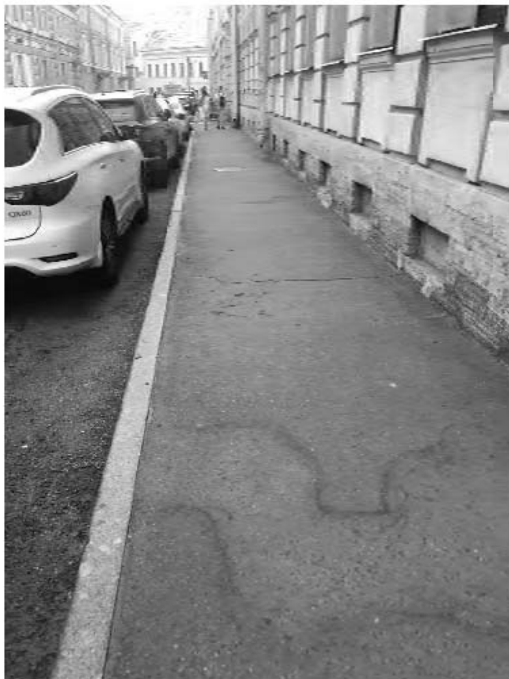
Фото №23. Общий вид на тротуар Биржевого пер. вдоль дома по адресу Биржевой пер. д. 1
