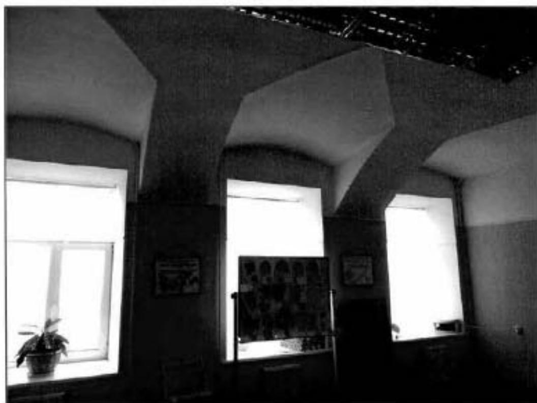
41. Помещение в уровне первого этажа.
