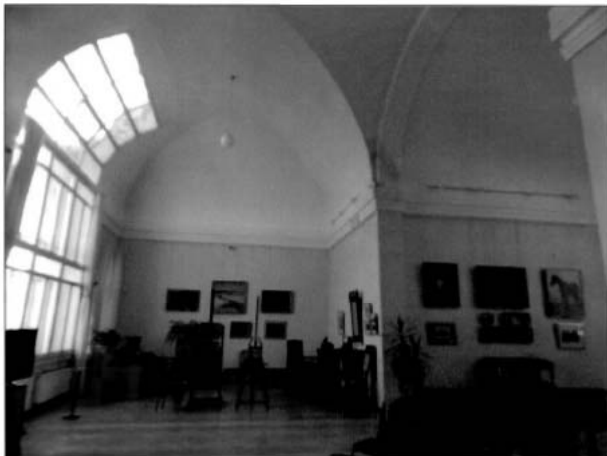
44. Помещение в уровне мансардного этажа.
