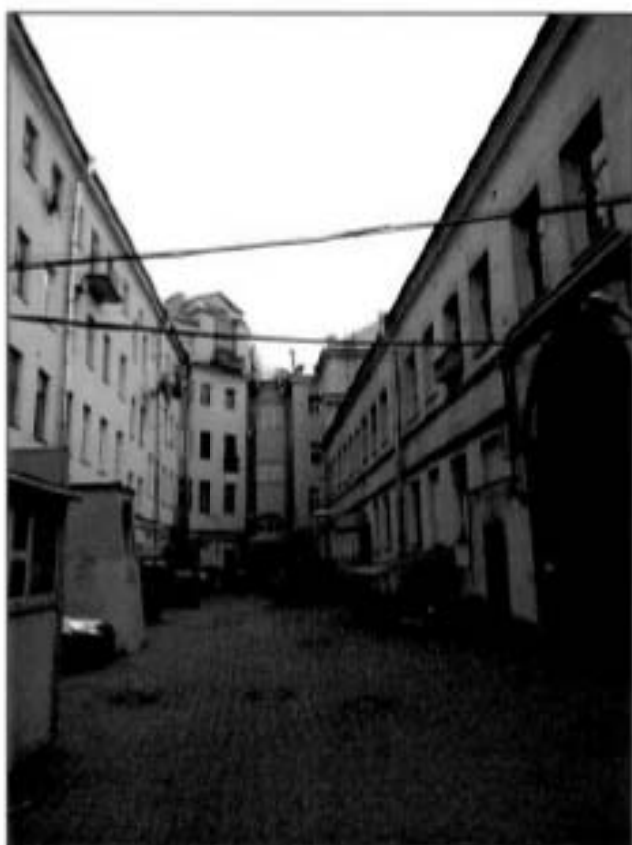
14. Внутренний двор. Вид с запада на восток.
