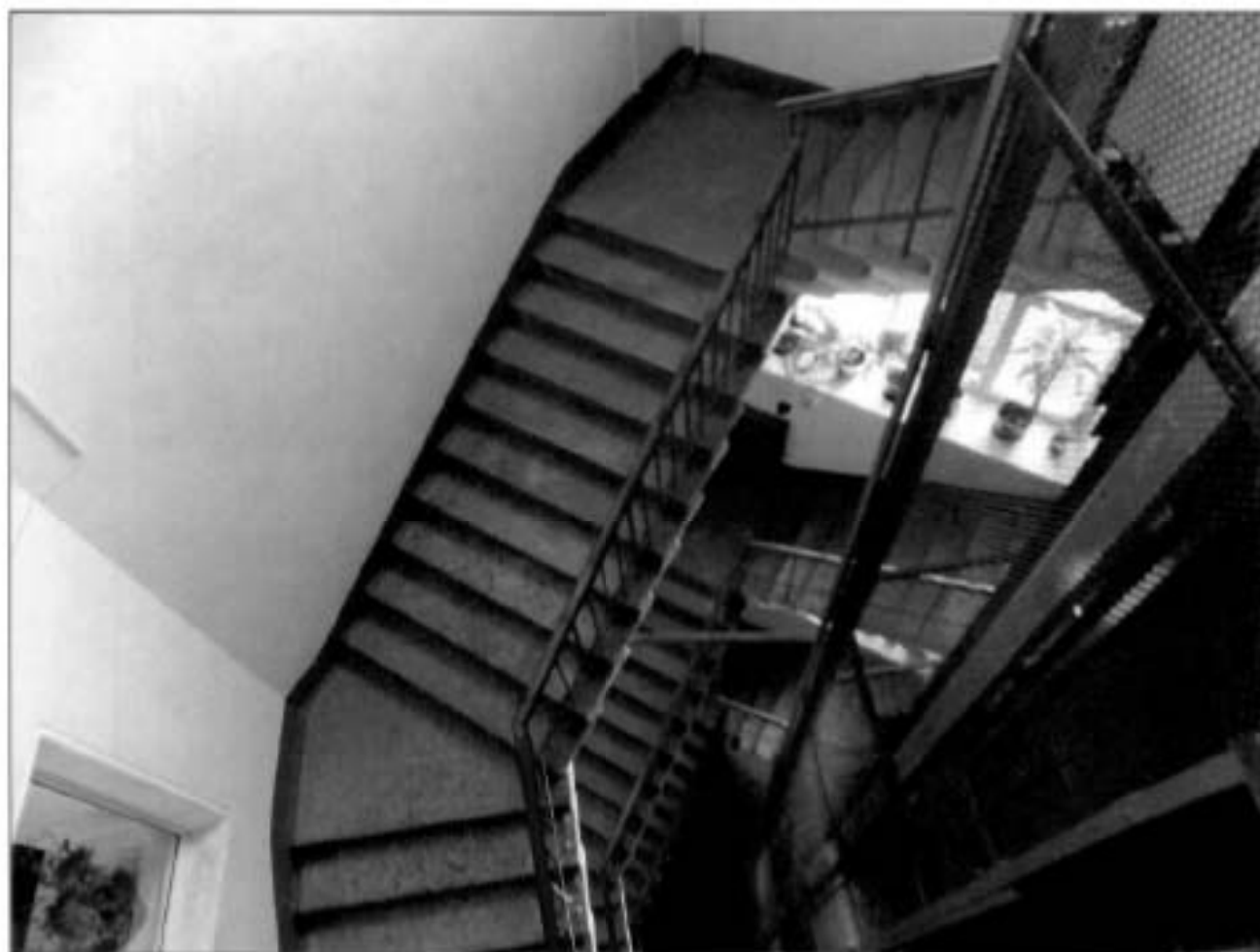
28. Подъезд № 1. Лестница. Общий вид.
