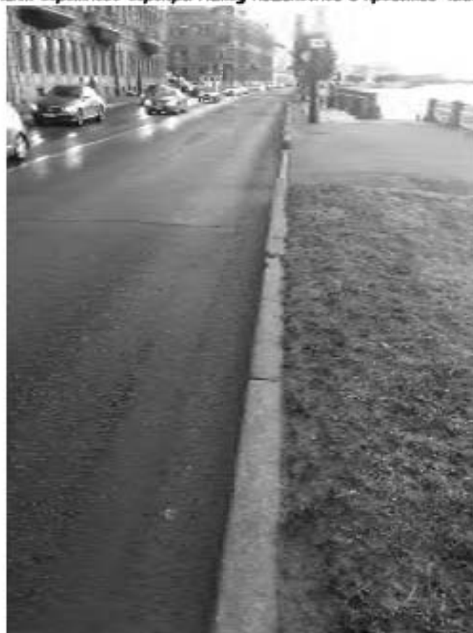
Фото №5. Фрагмент дорожного бордюра между пешеходной и проезжей частью с видом на Здание по адресу наб Макарова д. 10/1
