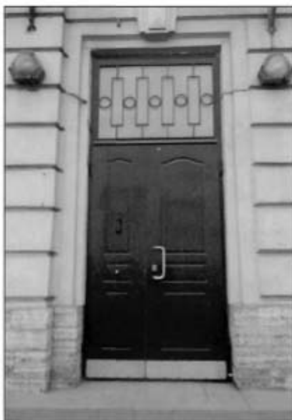
8. Северный фасад. Оформление дверного проема.
