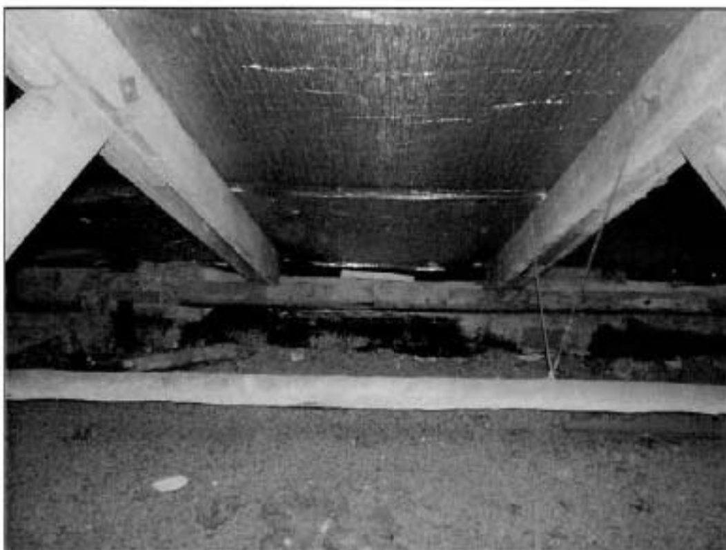
26. Стропильная система. Фрагмент.
