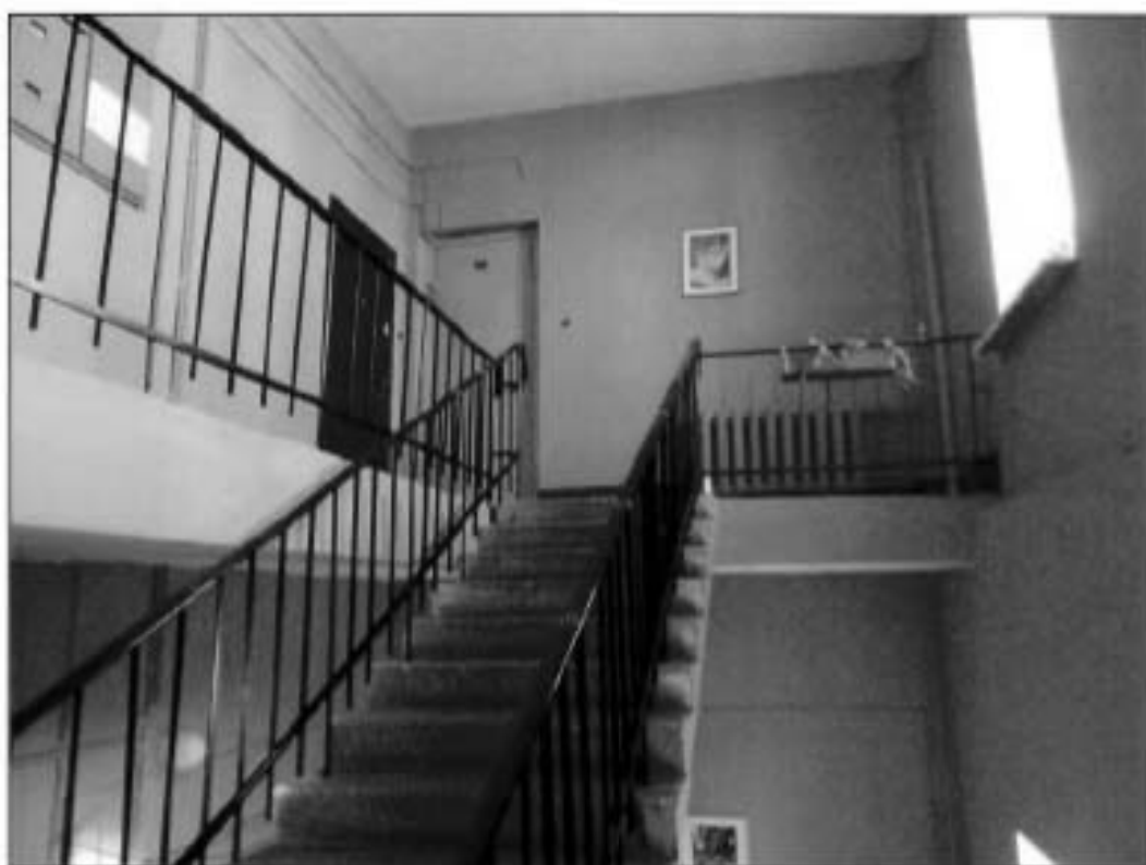
31. Подъезд № 4. Лестница. Общий вид.
