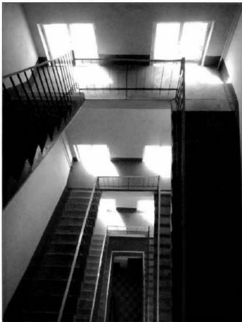
39. Подъезд № 10. Лестница. Общий вид.
