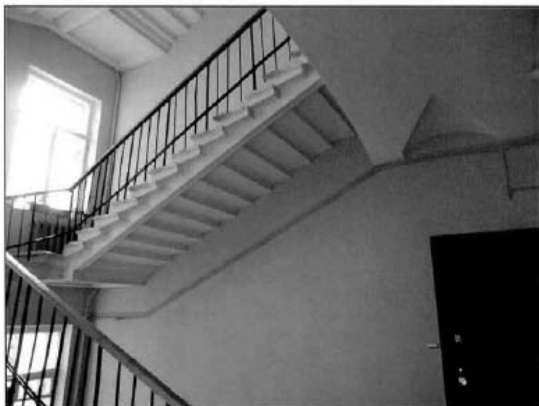
34. Подъезд № 7. Лестница. Общий вид.
