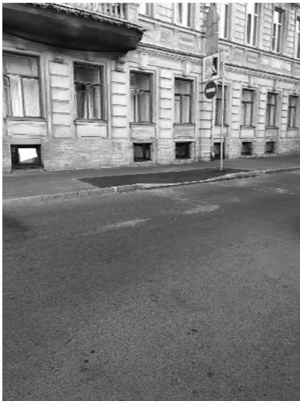
Фото №37 Фрагмент цоколя ограды по Вольскому пер
