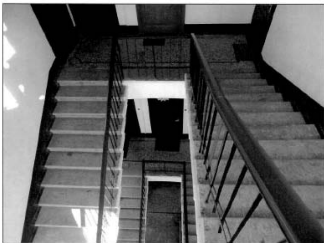
36. Подъезд № 8. Лестница. Общий вид.
