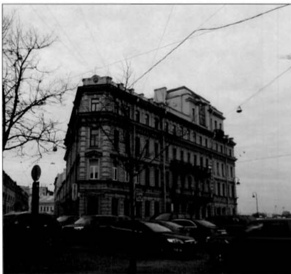
1. Общий вид с востока.
