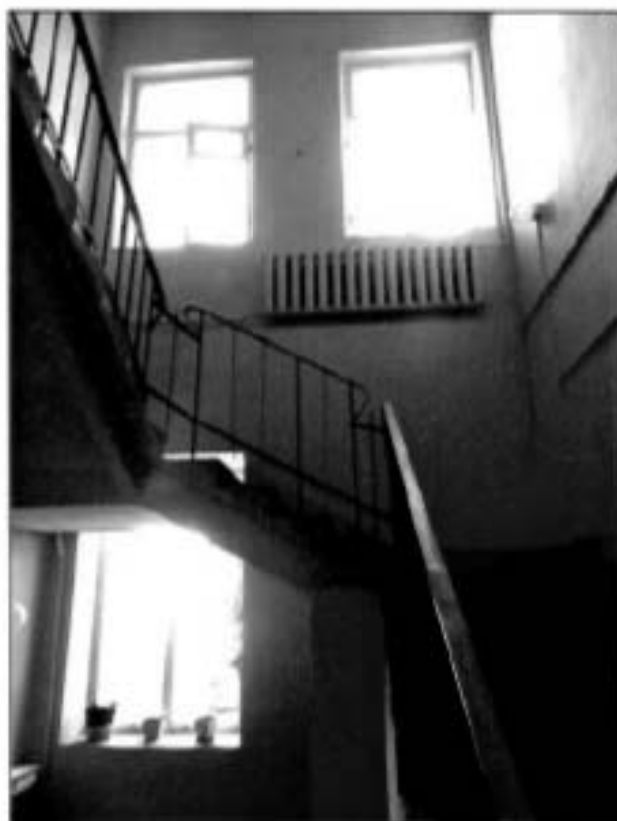
30. Подъезд № 3. Лестница. Общий вид.
