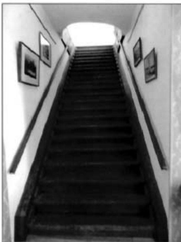
43. Внутрискладская деревянная лестница в уровне четвертого этажа.
