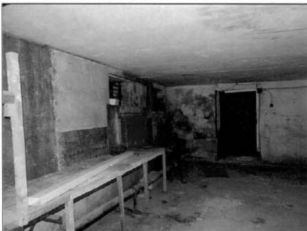
27. Помещение в уровне подвального этажа.
