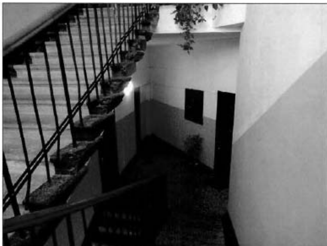
33. Подъезд № 6. Лестница. Общий вид.
