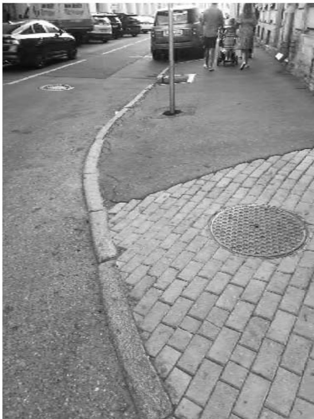
Фото №25. Фрагмент мощения пешеходного тротуара и проезжей части на перекрестке Биржевого пер и Биржевой линии у дома по адресу Биржевой пер. 1
