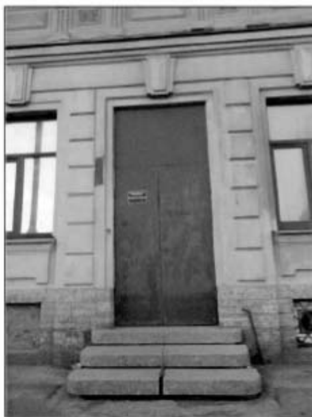
9. Северный фасад. Оформление дверного проема.
