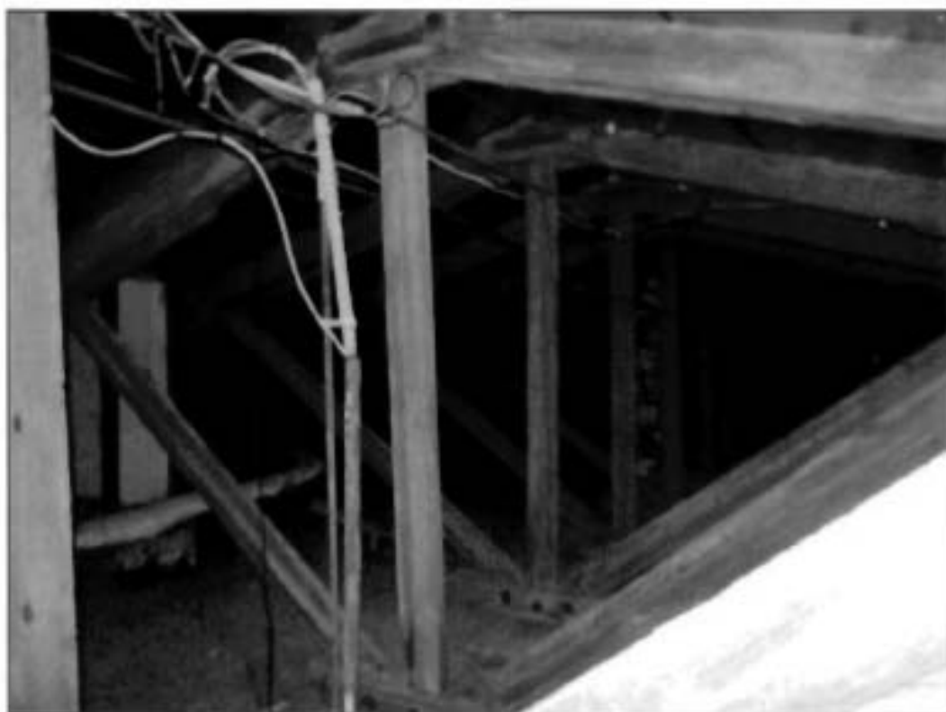
25. Стропильная система. Общий вид.
