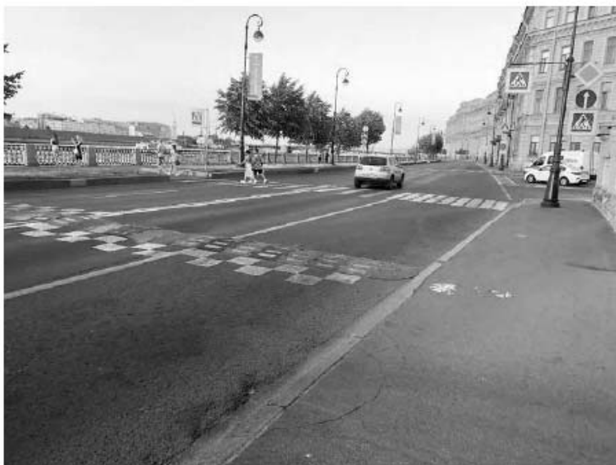
Фото №33 Общий вид на перекресток и пешеходную часть наб. Макарова и Волховского пер со стороны здания по адресу наб. Макарова д.12
