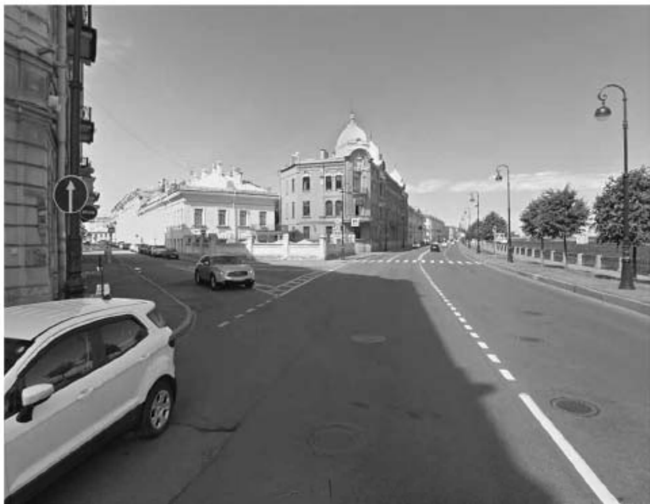
Фото №31 Общий вид на перекресток наб. Макарова и Волковского пер. со стороны дома по адресу Буржевая линия 16
