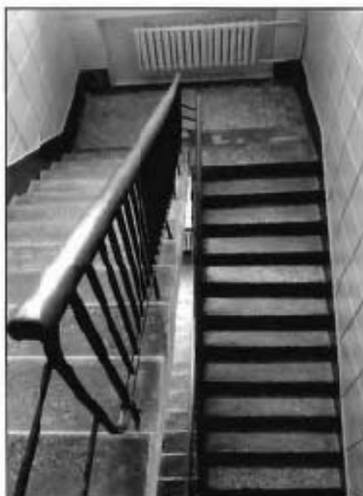
3. Центральная лестница. Общий вид.
