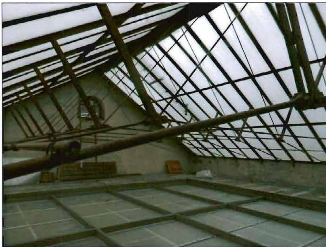
36. Металлические фермы над световым фонарем парадной лестницы.
