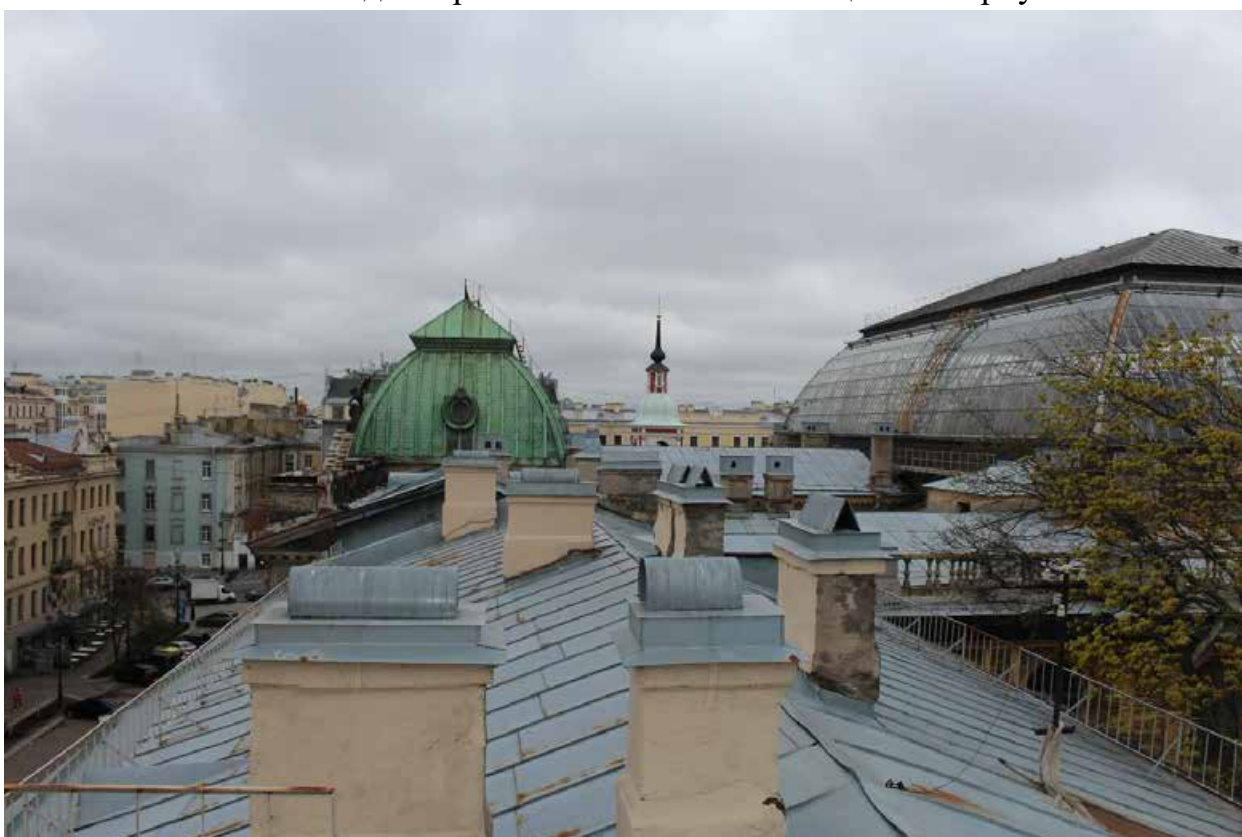
Фото 28. Вид на кровлю южной части лицевого корпуса.
