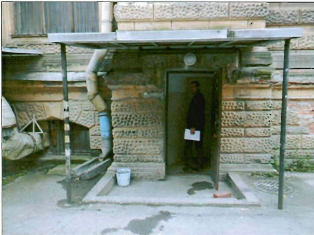
9. Северный дворовый фасад. Фрагмент.
