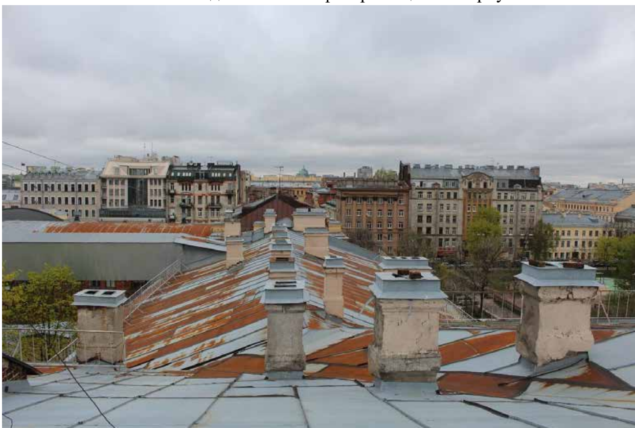
Фото 32. Вид на кровлю северной части лицевого корпуса.
