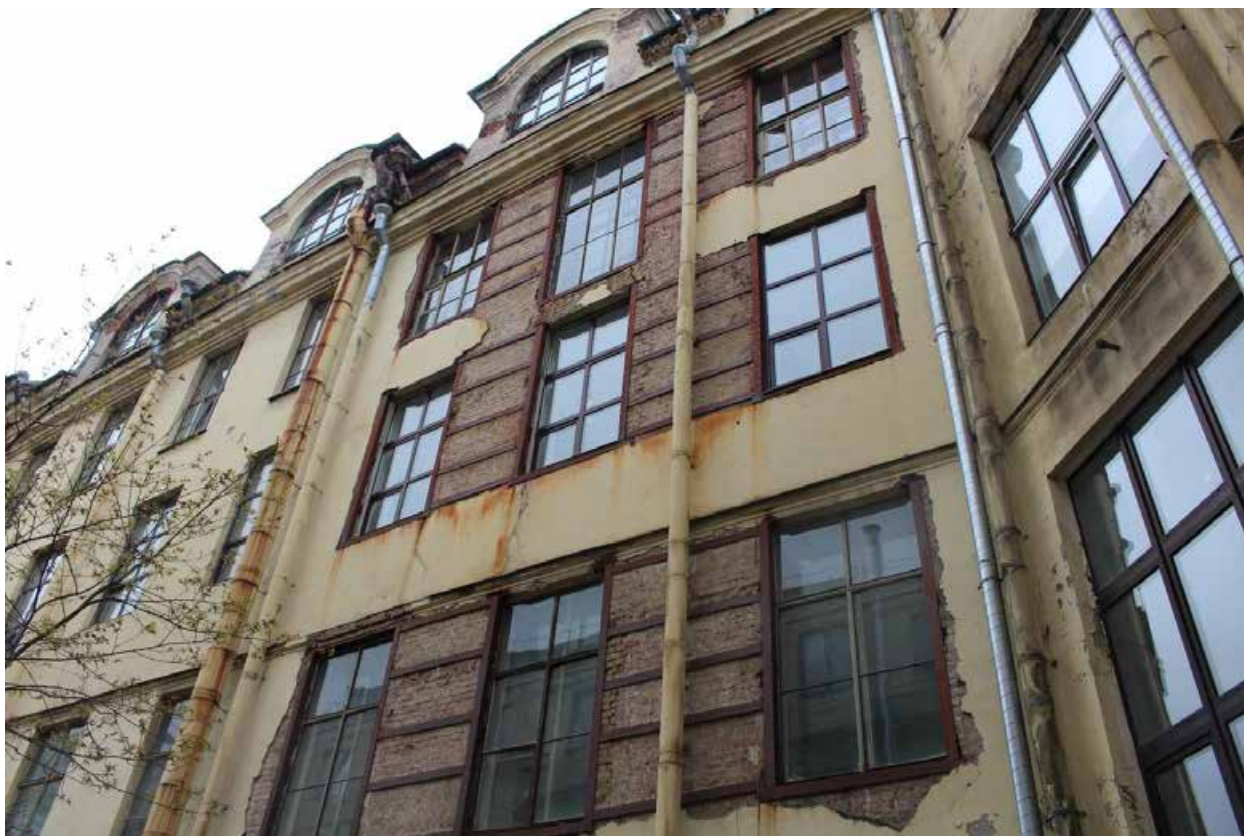
Фото 21. Вид на дворовый фасад четырехэтажного корпуса с мансардами в северном дворе.
