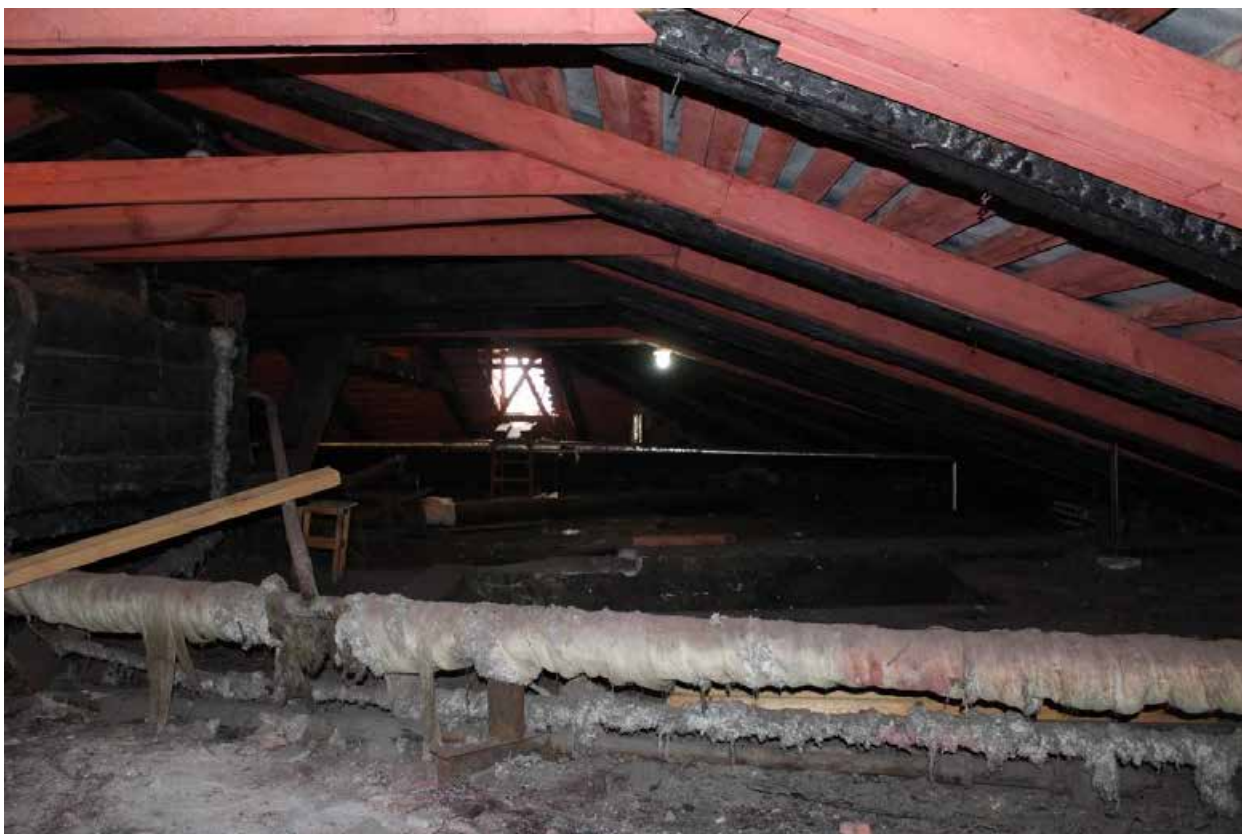
Фото 43. Вид на чердачные помещения пятиэтажного дворового корпуса.
