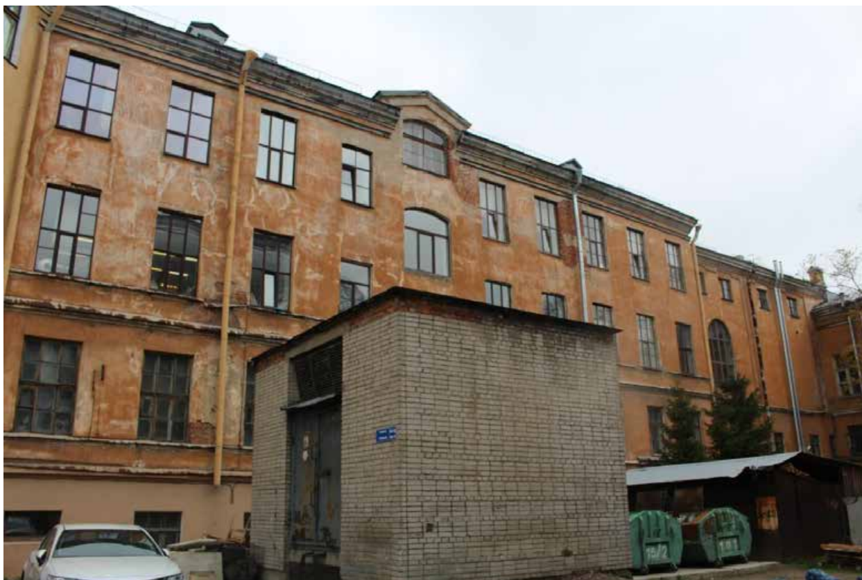
Фото 11. Вид на дворовый фасад четырехэтажного дворового корпуса в центральном дворе.
