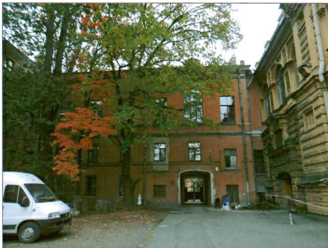
31. Восточный дворовый фасад. Общий вид.
