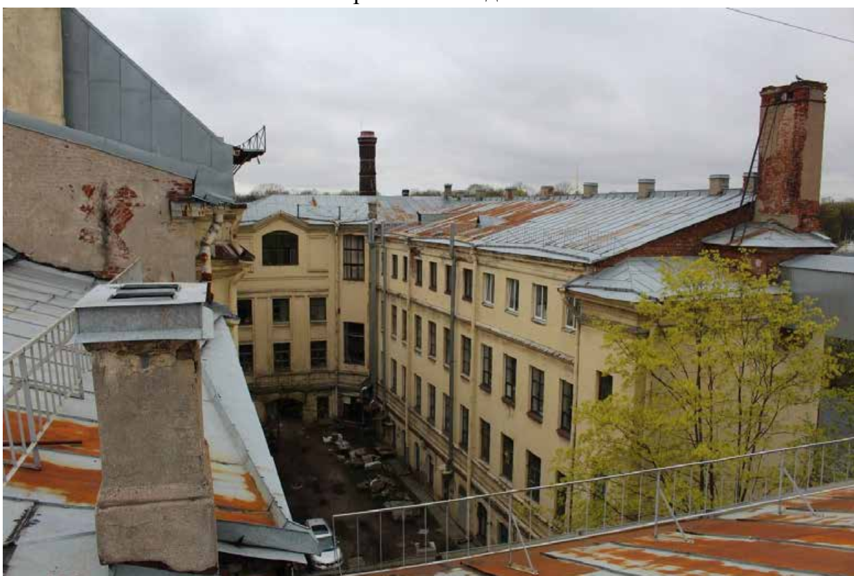
Фото 34. Вид на кровлю дворовых корпусов северного двора.
