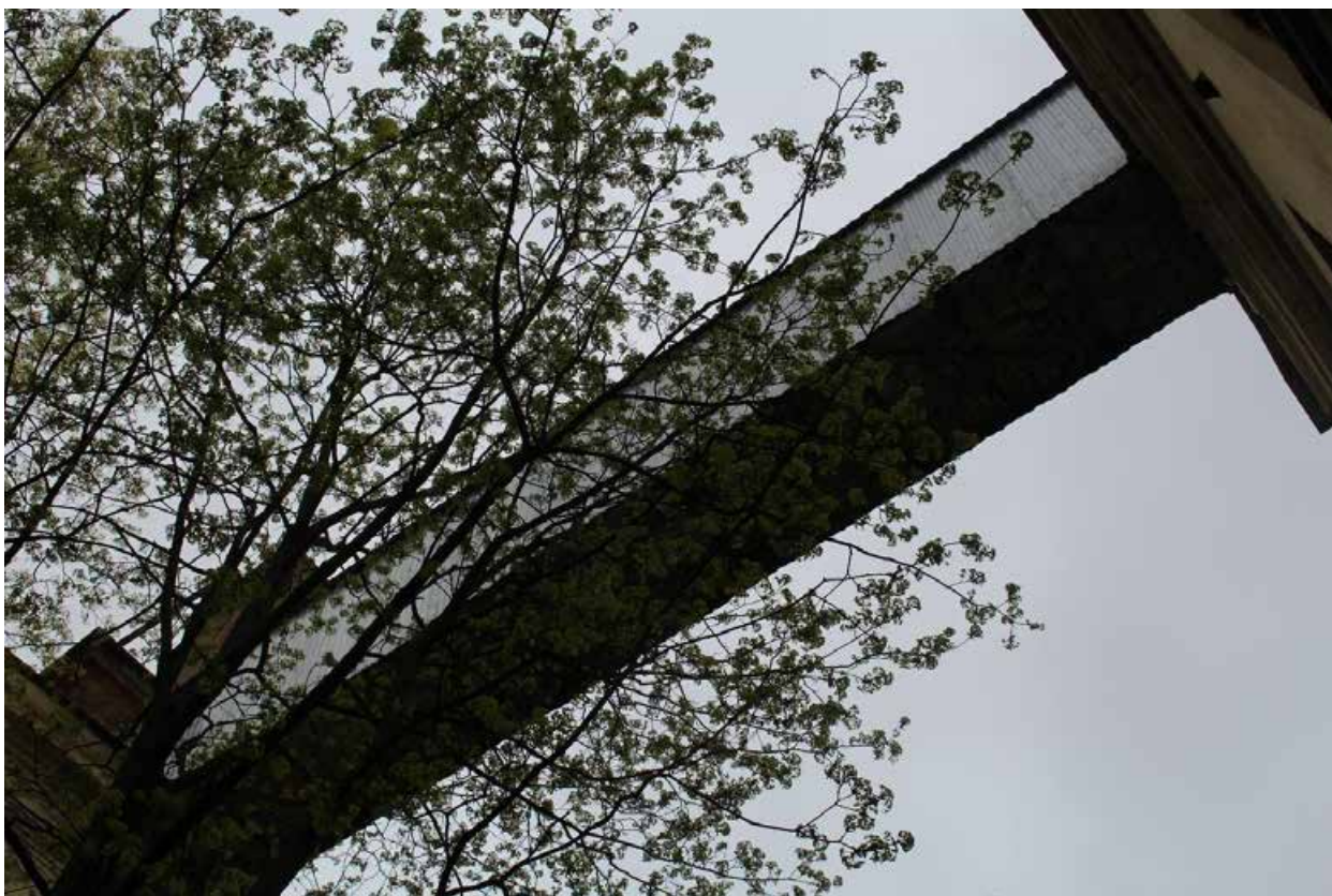
Фото 25. Вид на металлический переход между лицевым корпусом и дворовым корпусом в северной части здания.
