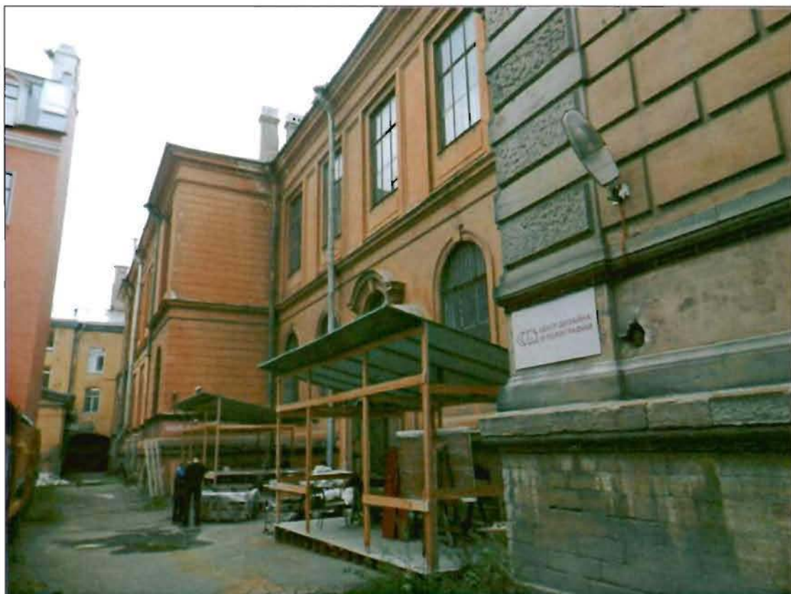
6. Южный дворовый фасад. Общий вид.
