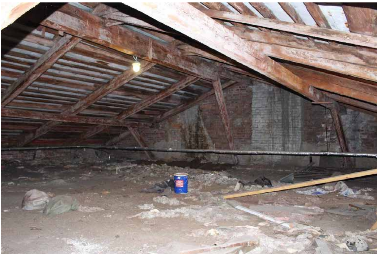
Фото 53. Вид на чердачные помещения южной части лицевого корпуса.
