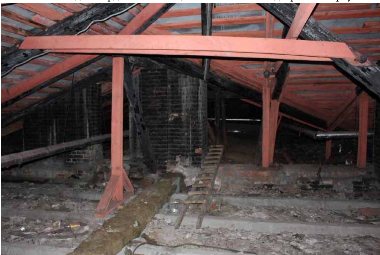
Фото 44. Вид на чердачные помещения пятиэтажного дворового корпуса.
