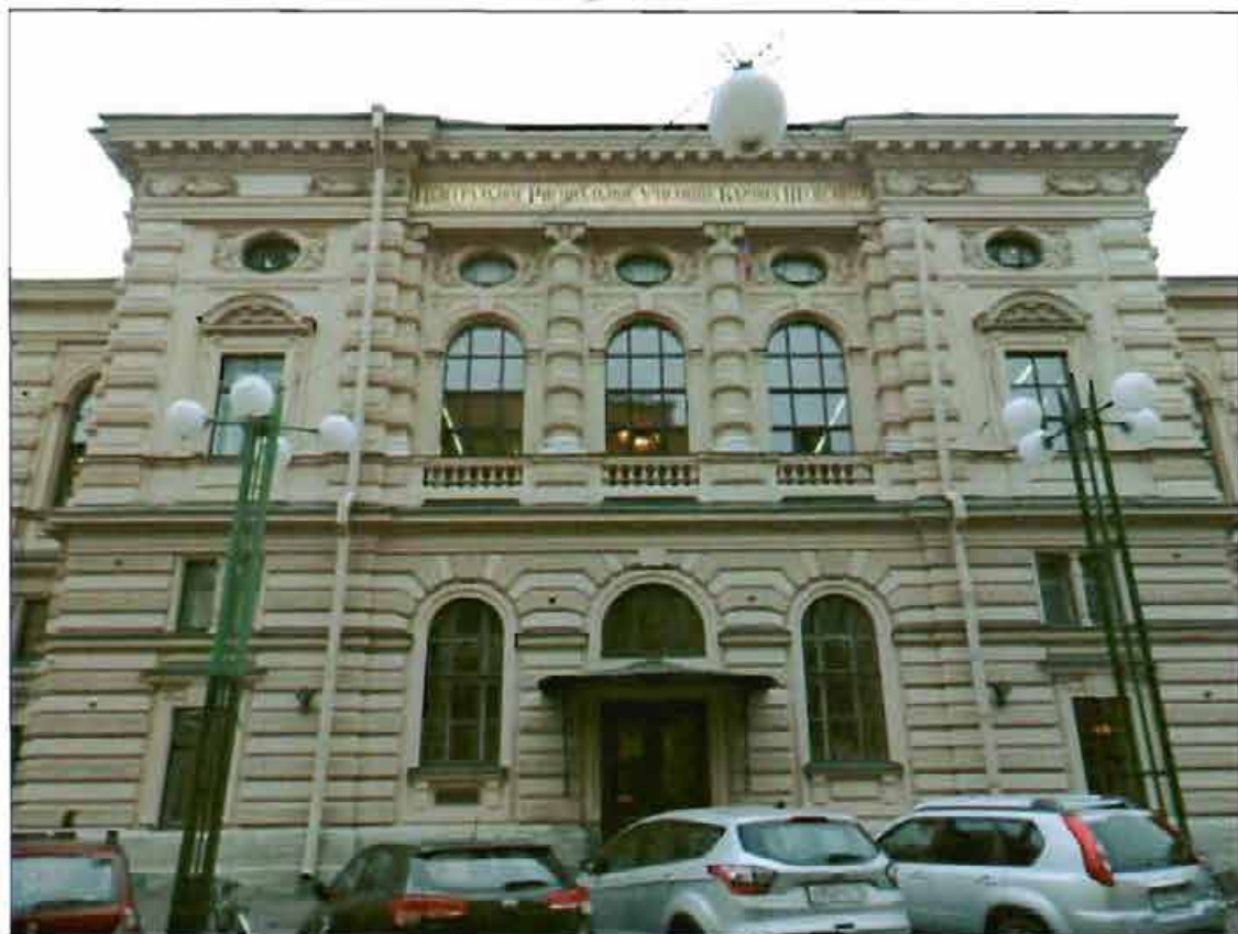
29. Лицевой фасад. Центральный ризалит.
