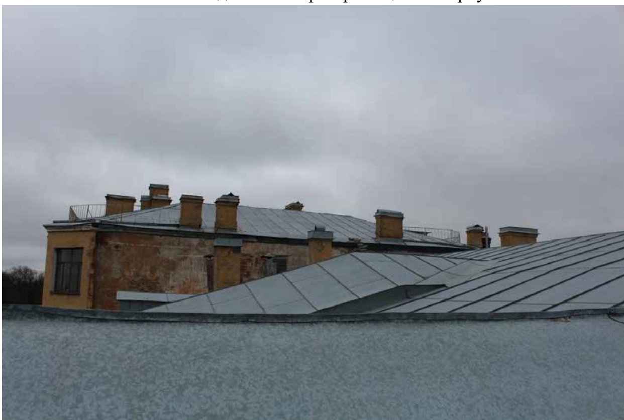
Фото 30. Вид на кровлю четырехэтажного дворового корпуса, примыкающего к центральной части лицевого корпуса.
