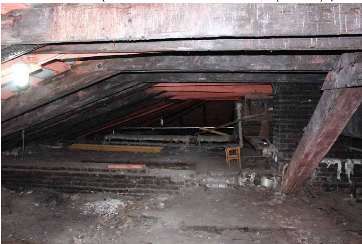
Фото 42. Вид на чердачные помещения пятиэтажного дворового корпуса.
