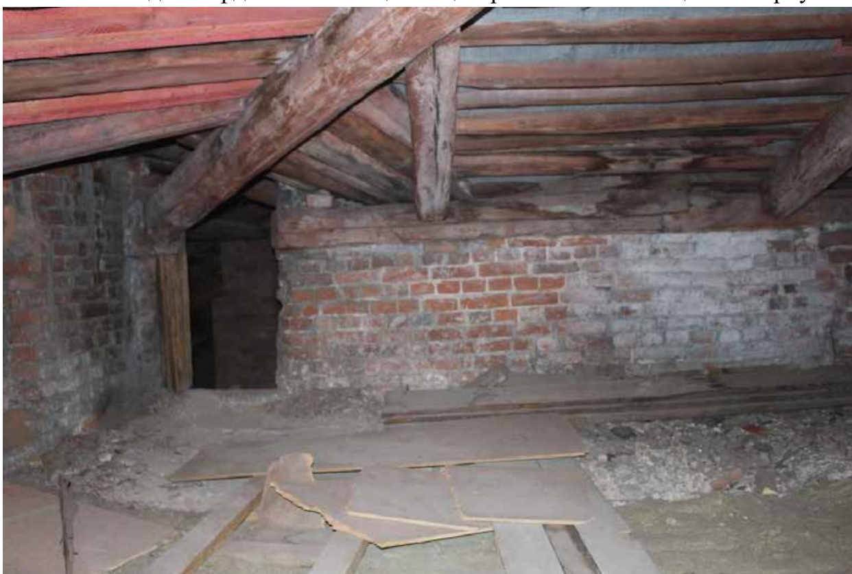
Фото 58. Вид на чердачные помещения центральной части лицевого корпуса.
