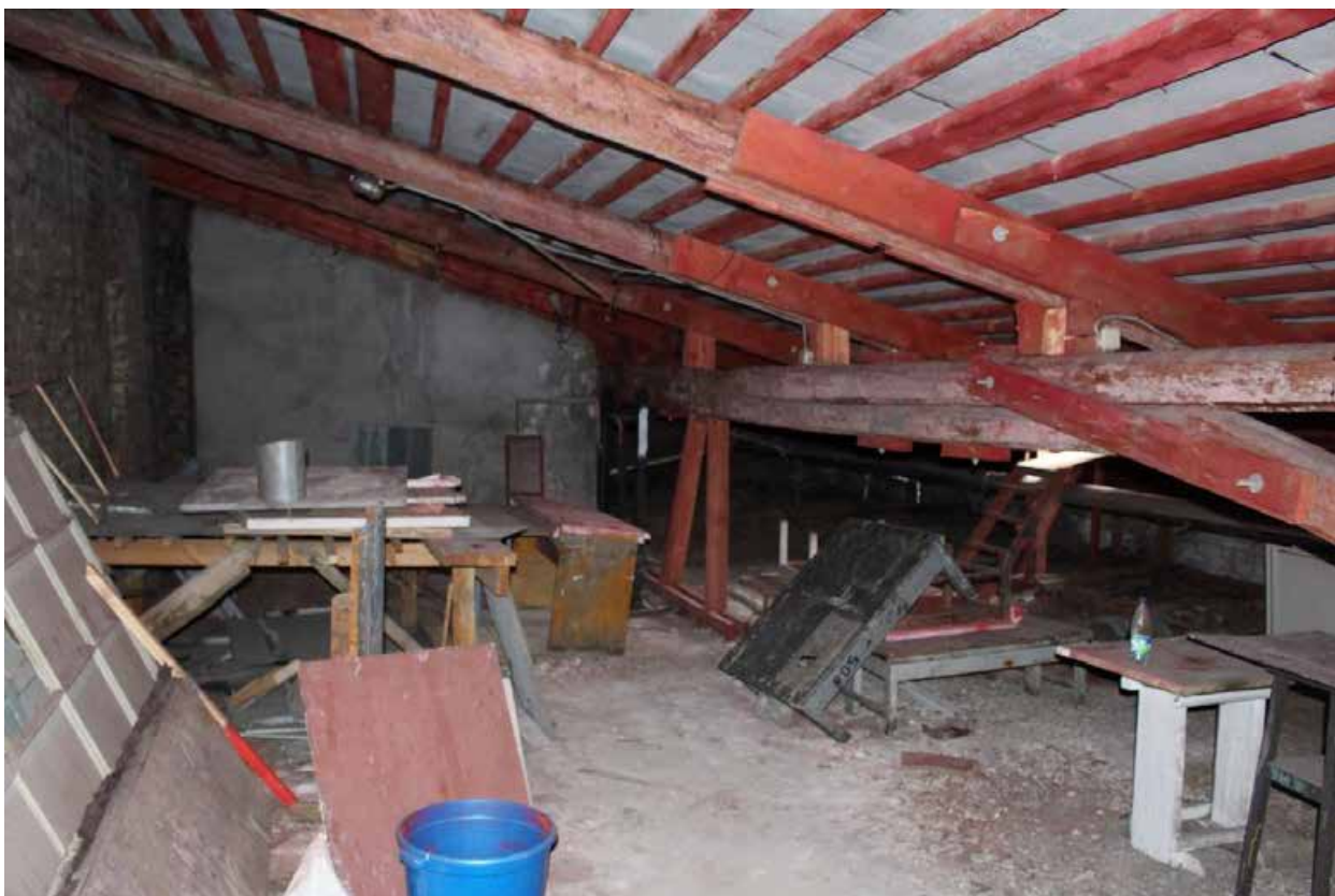
Фото 37. Вид на чердачные помещения в восточной части четырехэтажного дворового корпуса, примыкающего к центральной части лицевого корпуса.
