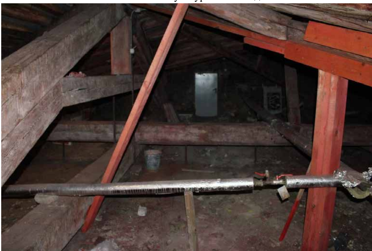
Фото 50. Вид на чердачные помещения дворового корпуса в северо-западной части объекта культурного наследия.
