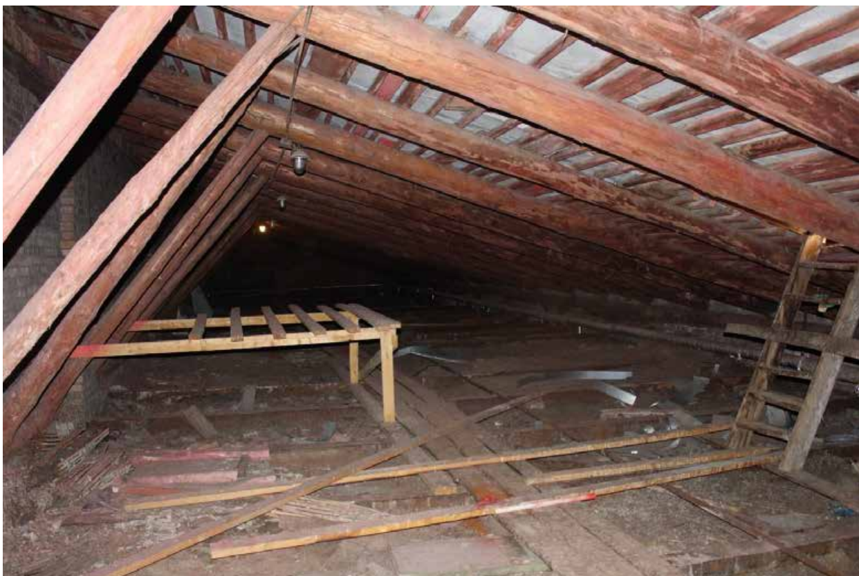
Фото 65. Вид на чердачные помещения северного дворового корпуса, расположенного в северном дворе.
