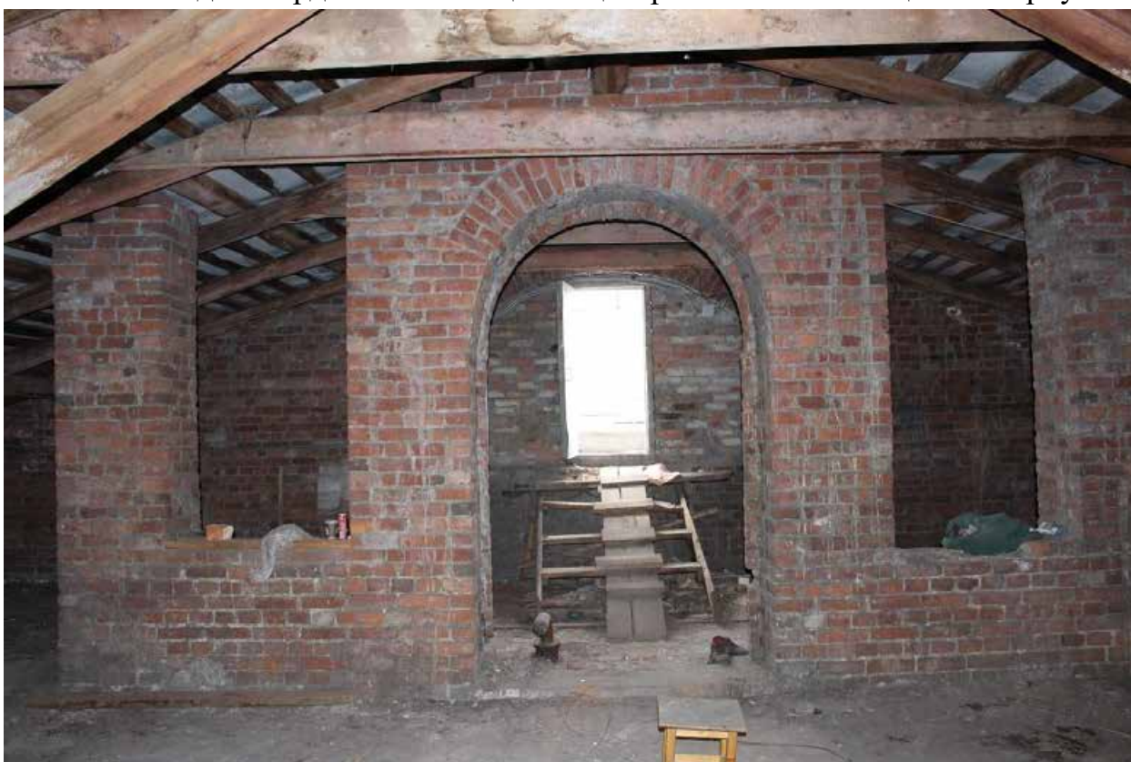
Фото 60. Вид на чердачные помещения центральной части лицевого корпуса.
