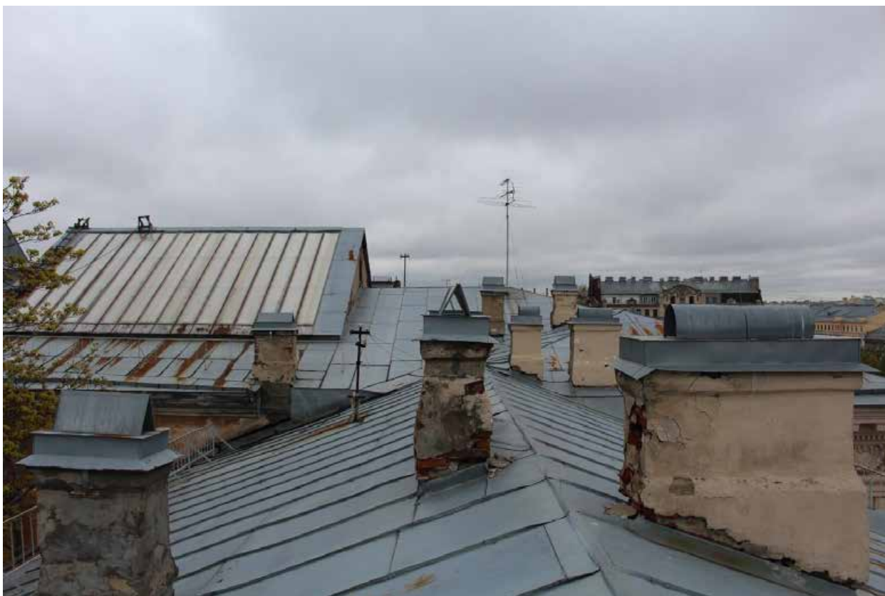
Фото 27. Вид на кровлю с южной части лицевого корпуса.
