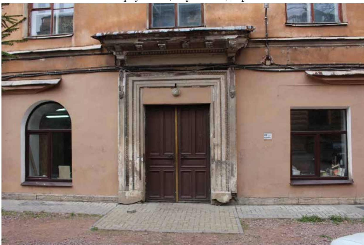
Фото 10. Вид на портал входа в дворовый корпус в центральном дворе.
