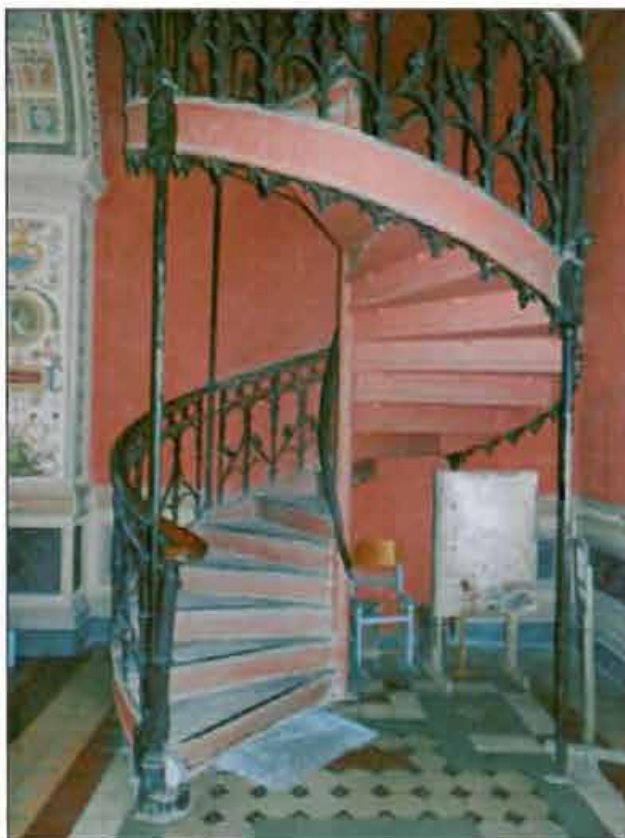
18. Помещение № 1-Н (285). Лестница.
