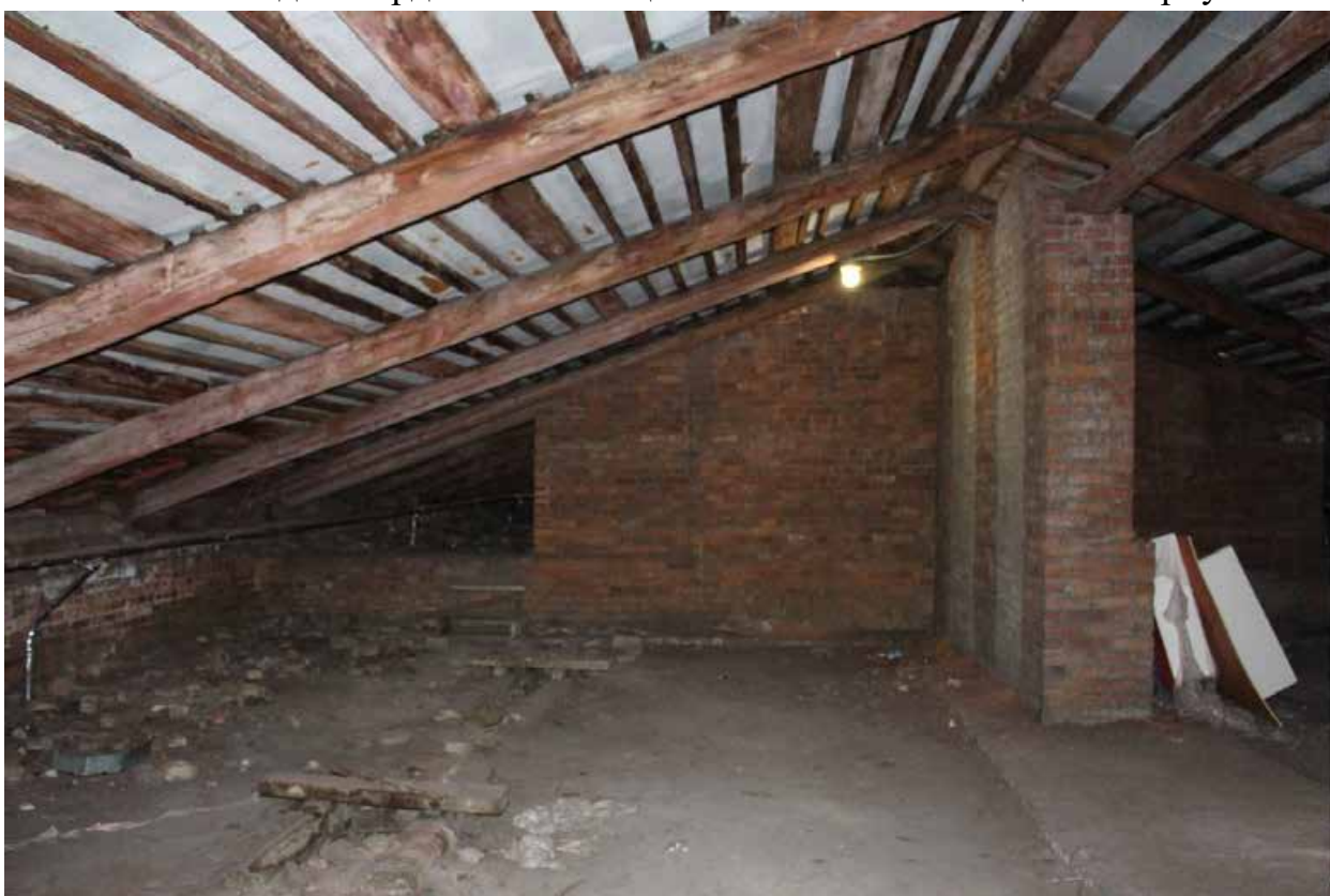
Фото 52. Вид на чердачные помещения южной части лицевого корпуса.
