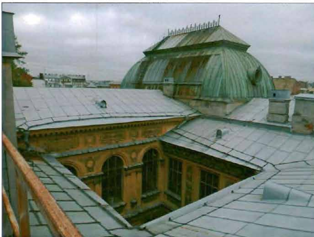
12. Купол над лицевым корпусом. Общий вид.
