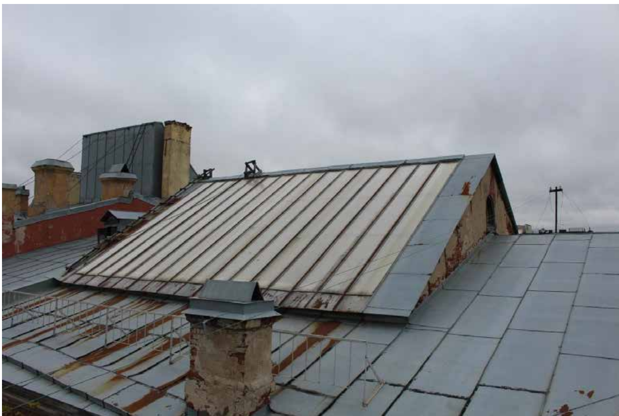
Фото 29. Вид световой фонарь лицевого корпуса.
