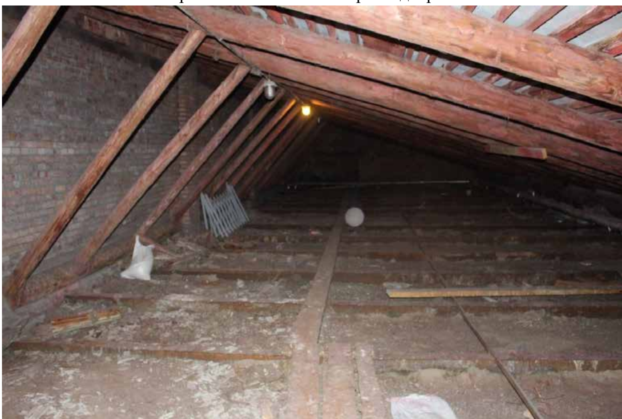
Фото 66. Вид на чердачные помещения северного дворового корпуса, расположенного в северном дворе.
