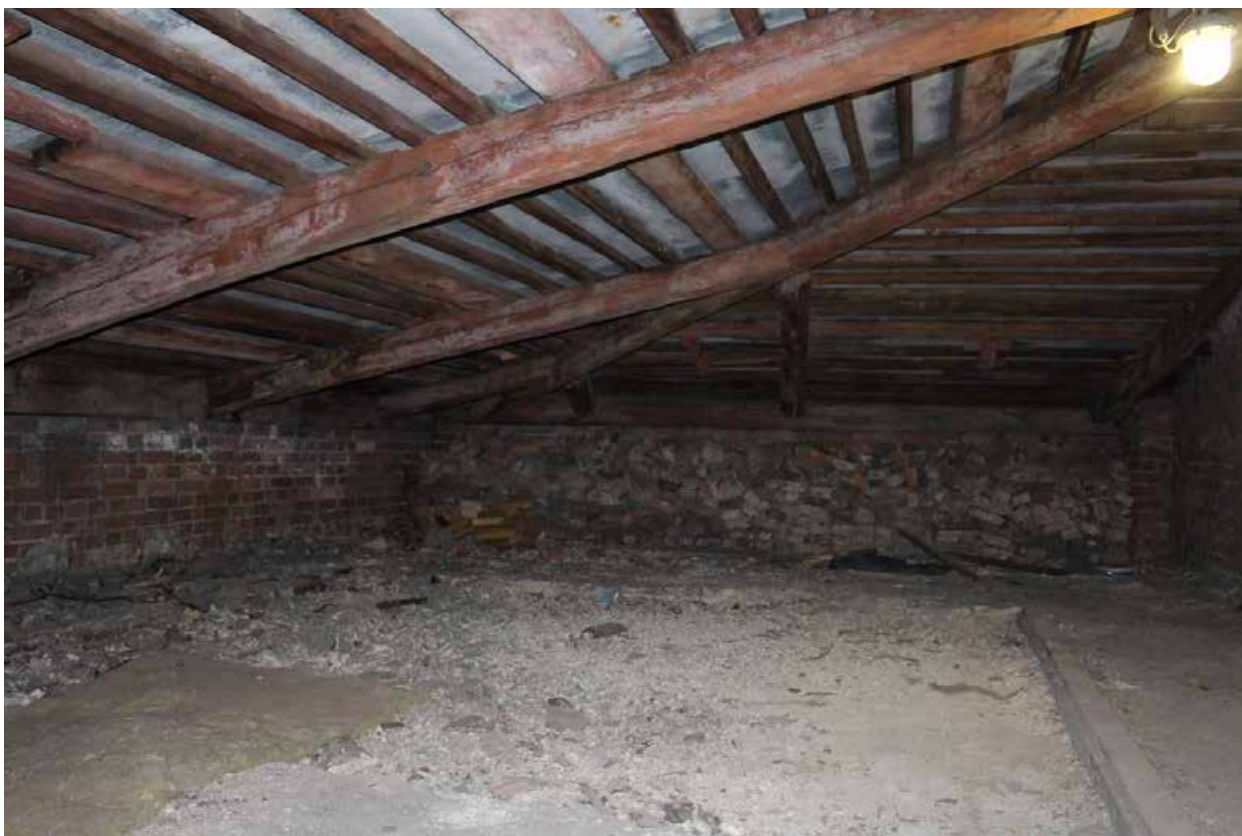
Фото 57. Вид на чердачные помещения центральной части лицевого корпуса.
