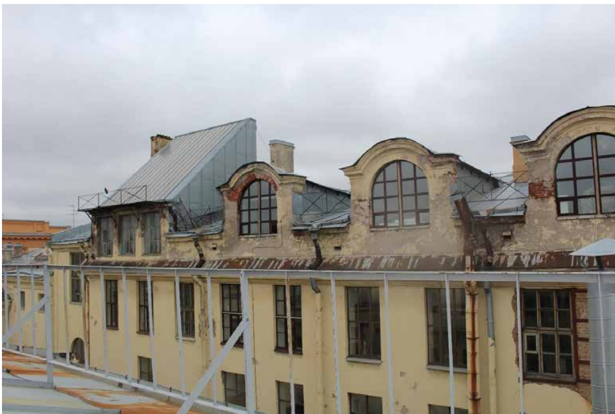
Фото 35. Вид на кровлю и односкатный световой фонарь четырехэтажного с мансардами дворового корпуса.
