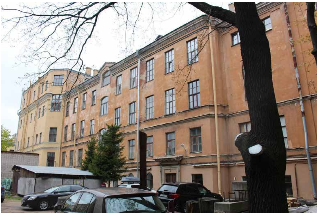
Фото 9. Вид на дворовые фасады четырехэтажного и пятиэтажного дворовых корпусов в центральном дворе.
