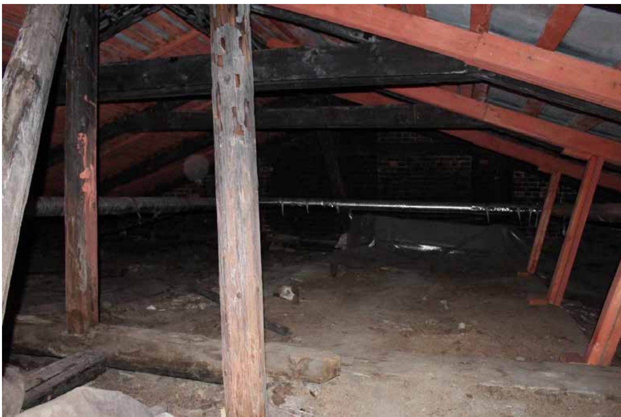
Фото 45. Вид на чердачные помещения пятиэтажного дворового корпуса.
