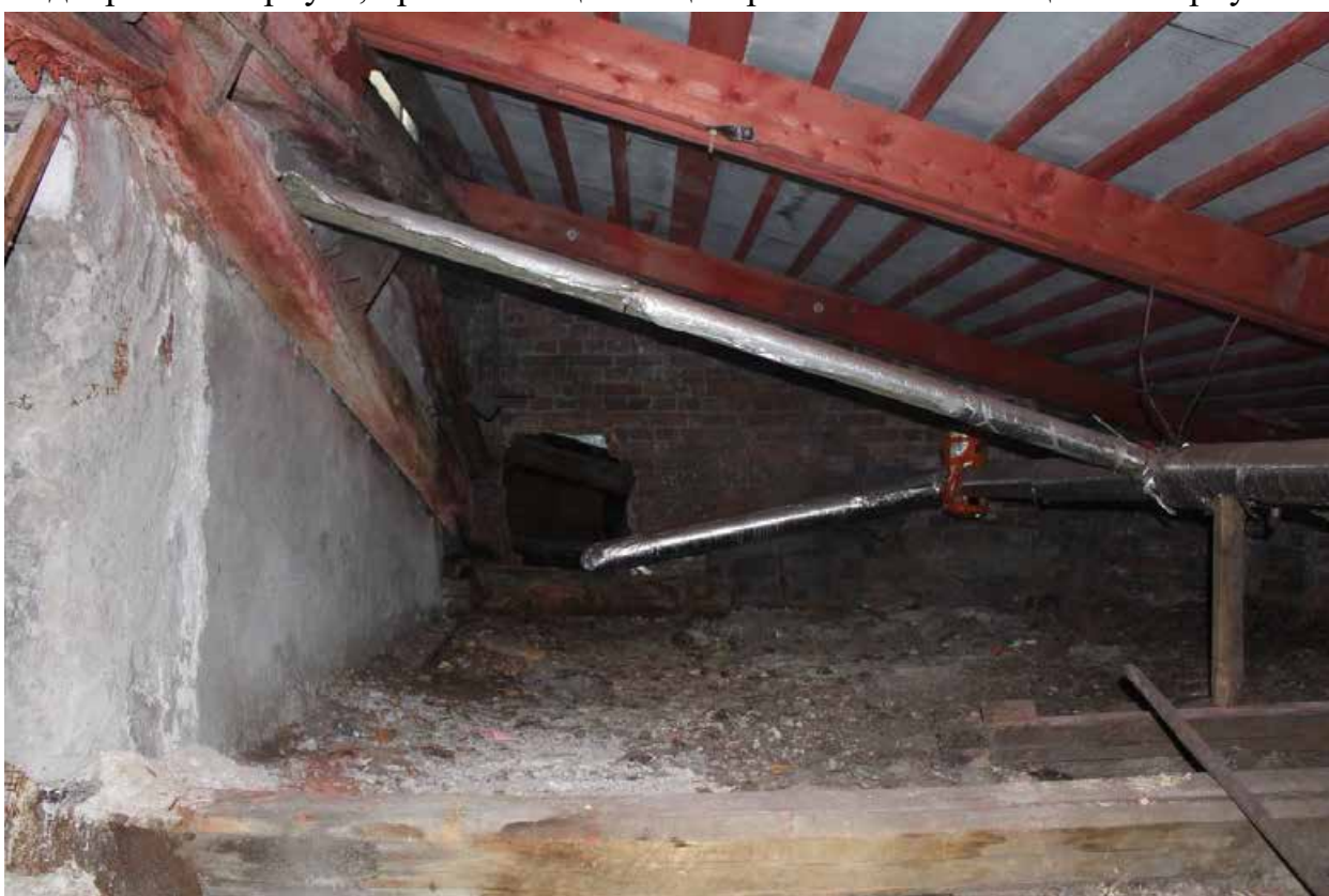
Фото 38. Вид на чердачные помещения в восточной части четырехэтажного дворового корпуса, примыкающего к центральной части лицевого корпуса.
