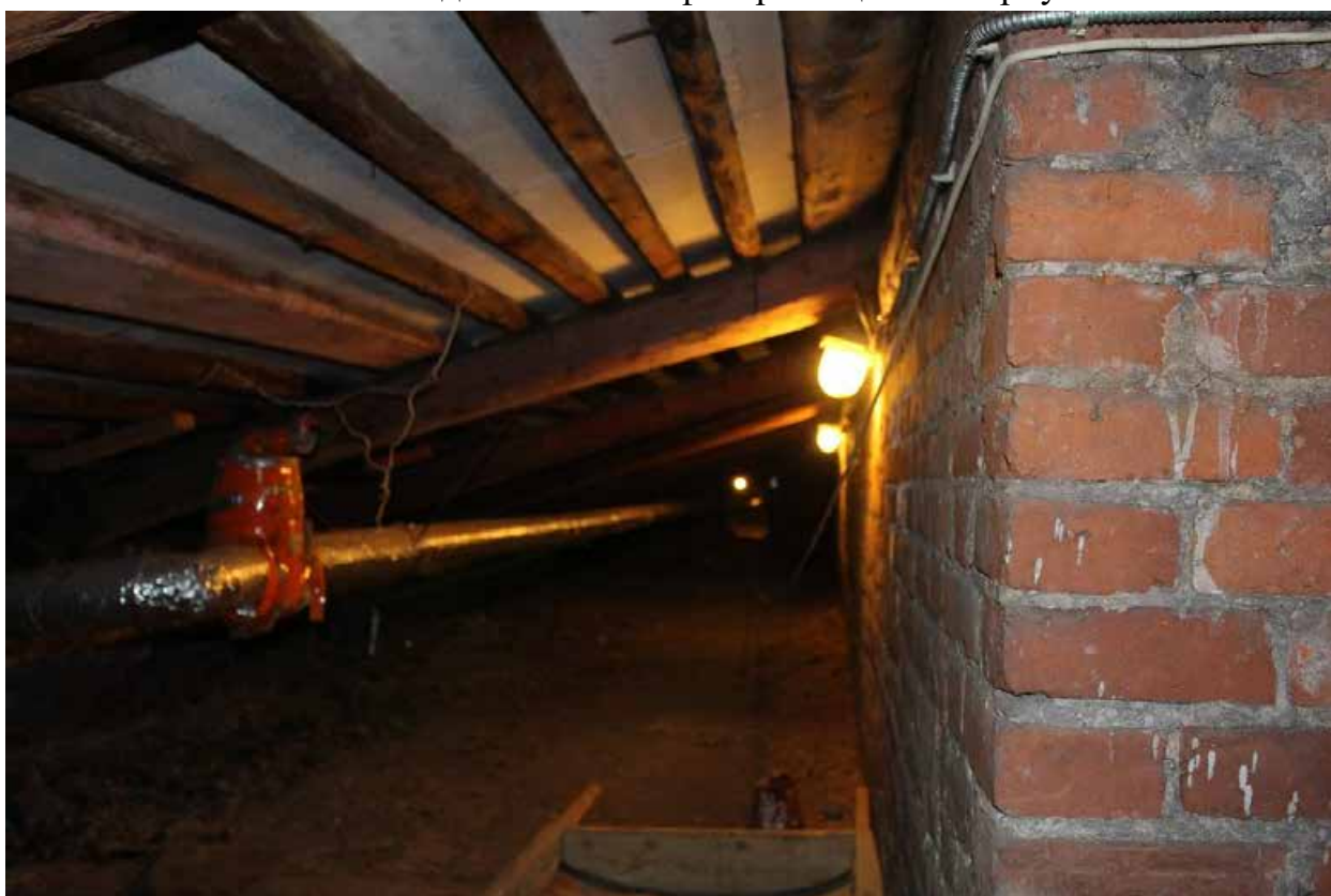
Фото 64. Вид на чердачные помещения центральной части лицевого корпуса.
