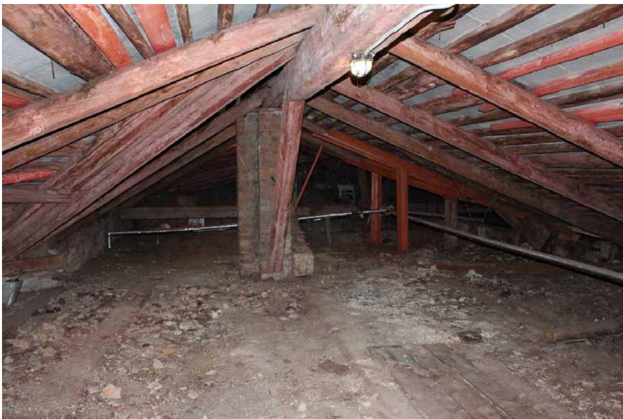
Фото 49. Вид на чердачные помещения дворового корпуса в северо-западной части объекта культурного наследия.
