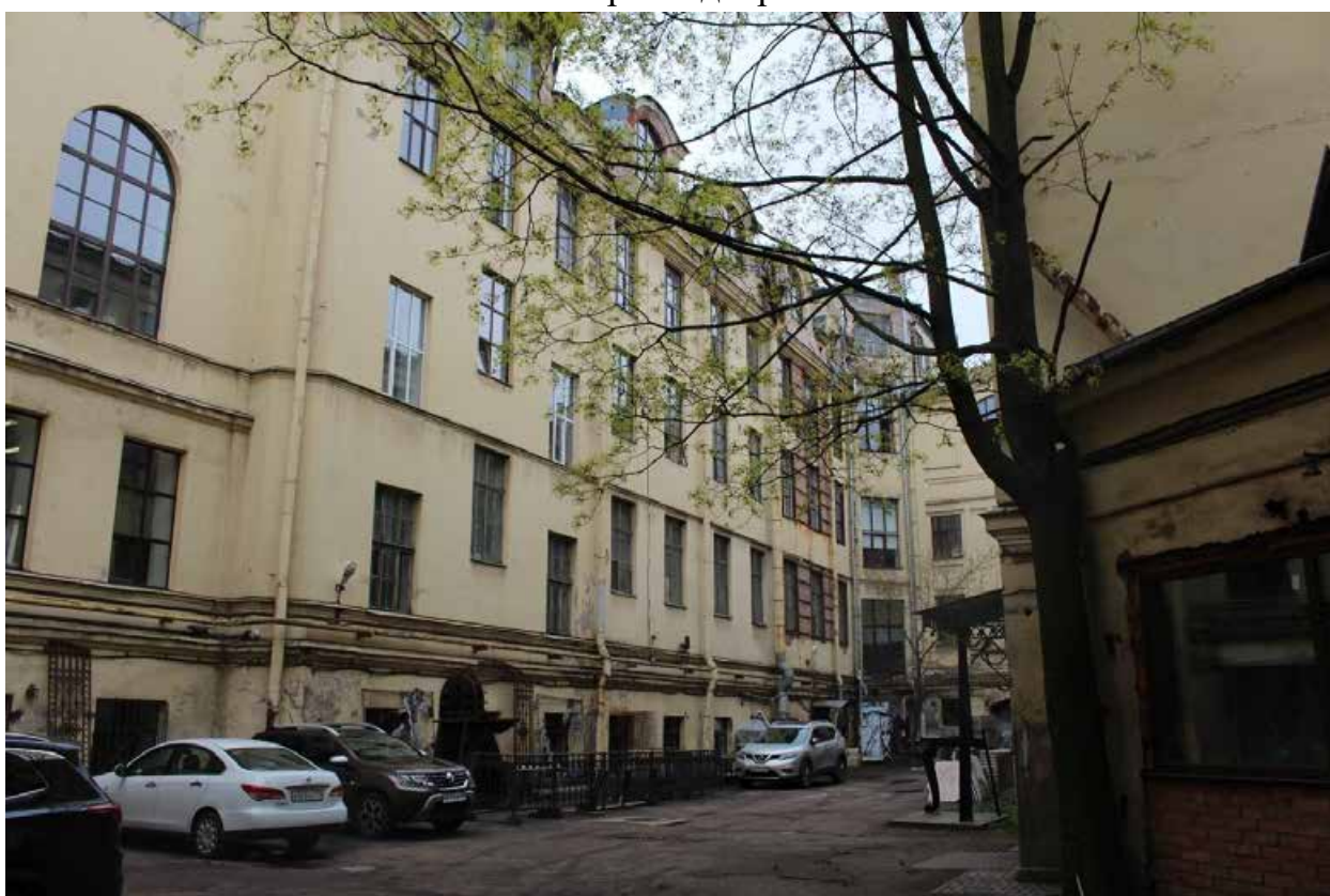
Фото 22. Вид на дворовый фасад четырехэтажного корпуса с мансардами в северном дворе.
