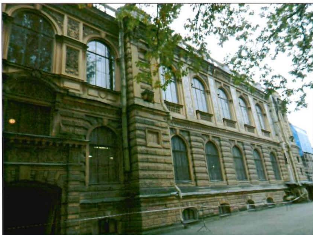
7. Северный дворовый фасад. Общий вид.
