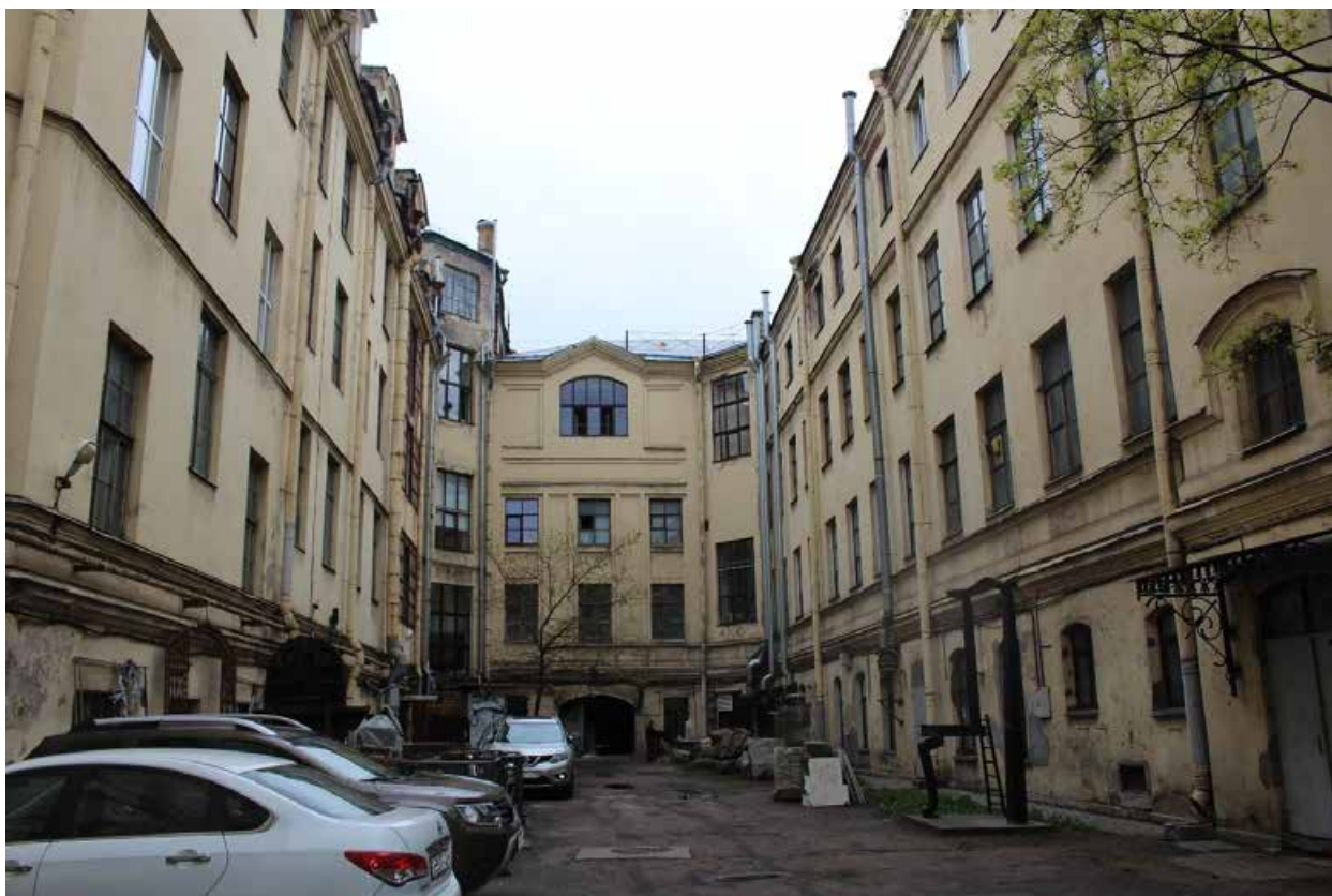
Фото 15. Вид на дворовые фасады дворовых корпусов в северном дворе.
