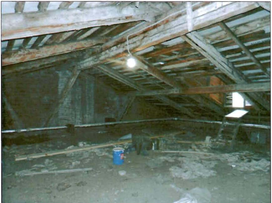
35. Стропильная система. Общий вид.
