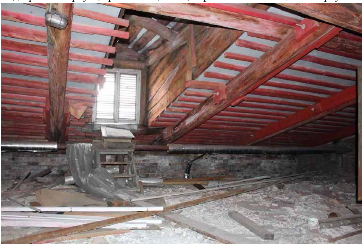
Фото 40. Вид на чердачные помещения в восточной части четырехэтажного дворового корпуса, примыкающего к центральной части лицевого корпуса.
