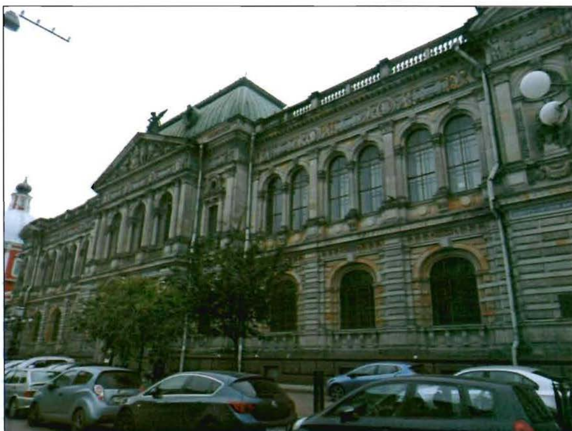
1. Общий вид с северо-востока.
