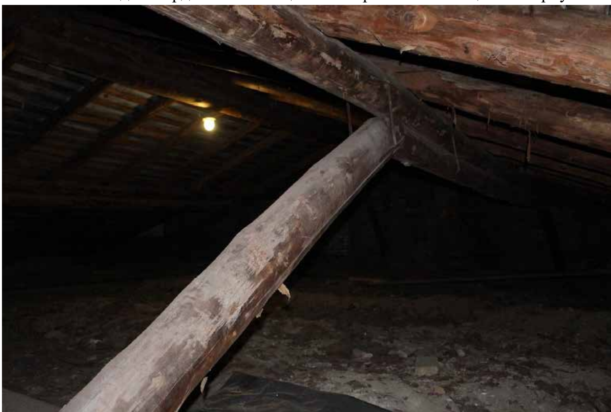
Фото 56. Вид на чердачные помещения северной части лицевого корпуса.
