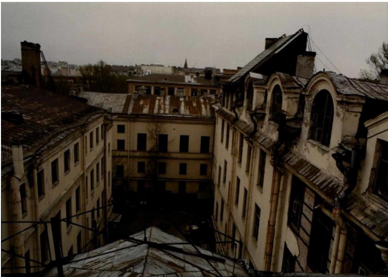
Илл. 46. Центральное училище технического рисования барона Штиглица. Внутренний двор. Вид с запада. 1998 г. (источник: паспорт памятника «Центральное училище технического рисования и музей А.Л. Штиглица». г. Санкт-Петербург, Центральный район, Соляной пер., 13, 15. Составители: Матвеев Б.М., Орлов В.П. 1998 г. архив КГИОП. Инв. № 958п).
