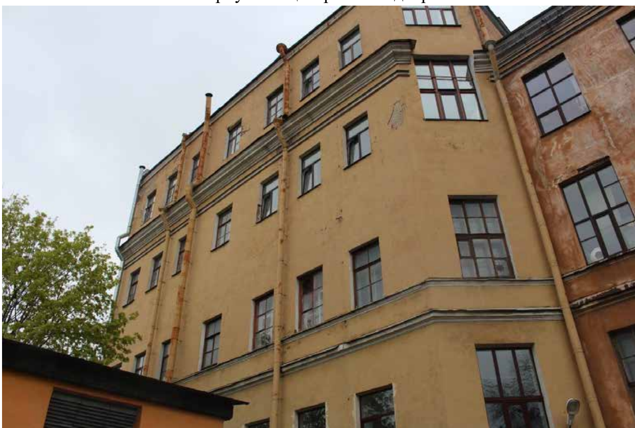
Фото 14. Вид на дворовый фасад пятиэтажного дворового корпуса в центральном дворе.
