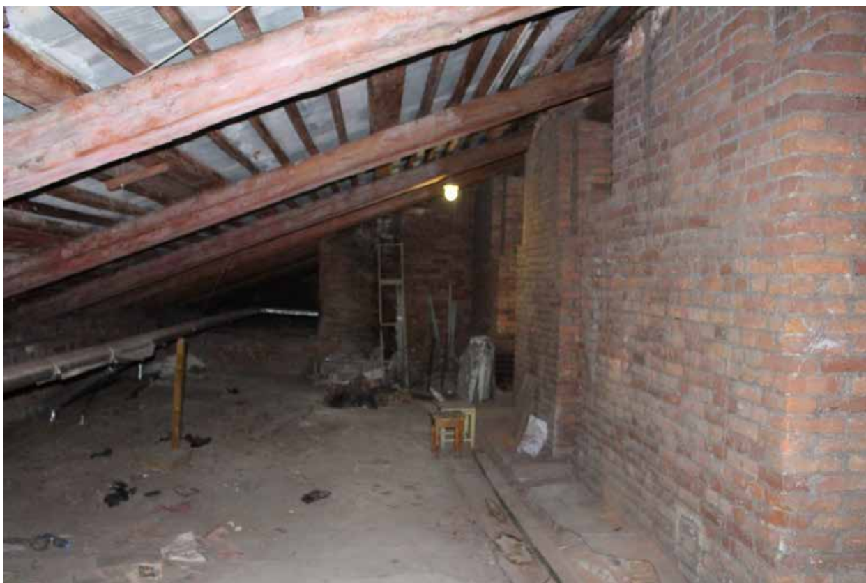
Фото 55. Вид на чердачные помещения северной части лицевого корпуса.
