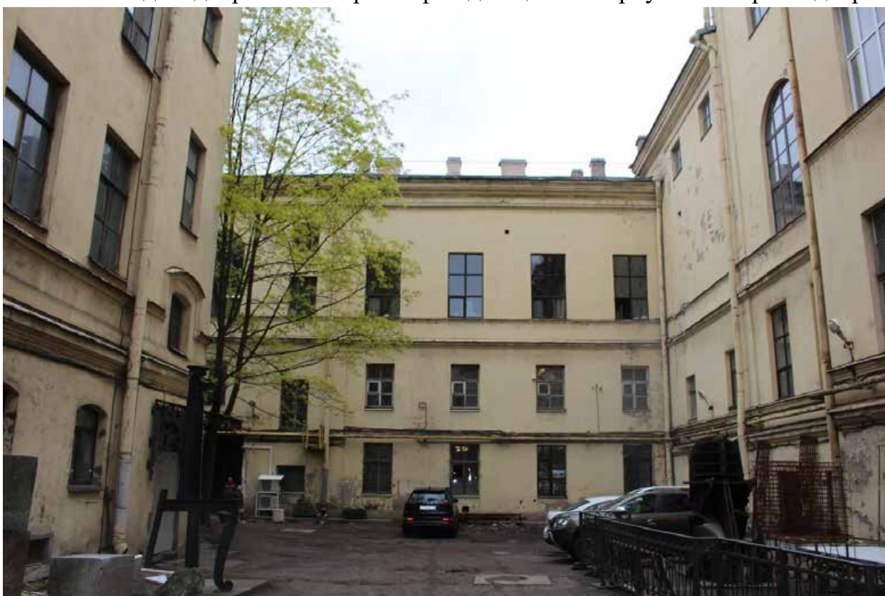
Фото 24. Вид на дворовый западный фасад лицевого корпуса в северном дворе.
