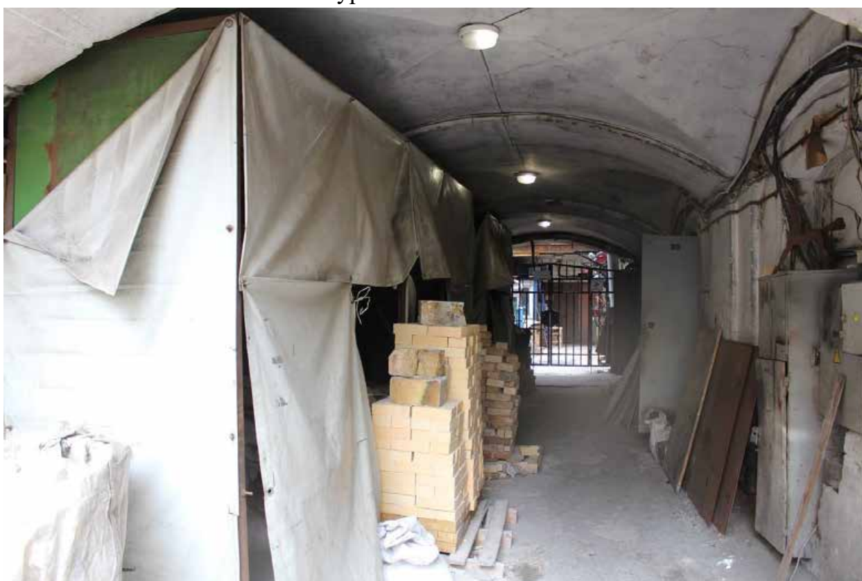
Фото 20. Вид на арку воротного проезда в западном дворовом корпусе северного двора.
