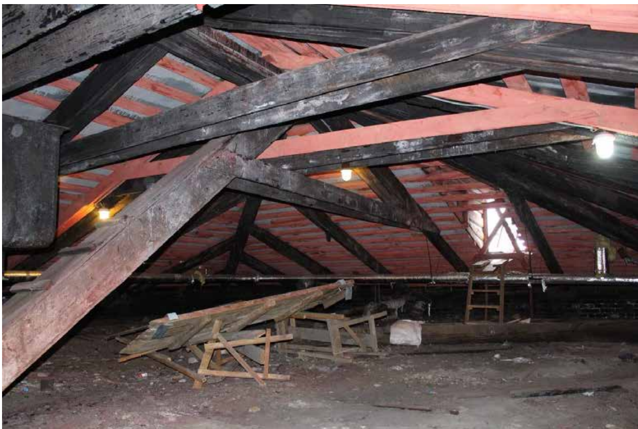
Фото 41. Вид на чердачные помещения пятиэтажного дворового корпуса.
