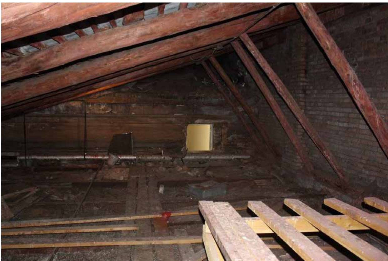
Фото 67. Вид на чердачные помещения северного дворового корпуса, расположенного в северном дворе.
