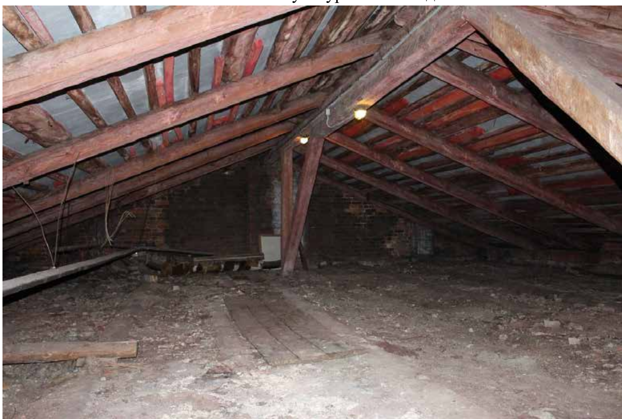
Фото 48. Вид на чердачные помещения дворового корпуса в северо-западной части объекта культурного наследия.
