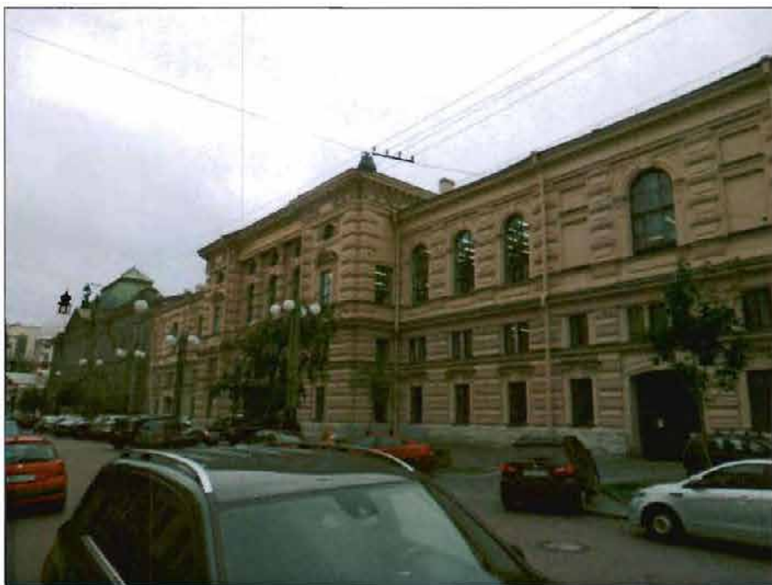
28. Лицевой фасад. Общий вид.
