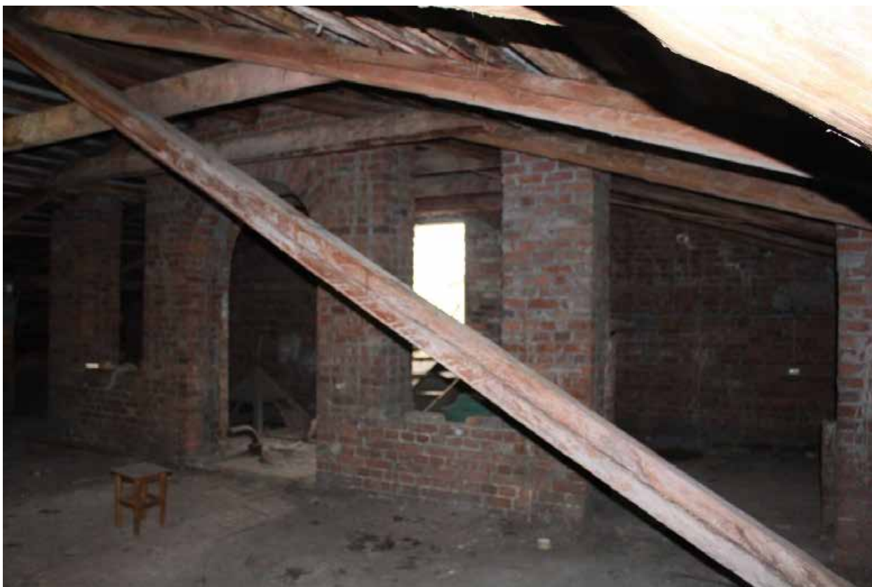
Фото 59. Вид на чердачные помещения центральной части лицевого корпуса.
