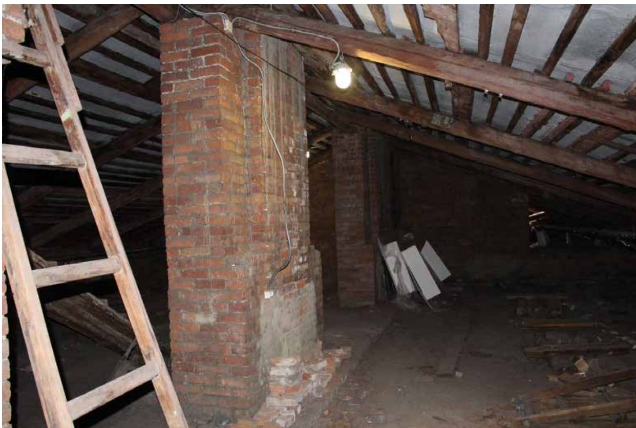
Фото 51. Вид на чердачные помещения южной части лицевого корпуса.
