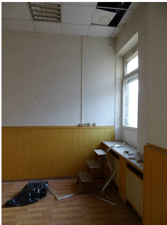
Фото 63. Выявленный объект культурного наследия «Здание Петроградской АТС» 3-й этаж. Пом. 12/19,2. Съемка 15.11.2021 г. Трушковский В.Э.
