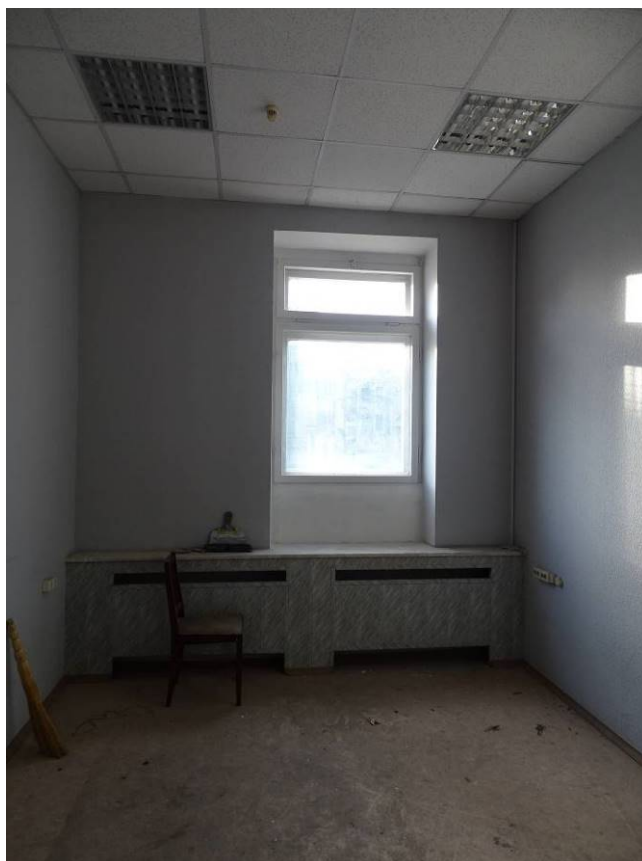
Фото 61. Выявленный объект культурного наследия «Здание Петроградской АТС» 3-й этаж. Пом. 13/13,9. Съемка 15.11.2021 г. Трушковский В.Э.
