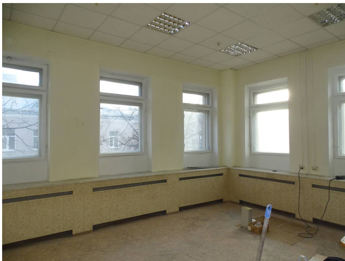
Фото 60. Выявленный объект культурного наследия «Здание Петроградской АТС» 3-й этаж. Пом. 16/24,8. Съемка 15.11.2021 г. Трушковский В.Э.
