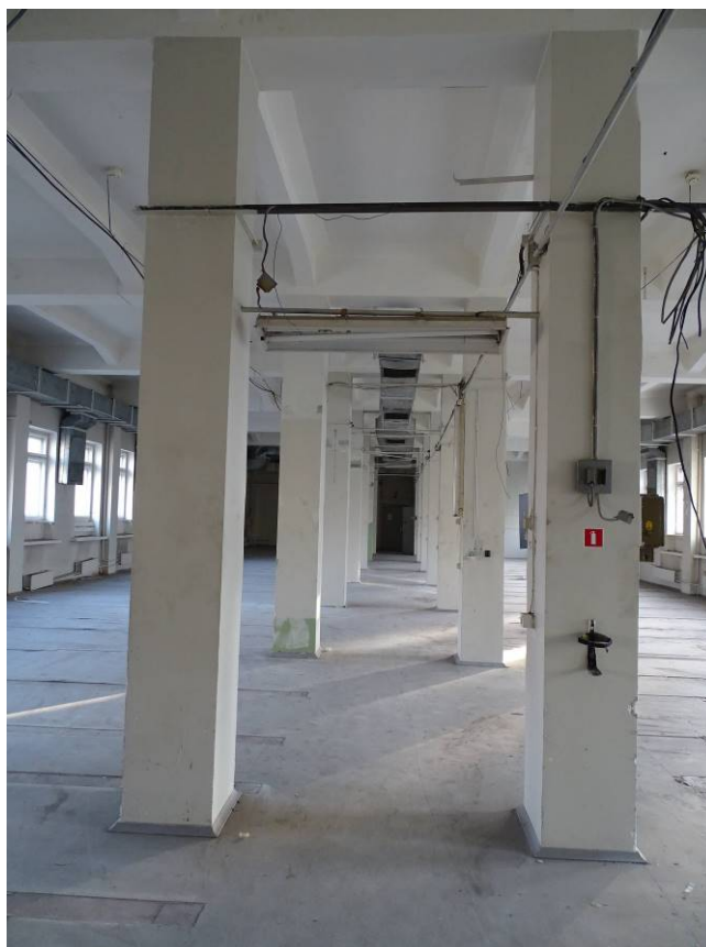
Фото 33. Выявленный объект культурного наследия «Здание Петроградской АТС» 3-й этаж. Пом. 3/413,0. Съемка 15.11.2021 г. Трушковский В.Э.
