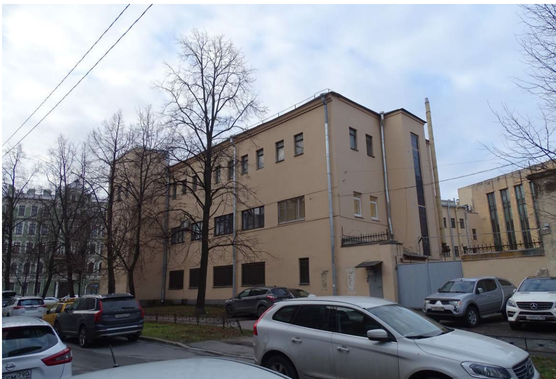
Фото 11. Выявленный объект культурного наследия «Здание Петроградской АТС» (ул. Ленина, д. 5, лит. А). Северо-восточный фасад. Съемка 15.11.2021 г. Трушковский В.Э.
