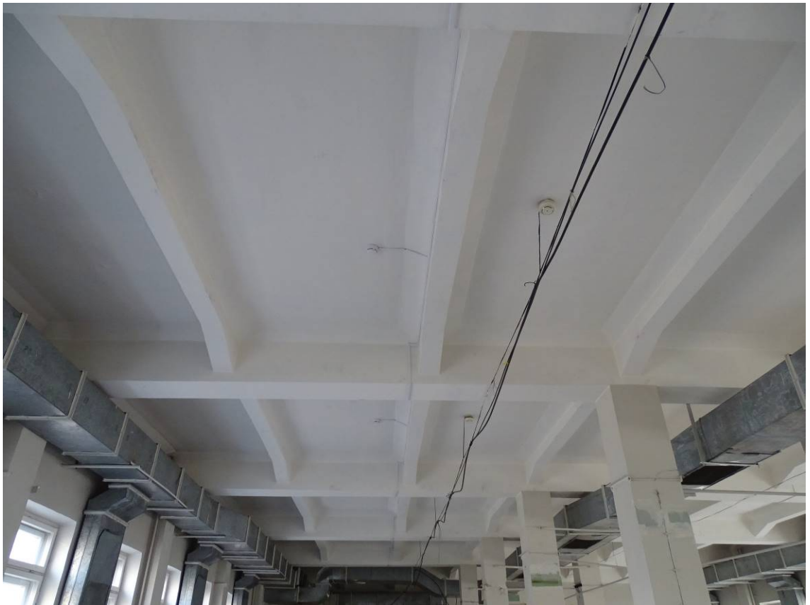
Фото 35. Выявленный объект культурного наследия «Здание Петроградской АТС» 3-й этаж. Пом. 3/413,0. Съемка 15.11.2021 г. Трушковский В.Э.
