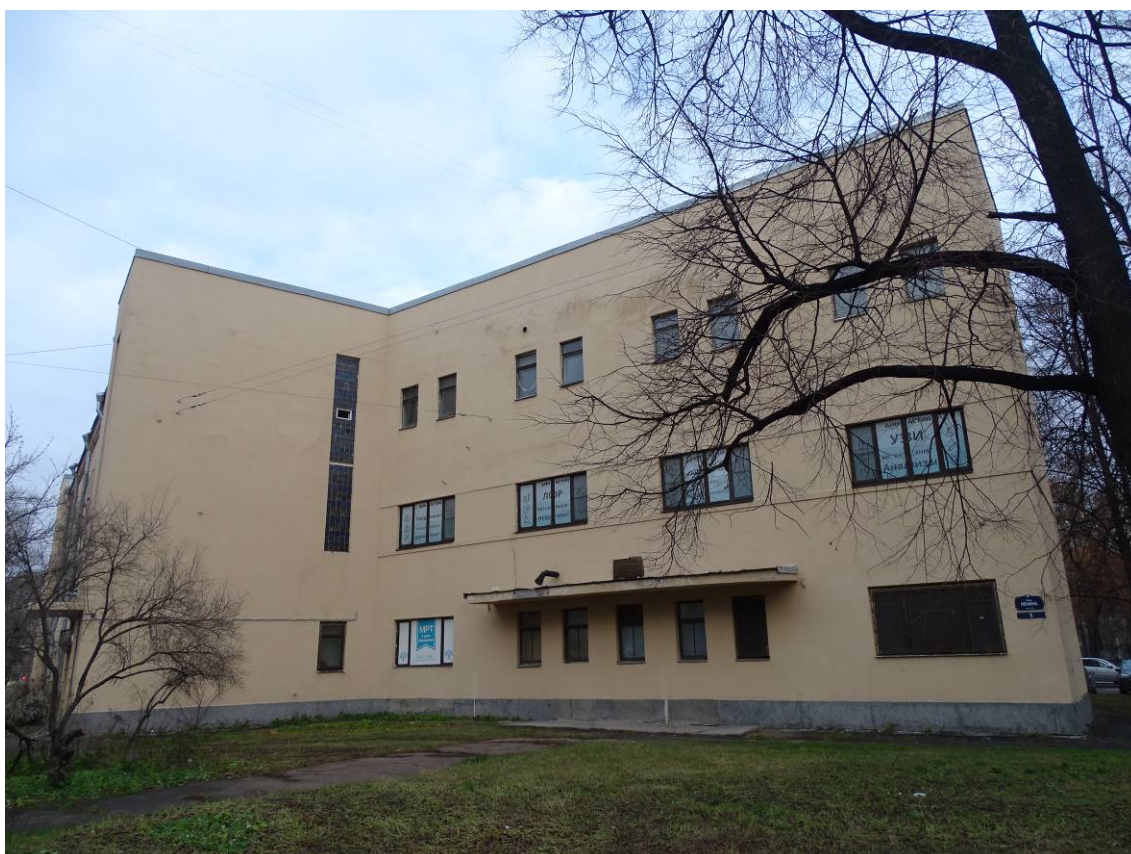
Фото 2. Выявленный объект культурного наследия «Здание Петроградской АТС» (ул. Ленина, д. 5, лит. А). Юго-восточный фасад. Фрагмент. Съемка 15.11.2021 г. Трушковский В.Э.
