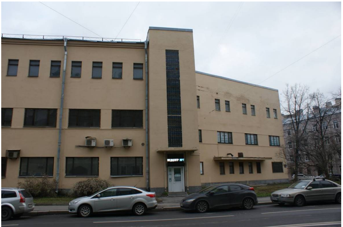
Фото 4. Выявленный объект культурного наследия «Здание Петроградской АТС» (ул. Ленина, д. 5, лит. А). Юго-восточный фасад. Фрагмент. Съемка 15.11.2021 г. Трушковский В.Э.
