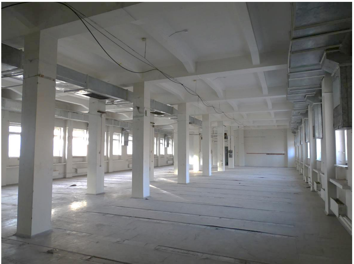
Фото 38. Выявленный объект культурного наследия «Здание Петроградской АТС» 3-й этаж. Пом. 3/413,0. Съемка 15.11.2021 г. Трушковский В.Э.
