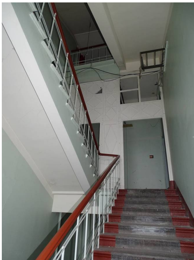
Фото 31. Выявленный объект культурного наследия «Здание Петроградской АТС» Западная лестница. Вид на площадку 3-го этажа. Съемка 15.11.2021 г. Трушковский В.Э.
