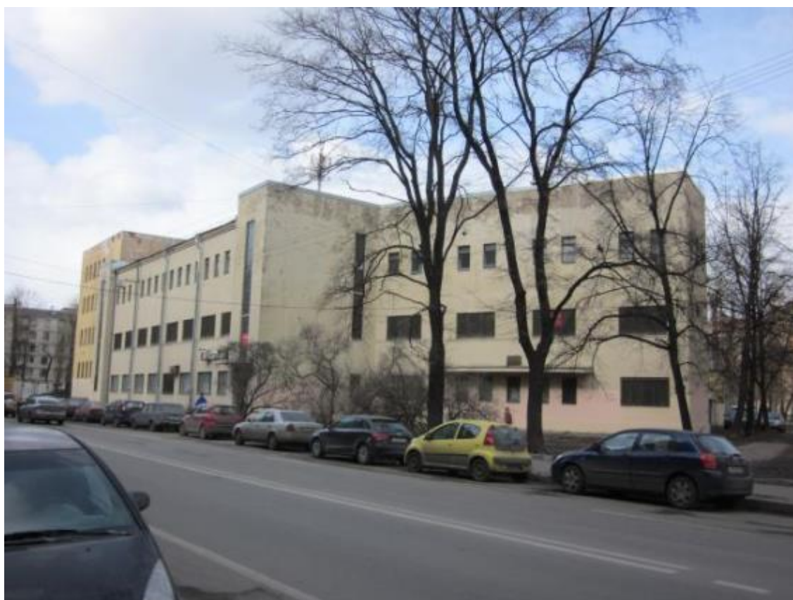
Илл. 75. Петроградская АТС, ул. Ленина, 5. 2009 г. https://p0.citywalls.ru/photo_124-127980.jpg?mt=1339514324
