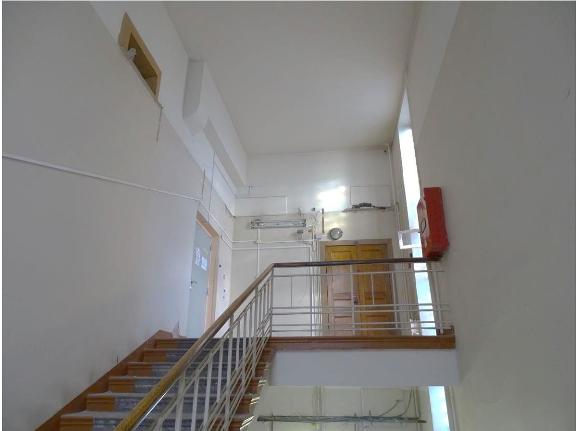
Фото 74. Выявленный объект культурного наследия «Здание Петроградской АТС» Площадка 3-го этажа. Съемка 15.11.2021 г. Трушковский В.Э.
