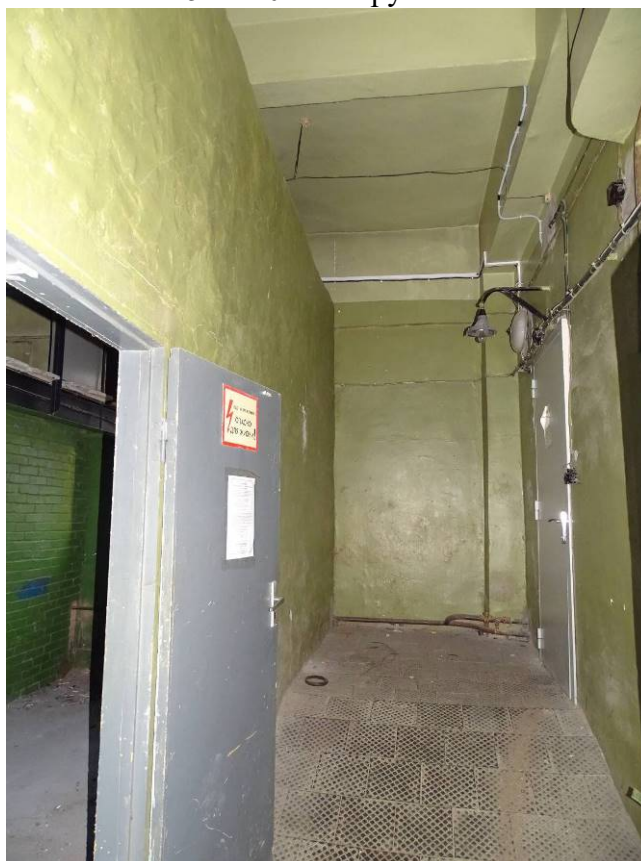
Фото 42. Выявленный объект культурного наследия «Здание Петроградской АТС» 1-й этаж. Пом. 24/26,4. Съемка 15.11.2021 г. Трушковский В.Э.
