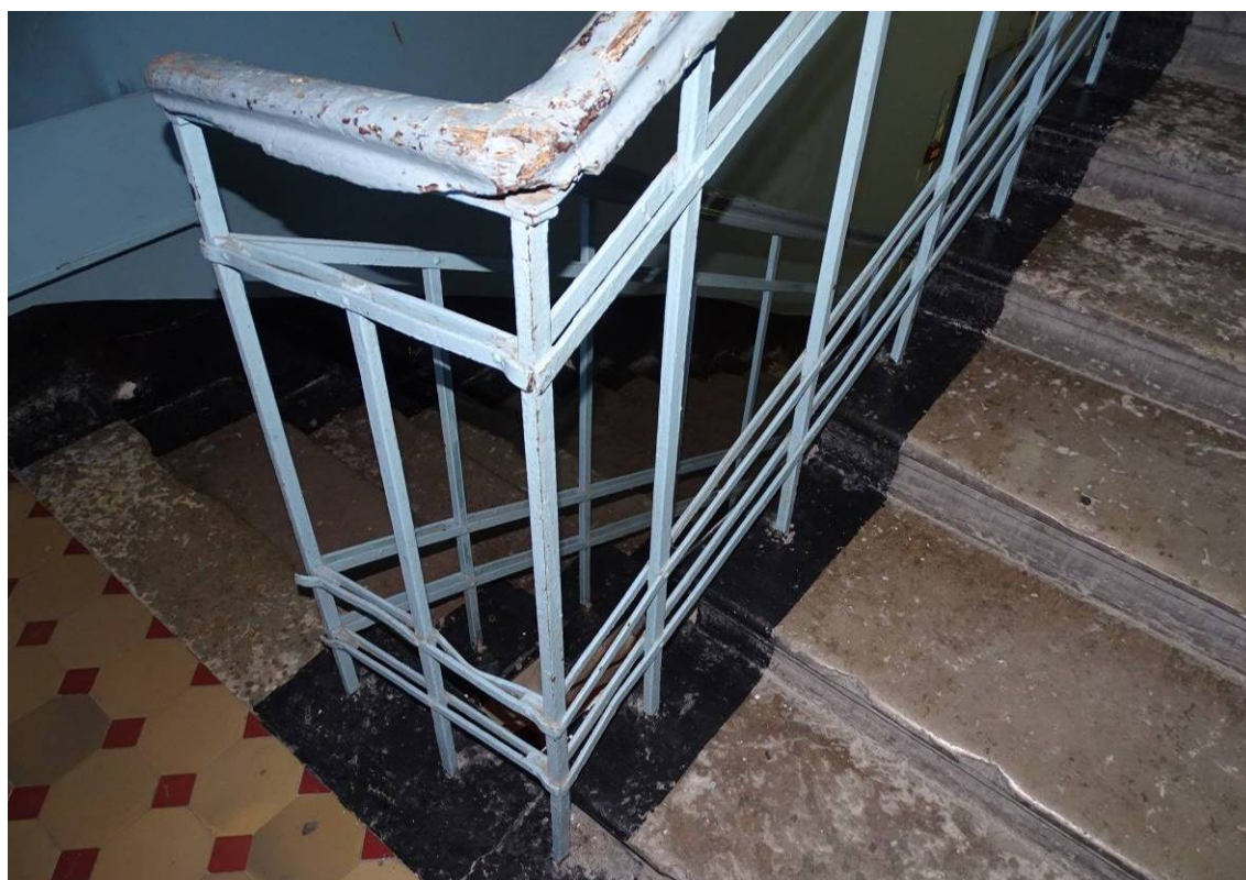
Фото 46. Выявленный объект культурного наследия «Здание Петроградской АТС» Восточная лестница. Лестничное ограждение. Съемка 15.11.2021 г. Трушковский В.Э.
