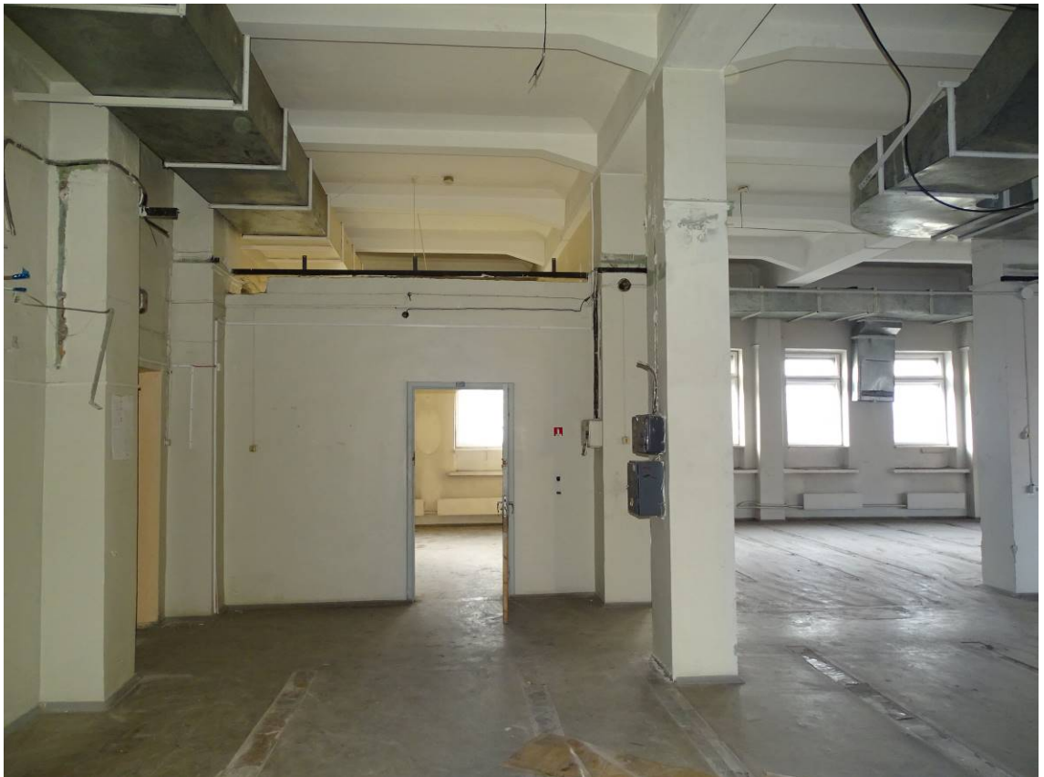
Фото 37. Выявленный объект культурного наследия «Здание Петроградской АТС» 3-й этаж. Пом. 3/413,0. Съемка 15.11.2021 г. Трушковский В.Э.
