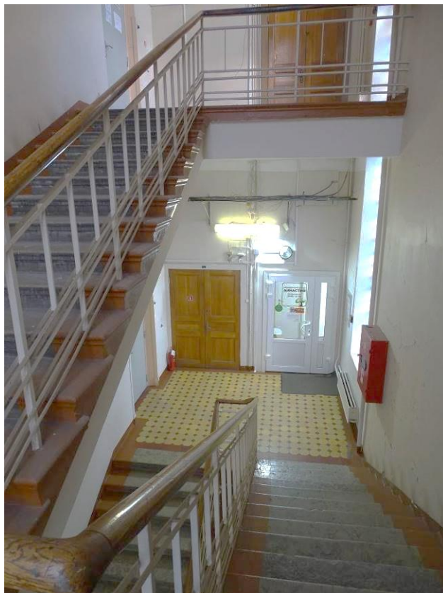
Фото 71. Выявленный объект культурного наследия «Здание Петроградской АТС» Центральная лестница. Вид на площадку 2-го этажа. Съемка 15.11.2021 г. Трушковский В.Э.
