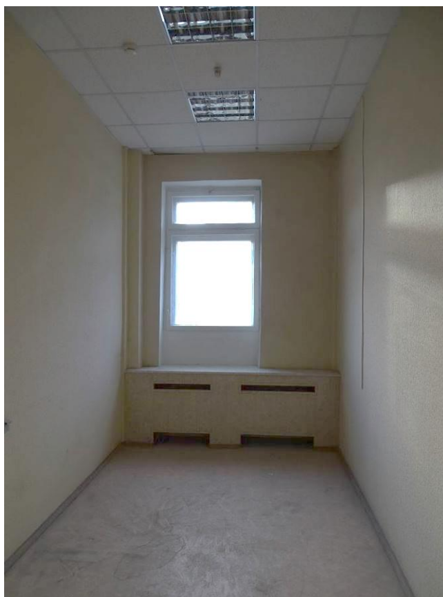
Фото 58. Выявленный объект культурного наследия «Здание Петроградской АТС» 3-й этаж. Пом. 14/15,3. Съемка 15.11.2021 г. Трушковский В.Э.
