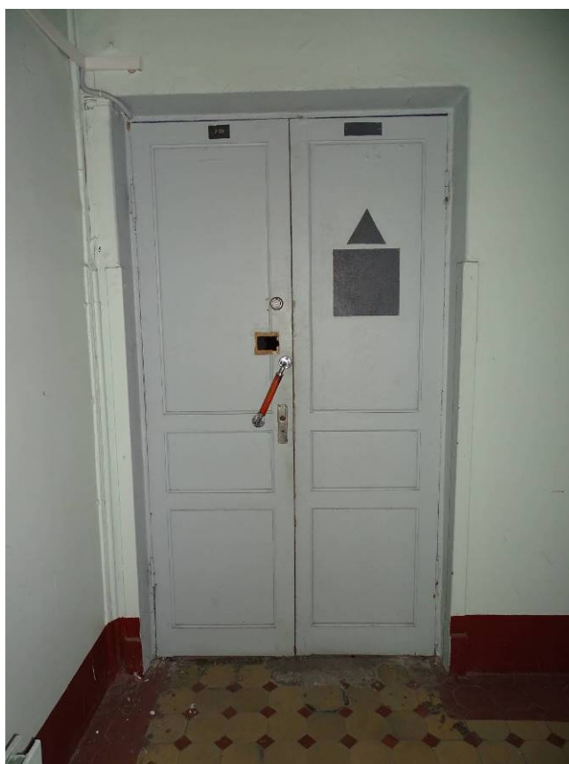
Фото 20. Выявленный объект культурного наследия «Здание Петроградской АТС» Западная лестница. Площадка 2-го этажа. Съемка 15.11.2021 г. Трушковский В.Э.
