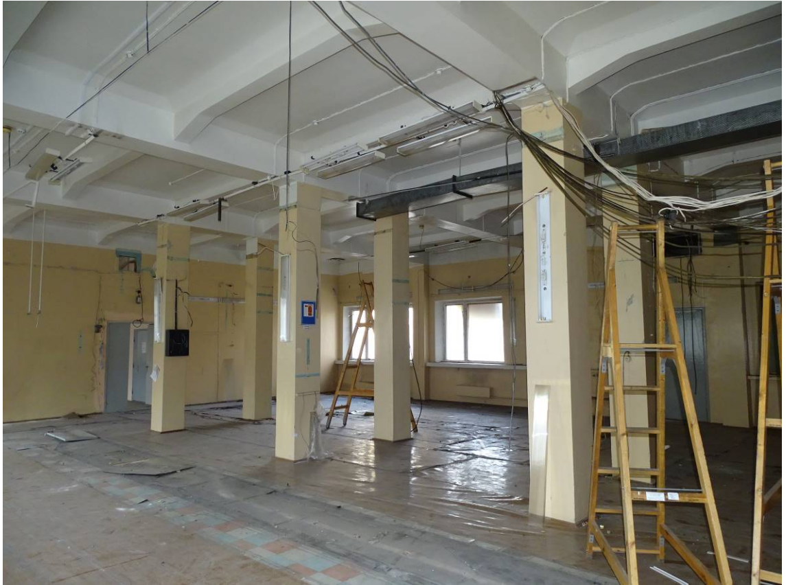
Фото 27. Выявленный объект культурного наследия «Здание Петроградской АТС» 2-й этаж. Пом. 6/82,7. Съемка 15.11.2021 г. Трушковский В.Э.
