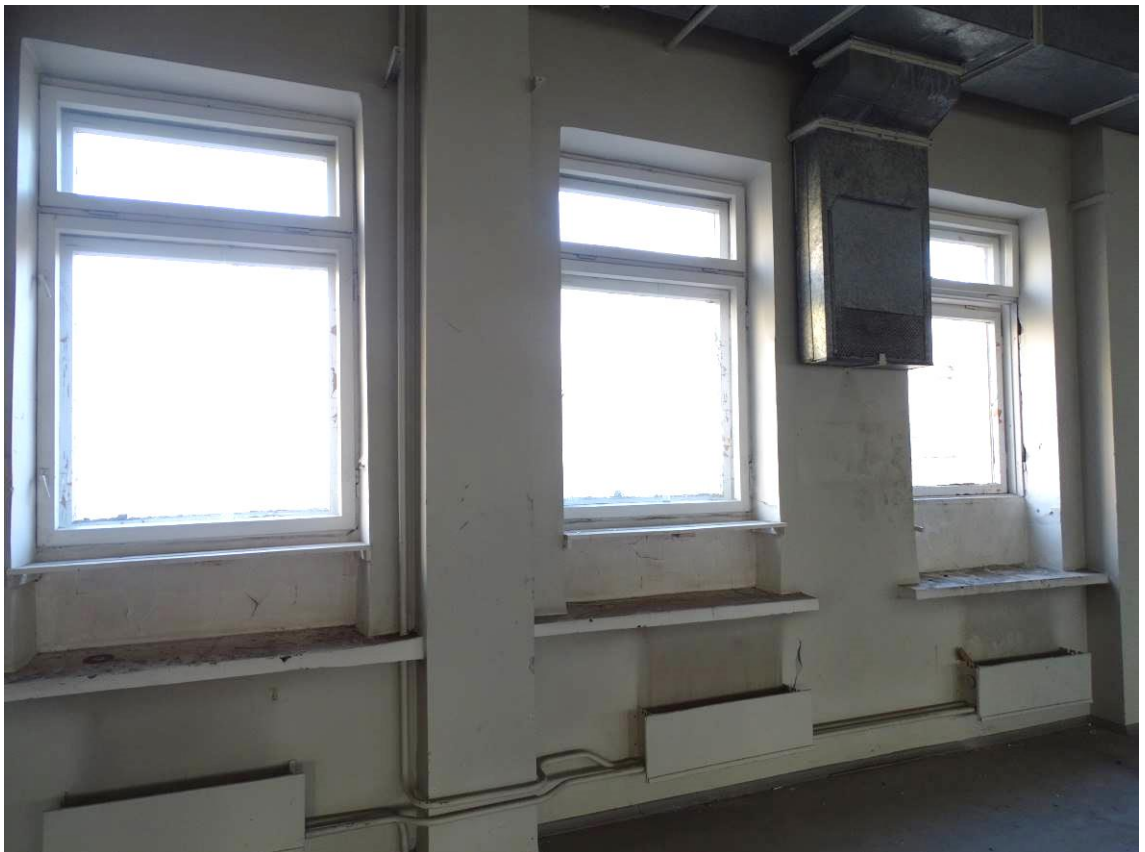
Фото 36. Выявленный объект культурного наследия «Здание Петроградской АТС» 3-й этаж. Пом. 3/413,0. Съемка 15.11.2021 г. Трушковский В.Э.
