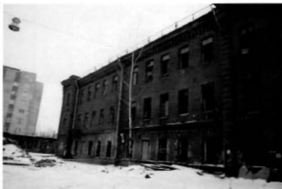
4. (Фрагмент восточного фасада)
