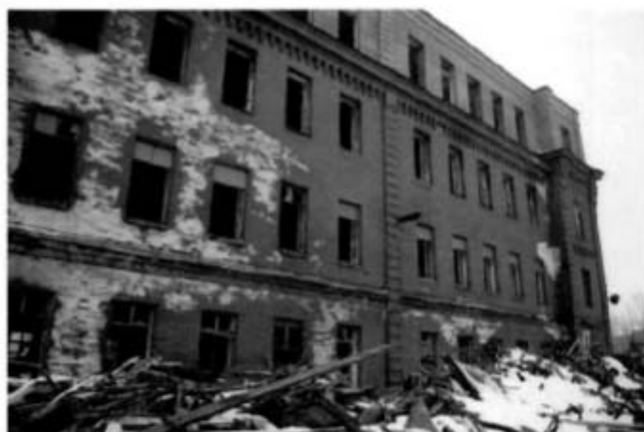
2. (Фрагмент западного фасада)
