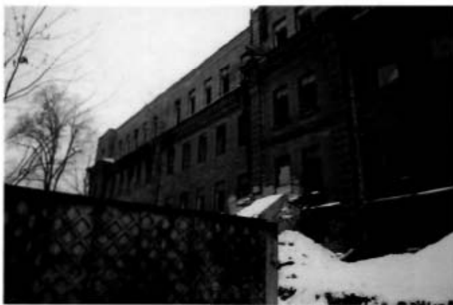
4. (Фрагмент восточного фасада)
