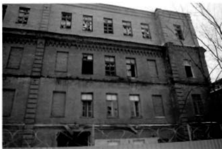
3. (Фрагмент восточного фасада)
