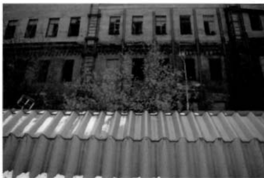
2. (Фрагмент западного фасада)
