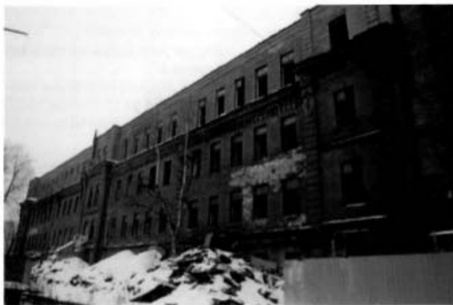
3. (Фрагмент восточного фасада)
