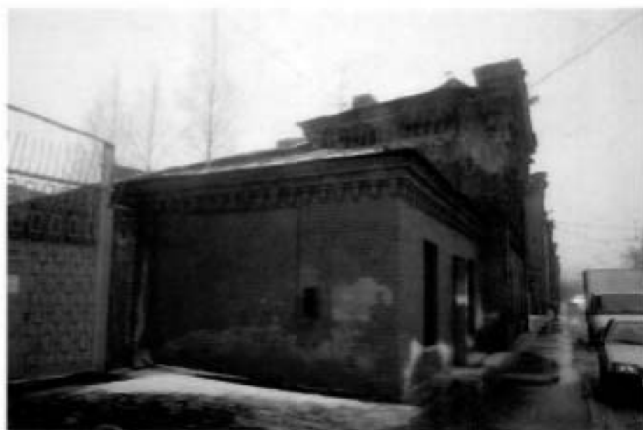
2. (Фрагмент северного фасада)
