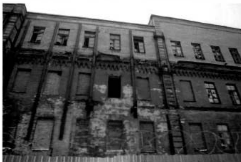
4. (Фрагмент восточного фасада)
