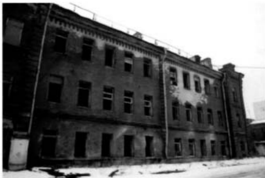
3. (Фрагмент восточного фасада)
