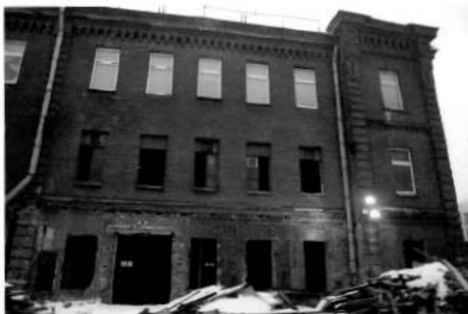
3. (Фрагмент восточного фасада)
