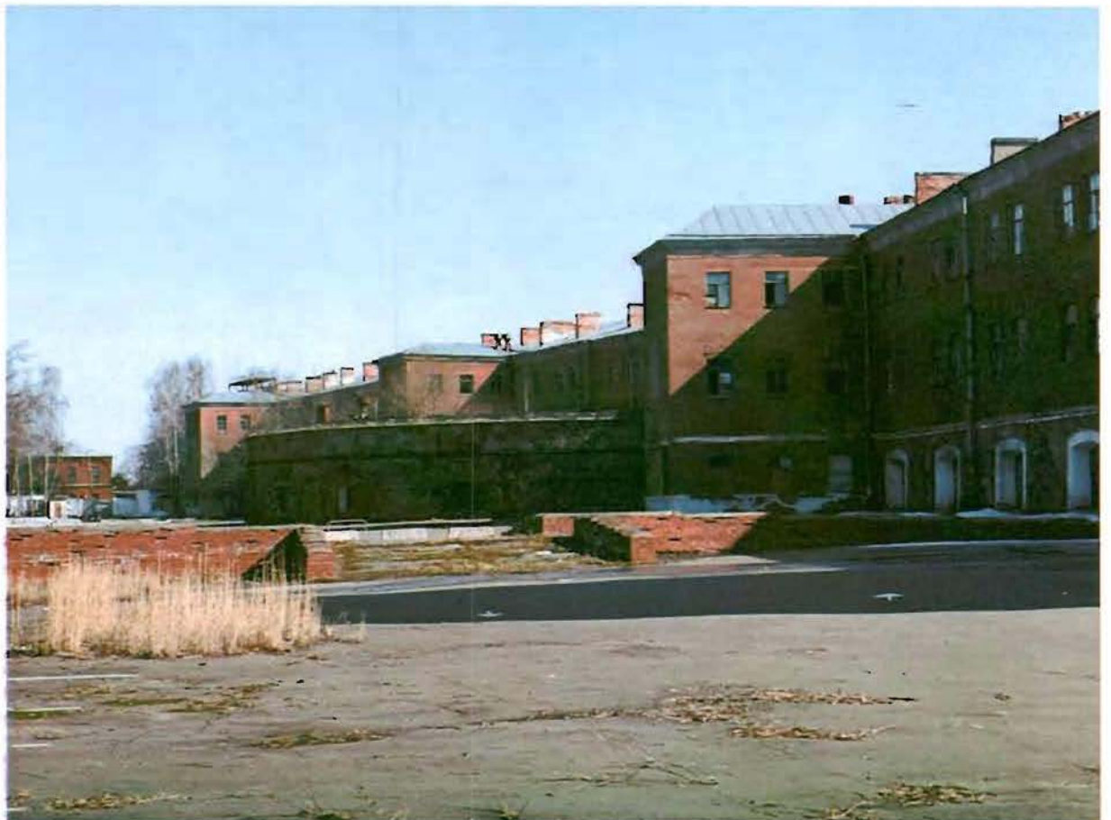
Фото №4. Западный фасад.
