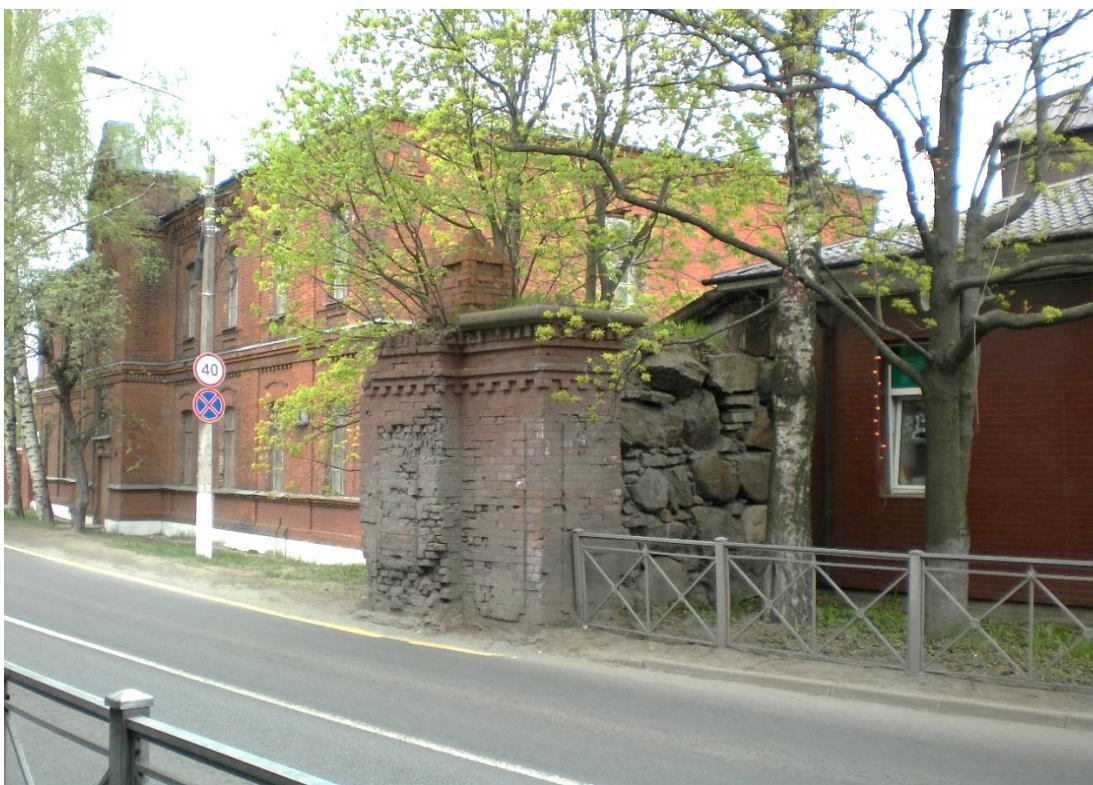
Фото 4. Фрагмент крепостной стены с кирпичными столбами бывших Кронштадтских ворот (утрачены) – часть объекта культурного наследия «Стена эскарповая» (в составе ансамбля «Крепость Кронштадт»).
