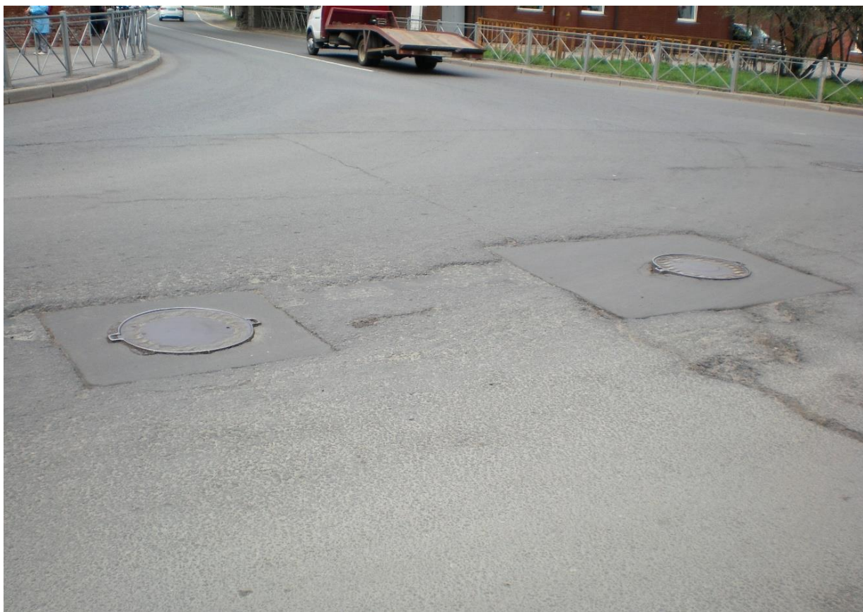
Фото 15. Покрытие проезжей части перекрестка. Фрагмент.
