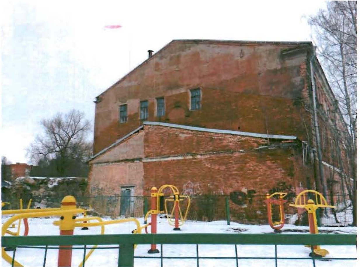
Фото №3. Южный фасад.
