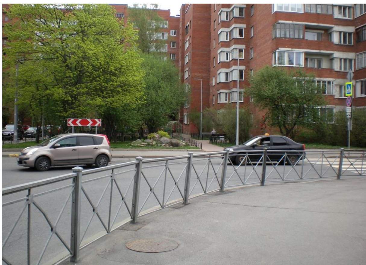
Фото 13. Пешеходное ограждение по юго-западному радиусу перекрестка Кронштадтского шоссе и ул. Зосимова.
