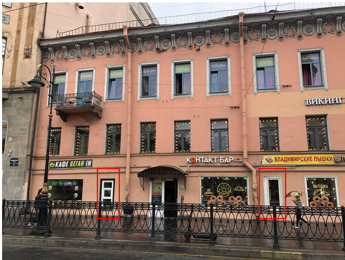
Фото 2. Фрагмент лицевого фасада объекта культурного наследия регионального значения «Дом Общества Санкт-Петербургского частного ломбарда»
