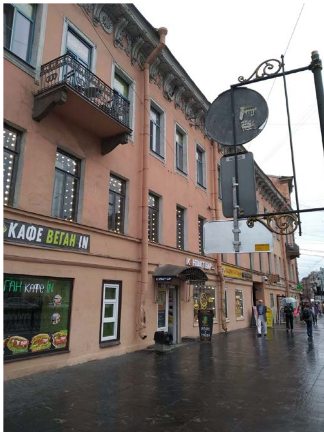
Фото 3. Фрагмент лицевого фасада объекта культурного наследия регионального значения «Дом Общества Санкт-Петербургского частного ломбарда»
