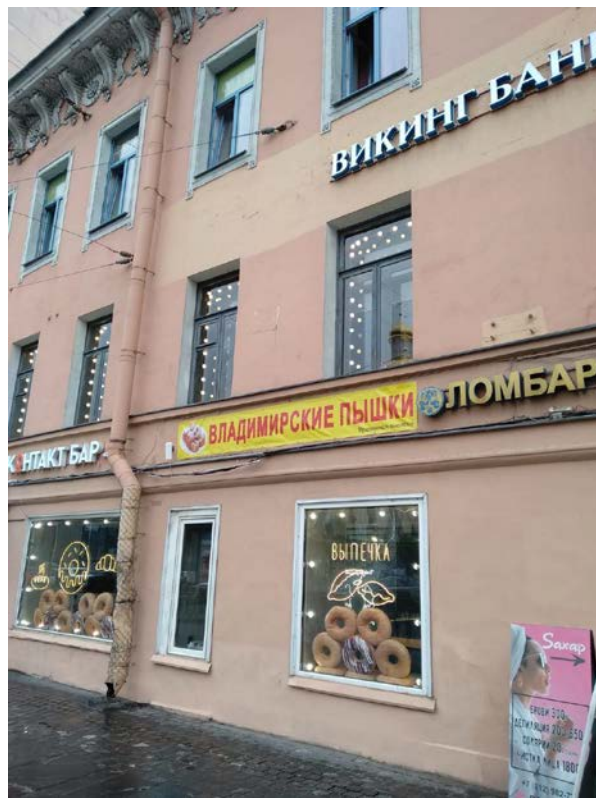
Фото 6. Фрагмент лицевого фасада объекта культурного наследия регионального значения «Дом Общества Санкт-Петербургского частного ломбарда», оконное заполнение пом. 1-Н
