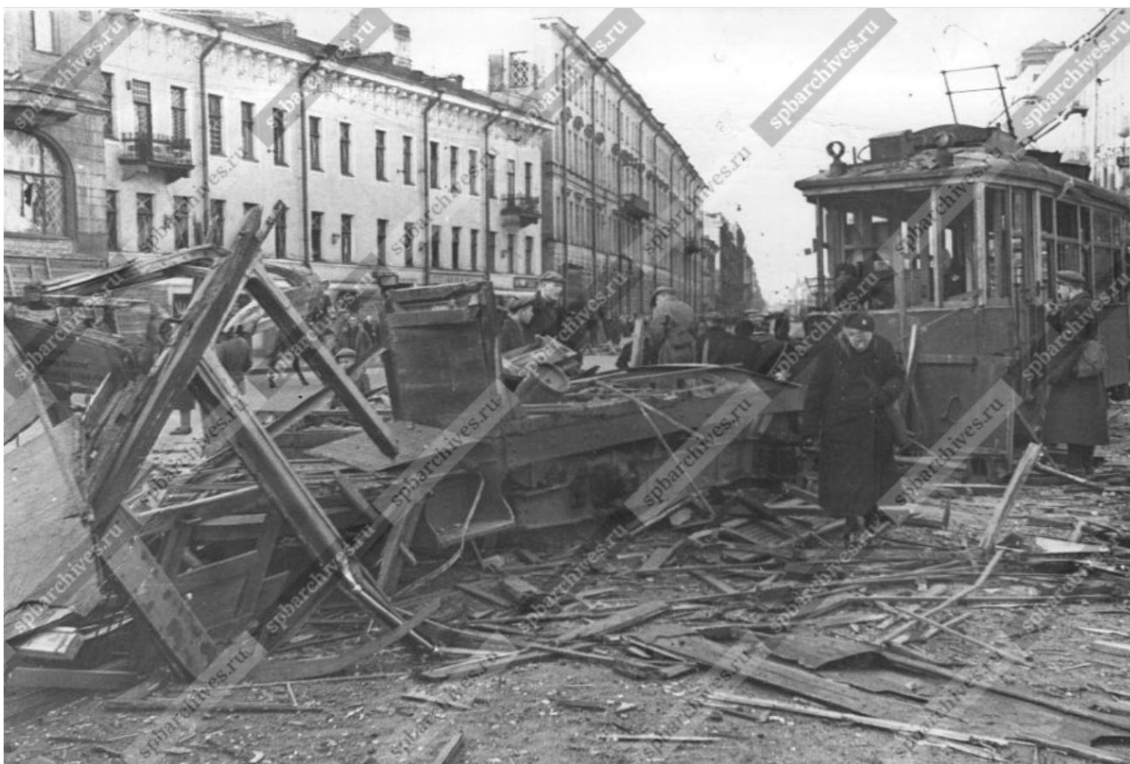
52. Трамвай, разрушенный прямым попаданием фугасной бомбы, на площади Нахимсона. 19 сентября 1941 г. ЦГАКФФД СПб Ар 14831
