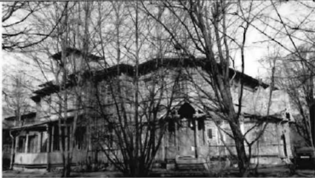
Фото 1. Южный фасад. Общий вид.
