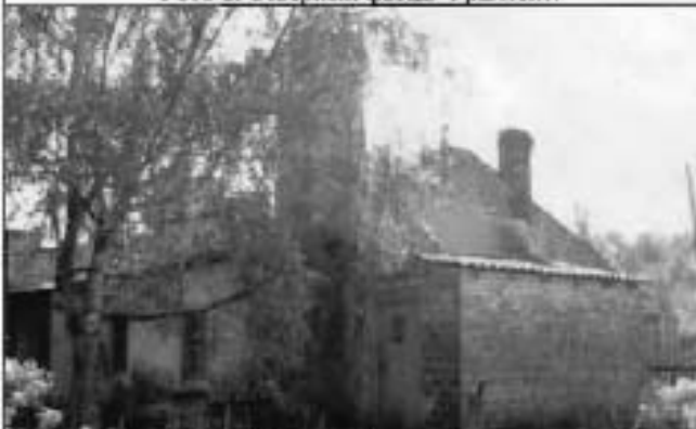
Фото 3. Северный фасад. Фрагмент.
