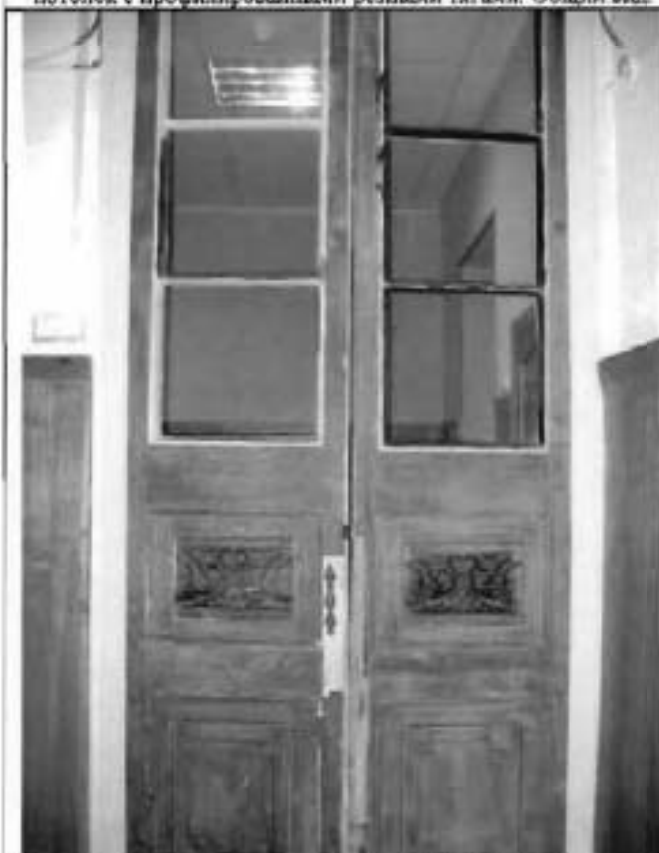
Фото 24. Дверное заполнение. Пом. 1-Н (20, 16). Общий вид.
