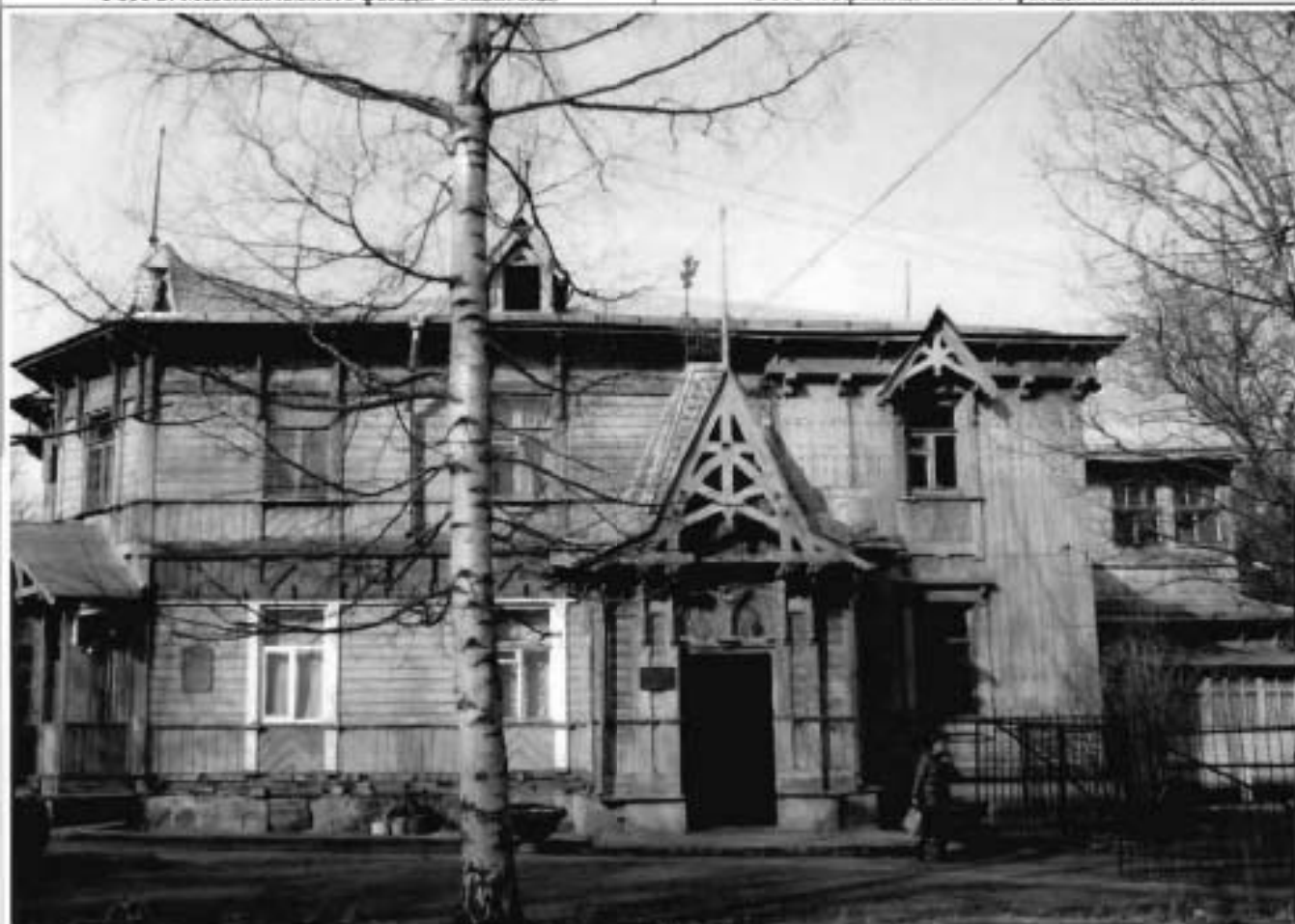
Фото 5. Восточный фасад. Общий вид.
