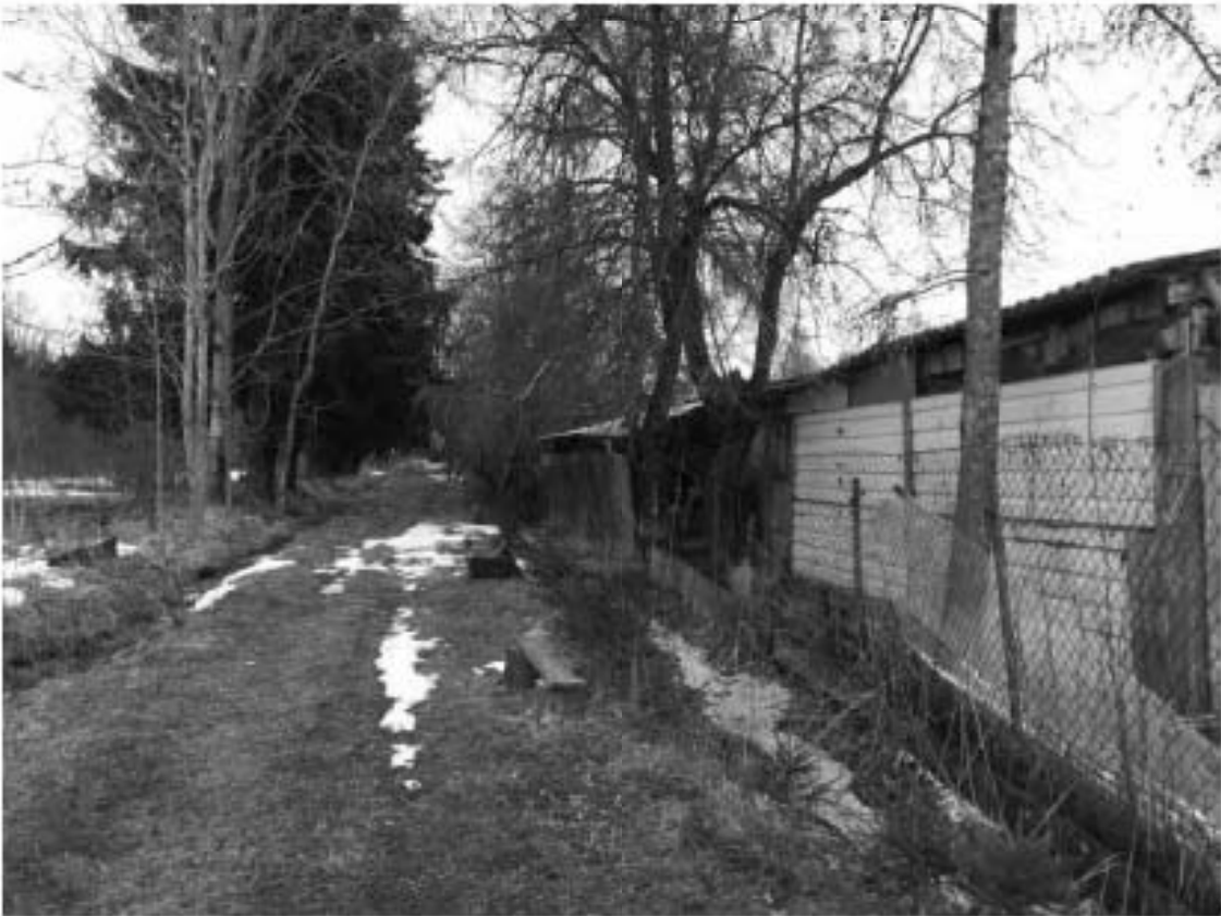
Фото 18. Вид на местный проезд с ул. Черникова, проходящий вдоль жилой застройки и вдоль западного участка территории ОКН «Жилой дом» (ул. Черникова д. 24, лит. А), входящего в состав ОКН «Усадебный дом Ратьковых-Рожновых».
