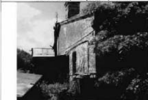
Фото 5. Восточный фасад. Общий вид.
