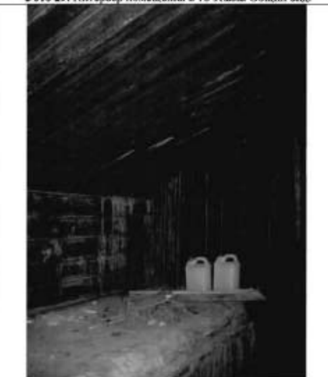
Фото 31. Конструкции крыши. Фрагмент.
