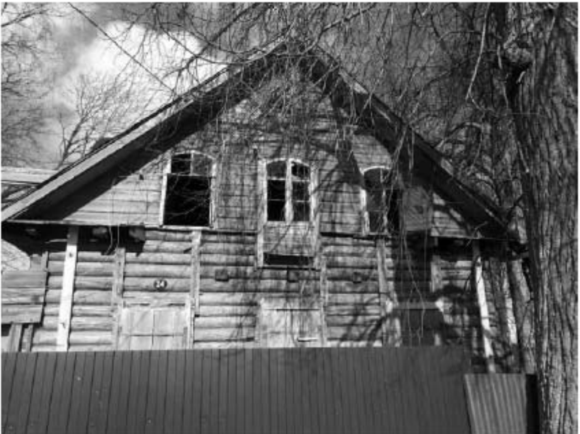
Фото 48. Вид с Центральной ул. на ОКН «Жилой дом» (д.24), на южный фасад.
