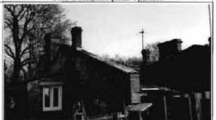
Фото 6. Западный, южный фасады. Общий вид.
