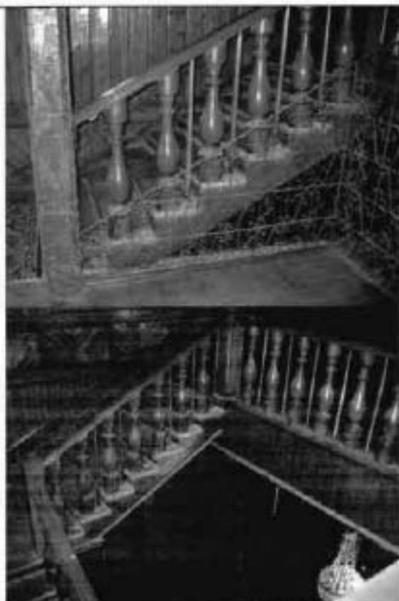
Фото 19. Главная лестница (Пом. 1-Н (1, 30)). Фрагмент.
