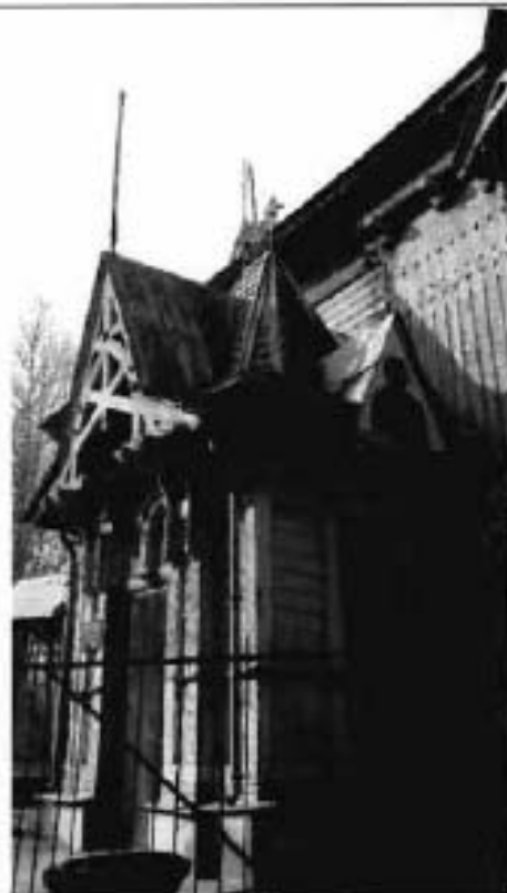
Фото 7. Тамбур восточного фасада. Общий вид.
