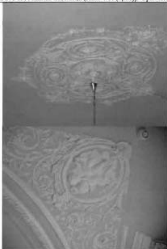
Фото 21. Лепные композиции потолка. Пом. 1-Н (4). Фрагмент.
