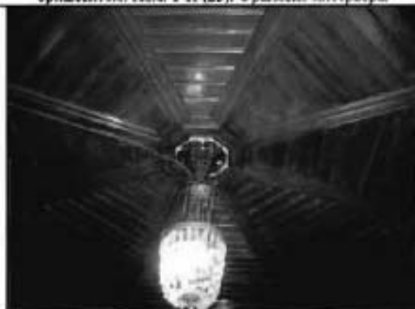
Фото 16. Потолок Пом. 1-Н (23). Фрагмент интерьера.
