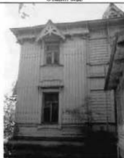
Фото 9. Северный фасад. Фрагмент.
