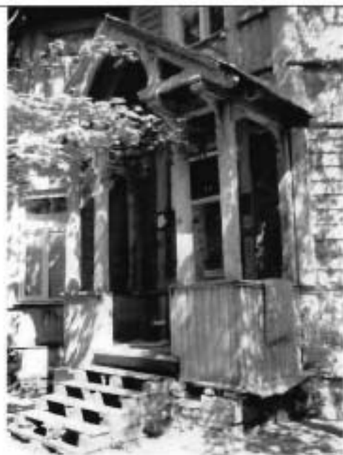
Фото 4. Крыльцо южного фасада. Общий вид.
