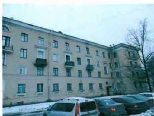
8. Фрагмент фасада. Вид с северо-востока.
