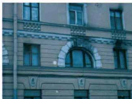
12. Оконные проемы второго этажа.
