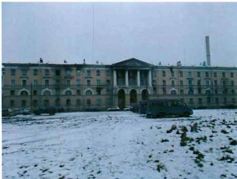
1. Лицевой фасад. Вид с юго-запада.
