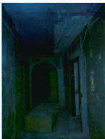
17. Помещение первого этажа.
