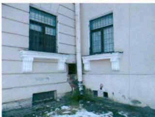
11. Оконные проемы первого этажа.
