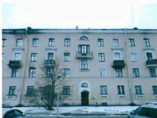
5. Фрагмент фасада. Вид с северо-востока.
