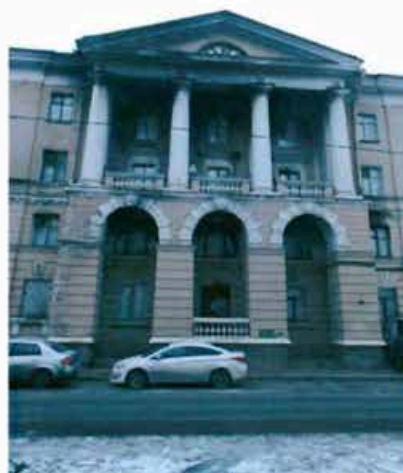
10. Портик западного фасада.
