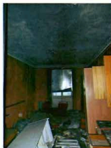
20. Помещение третьего этажа.
