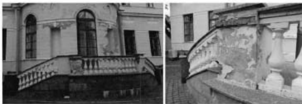
16, 17. Крыльцо со стороны восточного фасада здания
