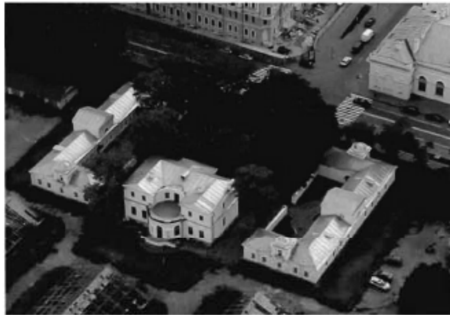
Здание по адресу Потемкинская ул., д. 2, литера А:
