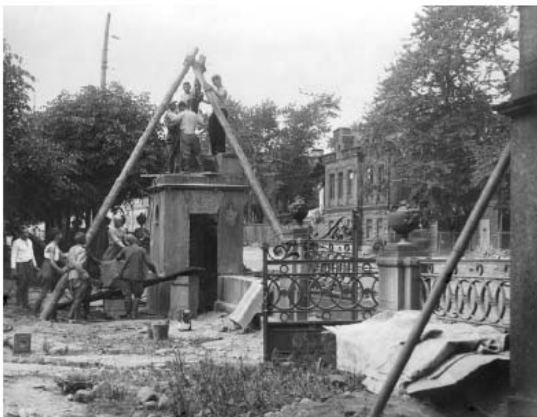
21. Восстановление ограды Гаврического дворца, разрушенной фугасной бомбой. 1943 г., фотография А.К. Григорьева. КГИОП
