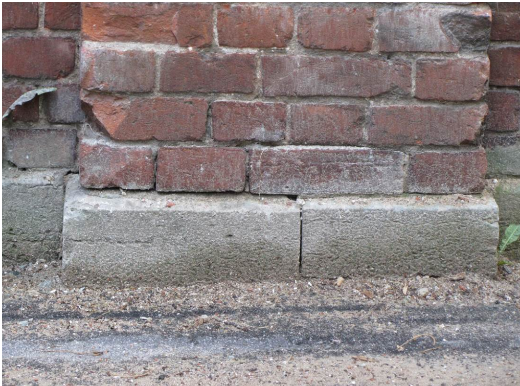
11. Казарма Офицерской стрелковой школы по адресу: г. Ломоносов, Владимирская ул., 15 Фрагменты торцевого фасада здания
