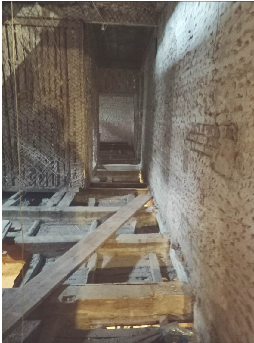
23. Казарма Офицерской стрелковой школы по адресу: г. Ломоносов, Владимирская ул., 15 Фрагмент интерьера 2-го этажа.
