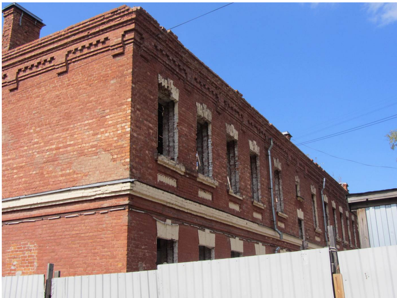
5. Казарма Офицерской стрелковой школы по адресу: г. Ломоносов, Владимирская ул., 16. Фрагмент торцевого и дворового фасадов казармы: венчающий карниз, оконные проемы 2-го этажа.
