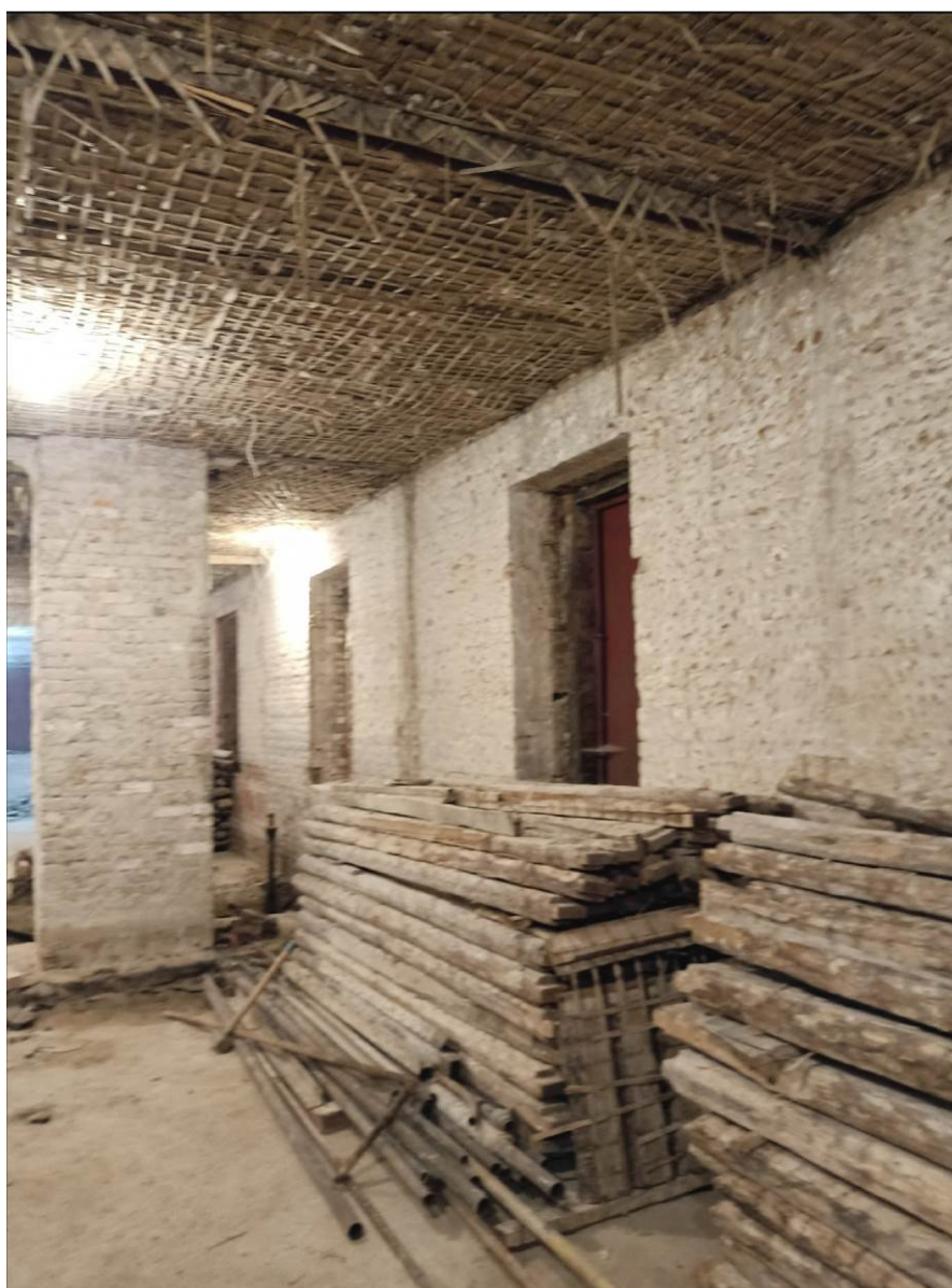
16. Казарма Офицерской стрелковой школы по адресу: г. Ломоносов, Владимирская ул., 15 Фрагмент интерьера 1-го этажа. Существующая кладка наружной стены.
