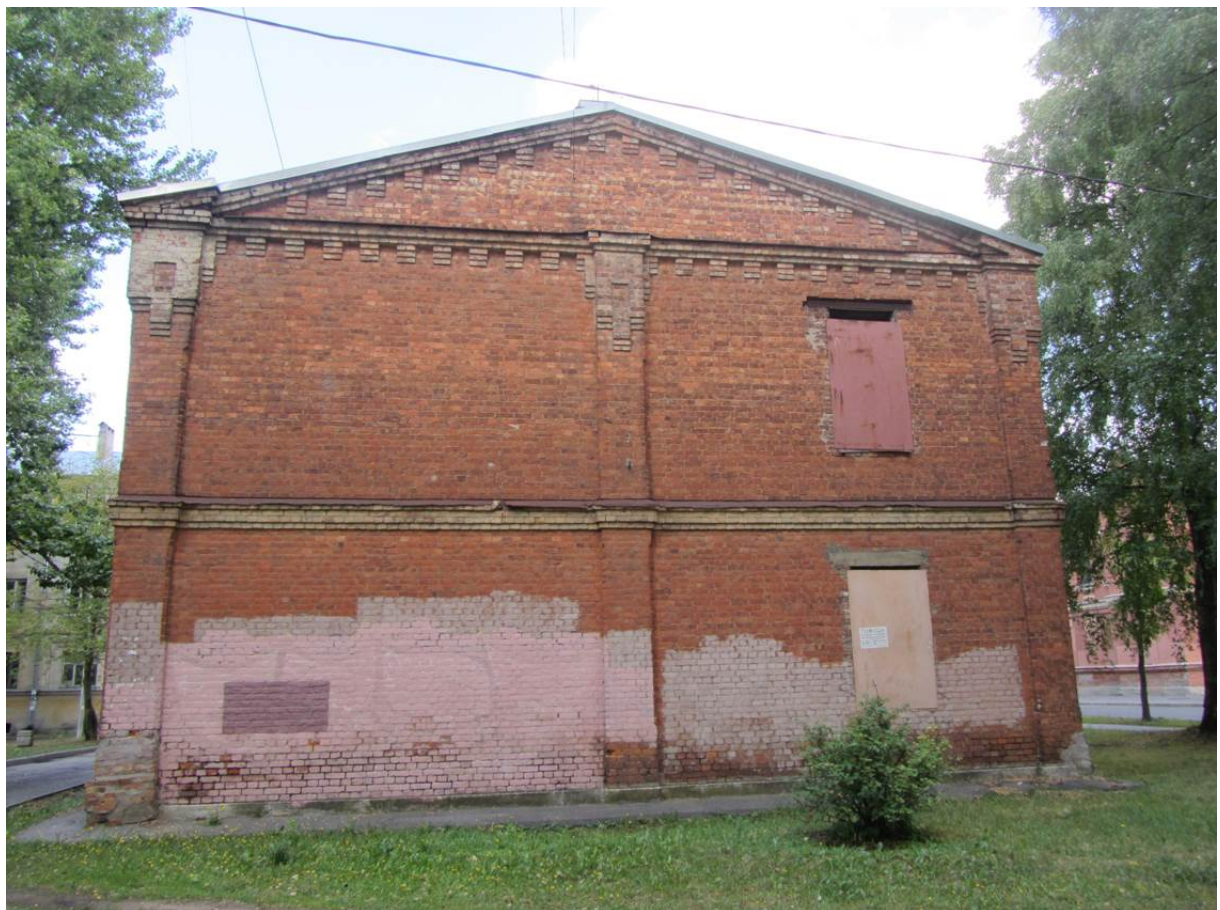
9. Казарма Офицерской стрелковой школы по адресу: г. Ломоносов, Владимирская ул., 15 Общий вид южного торцевого фасада здания
