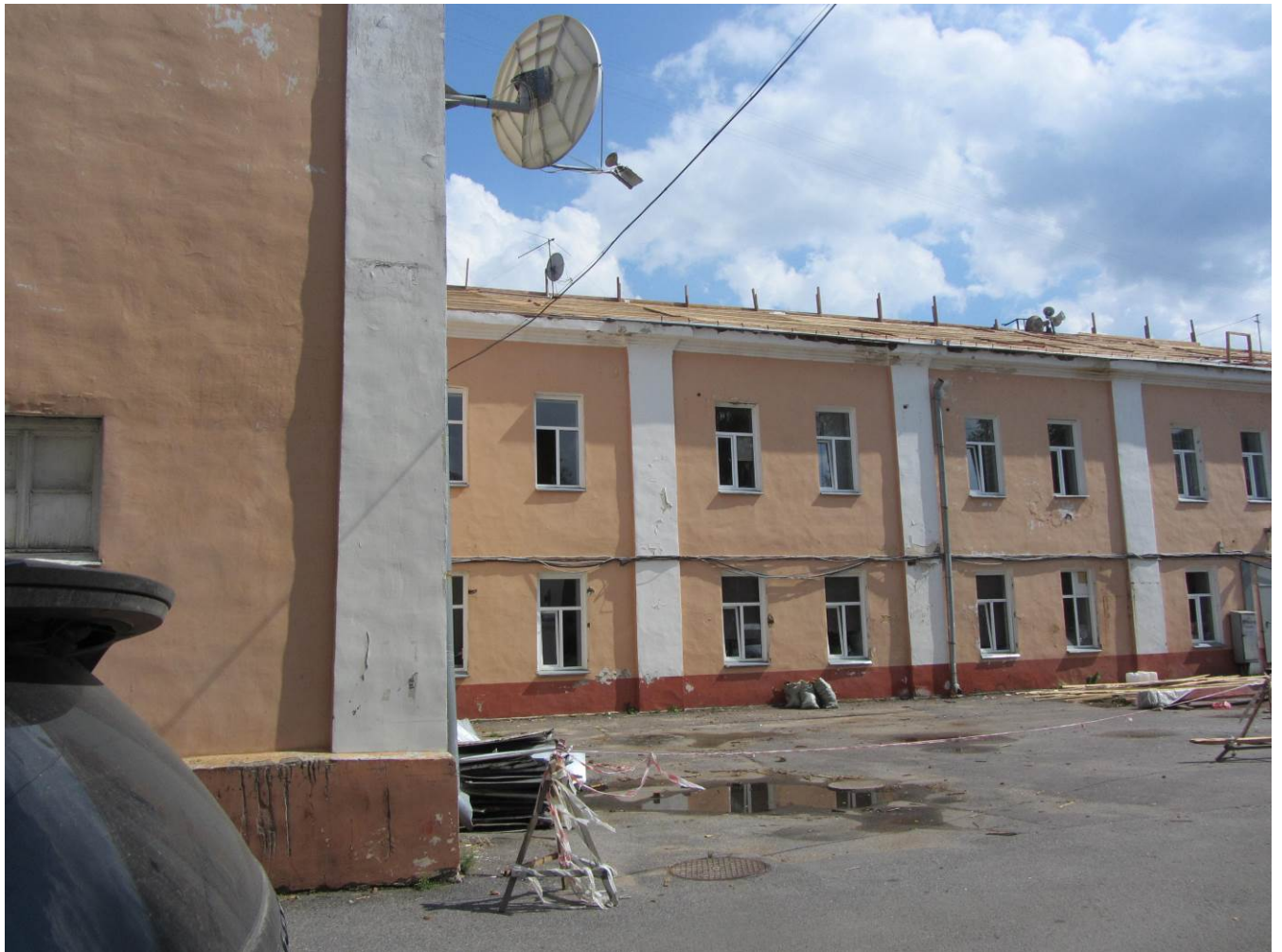
5. Казарма Офицерской стрелковой школы по адресу: г. Ломоносов, Владимирская ул., 19. Общий вид дворовых фасадов. Вид с северо-запада.
