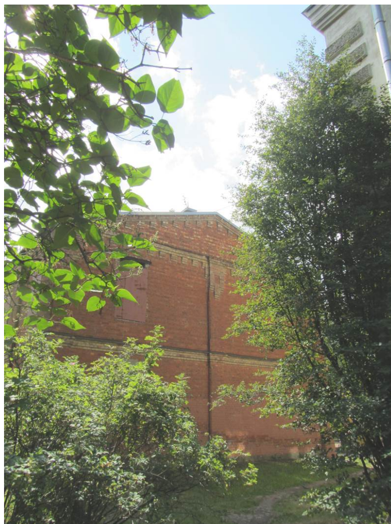
4. Казарма Офицерской стрелковой школы по адресу: г. Ломоносов, Владимирская ул., 15 Общий вид северного торцевого фасада здания
