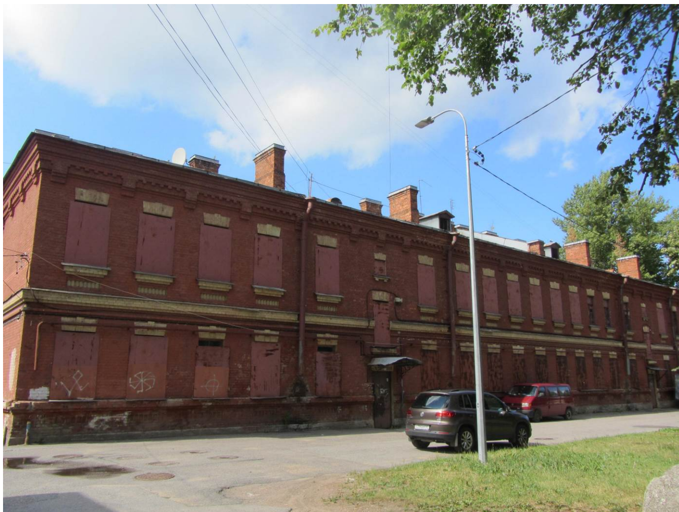
2. Казарма Офицерской стрелковой школы по адресу: г. Ломоносов, Владимирская ул., 12. Дворовой восточный фасад. Вид с юго-востока.
