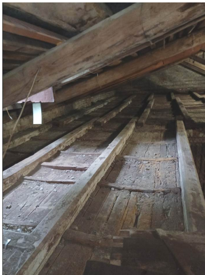
28. Казарма Офицерской стрелковой школы по адресу: г. Ломоносов, Владимирская ул., 15 Фрагменты интерьера чердака.
