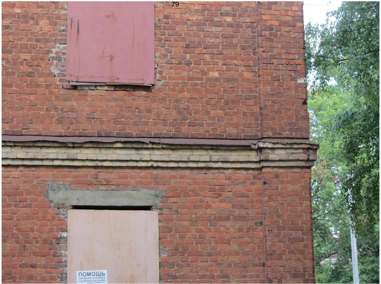
12. Казарма Офицерской стрелковой школы по адресу: г. Ломоносов, Владимирская ул., 15 Фрагмент торцевого фасада здания
