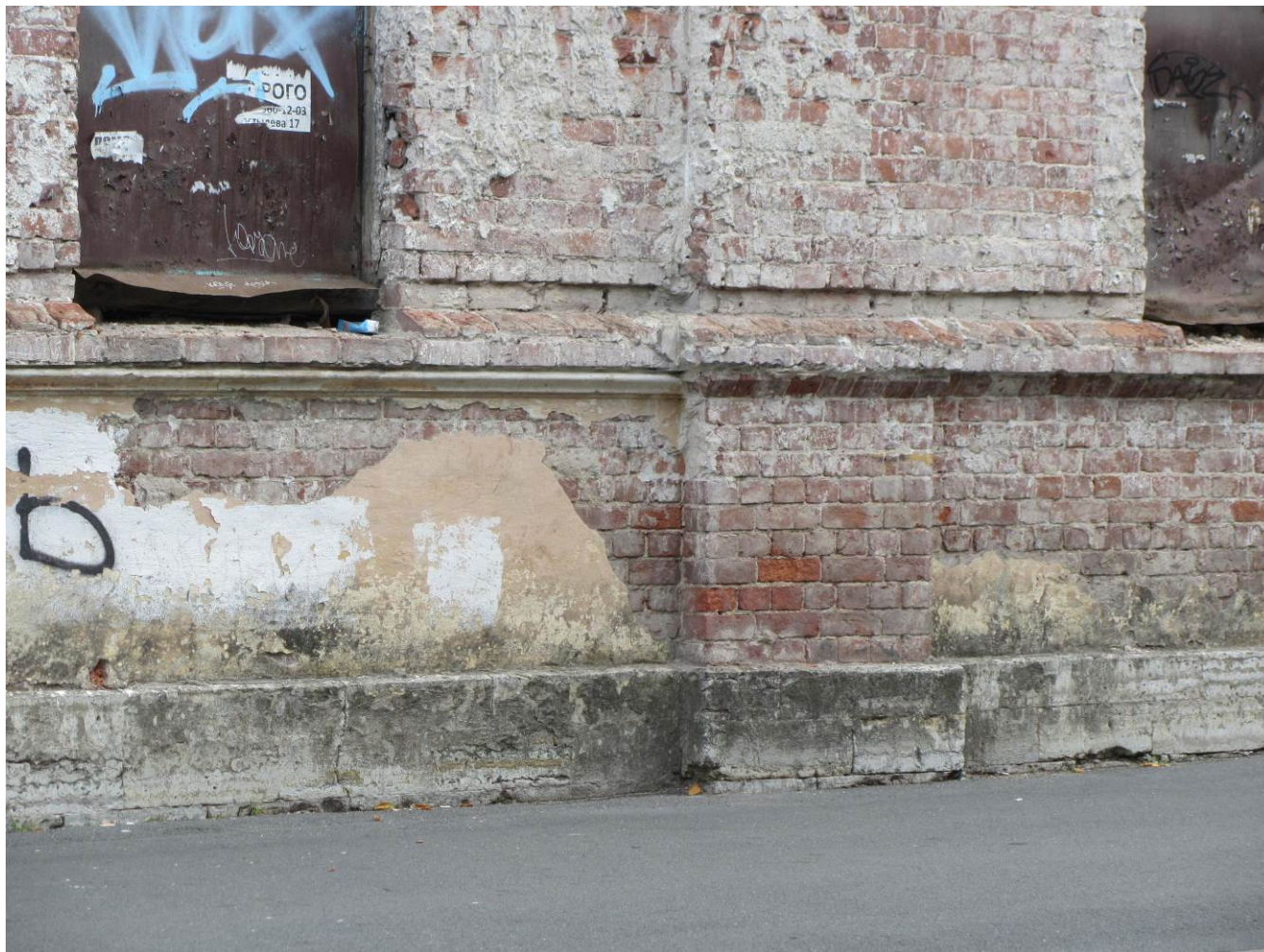
6. Казарма Офицерской стрелковой школы по адресу: г. Ломоносов, Владимирская ул., 10. Фрагмент западного лицевого фасада. Цокольная часть.
