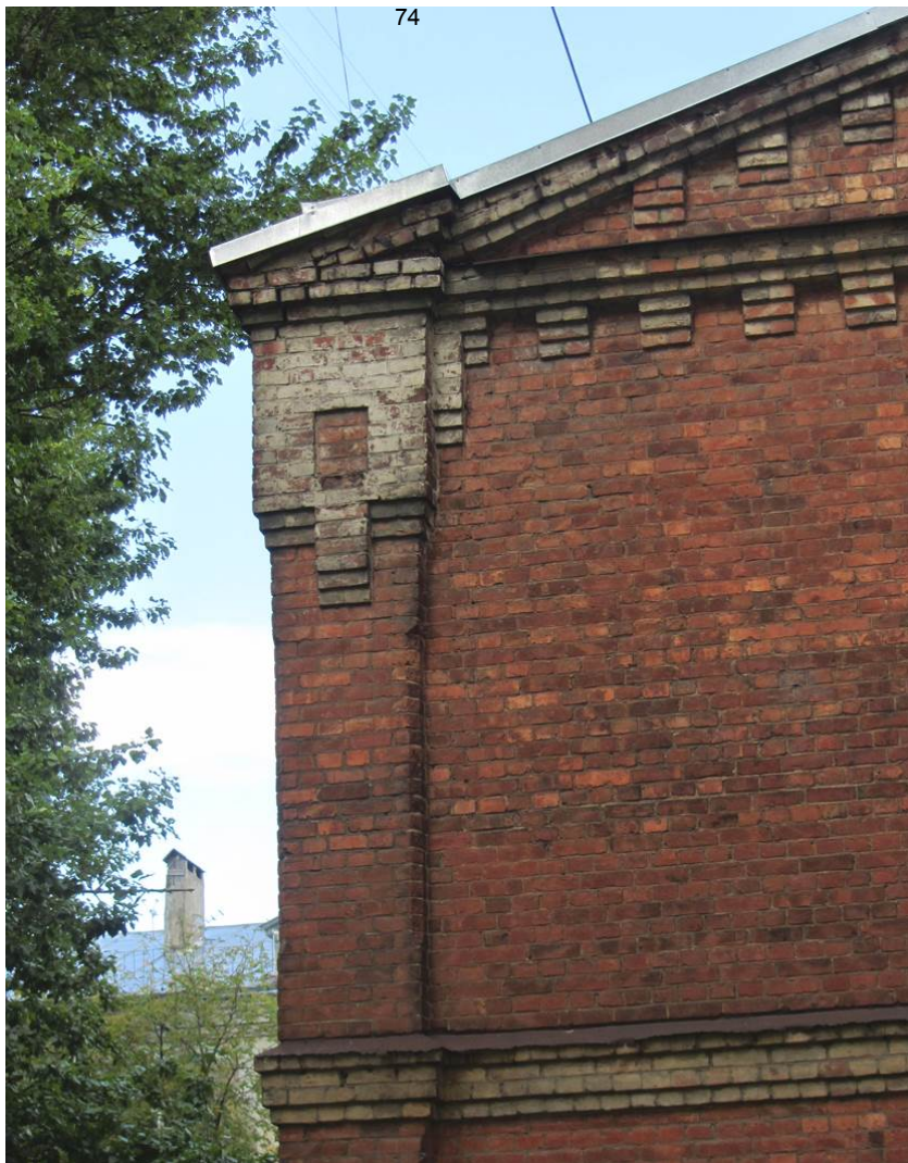
5. Казарма Офицерской стрелковой школы по адресу: г. Ломоносов, Владимирская ул., 15 Фрагмент торцевого фасада здания
