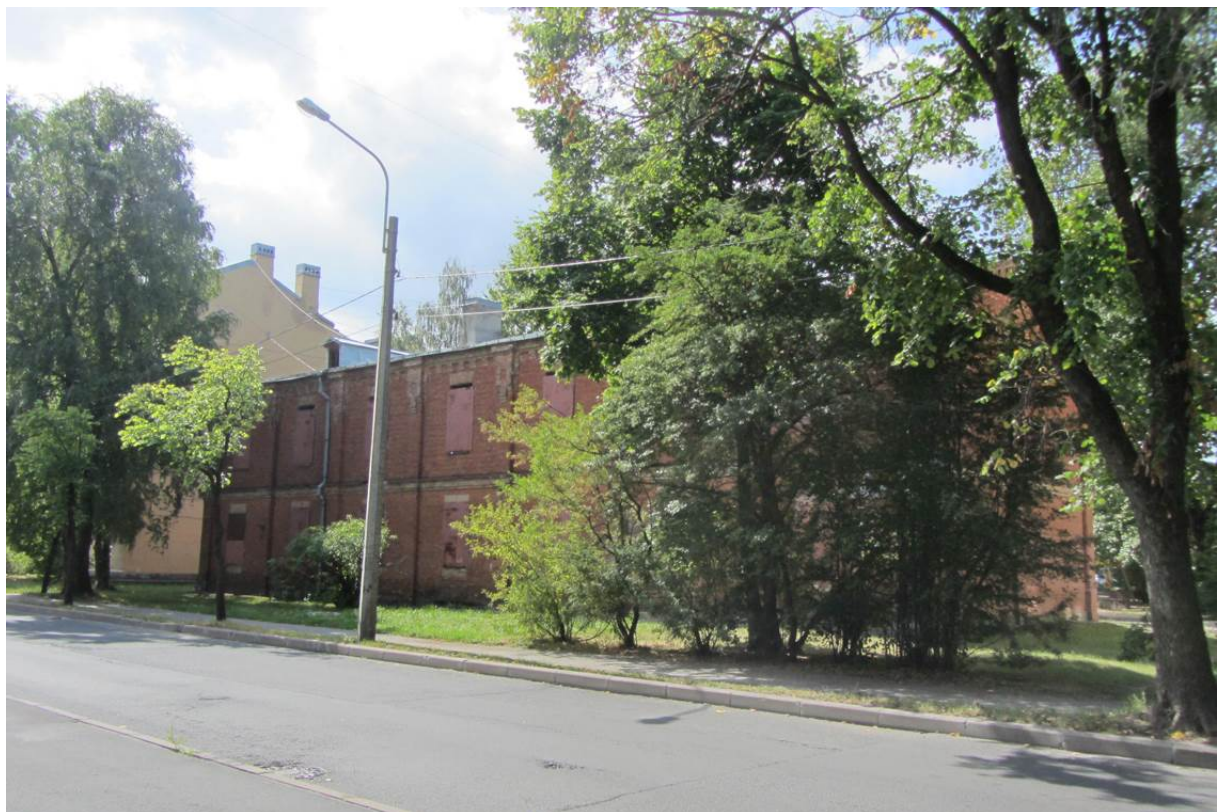
2. Казарма Офицерской стрелковой школы по адресу: г. Ломоносов, Владимирская ул., 15 Общий вид лицевого фасада здания. Вид с северо-востока.
