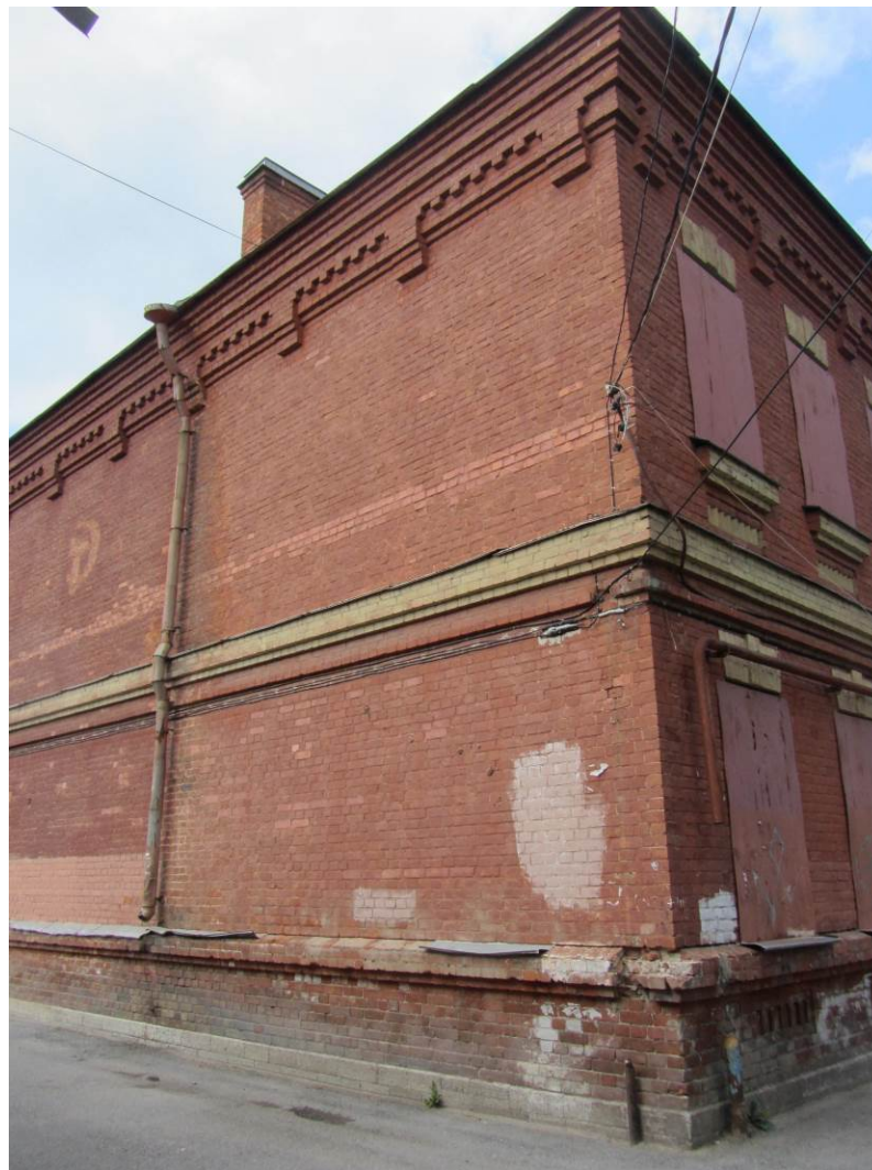
3. Казарма Офицерской стрелковой школы по адресу: г. Ломоносов, Владимирская ул., 12. Торцевой южный фасад. Вид с юго-востока.
