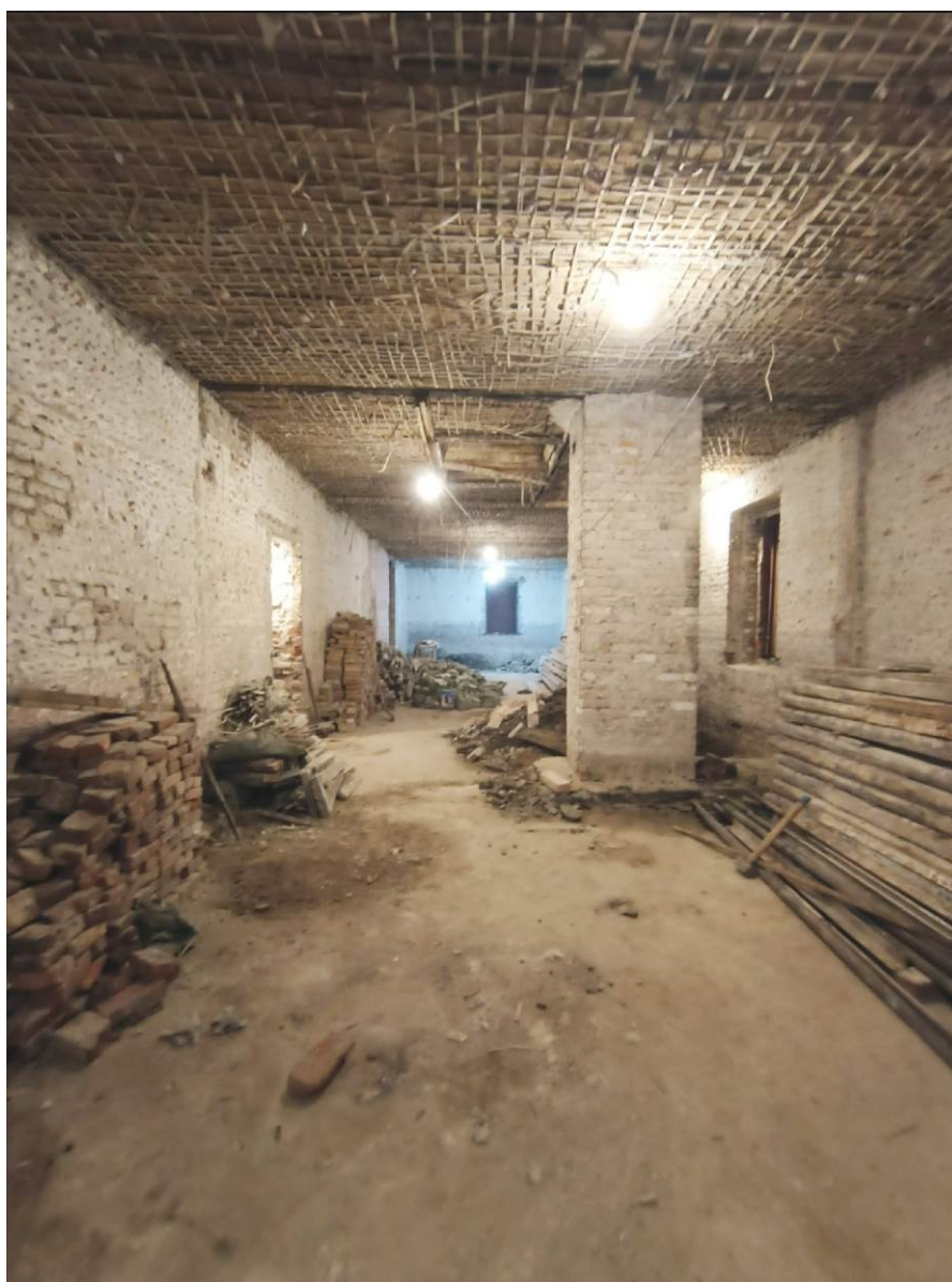
15. Казарма Офицерской стрелковой школы по адресу: г. Ломоносов, Владимирская ул., 15 Фрагмент интерьера 1-го этажа.
