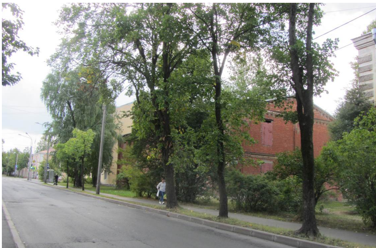
1. Казарма Офицерской стрелковой школы по адресу: г. Ломоносов, Владимирская ул., 15. Общий вид здания. Вид с севера.
