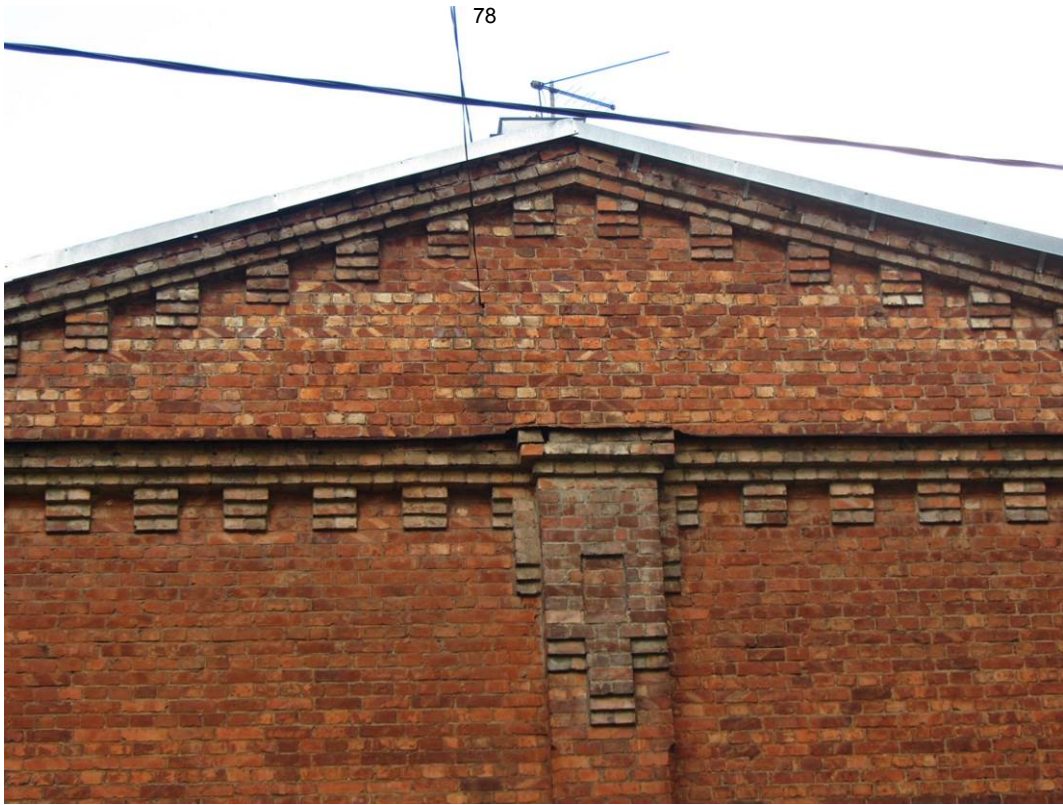
10. Казарма Офицерской стрелковой школы по адресу: г. Ломоносов, Владимирская ул., 15 Фрагменты торцевого фасада здания
