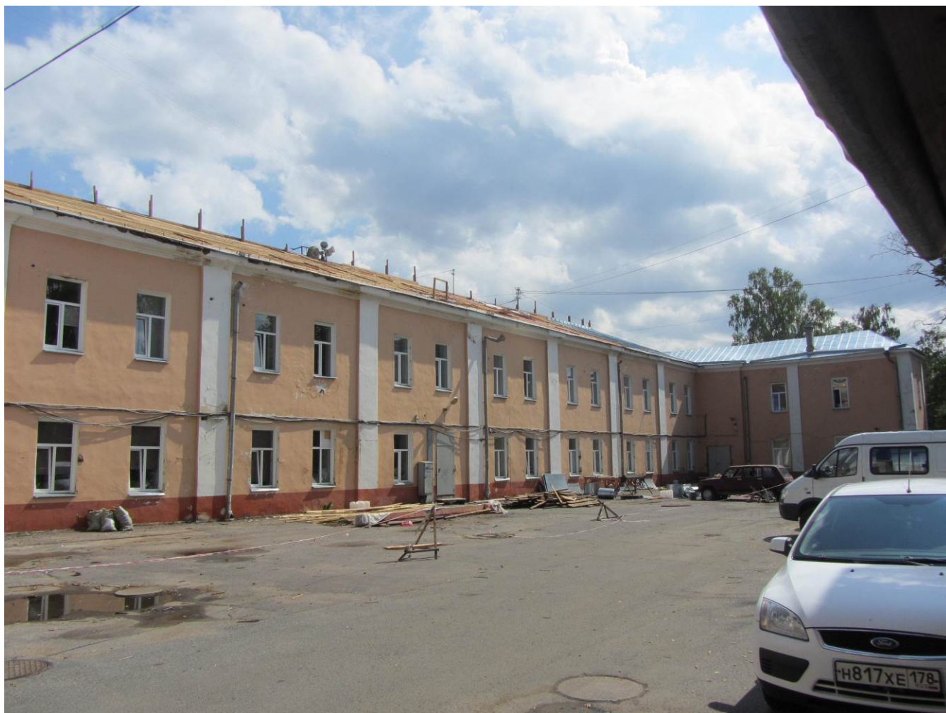
3. Казарма Офицерской стрелковой школы по адресу: г. Ломоносов, Владимирская ул., 19. Общий вид дворового фасада. Вид с северо-запада.
