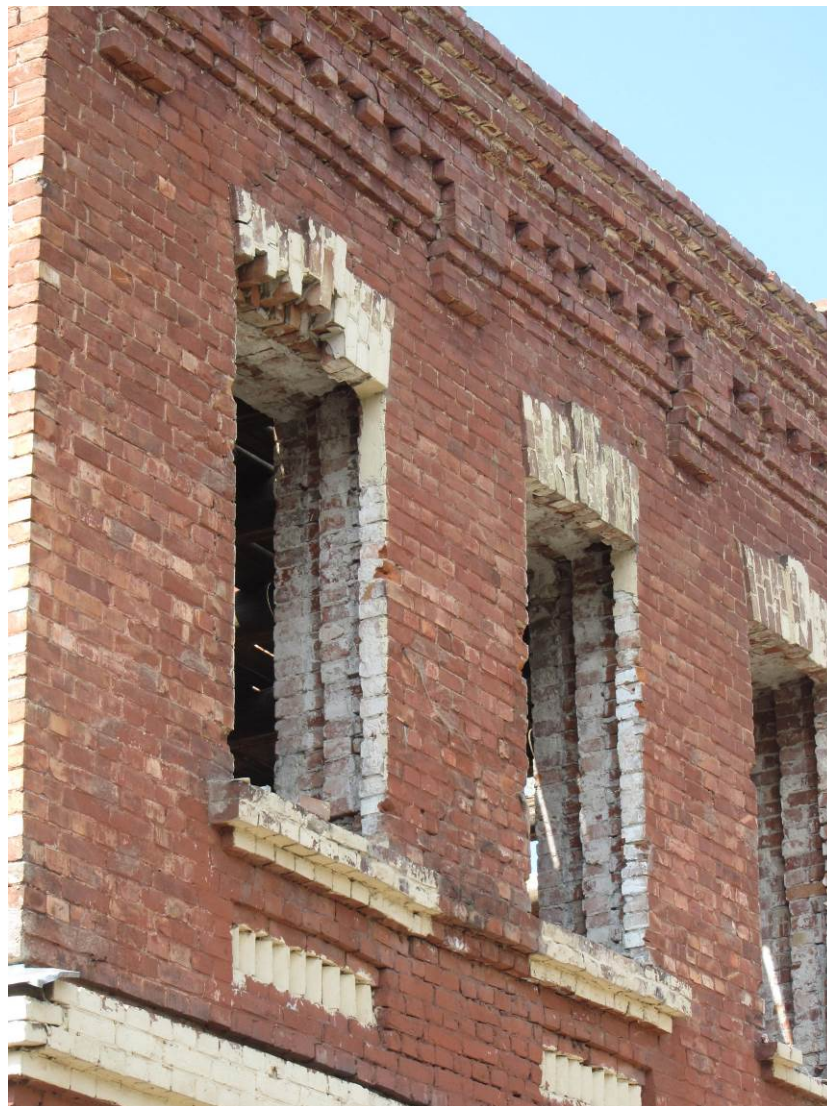
6. Казарма Офицерской стрелковой школы по адресу: г. Ломоносов, Владимирская ул., 16. Фрагмент дворового фасада: оконные проёмы 2-го этажа.
