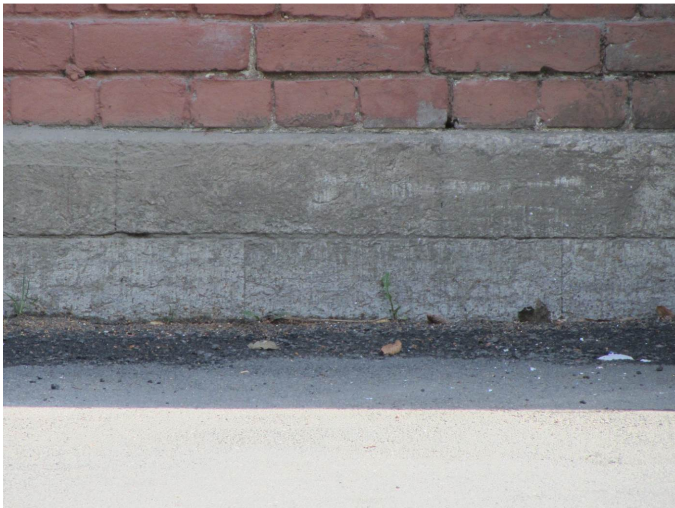
9. Казарма Офицерской стрелковой школы по адресу: г. Ломоносов, Владимирская ул., 12. Деталь цоколя.
