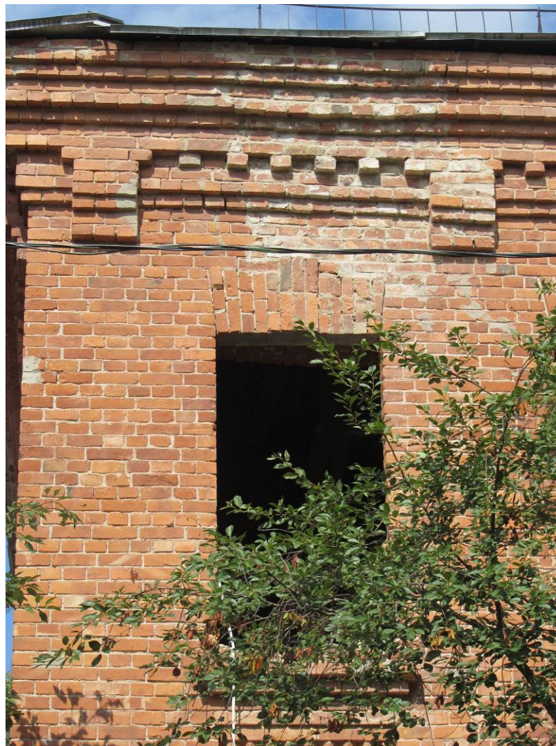
8. Казарма Офицерской стрелковой школы по адресу: г. Ломоносов, Владимирская ул., 16а. Деталь южного фасада. Венчающий карниз.
