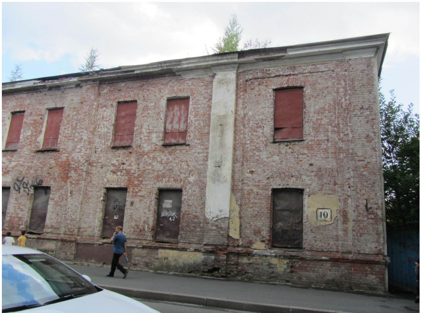
4. Казарма Офицерской стрелковой школы по адресу: г. Ломоносов, Владимирская ул., 10. Фрагмент западного фасада. Южная часть.
