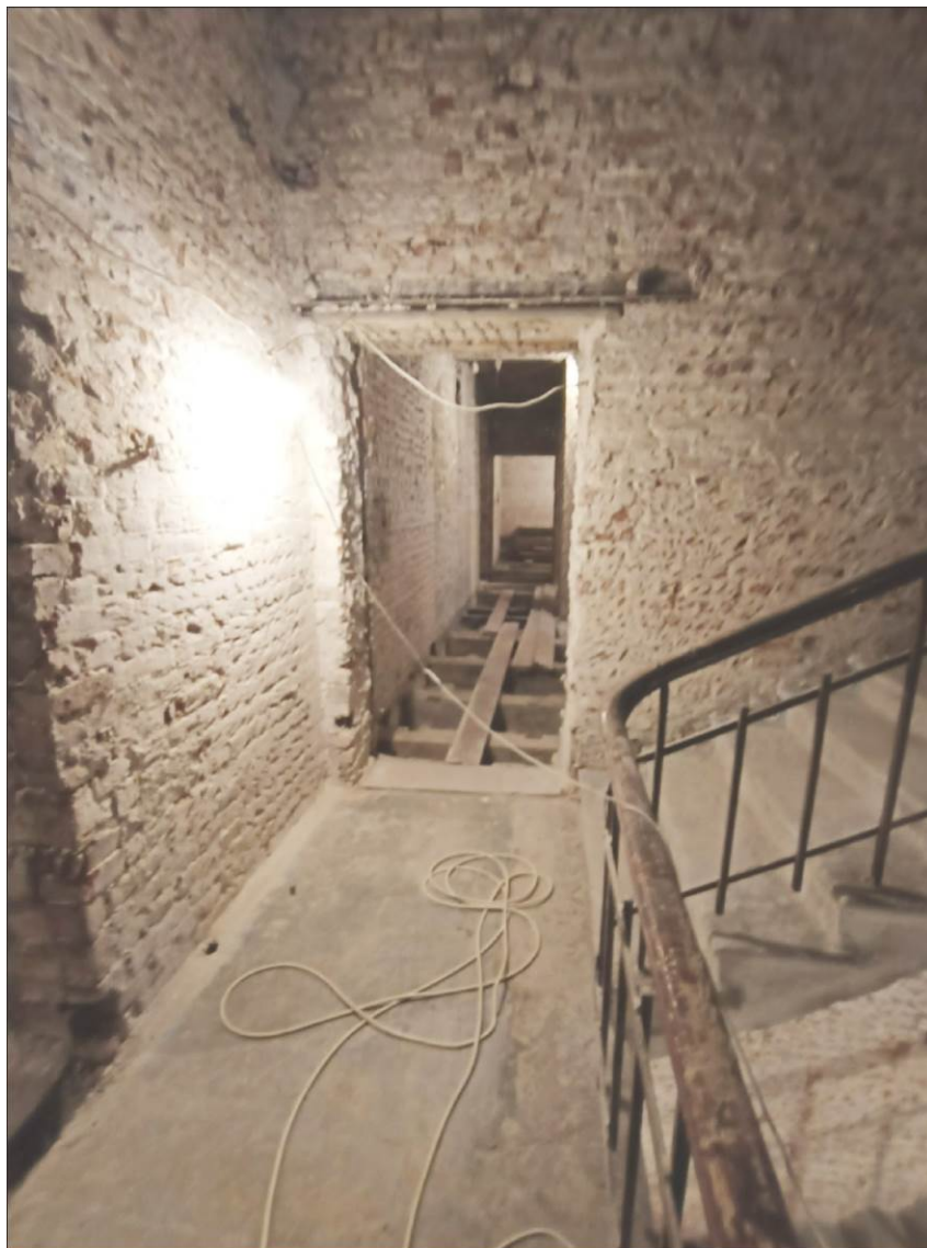
21. Казарма Офицерской стрелковой школы по адресу: г. Ломоносов, Владимирская ул., 15 Фрагмент интерьера. Фрагмент лестничной клетки.
