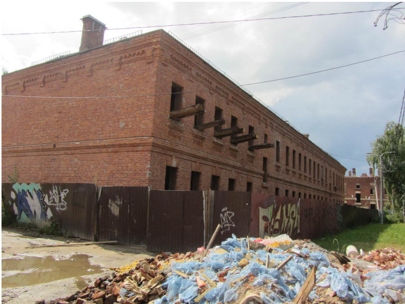
4. Казарма Офицерской стрелковой школы по адресу: г. Ломоносов, Владимирская ул., 16а. Общий вид северного фасада. Вид с северо-востока.
