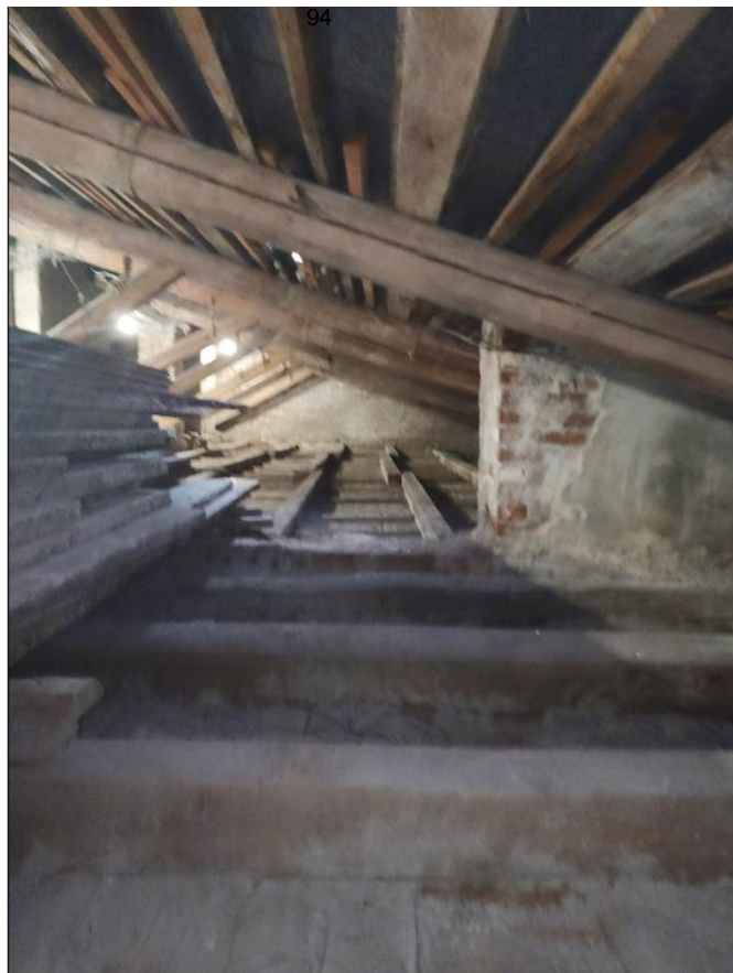
27. Казарма Офицерской стрелковой школы по адресу: г. Ломоносов, Владимирская ул., 15 Фрагменты интерьера чердака.
