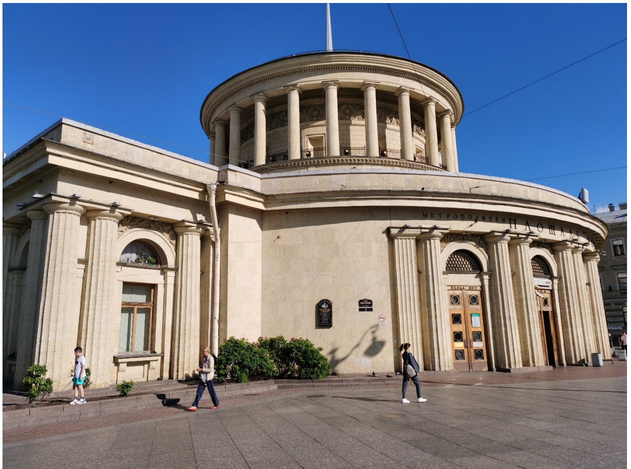
1. Юго-восточный фасад объекта культурного наследия регионального значения «Станция метро «Площадь Восстания» (с перронным залом)», расположенного по адресу: г. Санкт-Петербург, площадь Восстания, д. 2, литера А. 01.07.2022
