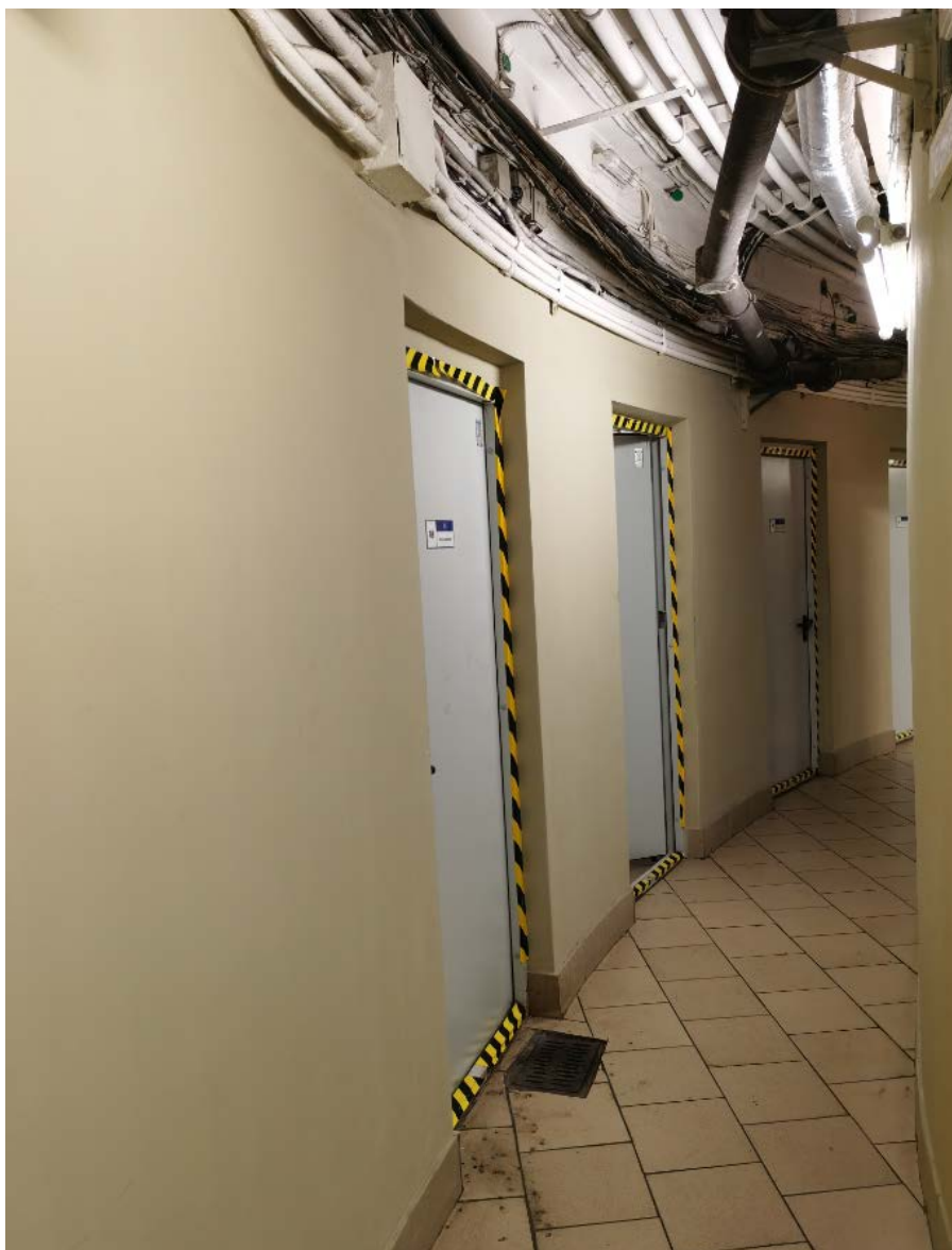
7. Помещение 1-Н (ч.п. 48) объекта культурного наследия регионального значения «Станция метро «Площадь Восстания» (с перронным залом)», расположенного по адресу: г. Санкт-Петербург, площадь Восстания, д. 2, литера А. 01.07.2022
