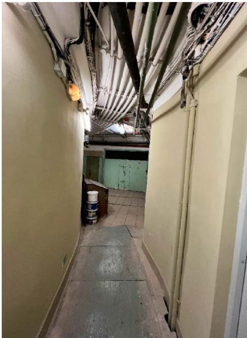
8. Помещение 1-Н (ч.п. 48) объекта культурного наследия регионального значения «Станция метро «Площадь Восстания» (с перронным залом)», расположенного по адресу: г. Санкт-Петербург, площадь Восстания, д. 2, литера А. 01.07.2022
