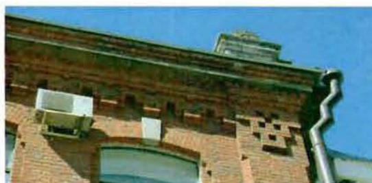
аттиковая стенка, с двумя фланкирующими прямоугольными филенчатыми тумбами, с профилированным карнизом; фигурные известняковые навершия тумб с кованым металлическим декором;
