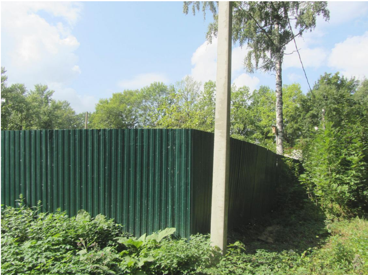
8. Выявленный объект культурного наследия «Служебное здание». Общий вид с северо-востока.
