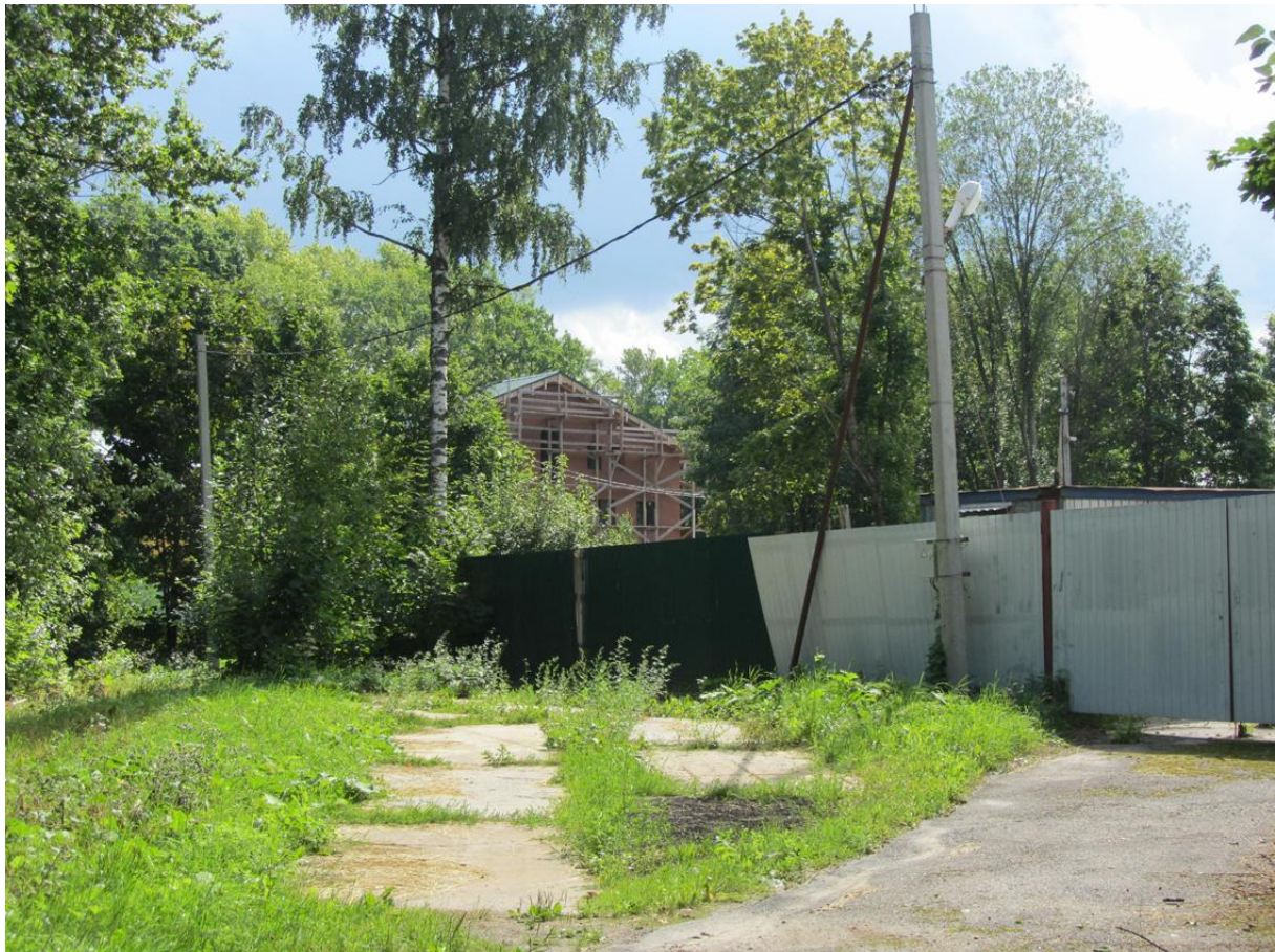
9. Выявленный объект культурного наследия «Служебное здание». Общий вид с северо-запада.
