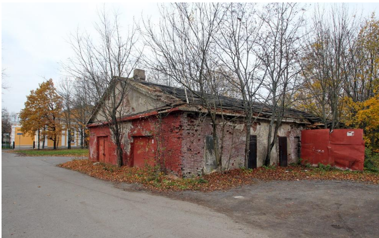
19. Выявленный объект культурного наследия «Служебное здание». Вид с востока. Фотография 2016 г.
