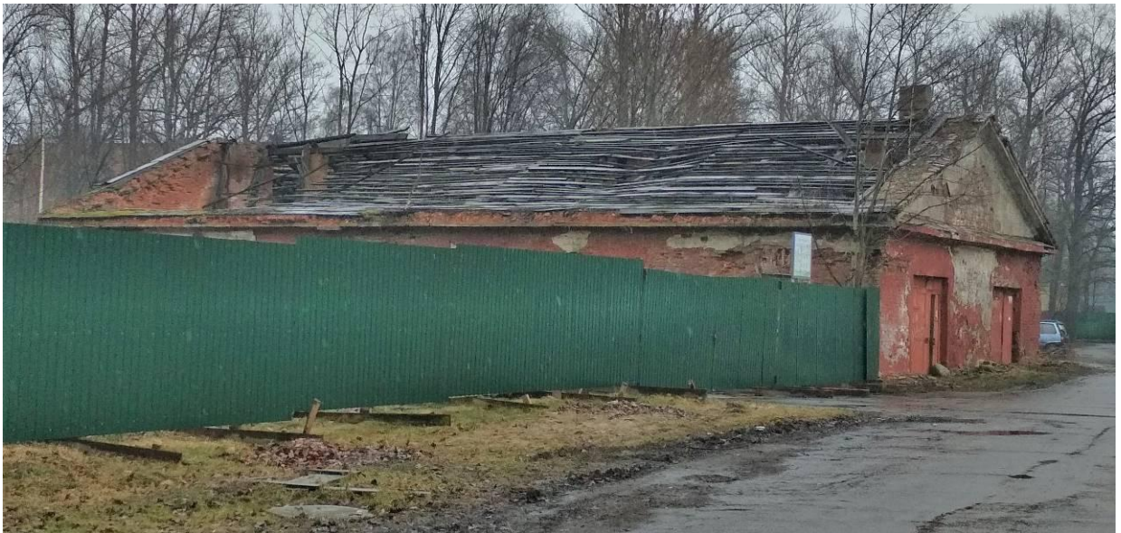
20. Выявленный объект культурного наследия «Служебное здание». Общий вид с юго-запада. Фотография 2018 г.
