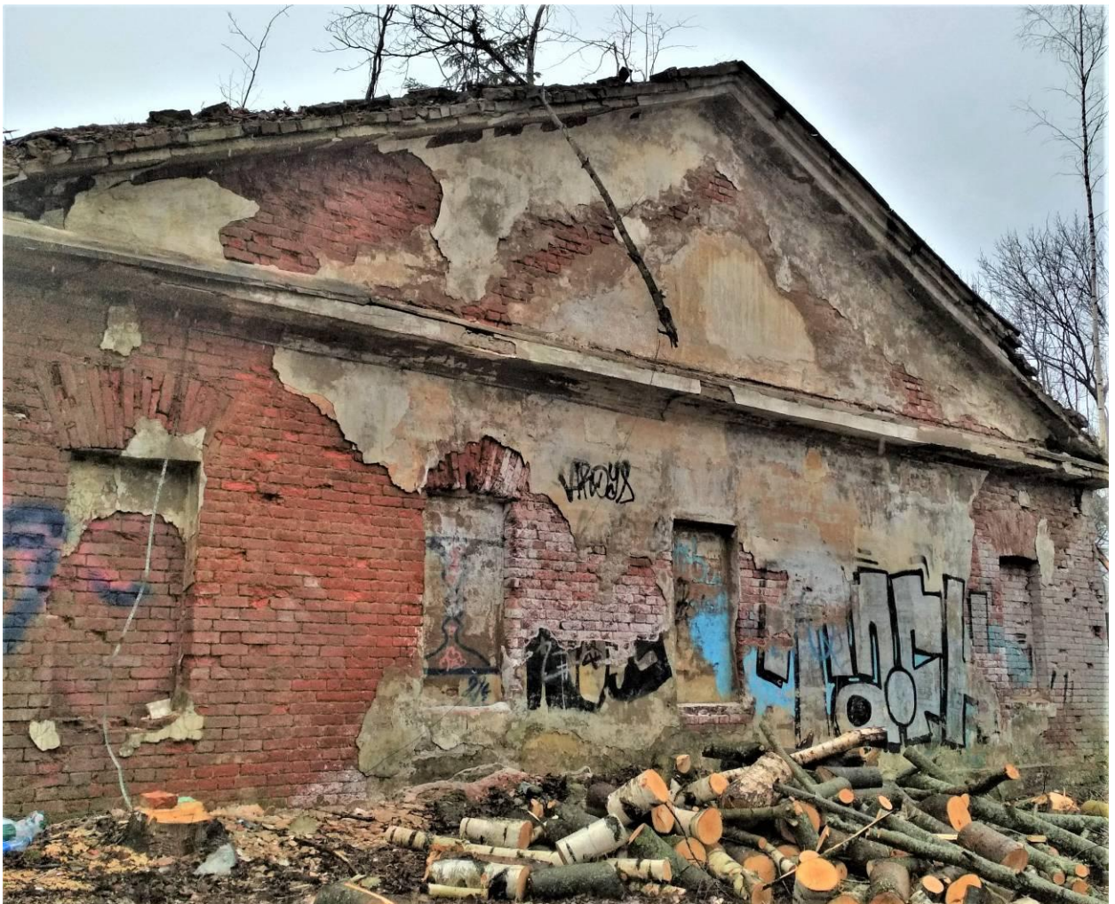
21. Выявленный объект культурного наследия «Служебное здание». Северный фасад. Фотография 2018 г.
