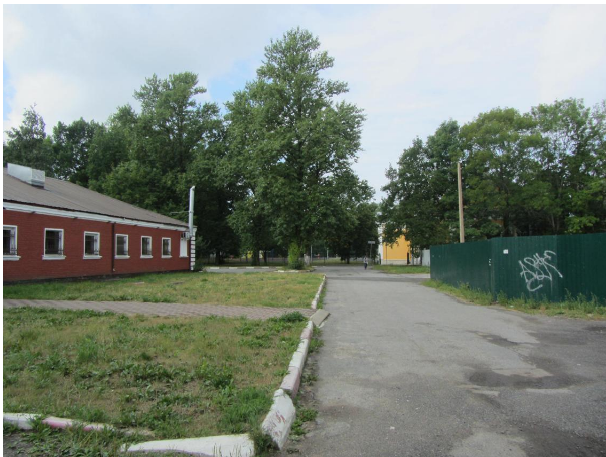
5. Выявленный объект культурного наследия «Службное здание». Общий вид в сторону Экзерциргауза лейб-гвардии Волынского полка. Слева – Службное здание (Манежная, 8А)
