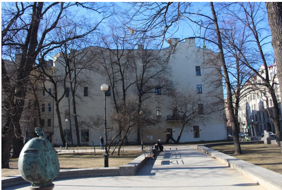
Фото 29. Вид на южный фасад выявленного объекта культурного наследия «Дом Э.Г. Шведерского».
