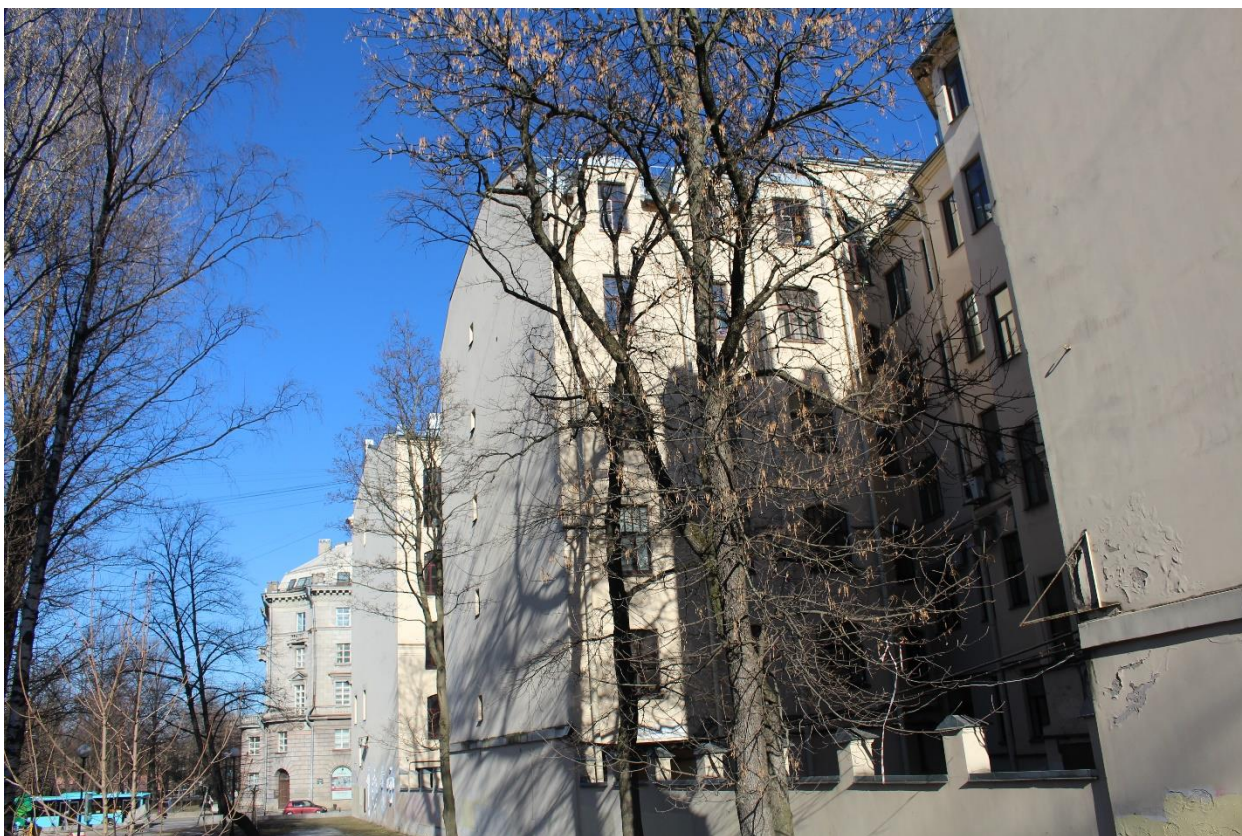
Фото 28. Вид на кирпичную оштукатуренную ограду дворовых корпусов объекта культурного наследия федерального значения «Дом, где в 1926-1934 гг. в квартире 20 жил секретарь Ленинградского губкома ВКП(б) Киров С.М.» с запада.
