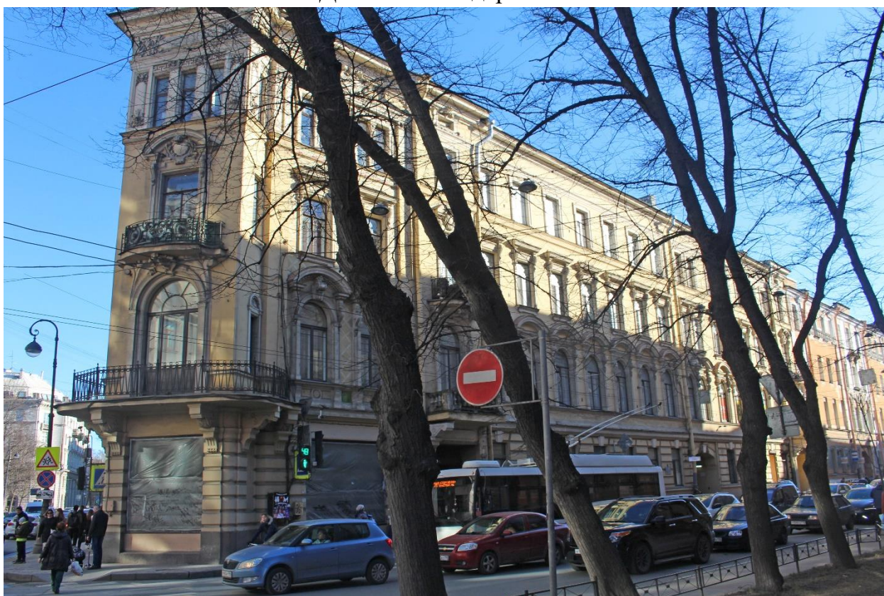
Фото 35. Вид на лицевой фасад северо-западного лицевого корпуса выявленного объекта культурного наследия «Дом Э.Г. Шведерского».
