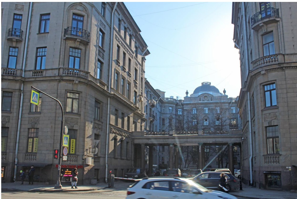
Фото 3. Вид на лицевой двор объекта культурного наследия федерального значения «Дом, где в 1926-1934 гг. в квартире 20 жил секретарь Ленинградского губкома ВКП(б) Киров С.М.» с востока.
