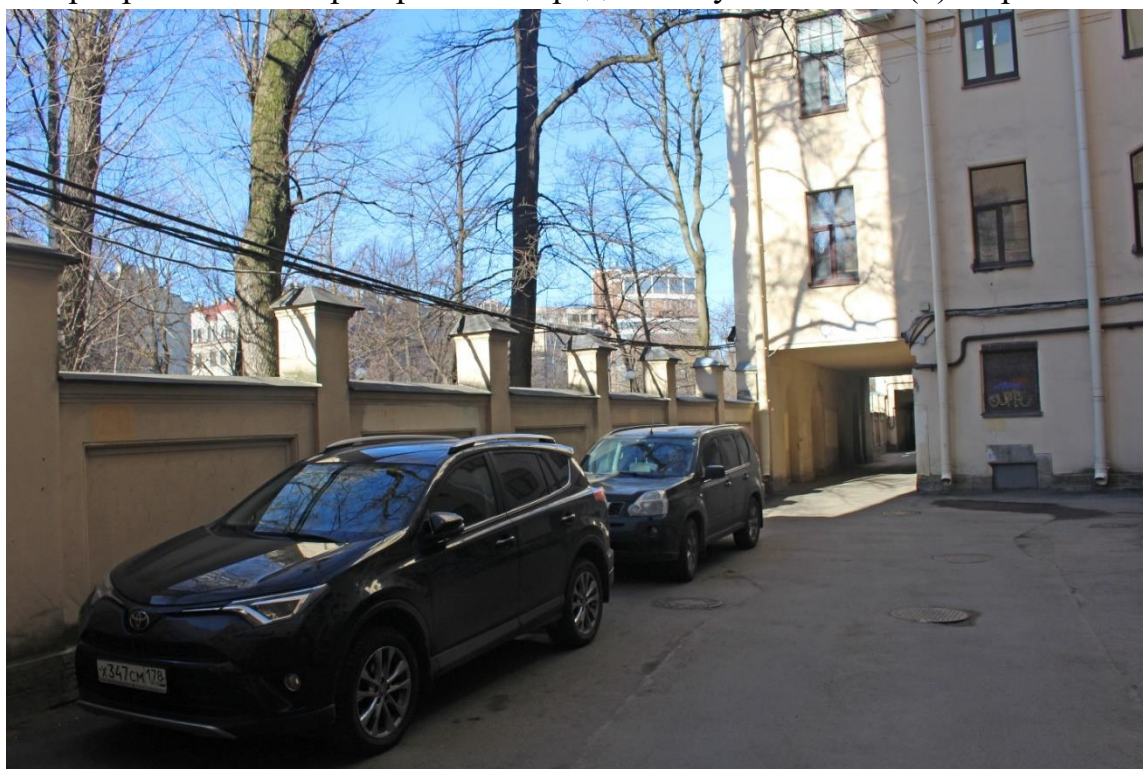
Фото 13. Вид на кирпичную оштукатуренную ограду дворежных корпусов объекта культурного наследия федерального значения «Дом, где в 1926-1934 гг. в квартире 20 жил секретарь Ленинградского губкома ВКП(б) Киров С.М.» с юга.
