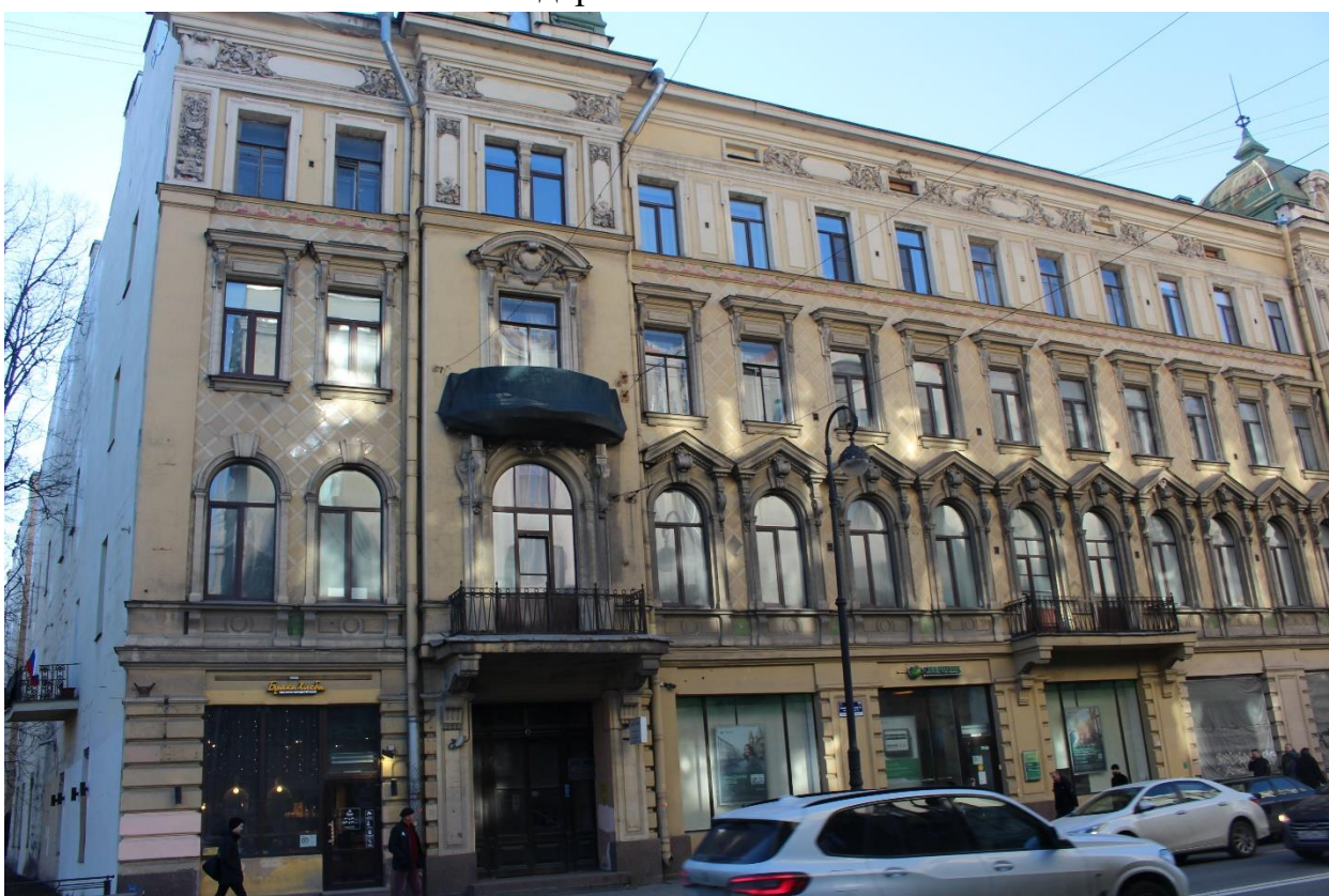
Фото 33. Вид на восточный фасад восточного лицевого корпуса выявленного объекта культурного наследия «Дом Э.Г. Шведерского».
