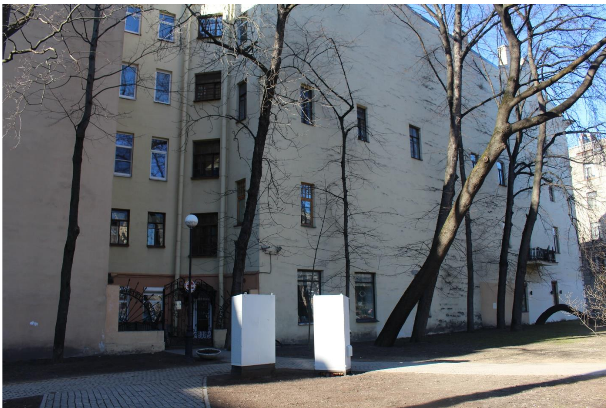
Фото 30. Вид на южный фасад выявленного объекта культурного наследия «Дом Э.Г. Шведерского».
