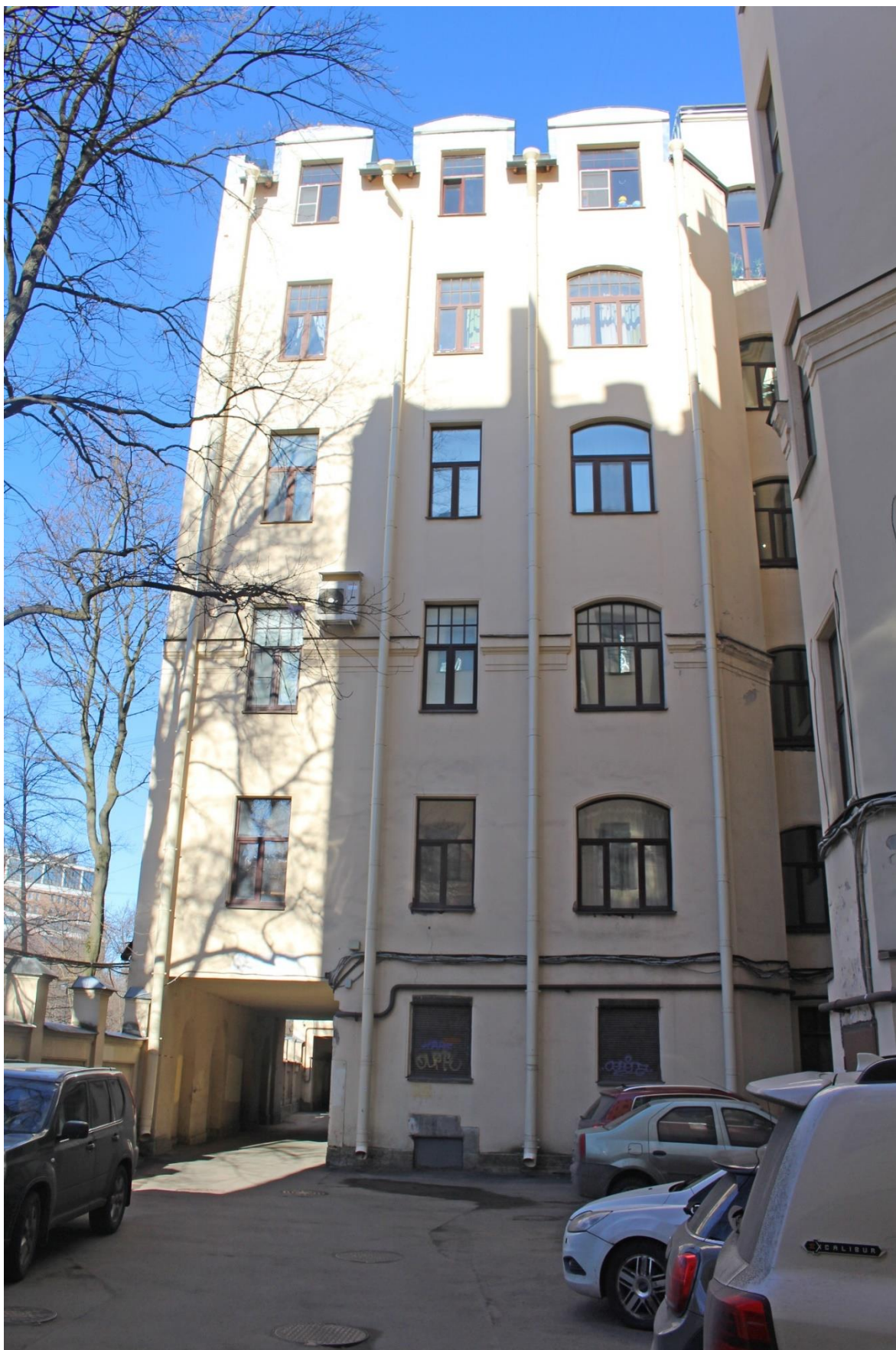
Фото 14. Вид на фасад дворового корпуса в северной части объекта культурного наследия федерального значения «Дом, где в 1926-1934 гг. в квартире 20 жил секретарь Ленинградского губкома ВКП(б) Киров С.М.».
