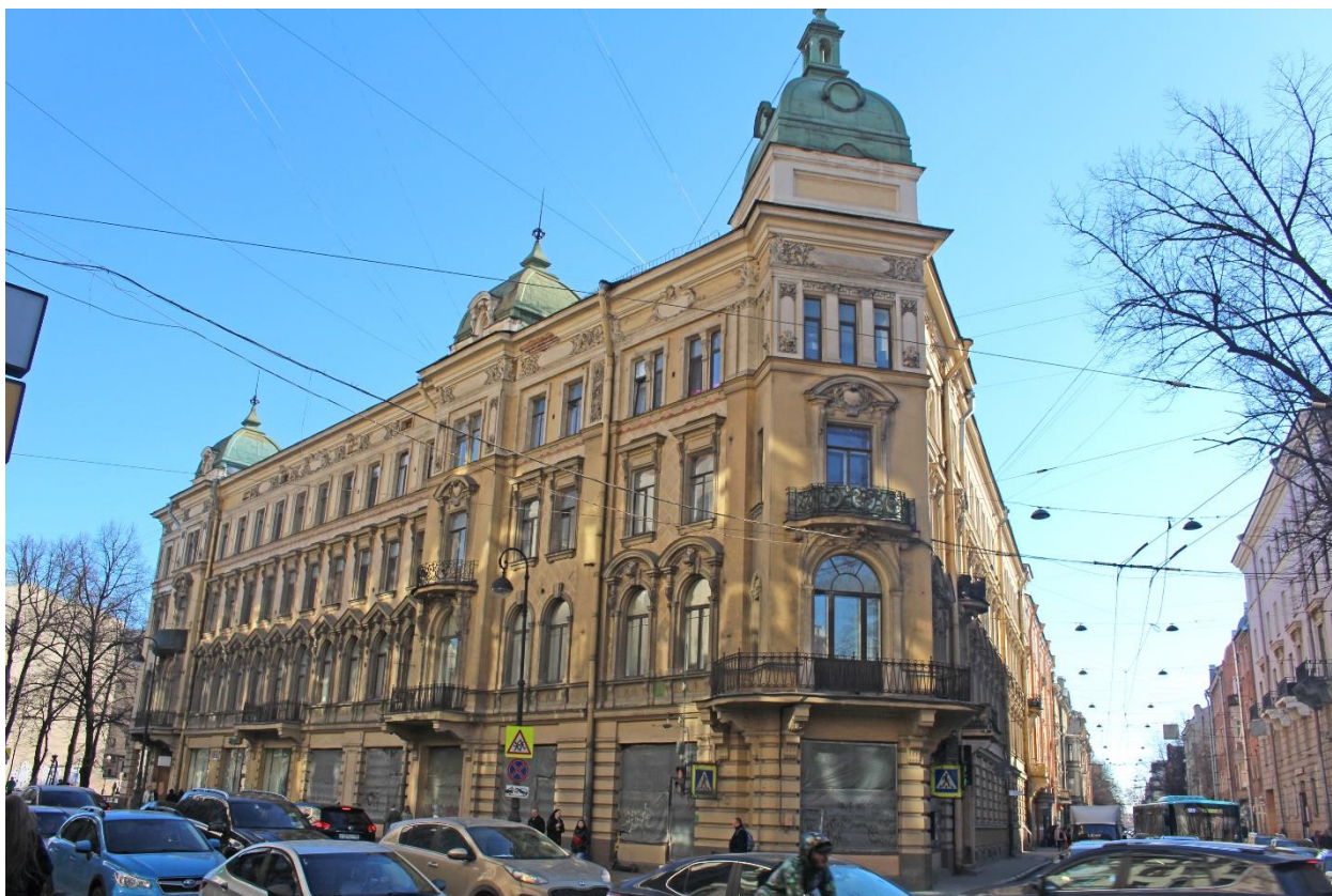
Фото 34. Вид на северный угол выявленного объекта культурного наследия «Дом Э.Г. Шведерского».
