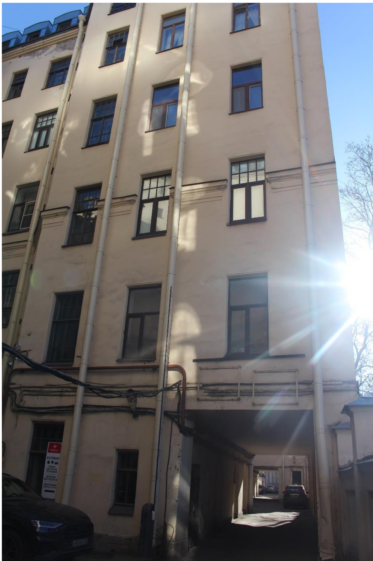
Фото 17. Вид на фасад дворового корпуса в северной части объекта культурного наследия федерального значения «Дом, где в 1926-1934 гг. в квартире 20 жил секретарь Ленинградского губкома ВКП(б) Киров С.М.».
