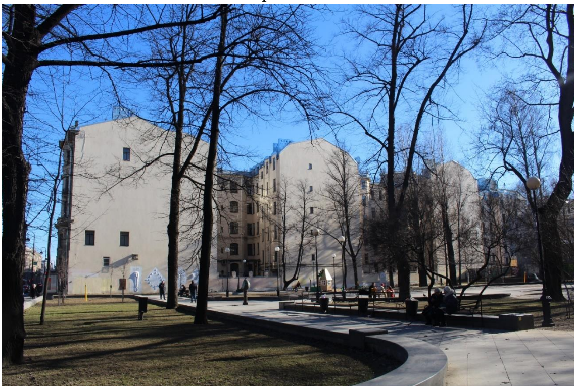
Фото 8. Вид на северные фасады лицевого и дворовых корпусов объекта культурного наследия федерального значения «Дом, где в 1926-1934 гг. в квартире 20 жил секретарь Ленинградского губкома ВКП(б) Киров С.М.» с севера.
