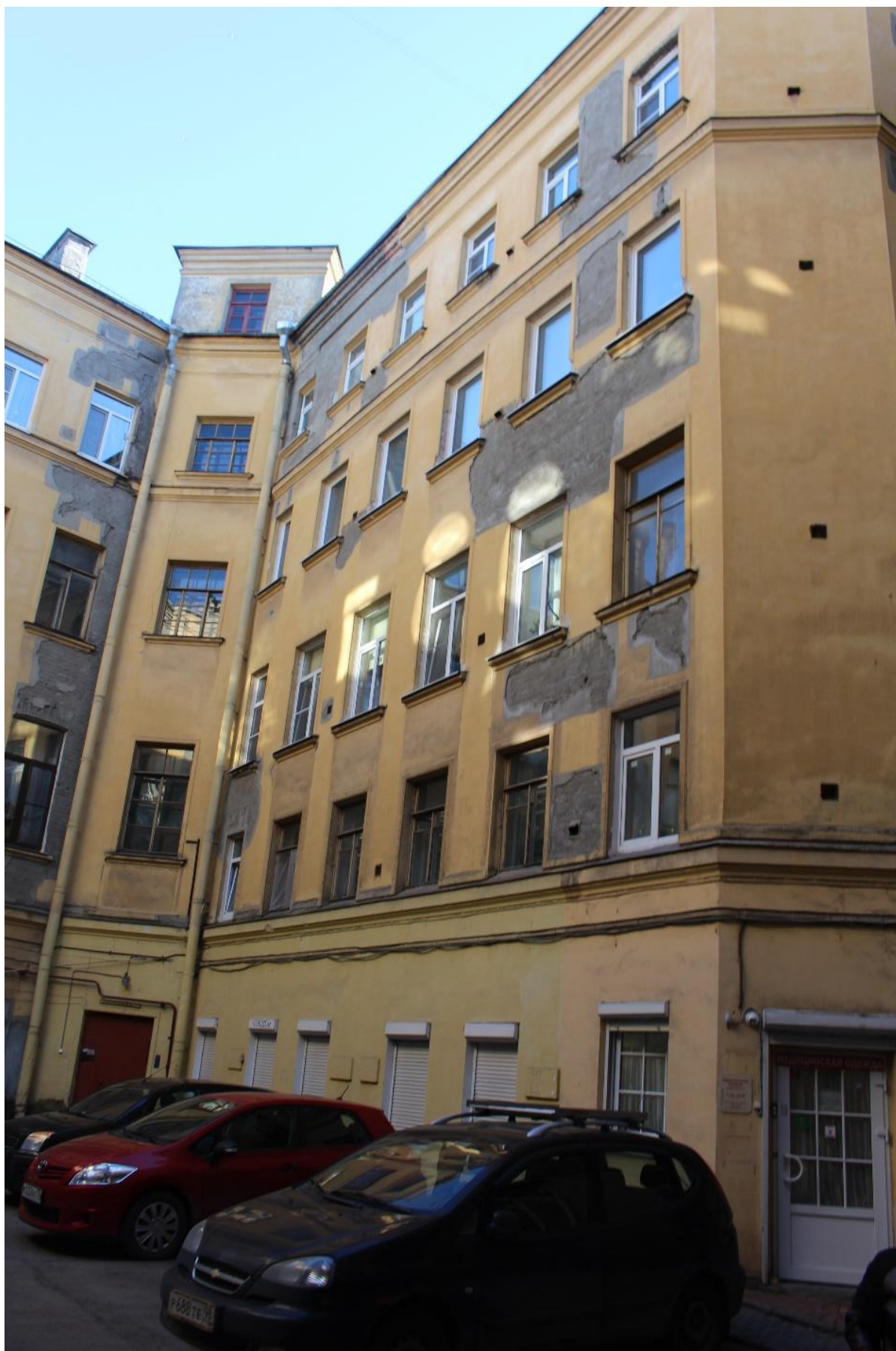
Фото 41. Вид на восточный фасад западного дворового корпуса выявленного объекта культурного наследия «Дом Э.Г. Шведерского».
