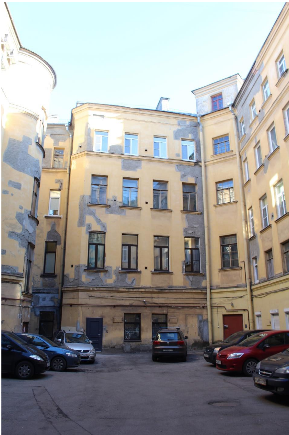
Фото 39. Вид на дворовый (северный) фасад южного дворового корпуса выявленного объекта культурного наследия «Дом Э.Г. Шведерского».
