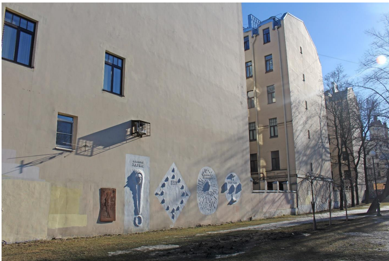
Фото 9. Вид на кирпичную оштукатуренную ограду дворовых корпусов объекта культурного наследия федерального значения «Дом, где в 1926-1934 гг. в квартире 20 жил секретарь Ленинградского губкома ВКП(б) Киров С.М.» с севера.
