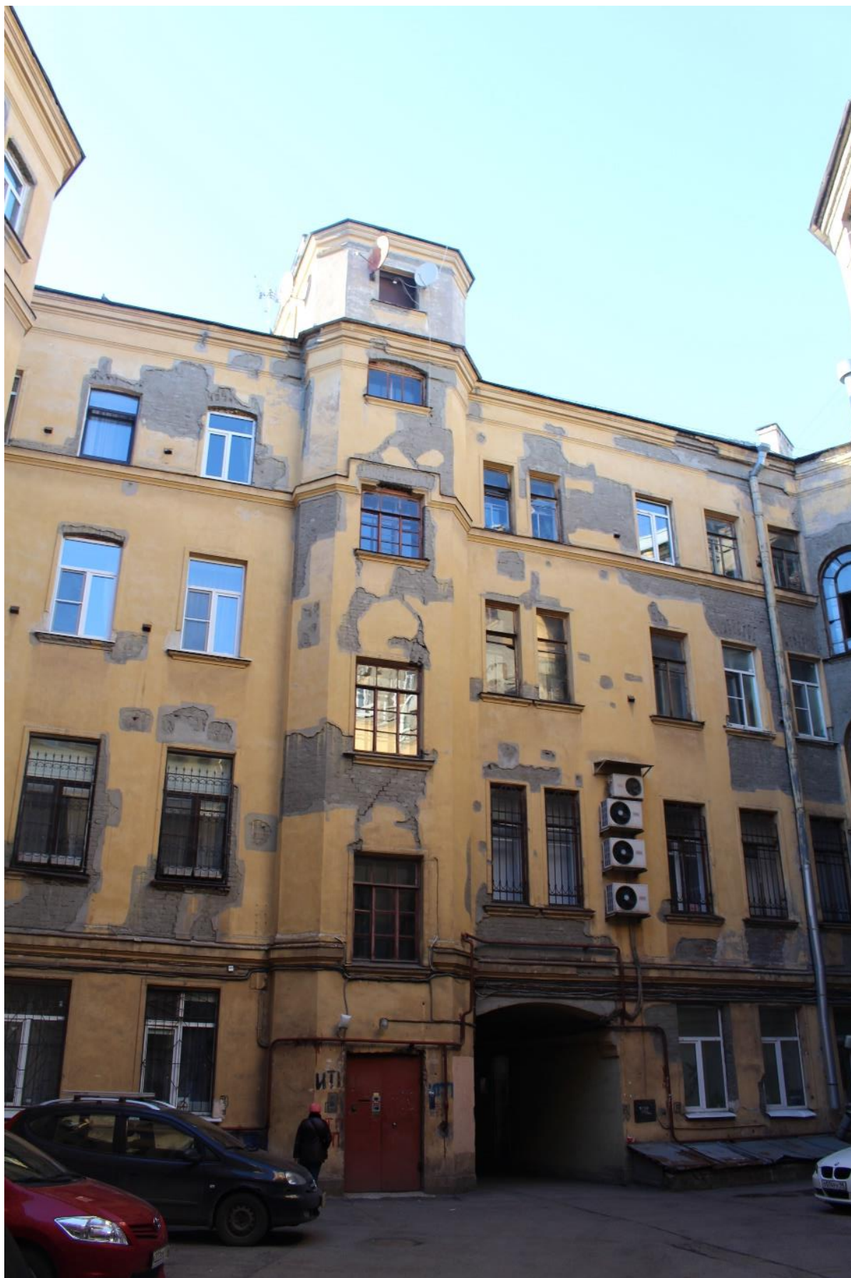
Фото 42. Вид на дворовый (юго-восточный) фасад северо-западного лицевого корпуса выявленного объекта культурного наследия «Дом Э.Г. Шведерского».
