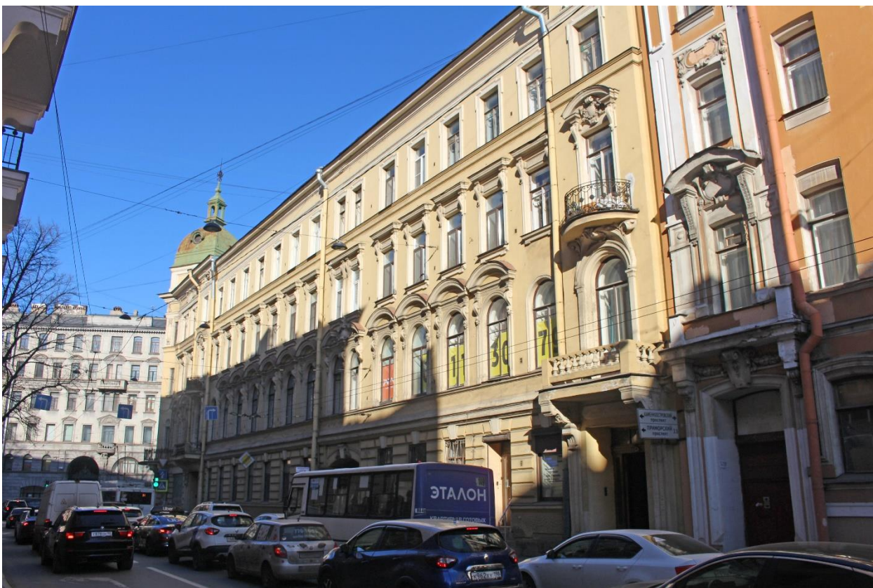
Фото 36. Вид на лицевой фасад северо-западного лицевого корпуса выявленного объекта культурного наследия «Дом Э.Г. Шведерского».
