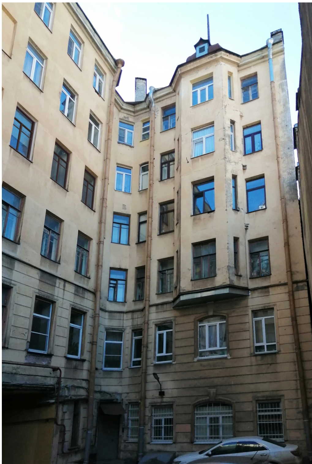
10. “Дом Герварт” Набережная реки Фонтанки, д 103, лит. А. 3-й двор. Юго-западный дворовый фасад. Фото: 24.05.2022.
