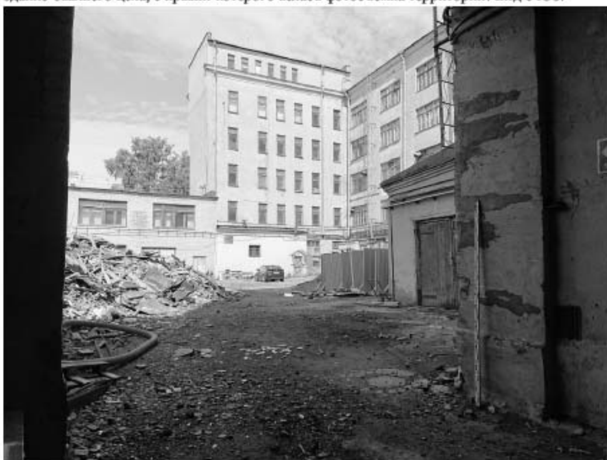
Ил. 34. Точка фотофиксации 7. Северная часть участка обследования из проездной арки здания бывшего цеха. Вид с ЮВ.
