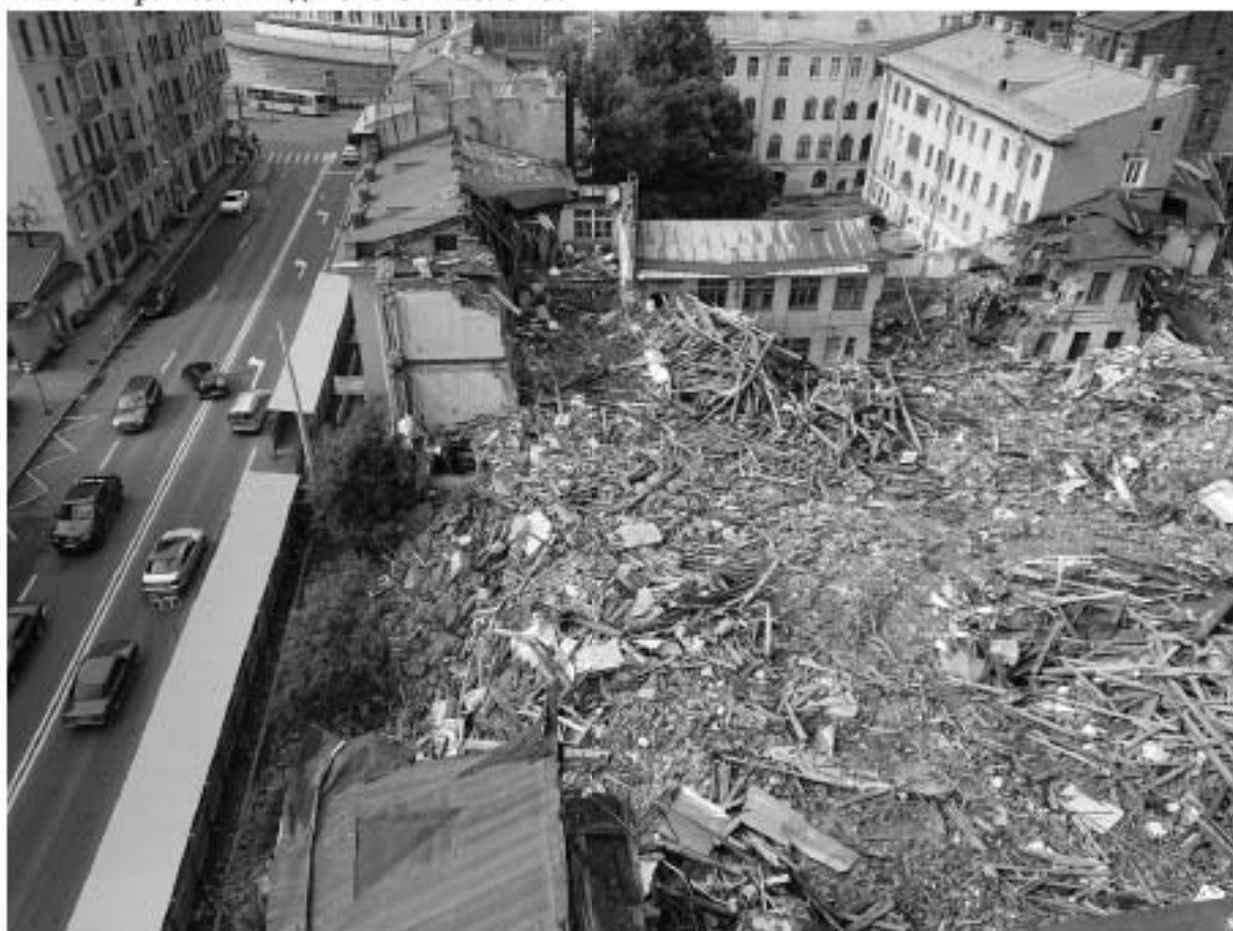
Ил. 28. Точка фотофиксации 2. Общий вид восточной части участка обследования с СВ (с крыши здания бывшего цеха).
