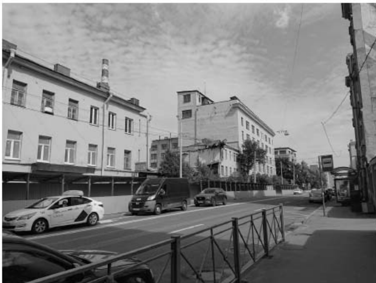
Ил. 27. Точка фотофиксации 1. Общий вид красной линии участка обследования от угла Малого пр. П.С. и Ждановской наб. с Ю.
