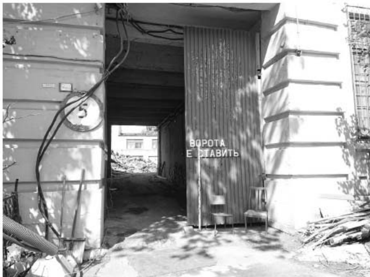
Ил. 35. Точка фотофиксации 8. Проездная арка здания бывшего цеха. Вид с ЮВ.
