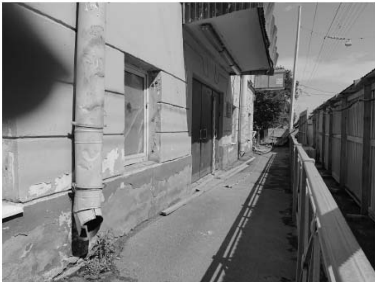
Ил. 39. Точка фотофиксации 11. Красная линия застройки участка обследования и тротуар Малого пр. П.С. Здание административного корпуса (место закладки шурфа 2). Вид с ЮЮЗ.
