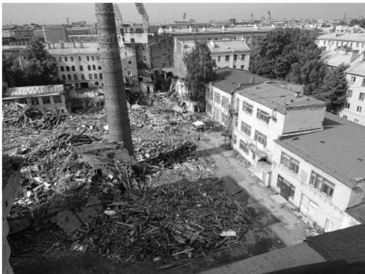
Ил. 31. Точка фотофиксации 4. Общий вид западной части участка обследования с СЗ (с крыши здания бывшего цеха).
