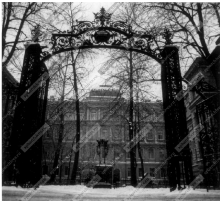
19. Вид центрального фасада дома №27-29 на Моховой улице, построенного по проекту архитектора Л.Н. Бенуа для страхового общества "Россия". ЦГАКФФД СПб. Фотодокумент Бр 41149
