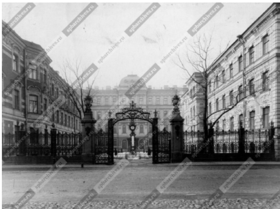
17. Фасад дома №27-29 - жилой дом страхового общества "Россия" (архитектор Л.Н.Бенуа, 1897-1900). ЦГАКФФД СПб. Фотодокумент Ж 6. До 1914г.
