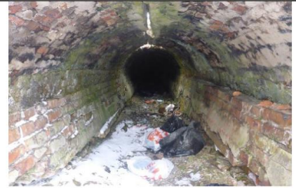
вид кирпичной галереи
