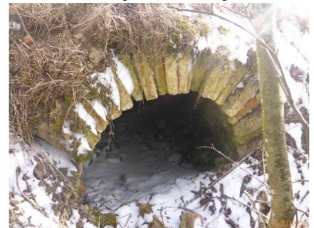
переход кирпичной галереи в канал
