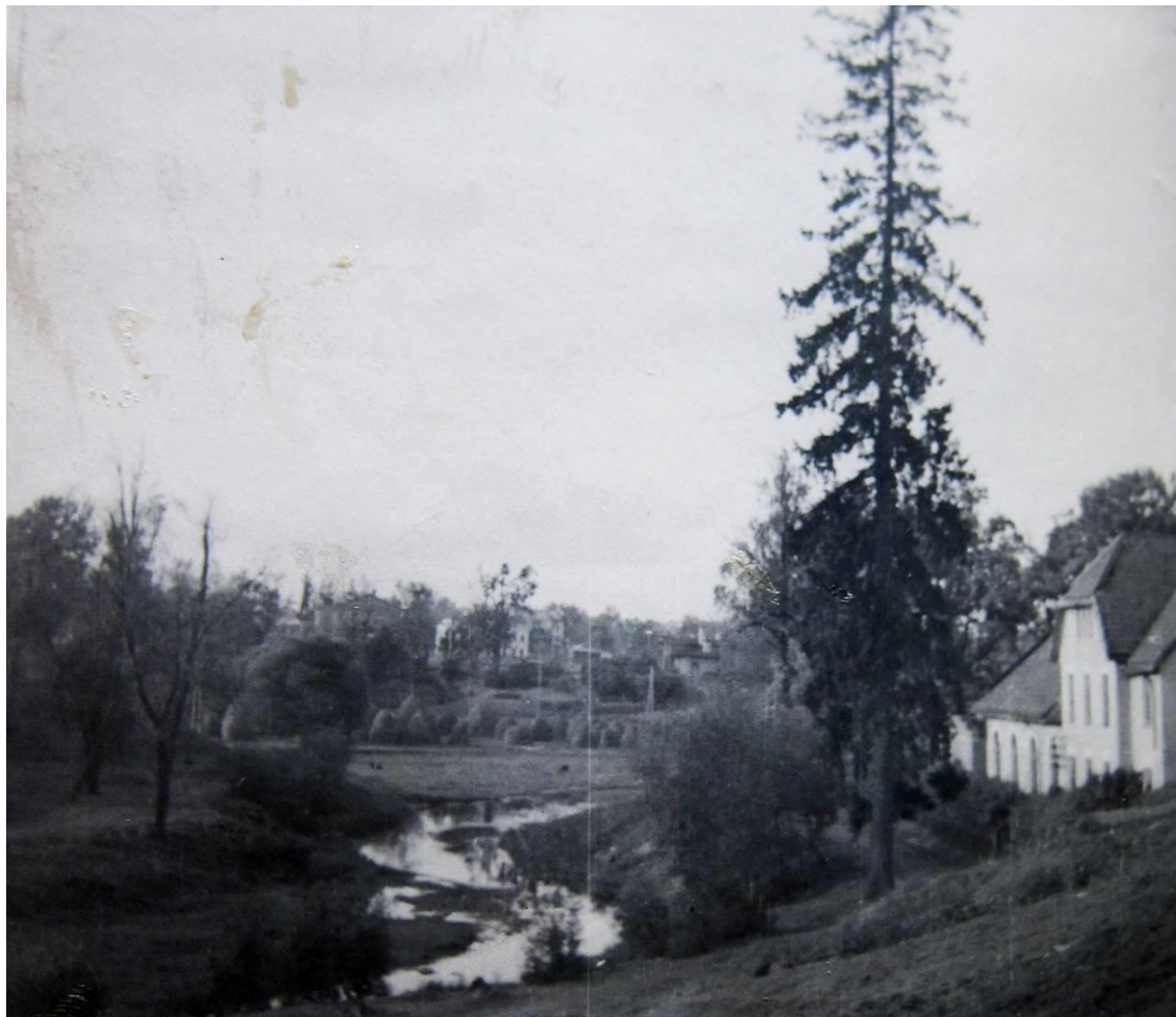
Илл. 87. Здание Электростанции и р. Славянка. Фото 1951 г. – Н.И. Громова «...» Илл. 181.
