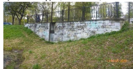
Водосливная плотина на пруду
