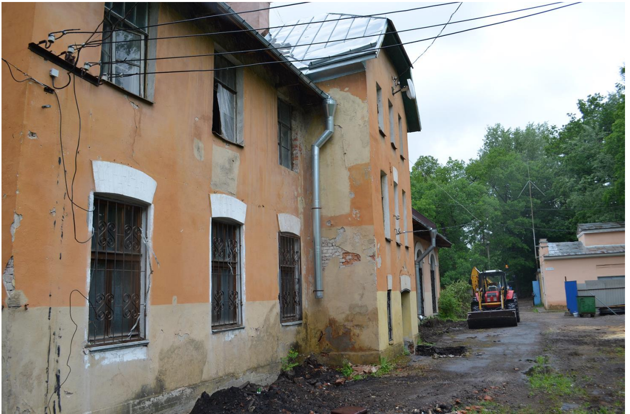
Фото 01. Выявленный ОКН «Павловская электрическая станция (с 2 службами и оградой)» (Санкт-Петербург, г. Павловск, ул. Надгорная, д. 16 лит А, Б; д. 16а лит. А). Главное здание. Общий вид. Съёмка 24.06.2022 г.
