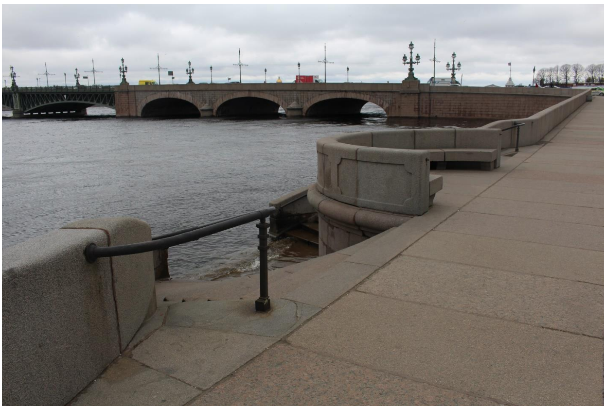
Фото 5. Вид на спуск № 4 с северо-востока.
