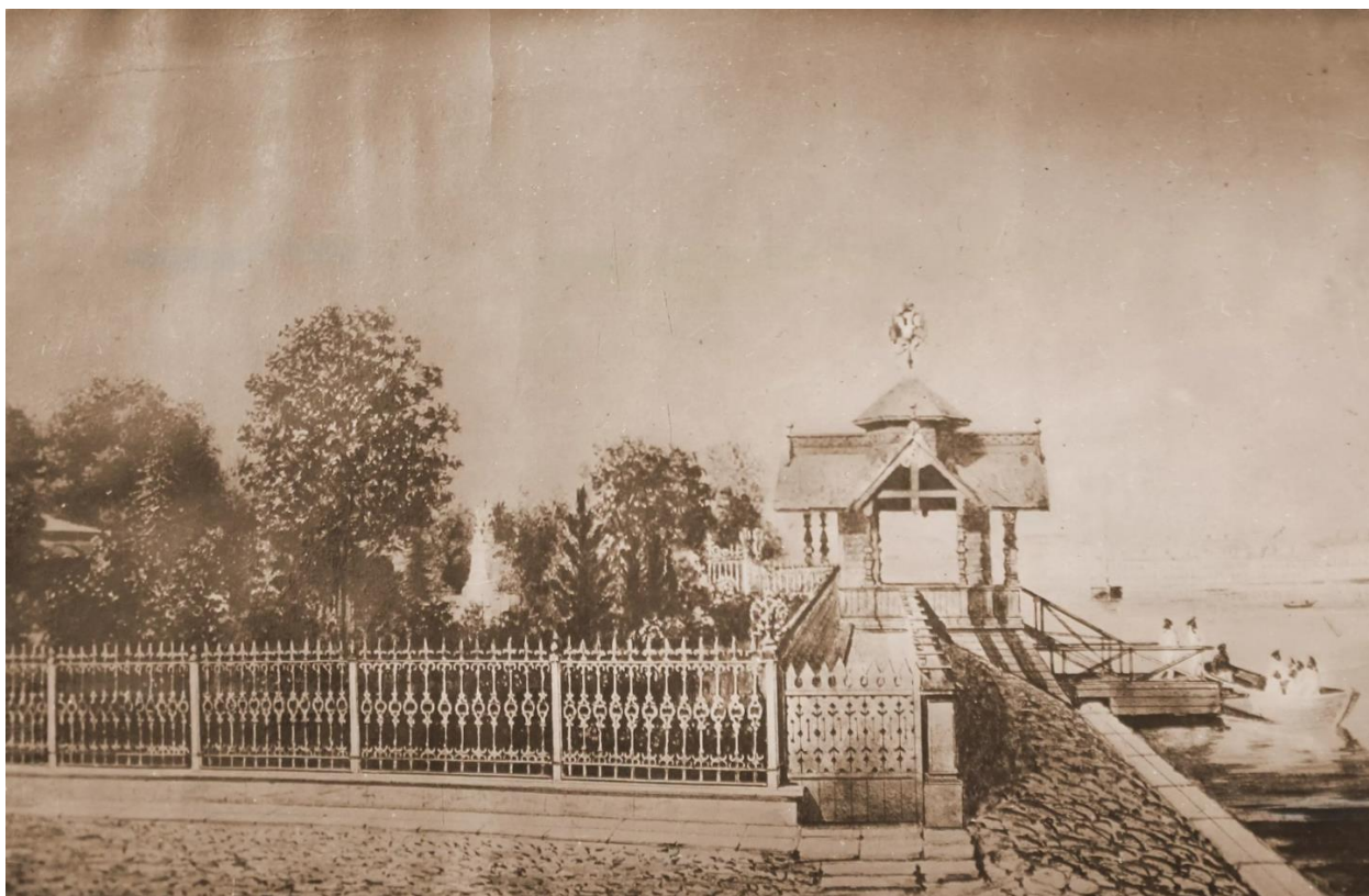
Илл. 10. Вход на территорию дома Петра I со стороны набережной реки Невы. 1875-1899 гг. (источник: https://pastvu.com/p/391870 ).
