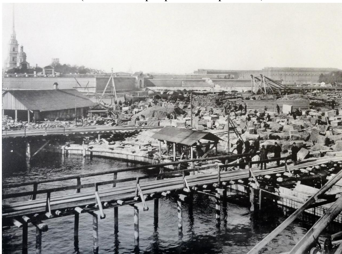
Илл. 13. Строительство Троицкого моста. 1900 г. (источник: https://pastvu.com/p/756212 ).
