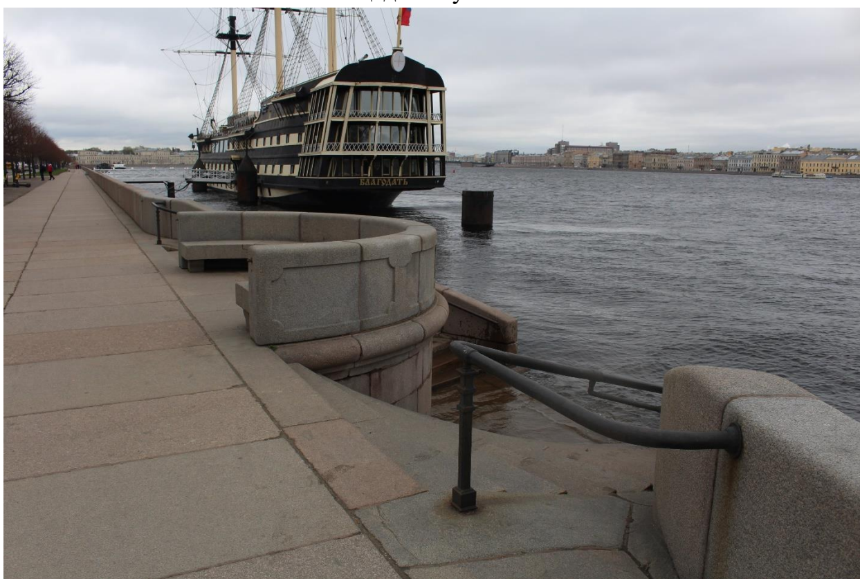
Фото 10. Вид на спуск № 4 с северо-запада.
