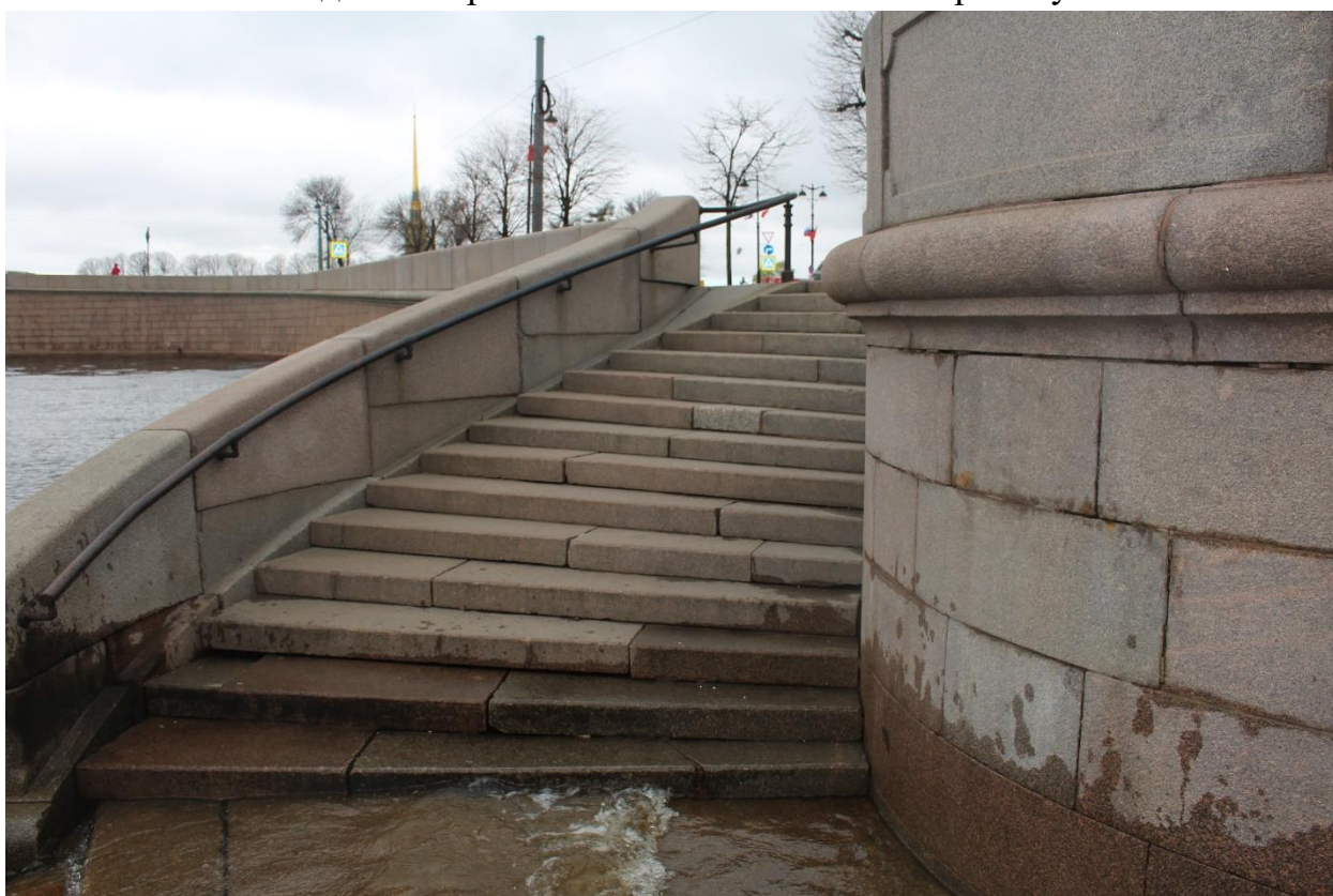
Фото 8. Вид на юго-западный лестничный марш спуска № 4.
