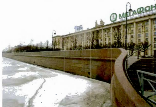
5. Вид стенки набережной
