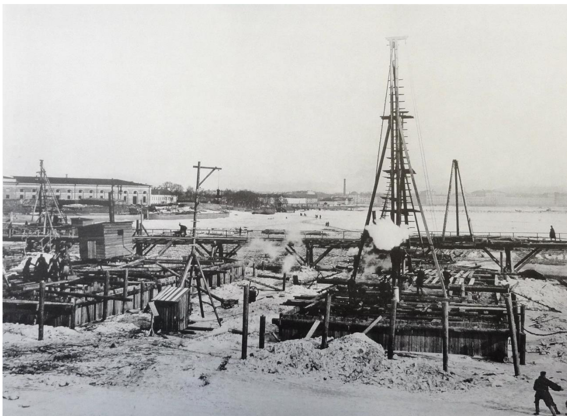
Илл. 14. Строительство Троицкого моста. 1901 г. (источник: https://pastvu.com/p/756202 ).
