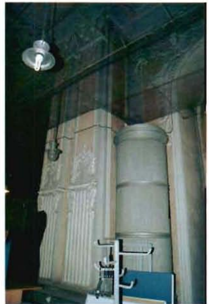
21. (Фрагмент интерьера северного корпуса)
