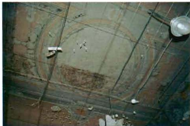
22. (Фрагмент интерьера северного корпуса)
