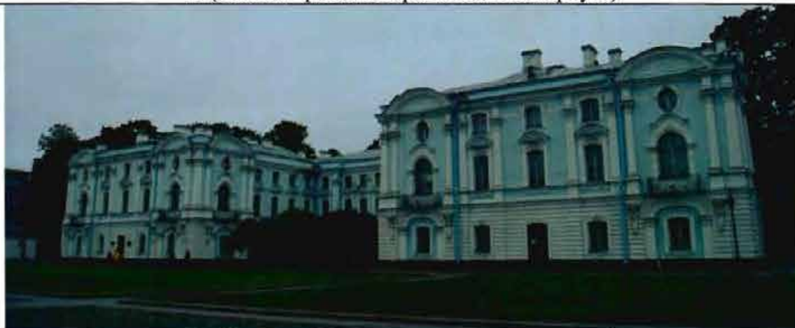
2. (Северный фасад юго-западного корпуса)
