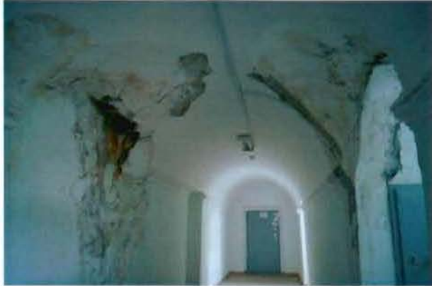
17. (Фрагмент интерьера северного корпуса)
