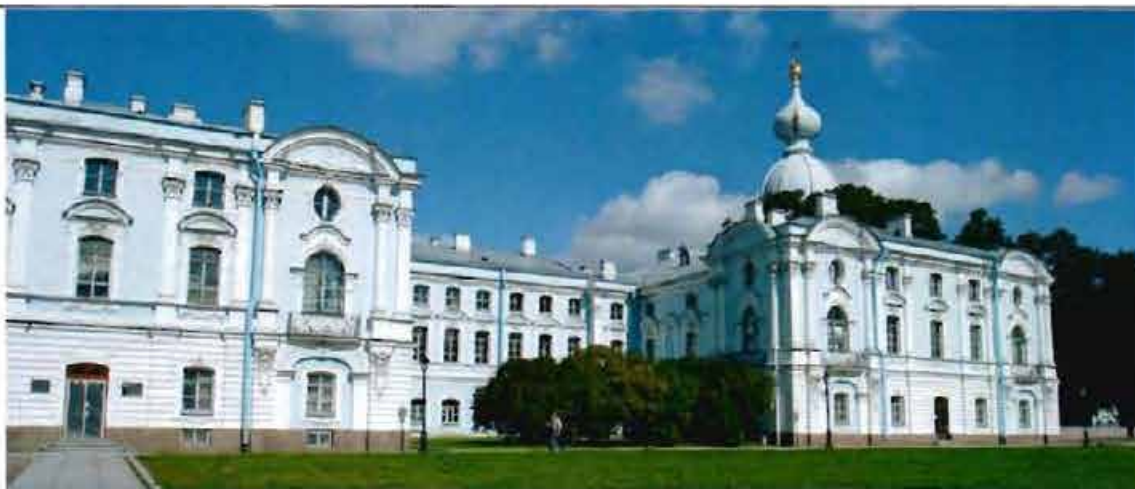
1. (Южный фасад северо-западного корпуса)
