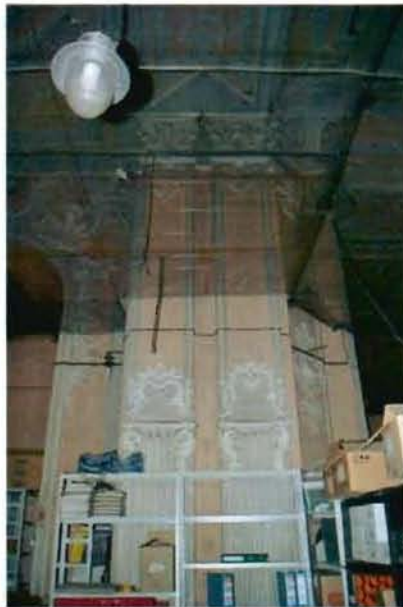
20. (Фрагмент интерьера северного корпуса)
