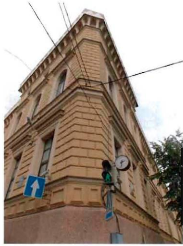
2. Фрагмент лицевого фасада.
