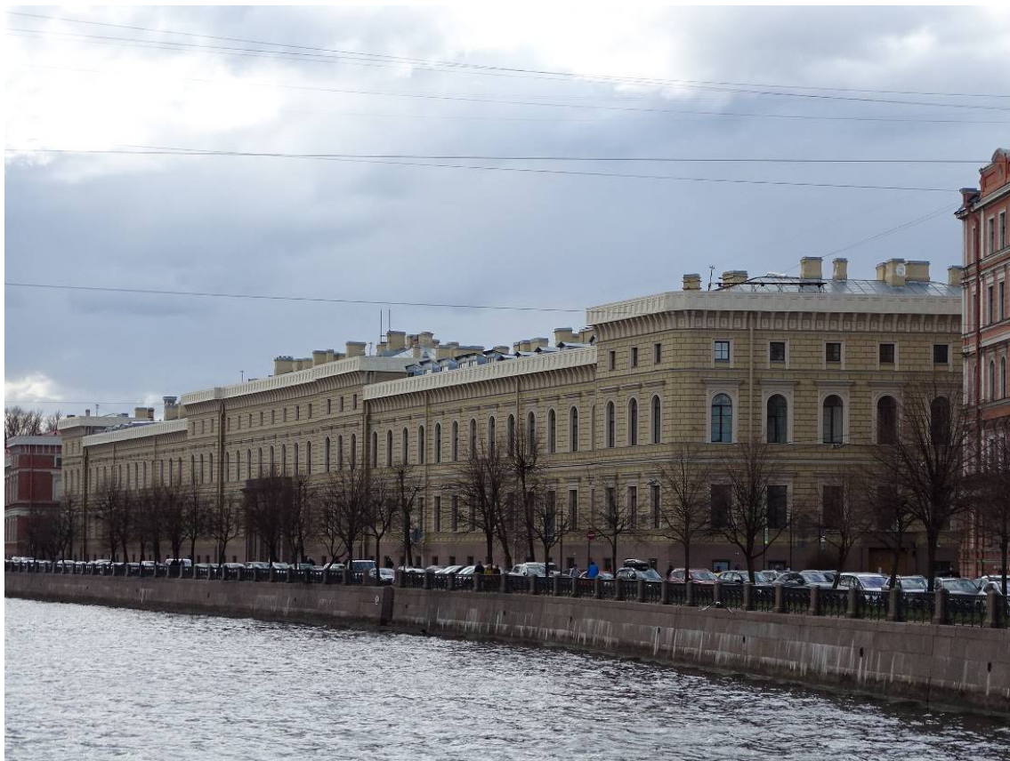
Фото 1. Объект культурного наследия федерального значения «Корпус офицерский» входящий в состав объекта культурного наследия «Казармы лейб-гвардии Конного полка» Южный и восточный фасады. Общий вид. Съемка 25.03.2022 г. Трушковский В.Э.
