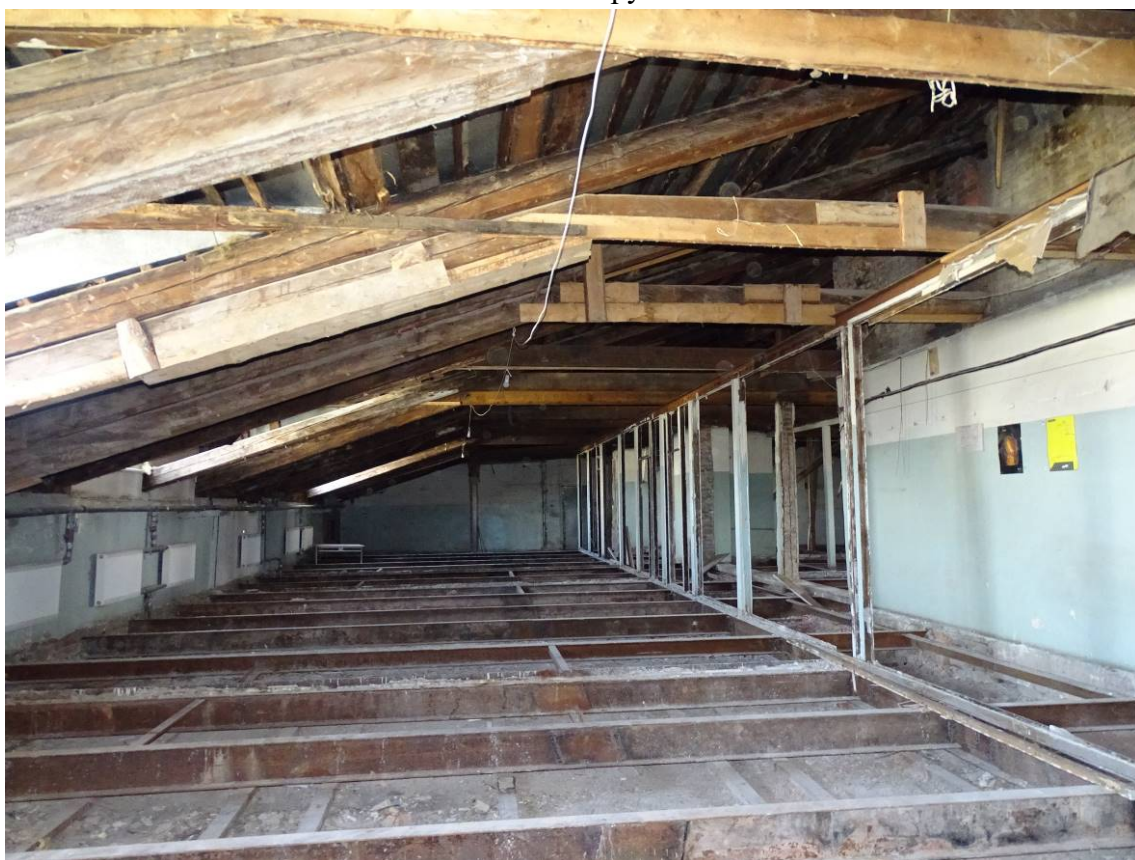
Фото 2. Помещение 4-й этаж (мансарда) 9/54,1; 10/40,6; 11/16,1; 12/7,0; 26/11,7; 27/6,2; 28/5,9; 29/48,2; 30/20,7; 31/53,0; 32/10,57; 33/16,29; 34/52,7; 35/72,4; 36/5,2. Съемка 25.03.2022 г. Трушковский В.Э.
