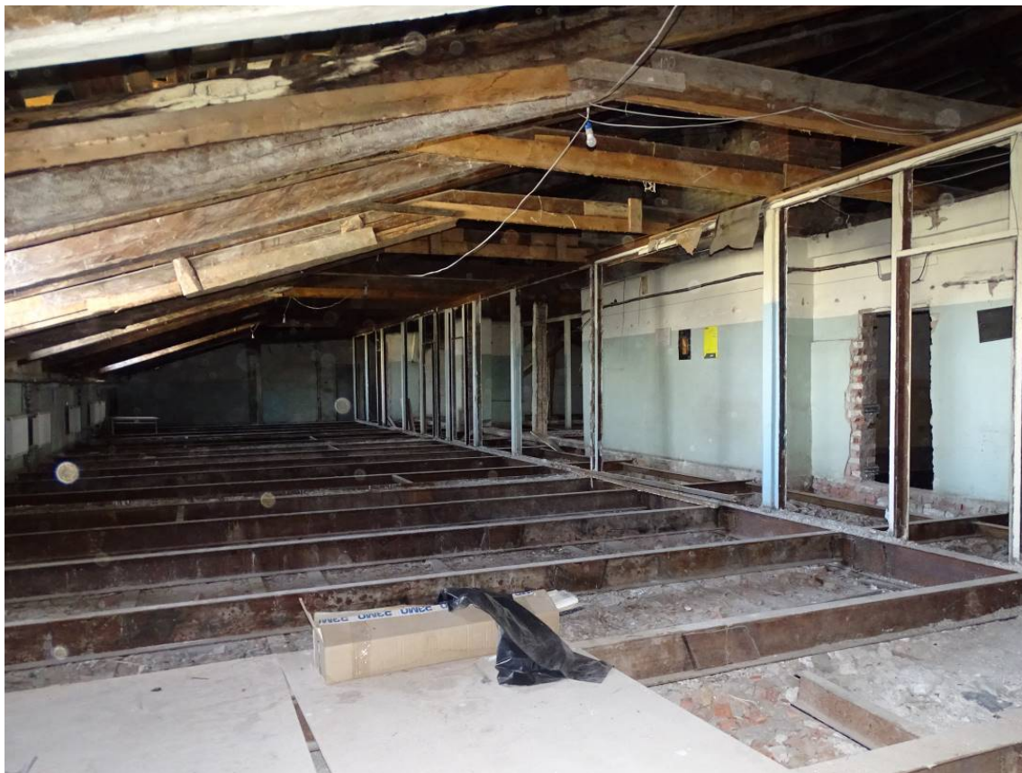
Фото 1. Помещение 118-Н 4-й этаж (мансарда) 9/54,1; 10/40,6; 11/16,1; 12/7,0; 26/11,7; 27/6,2; 28/5,9; 29/48,2; 30/20,7; 31/53,0; 32/10,57; 33/16,29; 34/52,7; 35/72,4; 36/5,2. Съемка 25.03.2022 г. Трушковский В.Э.
