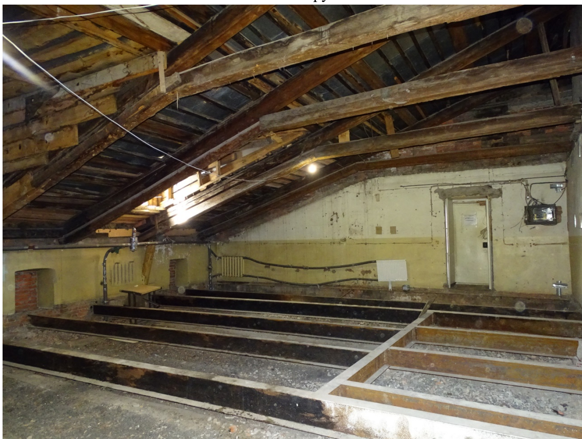
Фото 4. Помещение 4-й этаж (мансарда) 5/24,0; 6/16,2; 7/26,4; 8/9,8. Съемка 25.03.2022 г. Трушковский В.Э.
