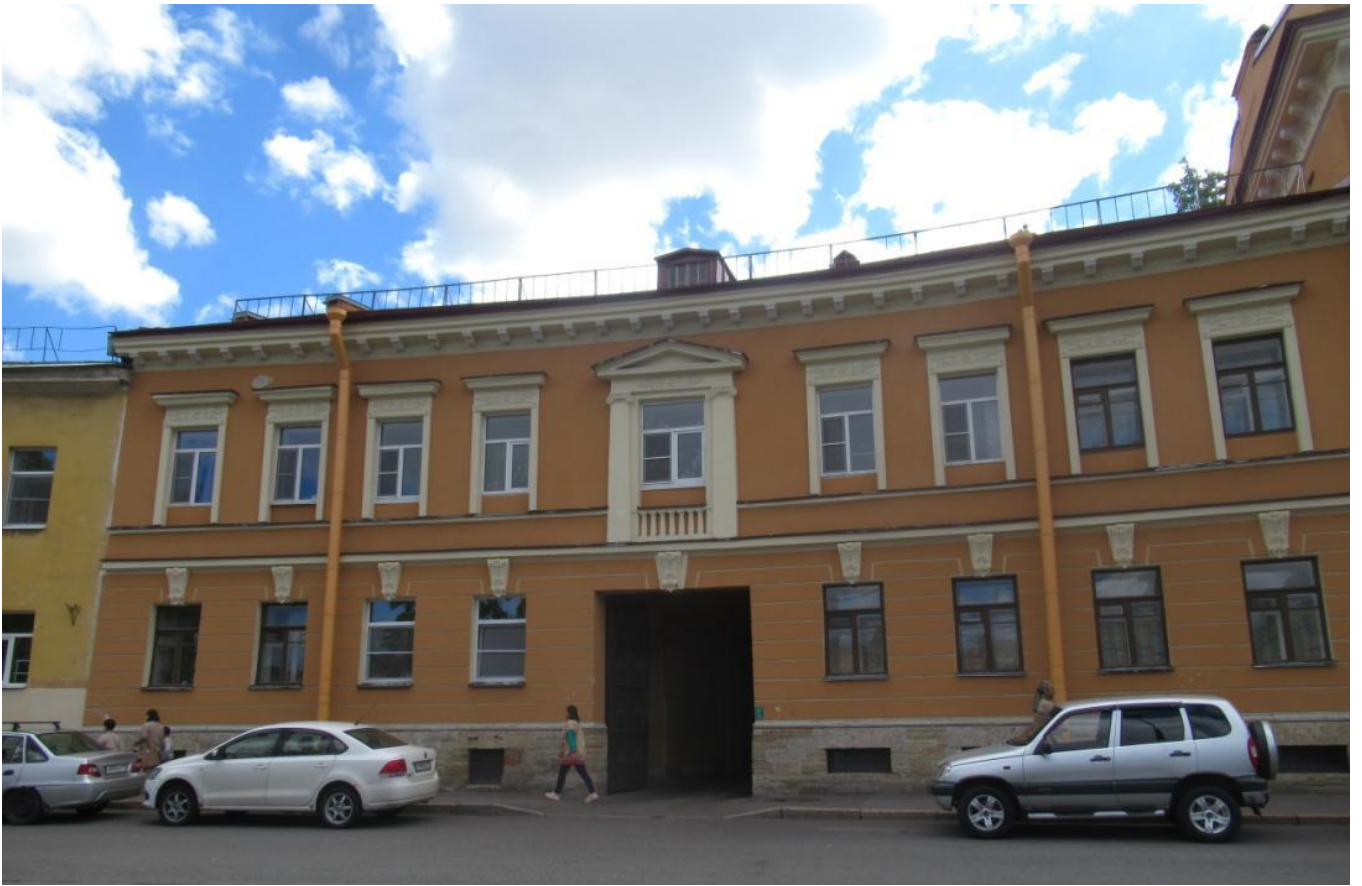
2. Фрагмент лицевого (северного) фасада здания. Вид со стороны набережной реки Фонтанки
