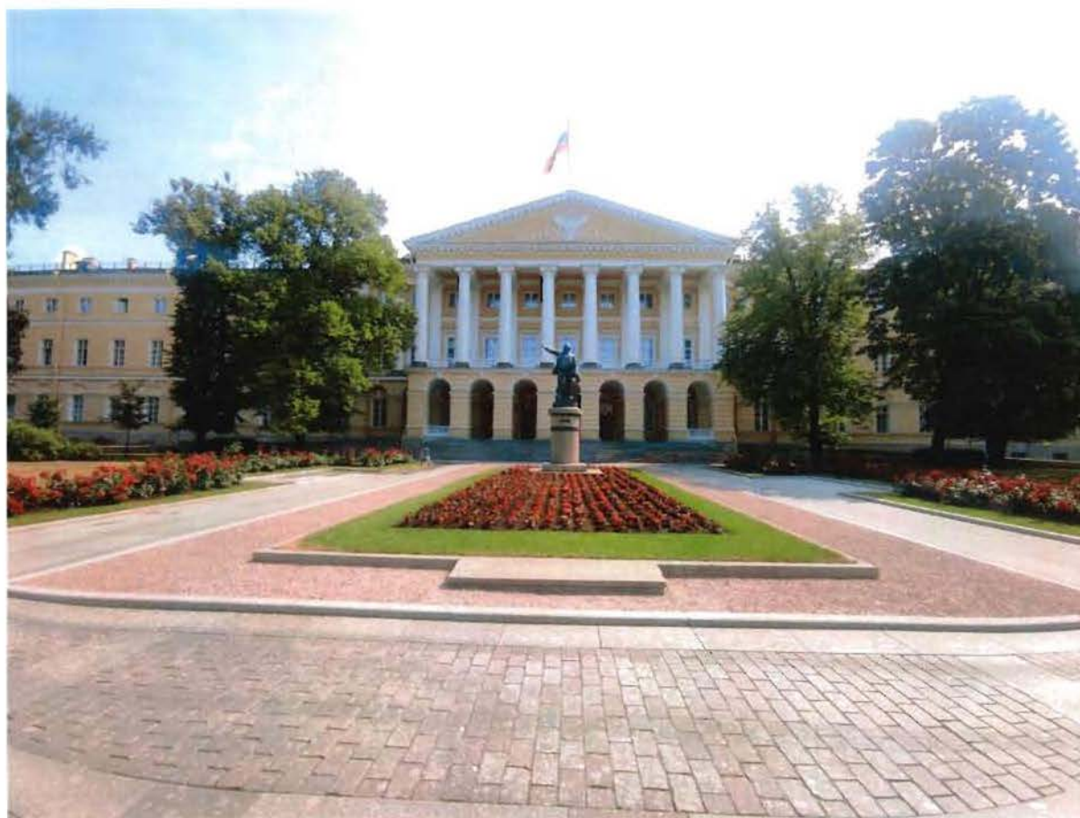
1. Центральная часть объекта культурного наследия. Вид с запада.
