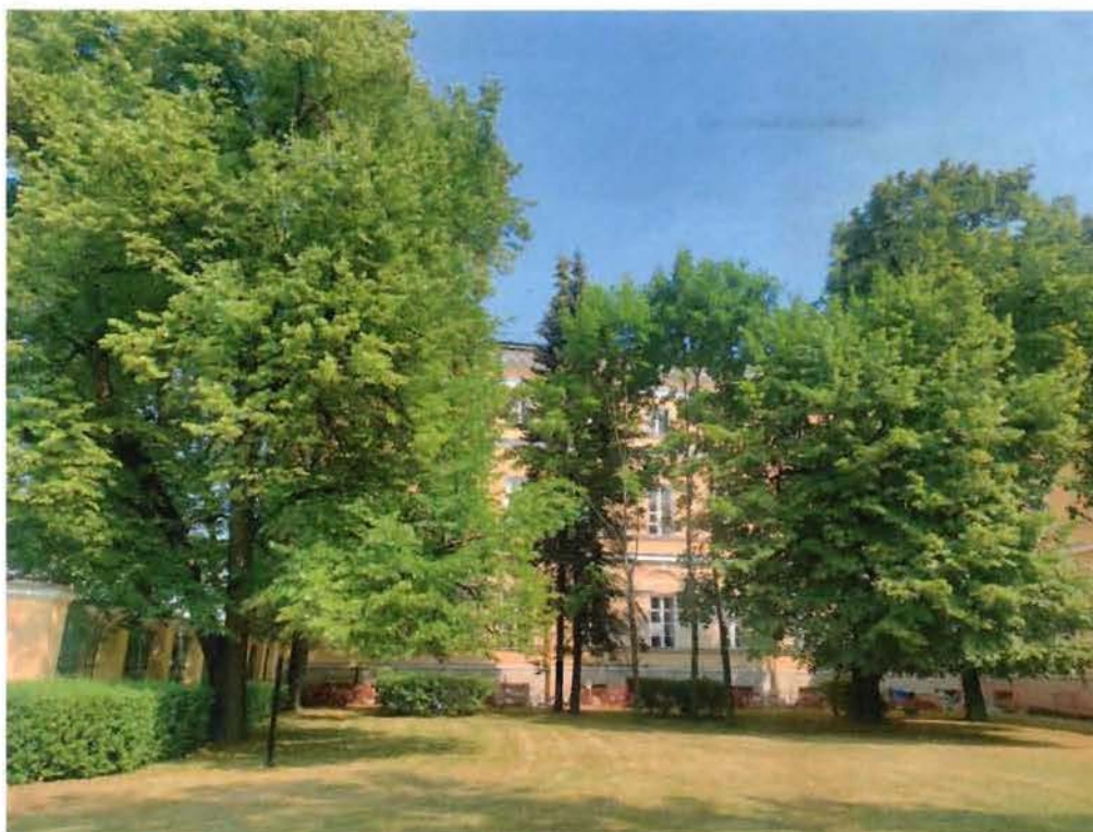
4. Северная часть объекта культурного наследия. Вид с юга.
