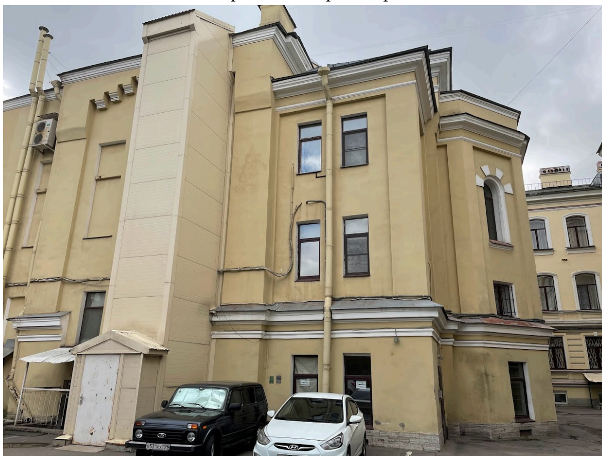
10. Фрагмент дворовых фасадов
