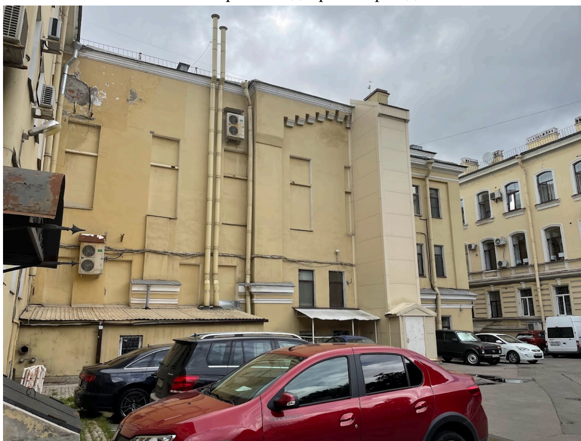
8. Фрагмент дворовых фасадов
