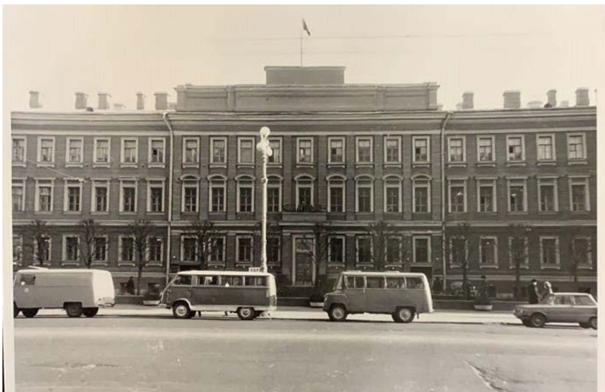
63. Вид лицевого фасада дома № 176 по Невскому проспекту. 1980-е гг. Архив КГИОП
