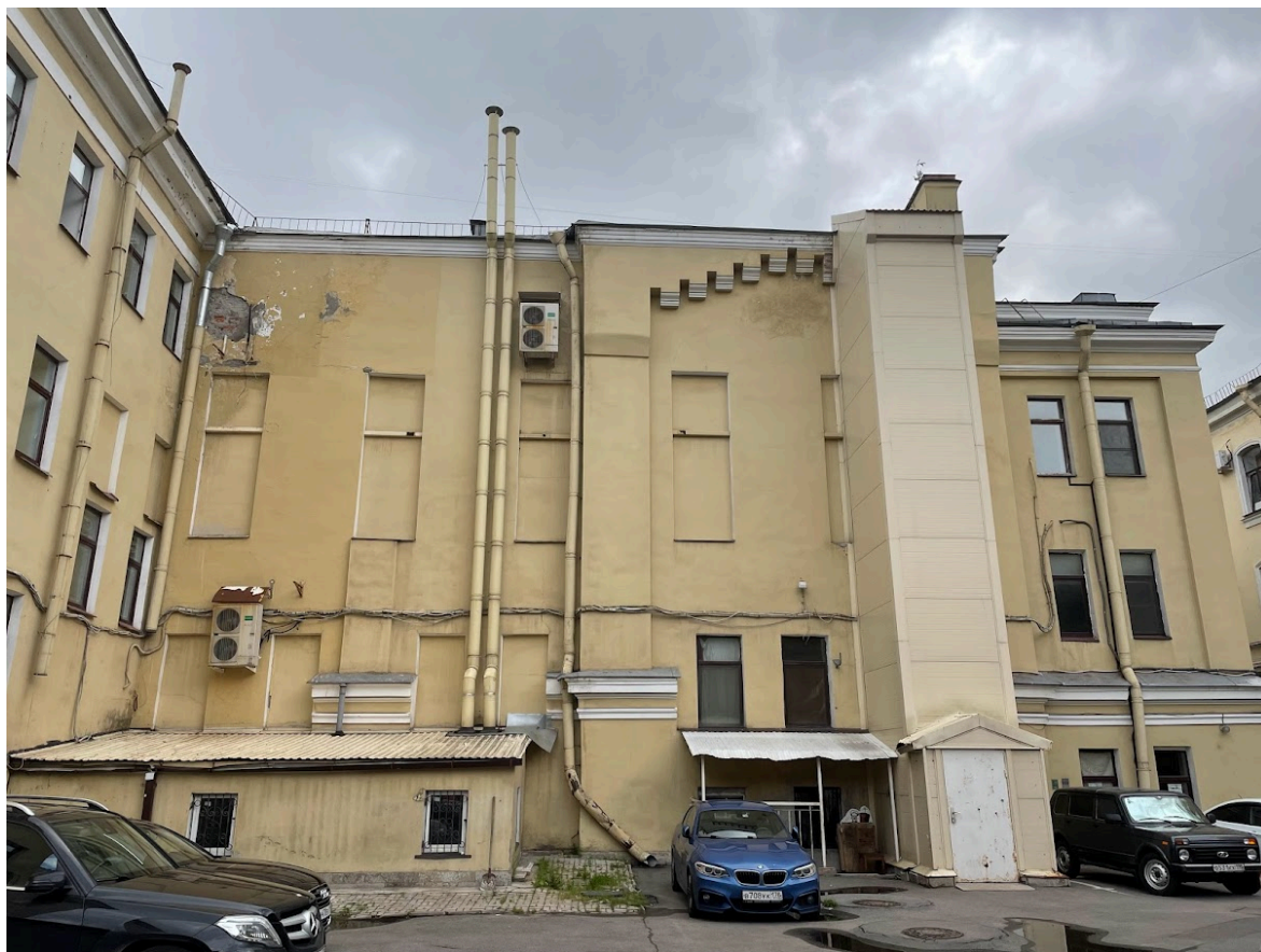
9. Фрагмент дворовых фасадов
