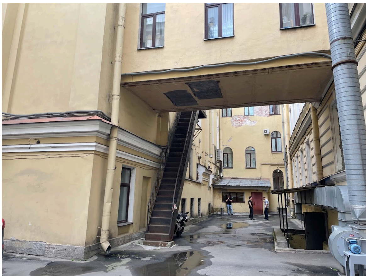
13. Фрагмент дворовых фасадов
