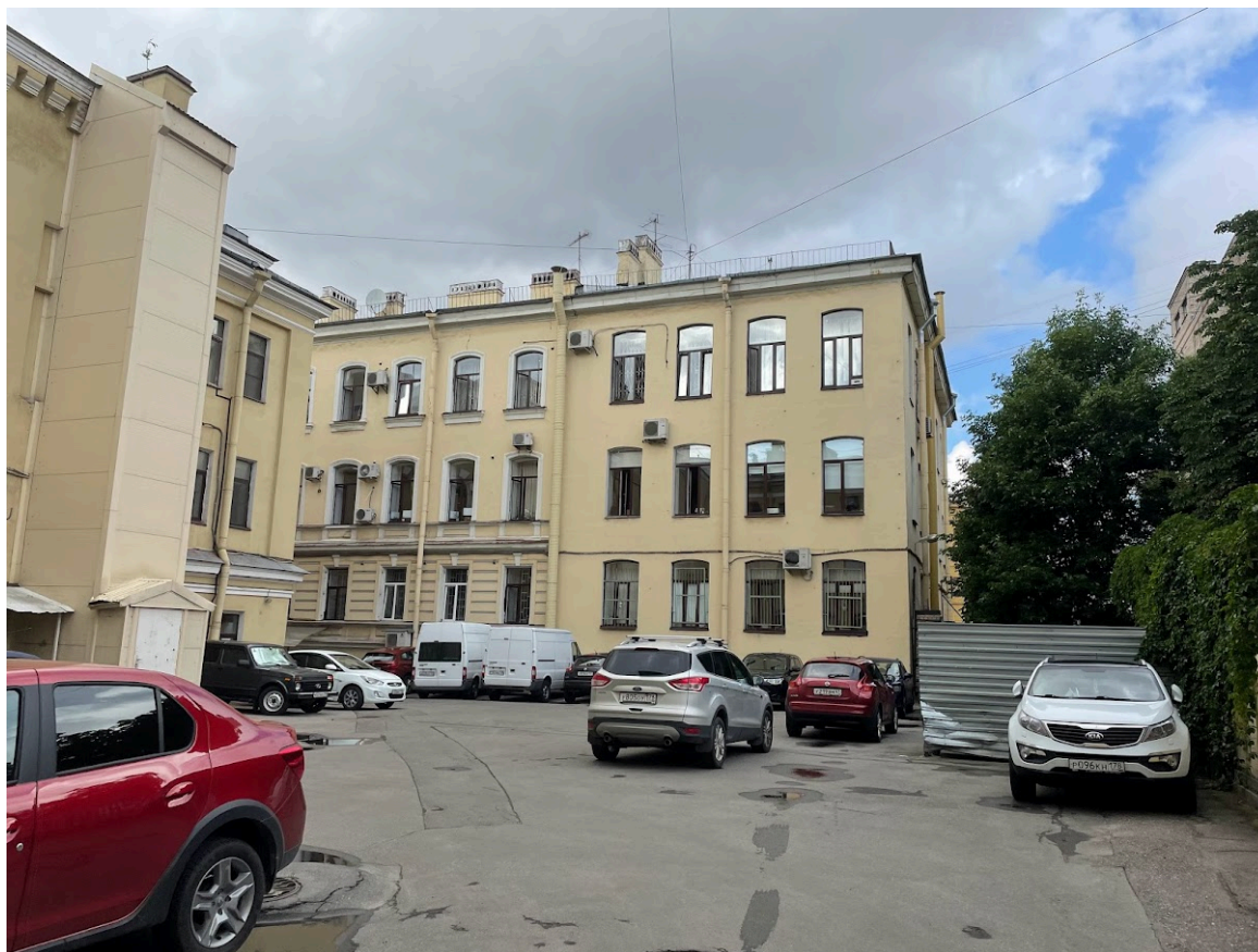
7. Фрагмент дворовых фасадов
