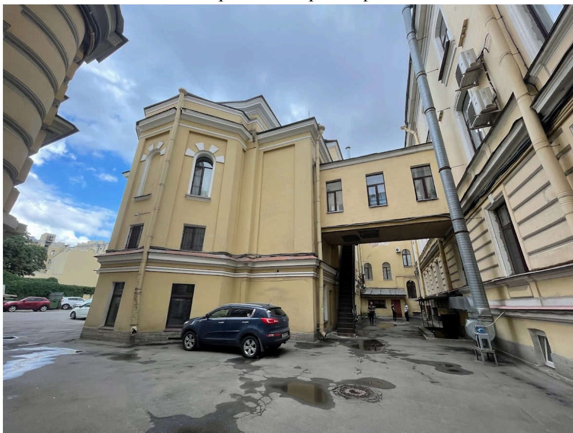
12. Фрагмент дворовых фасадов
