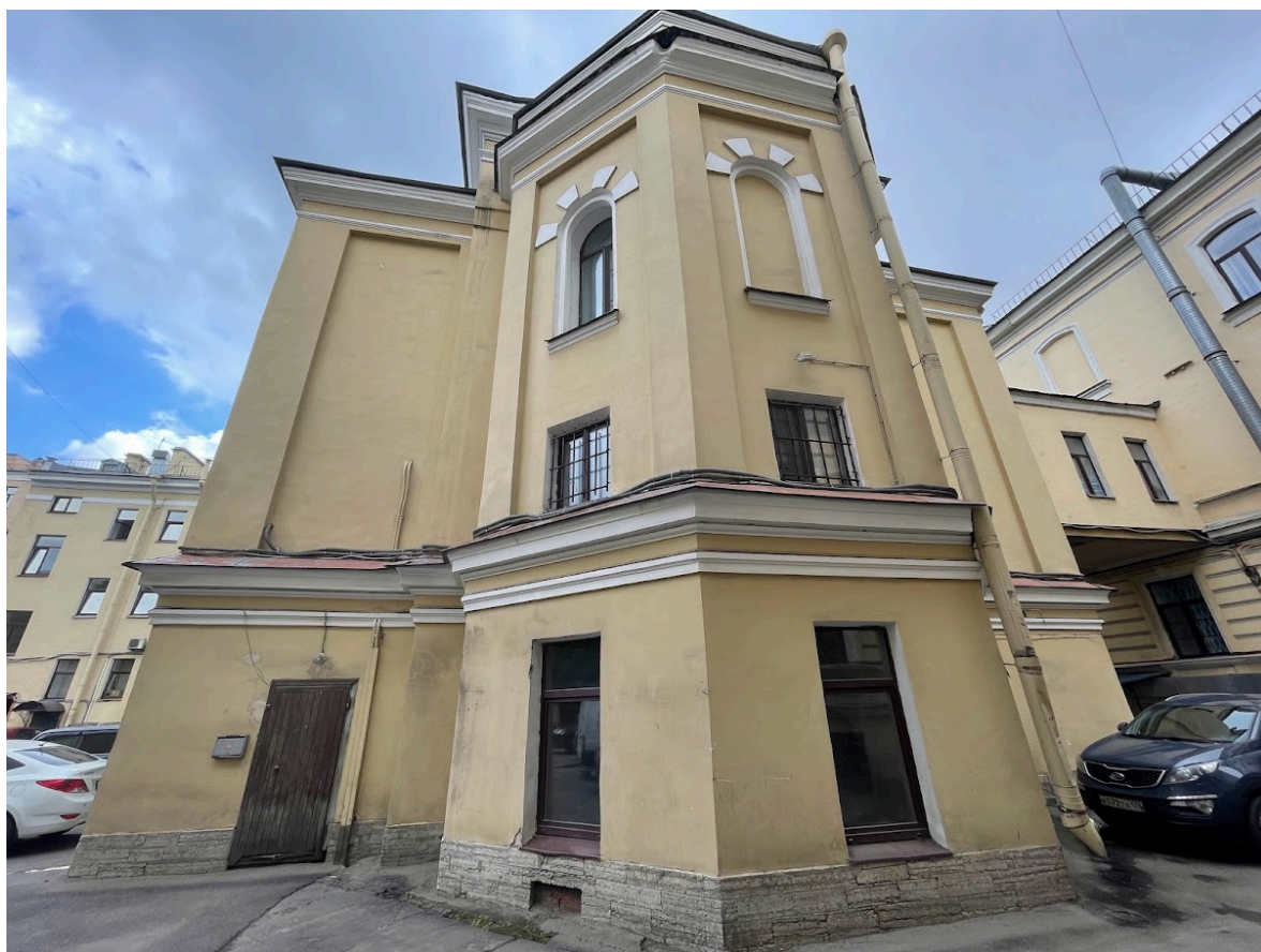
11. Фрагмент дворовых фасадов
