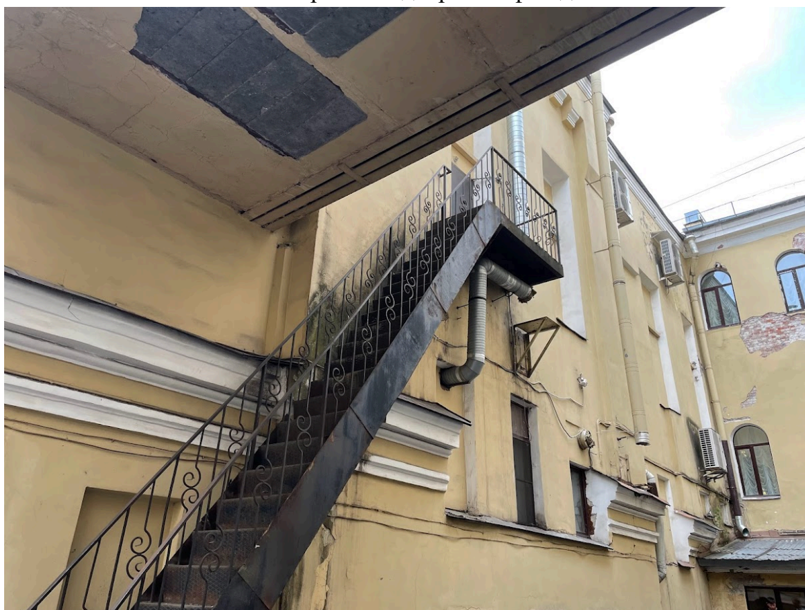
14. Фрагмент дворовых фасадов
