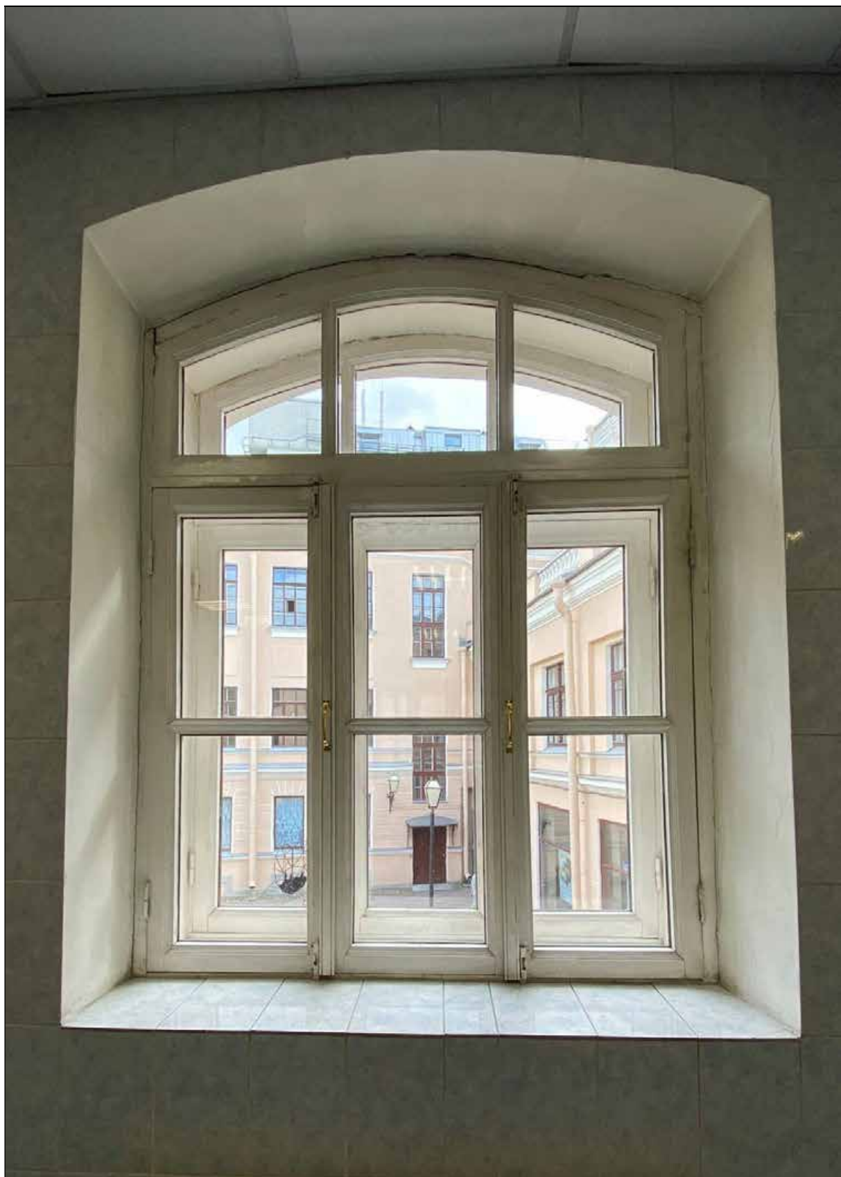
16. Главное здание (концертный зал с учебными флигелями). Помещения 2-го этажа литер А-7 (мужской зрительский санузел). Центральный оконный проем (помещение № 46). 08.07.2022 г.
