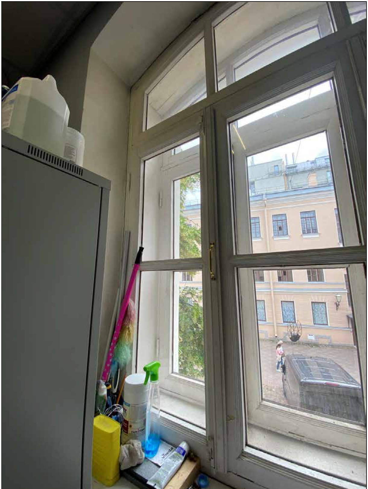
27. Главное здание (концертный зал с учебными флигелями). Помещения 2-го этажа литер А-7 (мужской зрительский санузел). Восточный оконный проем (помещение № 51). Фрагмент. 08.07.2022 г.
