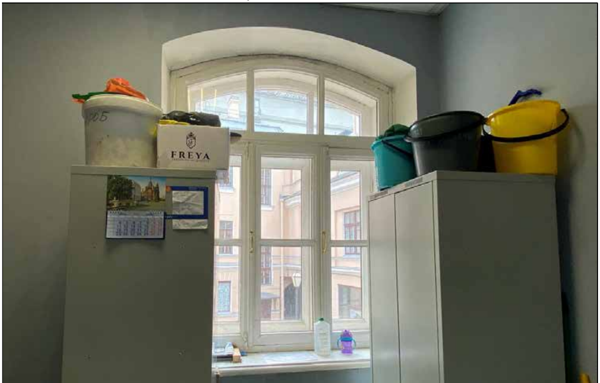
26. Главное здание (концертный зал с учебными флигелями). Помещения 2-го этажа литер А-7 (мужской зрительский санузел). Восточный оконный проем (помещение № 51). 08.07.2022 г.
