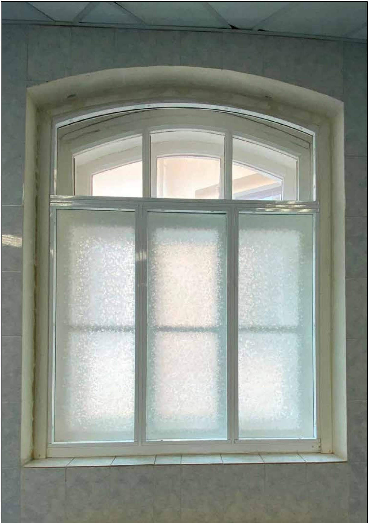
21. Главное здание (концертный зал с учебными флигелями). Помещения 2-го этажа литер А-7 (мужской зрительский санузел). Западный оконный проем (помещение № 46). 08.07.2022 г.
