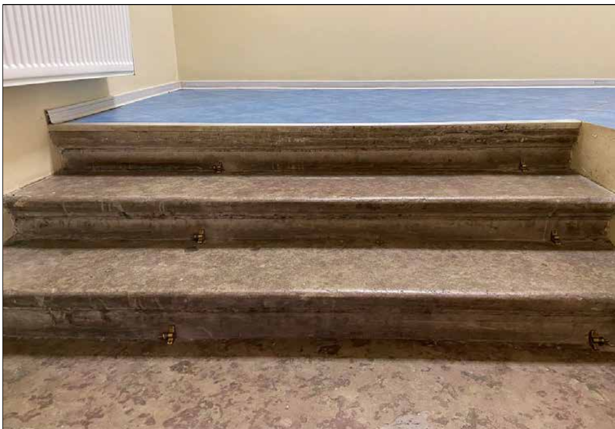
10. Главное здание (концертный зал с учебными флигелями). Одномаршевая лестница, ведущая в помещения 2-го этажа литер А-7 (мужской зрительский санузел). Фрагмент. 08.07.2022 г.
