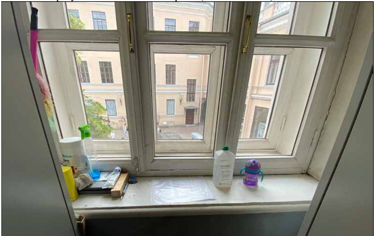
30. Главное здание (концертный зал с учебными флигелями). Помещения 2-го этажа литер А-7 (мужской зрительский санузел). Подоконник восточного оконного проема (помещение № 51). 08.07.2022 г.
