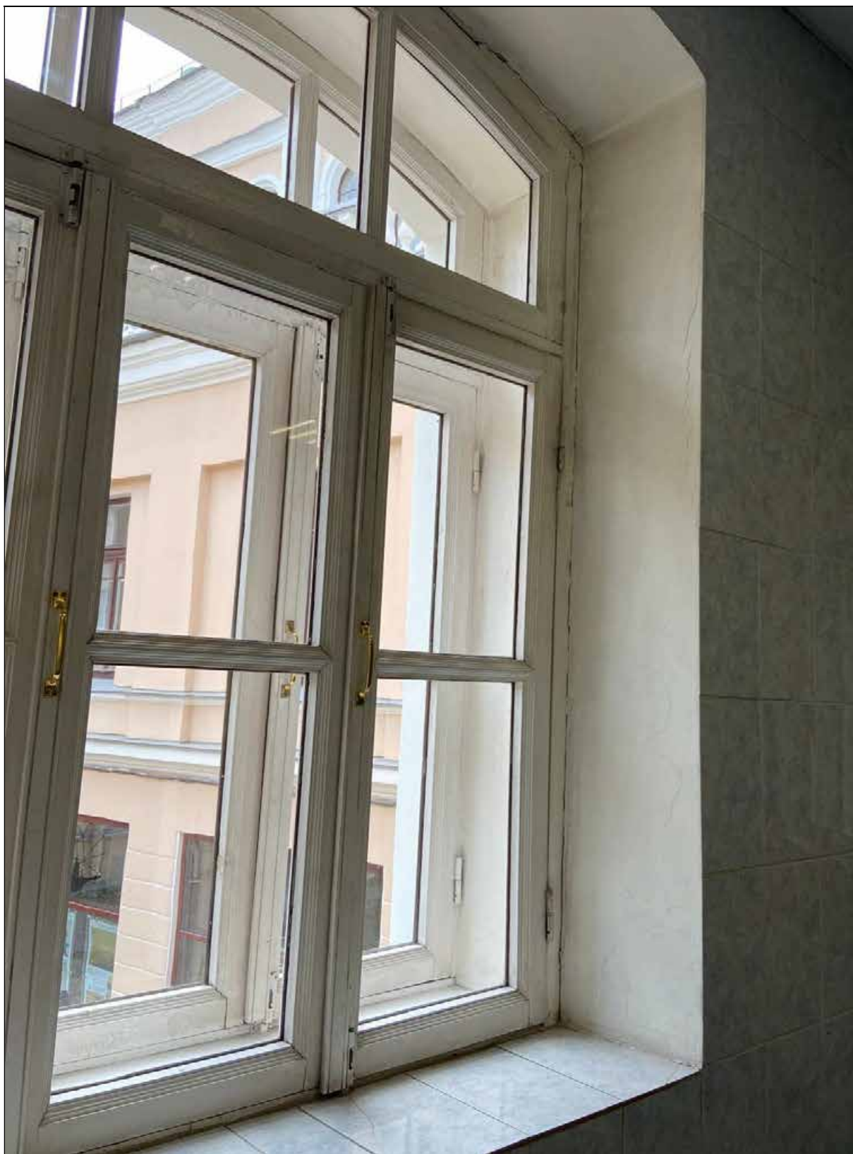
17. Главное здание (концертный зал с учебными флигелями). Помещения 2-го этажа литер А-7 (мужской зрительский санузел). Откос центрального оконного проема (помещение № 46). 08.07.2022 г.
