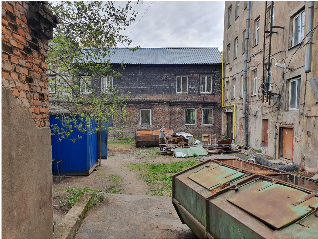
Рис. 16. СПб-2022. Московский район. Булавского ул., д. 6. Общий вид участка обследования. Точка фотофиксации 4. Вид с севера.
