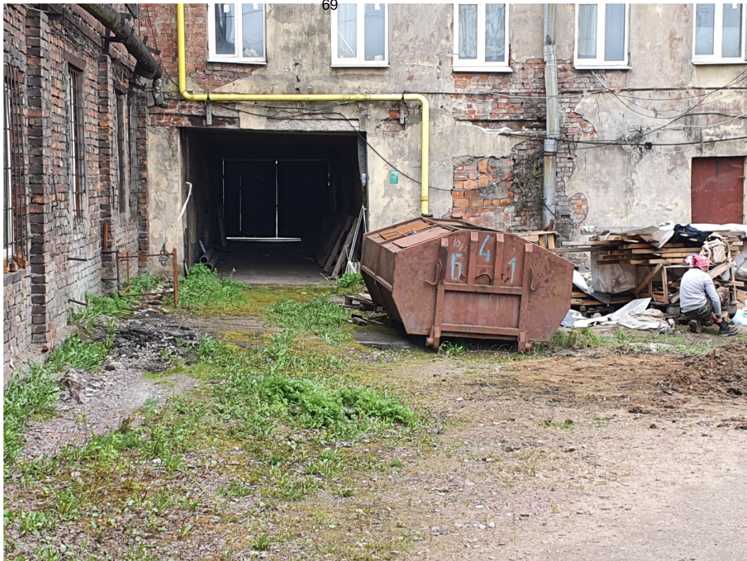
Рис. 12. СПб-2022. Московский район. Булавского ул., д. 6. Общий вид участка обследования. Точка фотофиксации 1. Вид с северо-востока.
