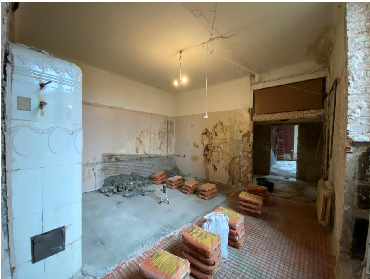
Фото 11. Помещение № 6. Кухня. Вид с северо-востока.
