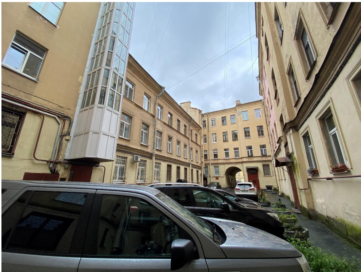
Фото 2. Общий вид дворовых фасадов объекта культурного наследия «Дом О.И. Либих».
