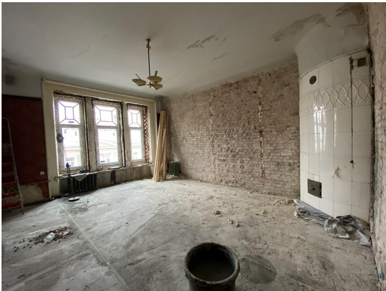
Фото 17. Помещение № 10. Комната. Вид с юго-востока.
