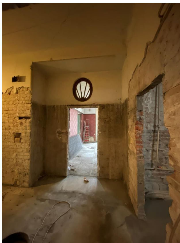
Фото 14. Помещение № 7. Коридор. Вид с запада.
