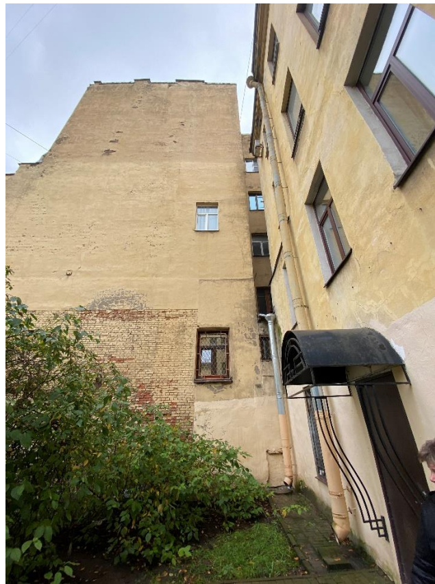
Фото 4. Фрагмент северного дворового фасада.
