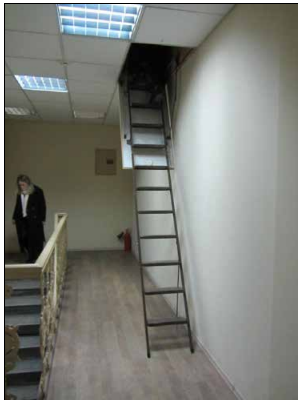
60. Здание «Ресторана», входящего в «Комплекс общественных и жилых зданий Г.А.Александрова (Каменноостровский пр., 10, 12, лит. А)». Подъем на чердак. (Фото 17.12.2021 г.)
