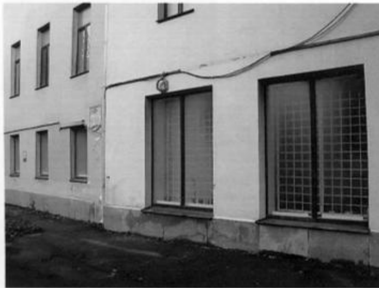
Дворовый фасад. Оконные проемы пом. 13-Н в 1-м этаже. Съемка 11.10.2010г. Е.А.Алехина
