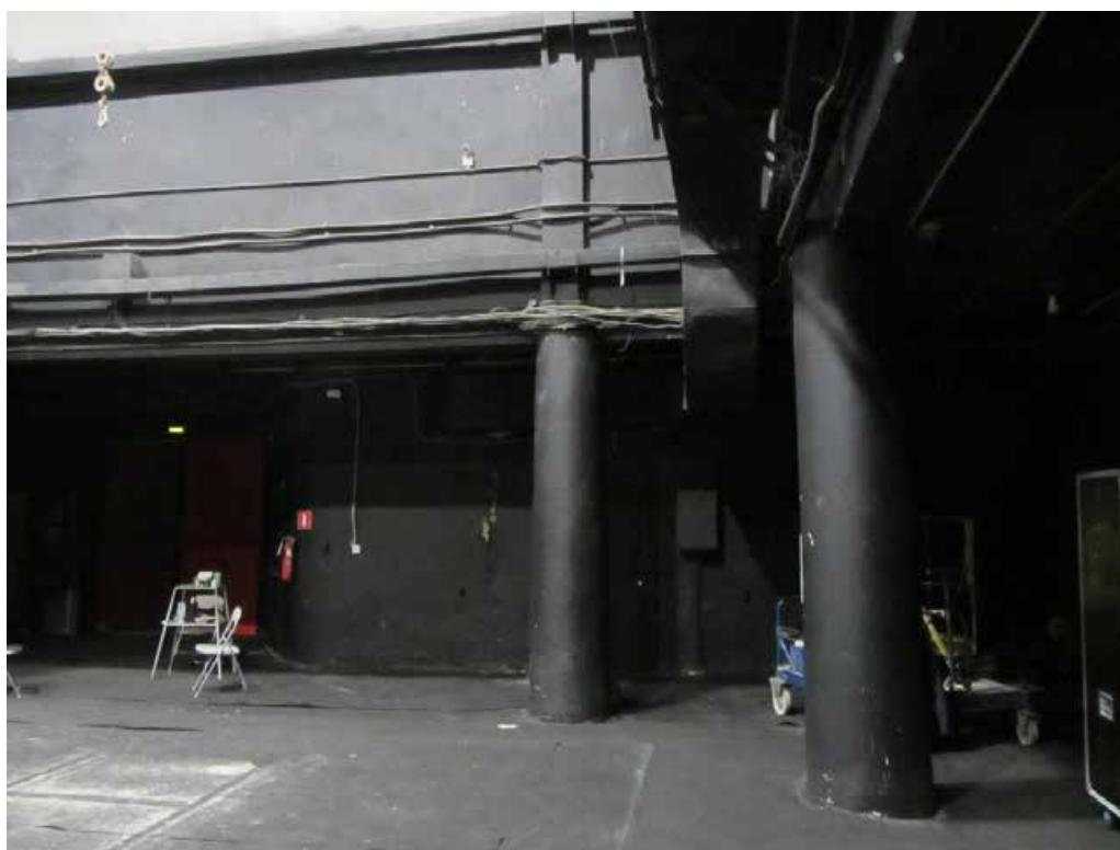
35. Фрагмент интерьера Павильона №1 в здании «Ресторана», входящего в «Комплекс общественных и жилых зданий Г.А.Александрова (Каменноостровский пр., 10, 12, лит.А)». (Фото 17.12.2021 г.)
