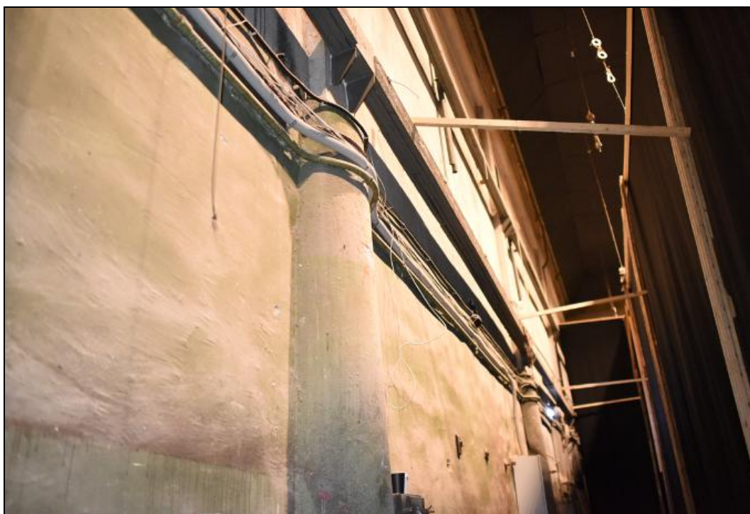
37. Фрагмент интерьера Павильона №1 в здании «Ресторана», входящего в «Комплекс общественных и жилых зданий Г.А.Александрова (Каменноостровский пр., 10, 12, лит.А)» (Фото 17.12.2021 г.)
