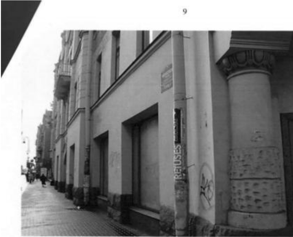
Лицевой фасад по Каменноостровскому пр., оконные проемы пом. 2-Н. Съемка 11.10.2010г. Е.А.Алехина
