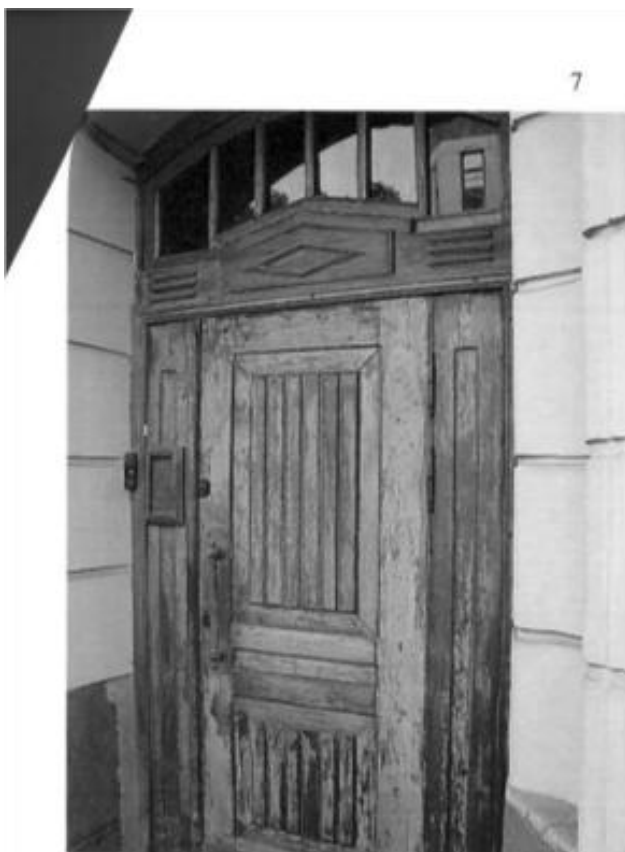
Входной проем помещения 13-Н, дверное заполнение, фрамуга. Съёмка 11.10.2010г. Е.А.Алехина
