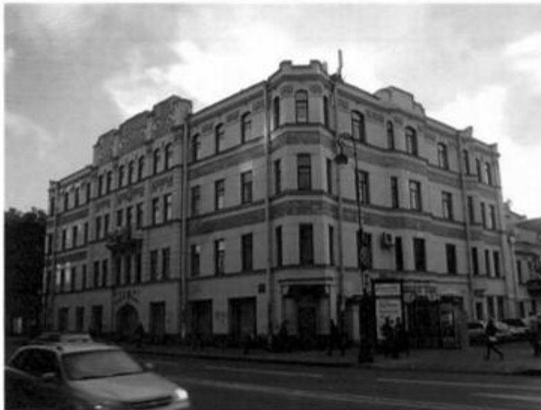
Лицевой фасад, вид на фасад по Каменноостровскому пр. и фасад курдонера (оконные проемы помещений 2-Н и 13-Н в 1-м этаже) Съемка 11.10.2010г. Е.А.Алехина
