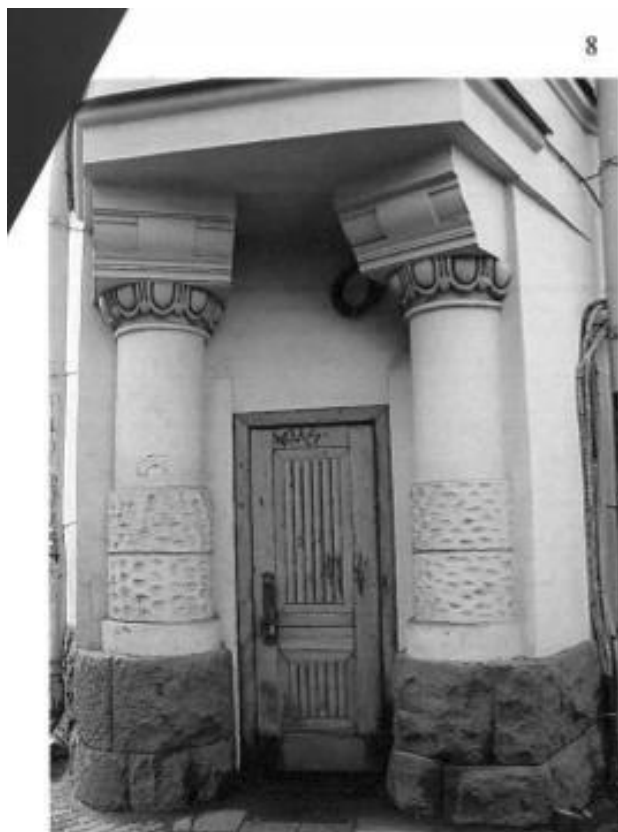
Лицевой фасад. Угловая зона. Входной проем помещений 2-Н. Съемка 11.10.2010г. Е.А.Алехина
