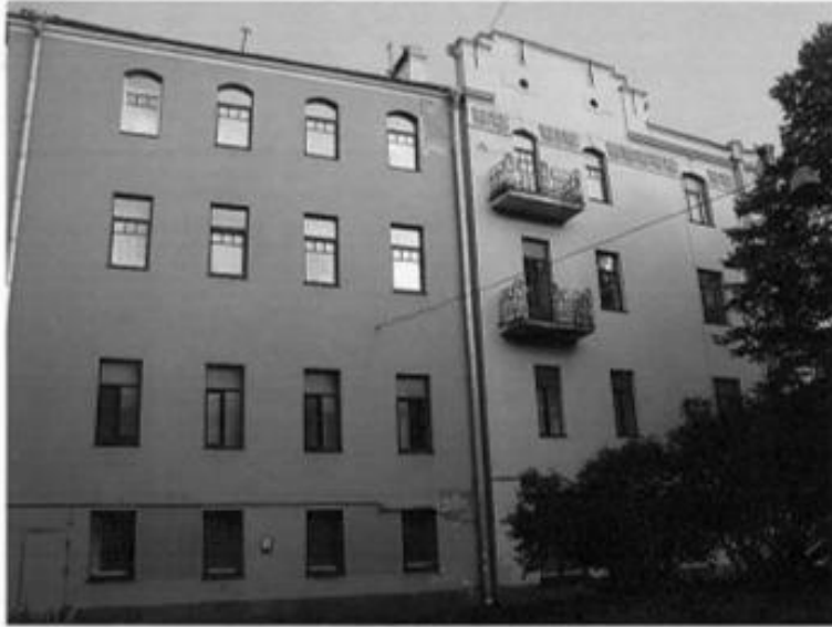
Дворовый фасад. Оконные проемы пом. 13-Н в 1-м этаже. Съемка 11.10.2010г. Е.А.Алехина
