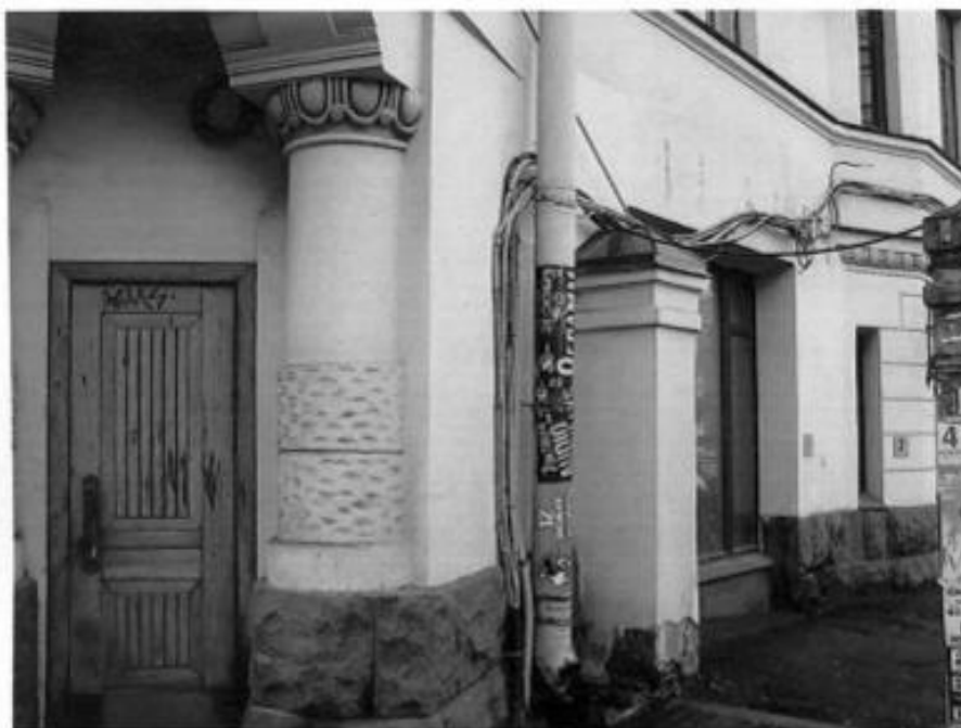
Лицевой фасад. Угловая зона. Входной проем и окна помещений 2-Н, пилон ограды. Съемка 11.10.2010г. Е.А.Алехина
