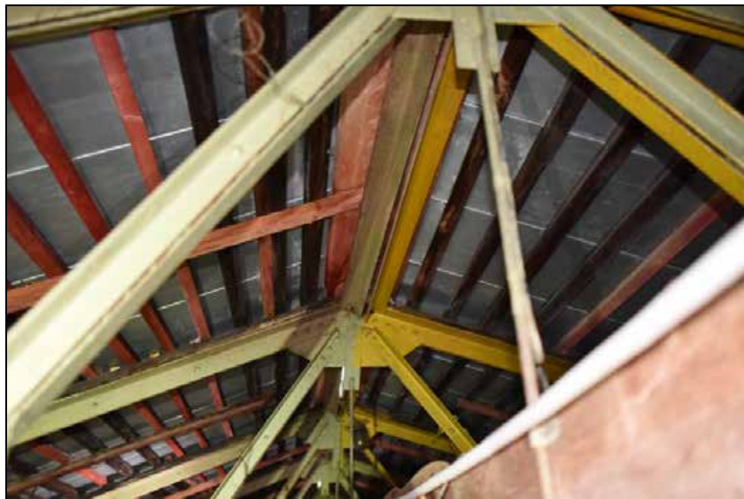
61, 62, 63. Здание «Ресторана», входящего в «Комплекс общественных и жилых зданий Г.А.Александрова (Каменноостровский пр., 10, 12, лит. А)». Чердачное пространство. Фрагменты стропильной системы. (Фото 17.12.2021 г.)
