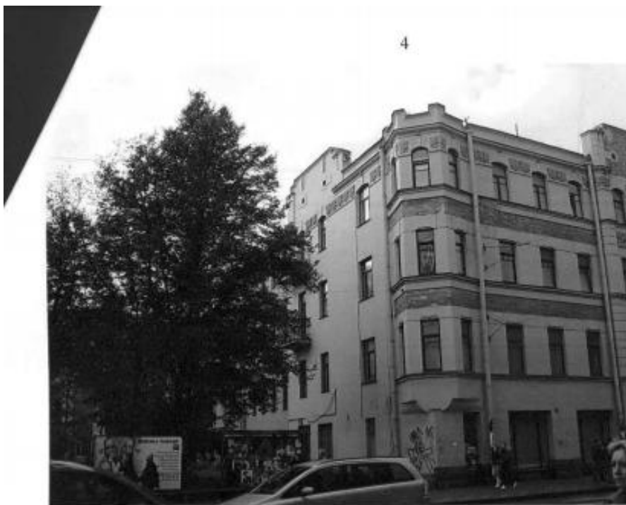
Фрагмент фасада по Каменноостровскому пр. и фрагмент дворового фасада (оконные проемы помещений 2-Н и 13-Н в 1-м этаже). Съемка 11.10.2010г. Е.А.Алехина
