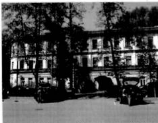
Дворовый флигель. Юго-восточный фасад. Съемка 17.05.2012. Л.Б.Хабло.
