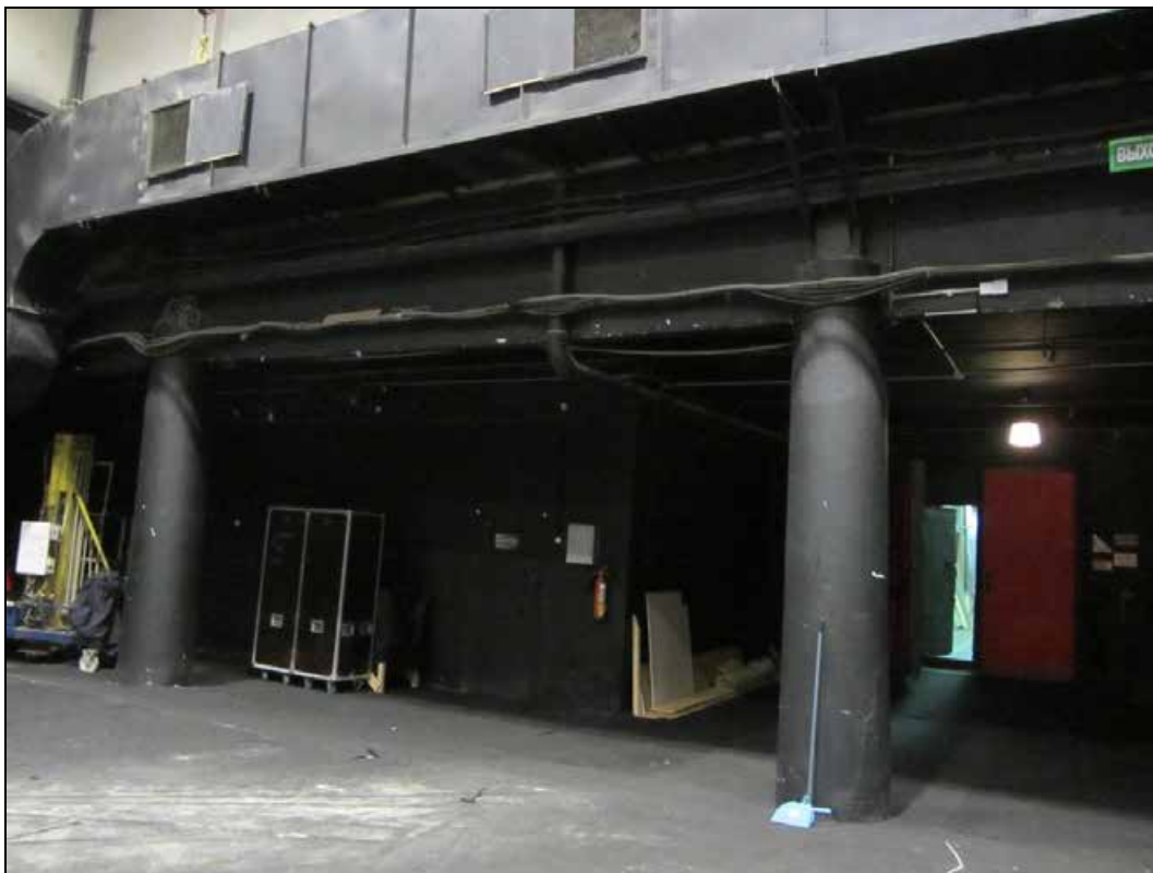
36. Фрагмент интерьера Павильона №1 в здании «Ресторана», входящего в «Комплекс общественных и жилых зданий Г.А.Александрова (Каменноостровский пр., 10, 12, лит.А)» (Фото 17.12.2021 г.)
