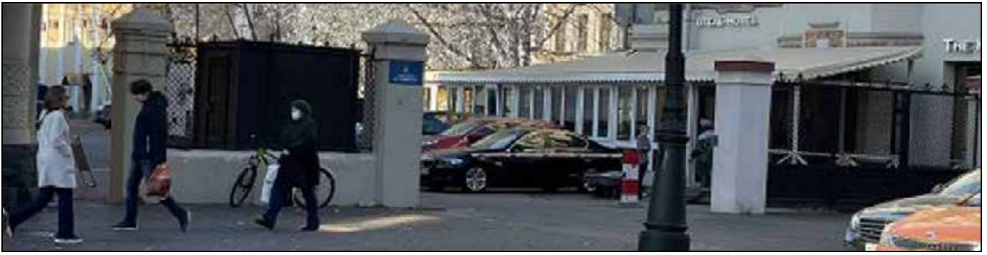
71. «Комплекс общественных и жилых зданий Г.А.Александрова (Каменноостровский пр., 10, 12, лит.А)». Ограда и северная калитка. (Фото 17.12.2021 г.)
