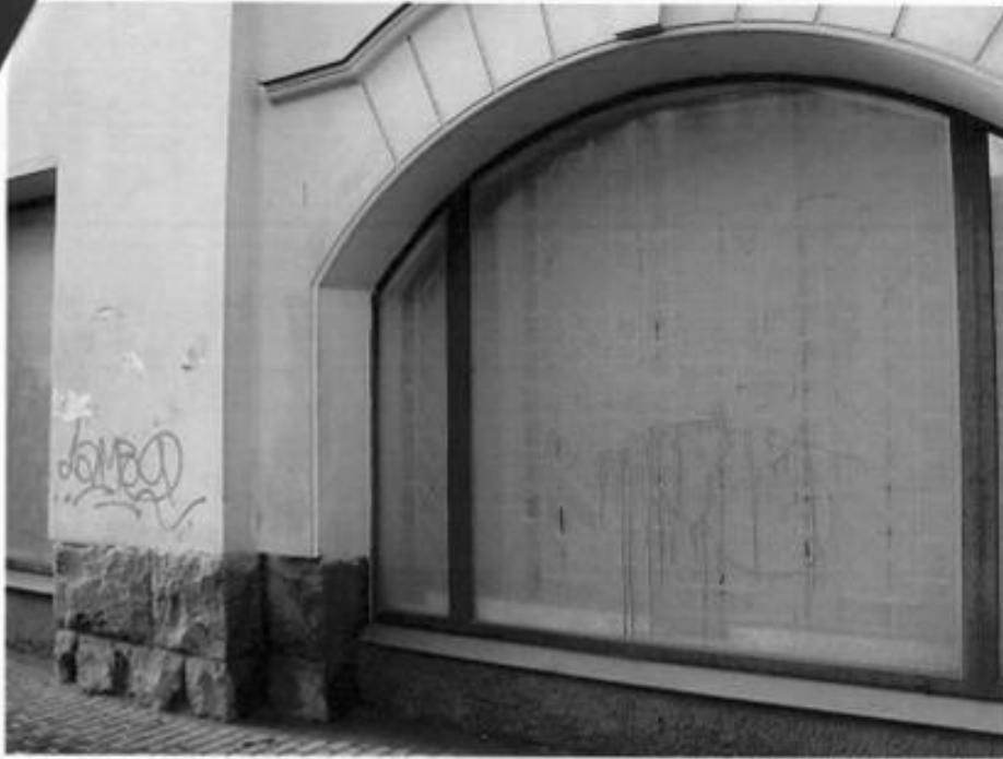
Лицевой фасад по Каменноостровскому пр., оконный проем с коробовым завершением пом. 2-Н. Съемка 11.10.2010г. Е.А.Алехина
