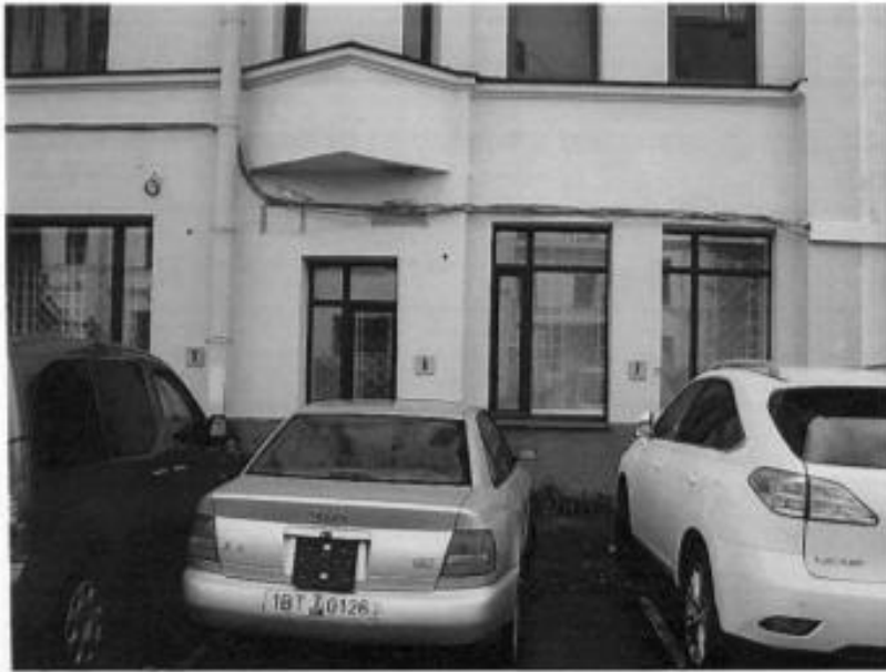
Фасад курдонера. Оконные проемы помещения 13-Н. Съемка 11.10.2010г. Е.А.Алехина
