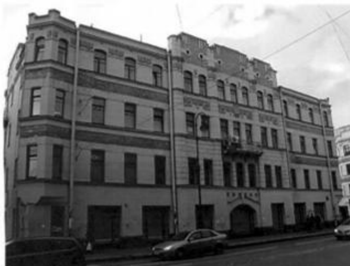
Лицевой фасад по Каменноостровскому пр. (оконные проемы помещений 2-Н и 13-Н в 1-м этаже). Съемка 11.10.2010г. Е.А.Алехина
