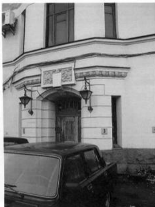
Фрагмент фасада курдонера с парадным входом в помещения 13-Н. Съемка 11.10.2010г. Е.А.Алехина
