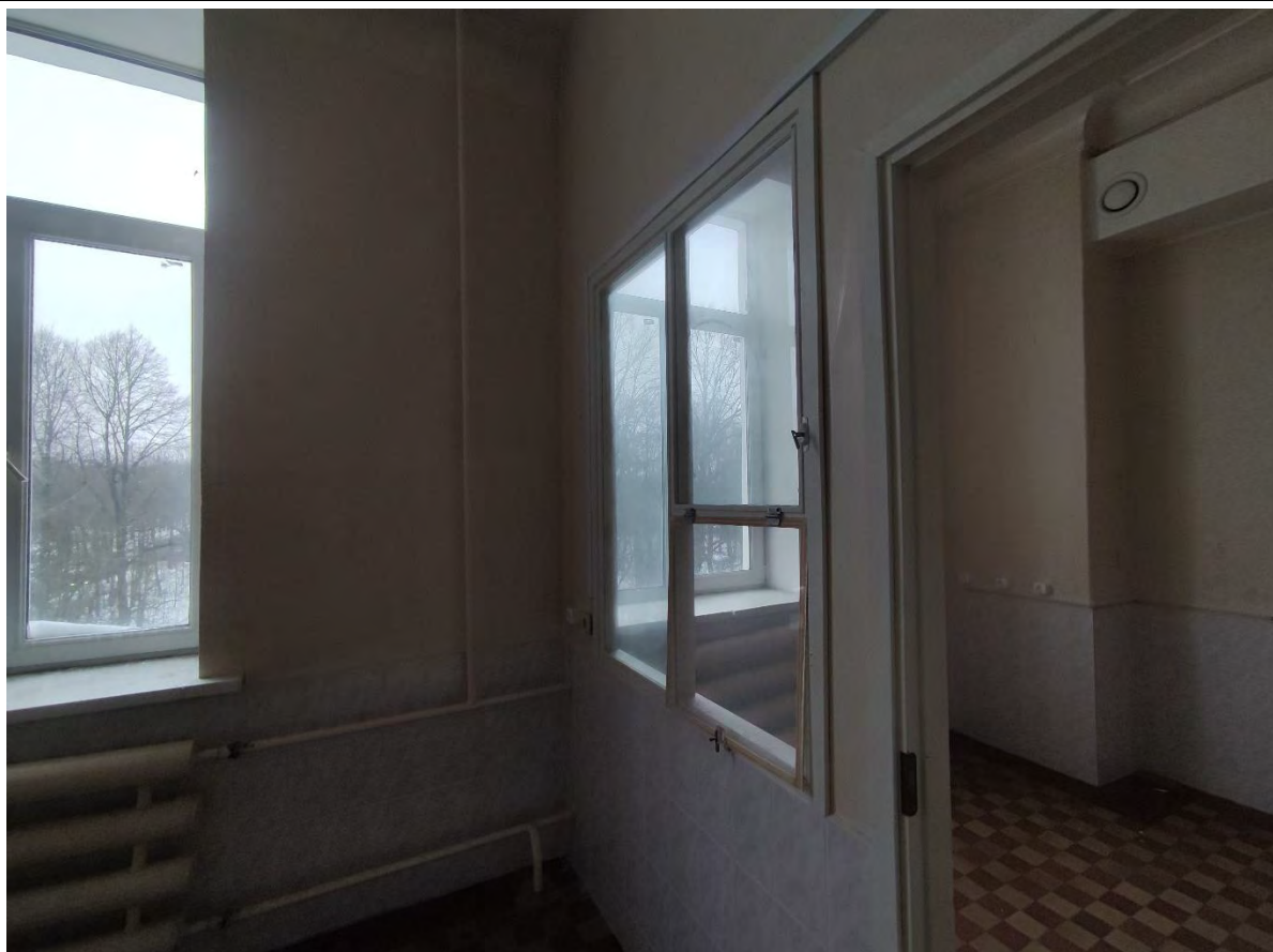
80. Общий вид пом. 4-Н (5, 6) в уровне 3-го этажа.
