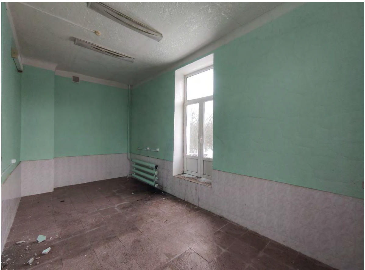
83. Общий вид пом. 4-Н (23) в уровне 3-го этажа.
