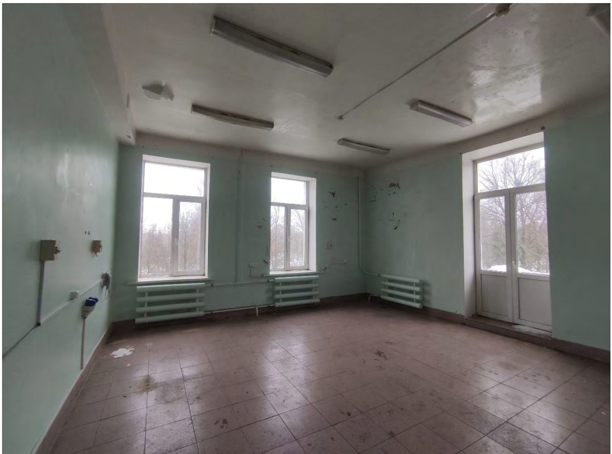
77. Общий вид пом. 4-Н (1) в уровне 3-го этажа.
