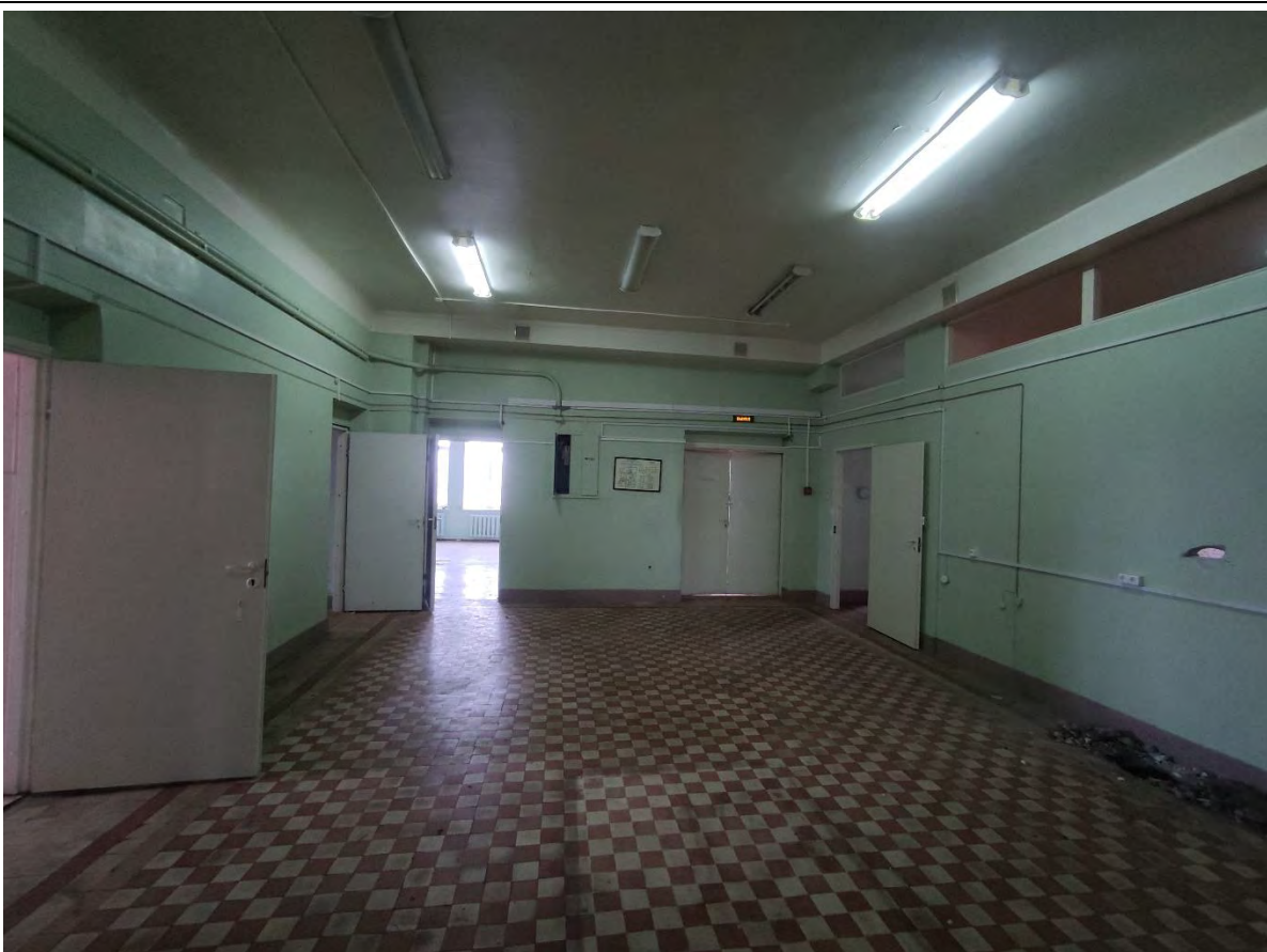
72. Общий вид пом. 4-Н (16) в уровне 3-го этажа.
