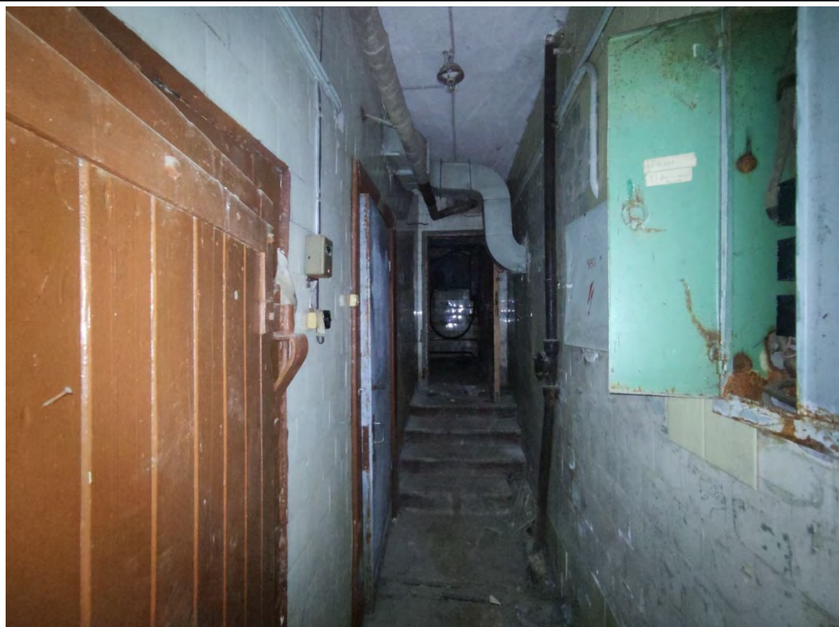
28. Общий вид пом. 1-Н (7) в уровне цокольного этажа.
