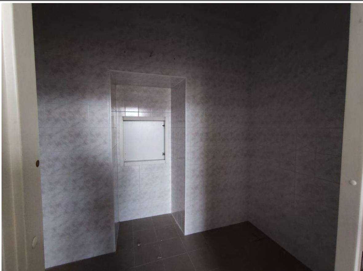
54. Общий вид пом. 3-Н (17) в уровне 2-го этажа.
