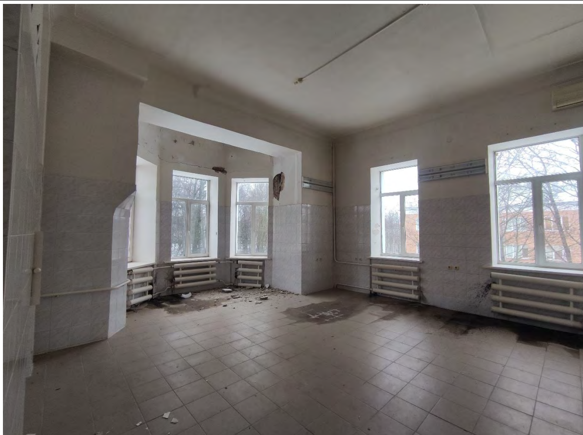
65. Общий вид пом. 3-Н (10) в уровне 2-го этажа.
