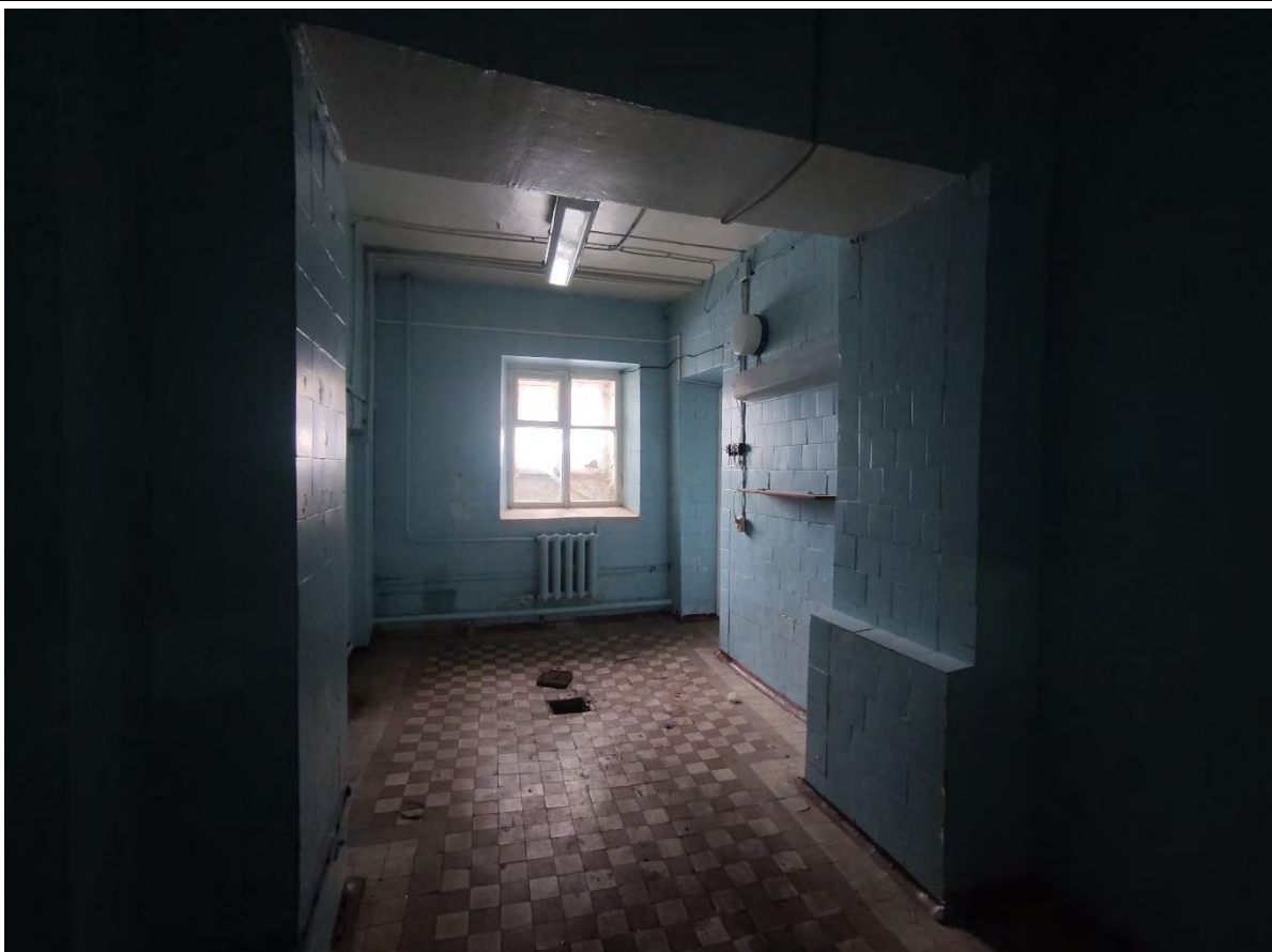
21. Общий вид пом. 1-Н (25) в уровне цокольного этажа.
