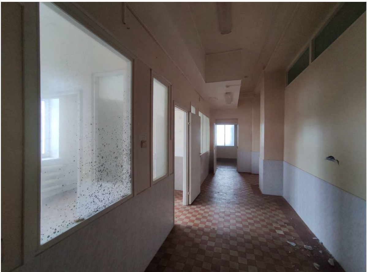
78. Общий вид пом. 4-Н (2, 3, 22) в уровне 3-го этажа.
