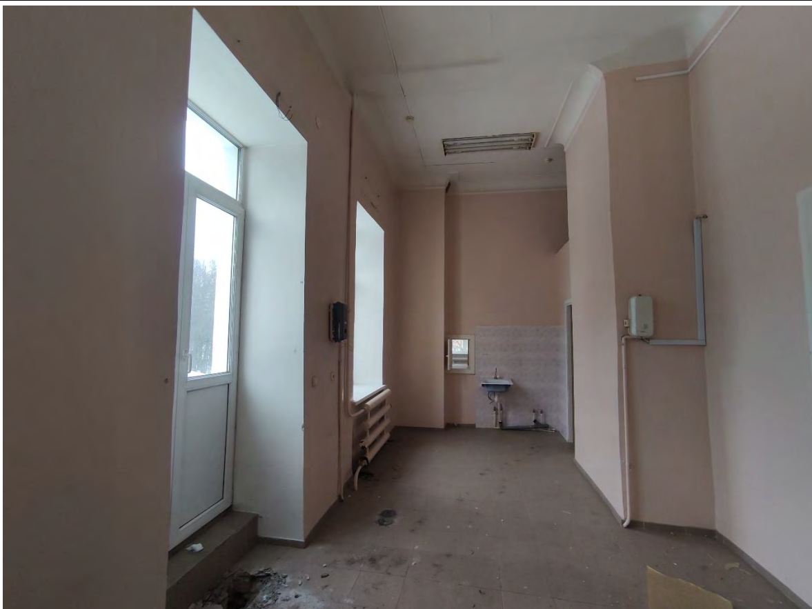
64. Общий вид пом. 3-Н (4, 7, 26) в уровне 2-го этажа.
