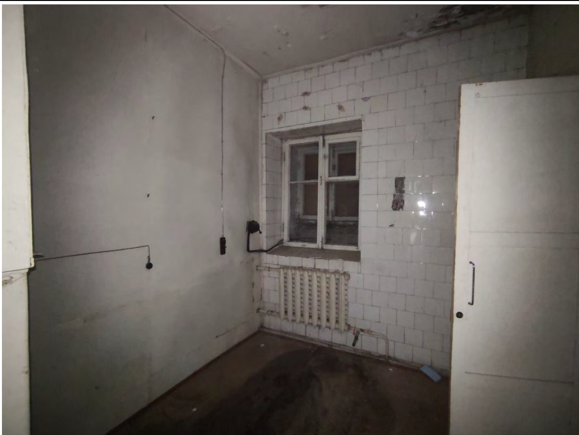
34. Общий вид пом. 1-Н (12) в уровне цокольного этажа.
