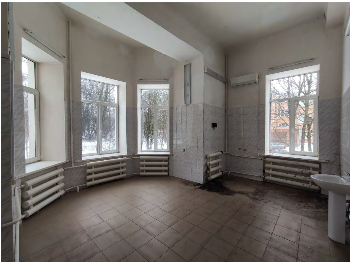
49. Общий вид пом. 2-Н (4, 5) в уровне 1-го этажа.
