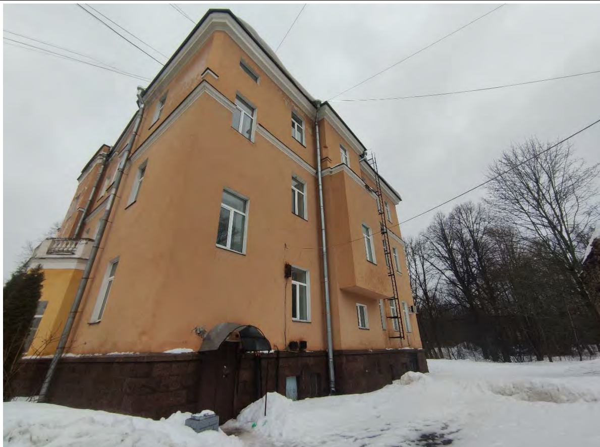
11. Общий вид северного фасада выявленного объекта культурного наследия значения «Дом Л.В. Калина (с садом)», расположенного по адресу: Санкт-Петербург, город Пушкин, Жуковско-Волынская улица, дом 2, литера А.
