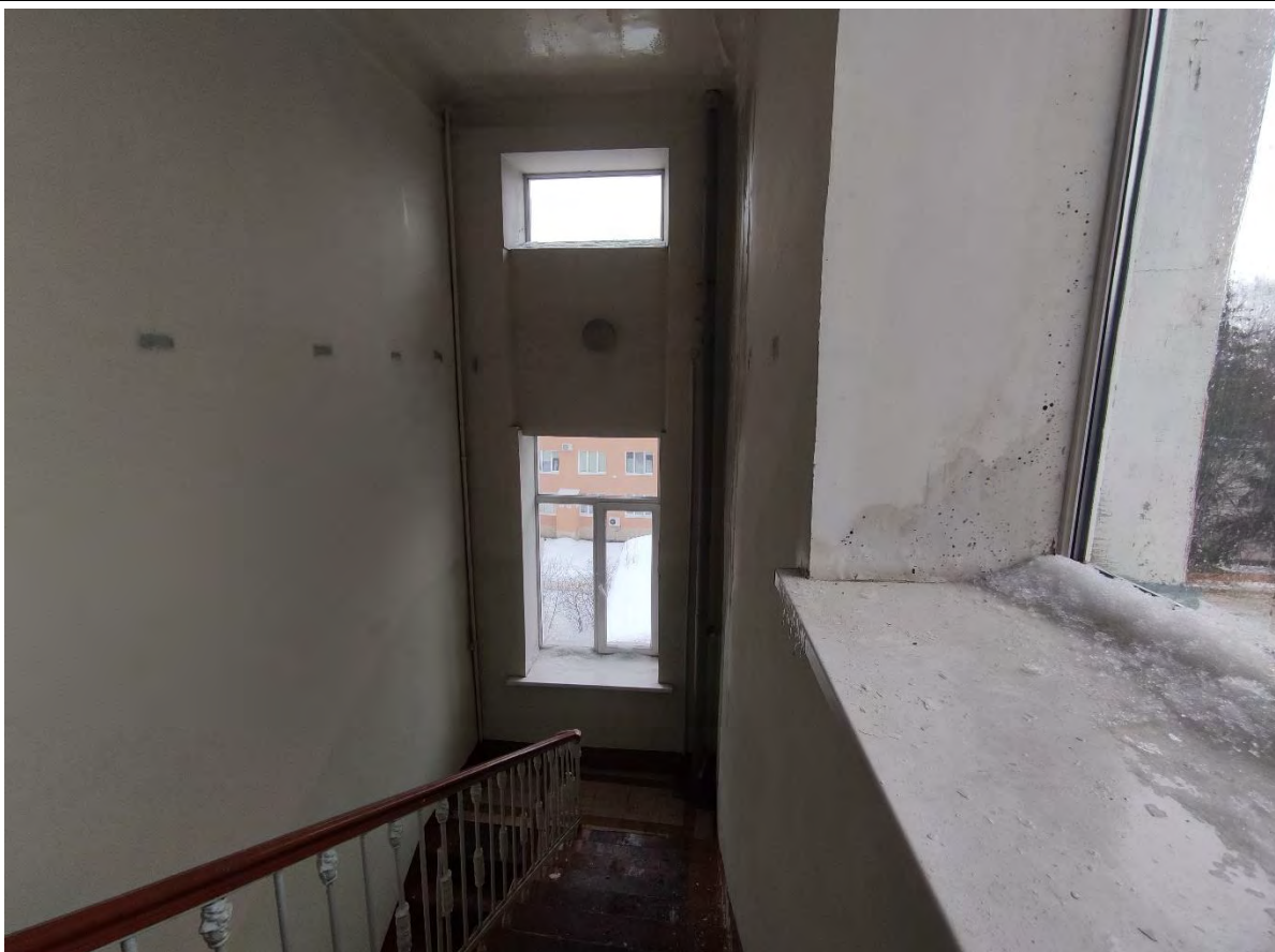
69. Общий вид объема двухмаршевой лестницы (пом. 4-Н (29)) в уровне 3-го этажа.
