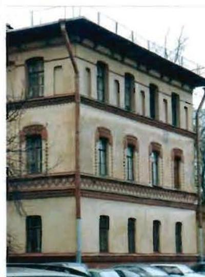
оформление оконных проемов - наличники оконных проемов 2-го этажа – с декоративным ребристым оформлением перемычек, стилизованными «ушками» и строчными выпусками кирпича по сторонам; оформление свесов кровли – деревянные кобылки;
