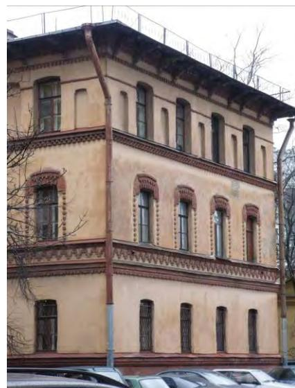
оформление оконных проемов - наличники оконных проемов 2-го этажа – с декоративным ребристым оформлением перемычек, стилизованными «ушками» и строчными выпусками кирпича по сторонам; оформление свесов кровли – деревянные кобылки;
