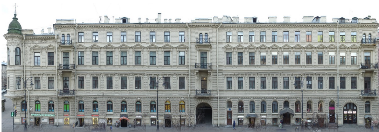
6. Восточный лицевой фасад объекта культурного наследия регионального значения «Дом Вейнера П.П.», расположенного по адресу: г. Санкт-Петербург, ул. Чайковского, д. 38/9, литера А. 28.04.2022
