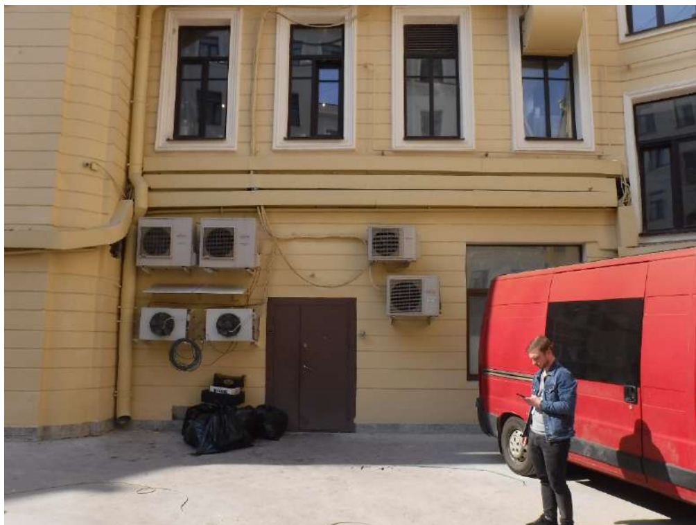
Фото № 11. Общий вид на дверь ДН-3 со стороны двора.
