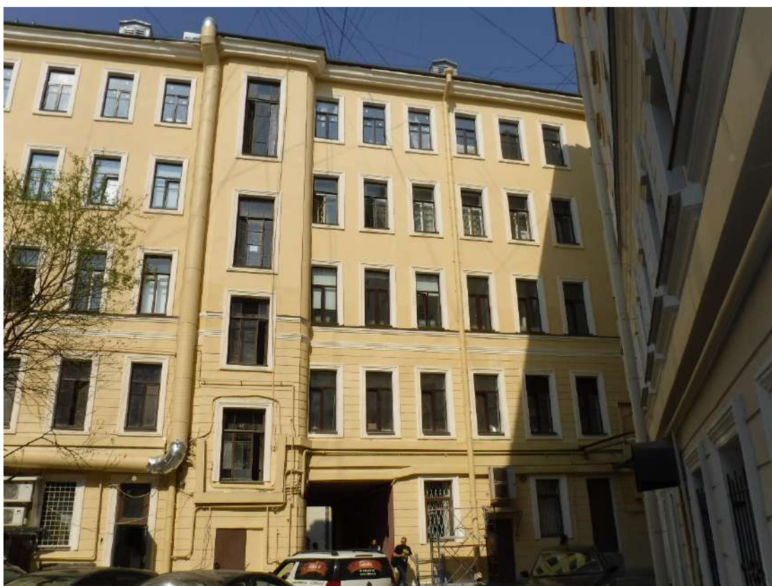
Фото № 10. Фрагмент дворового фасада с дверью ДН-2
