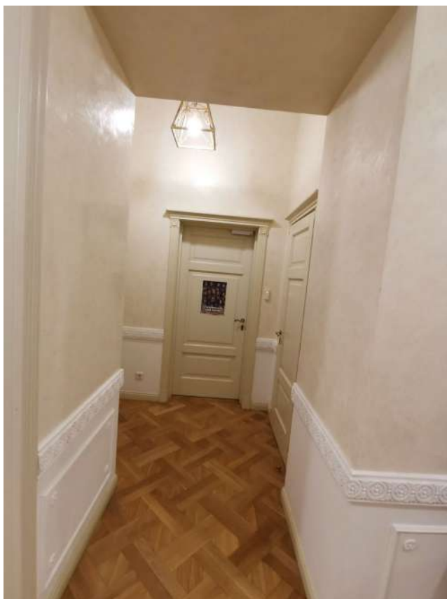
Фото 5. Вид на новые дверные заполнения проемов.
