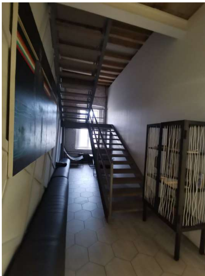
Фото 13. Вид на лестничную клетку 2
