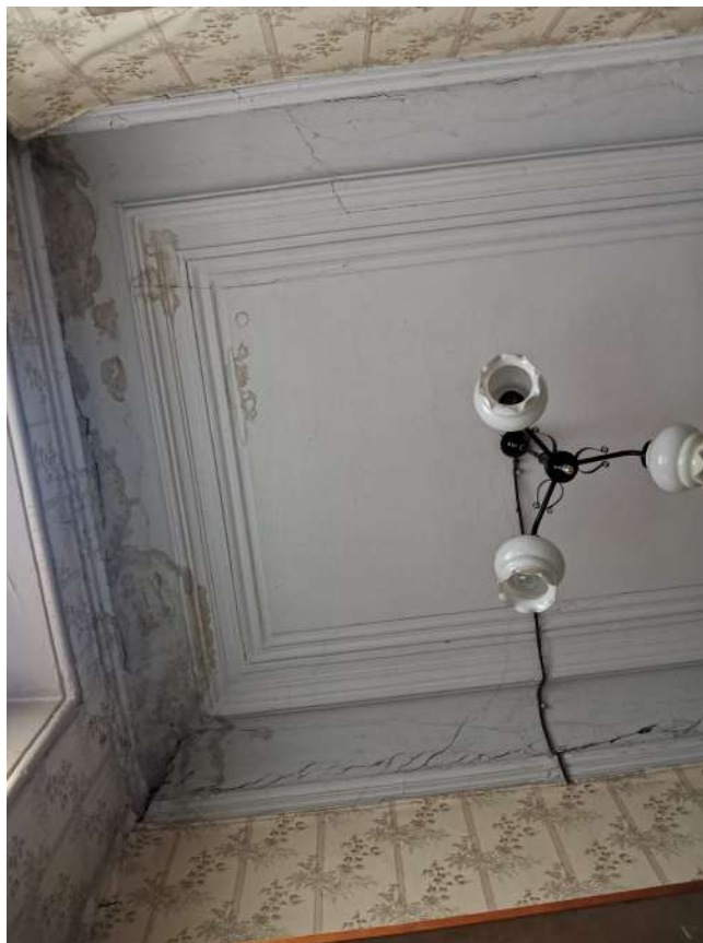
Фото №27. Фрагмент потолка помещения (пом.№13 согласно плану ПИБ)
