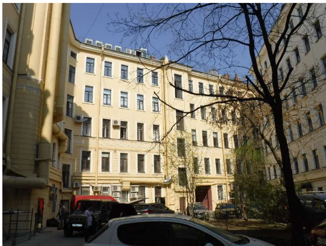
Фото № 8. Фрагмент дворового фасада помещения 3-Н с дверьми ДН-2 и ДН-3
