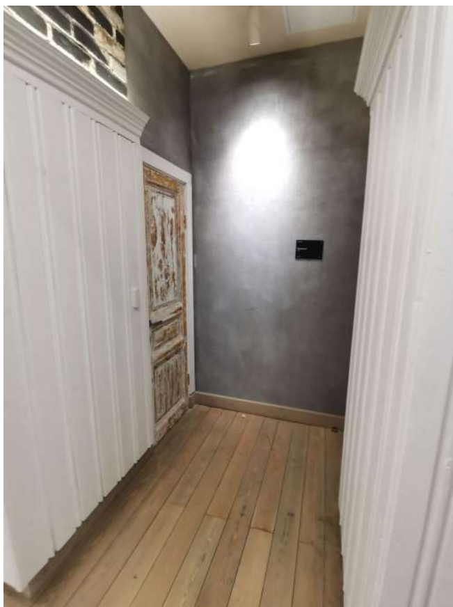
Фото 13. Заполнение дверного проема
