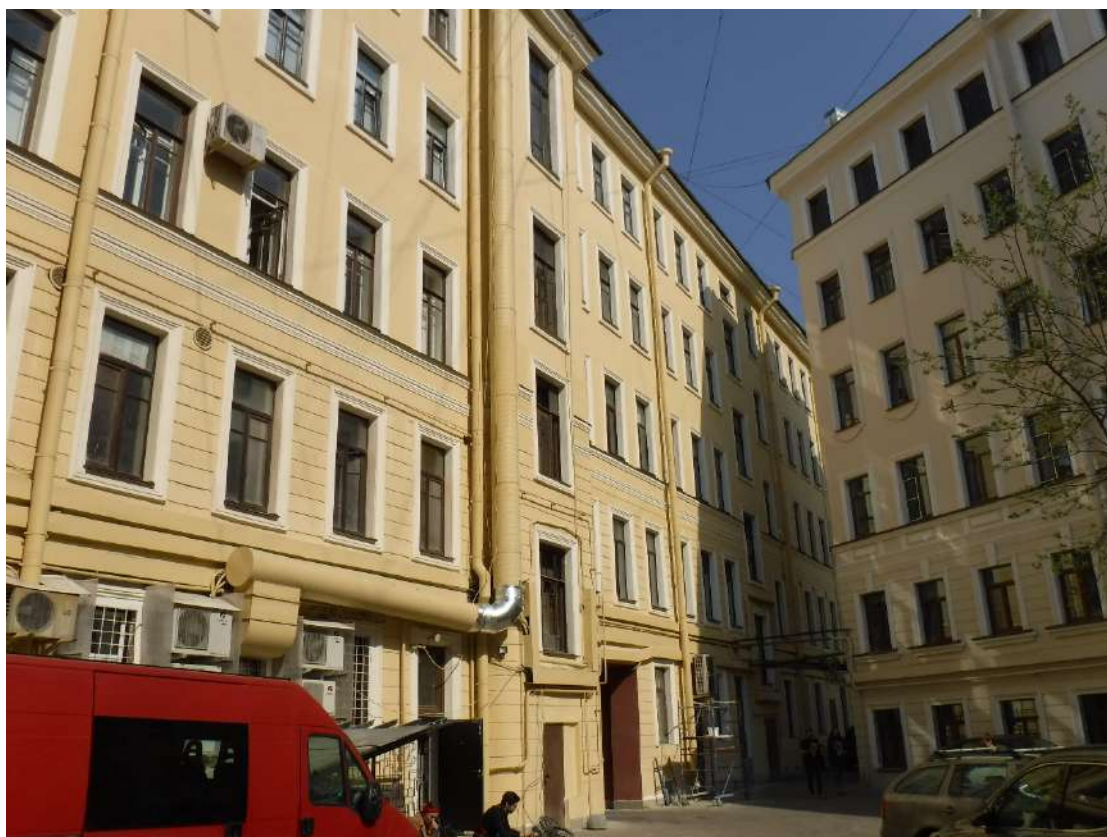
Фото № 9. Фрагмент дворового фасада с дверью ДН-2
