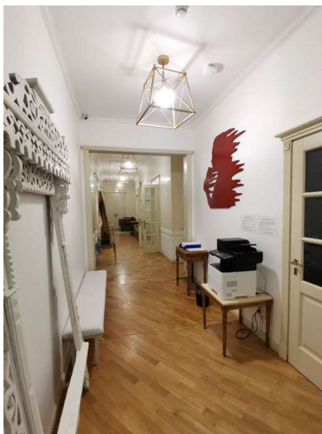
Фото 2. Вид на коридор, и расширенный дверной проем с удалением позднего кирпичного заполнения.
