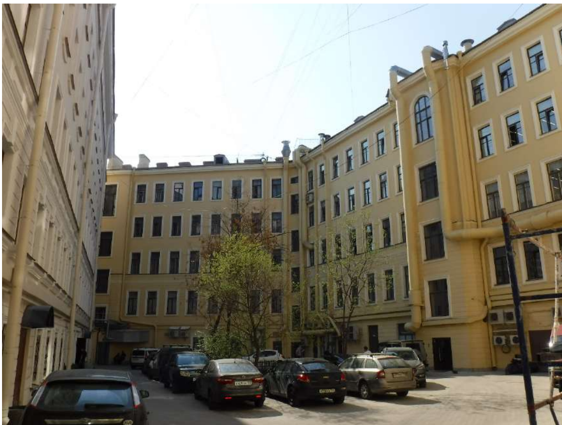
Фото № 5. Общий вид на дворовые фасады
