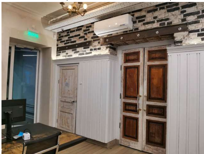
Фото 10. Современные дверные заполнения с использованием исторических столярных изделий.
