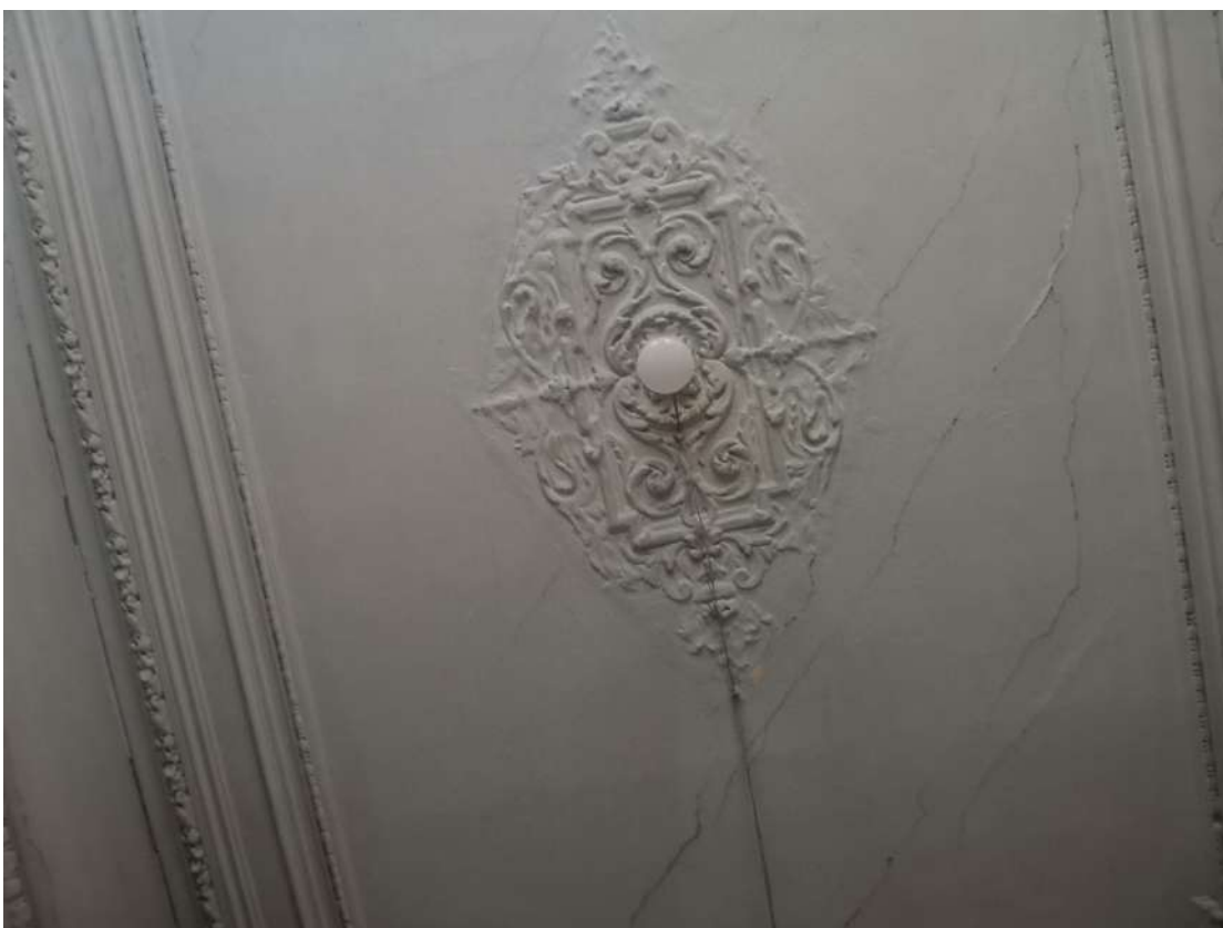
Фото №46. Фрагмент потолка помещения (пом.№4 согласно плану ПИБ)
