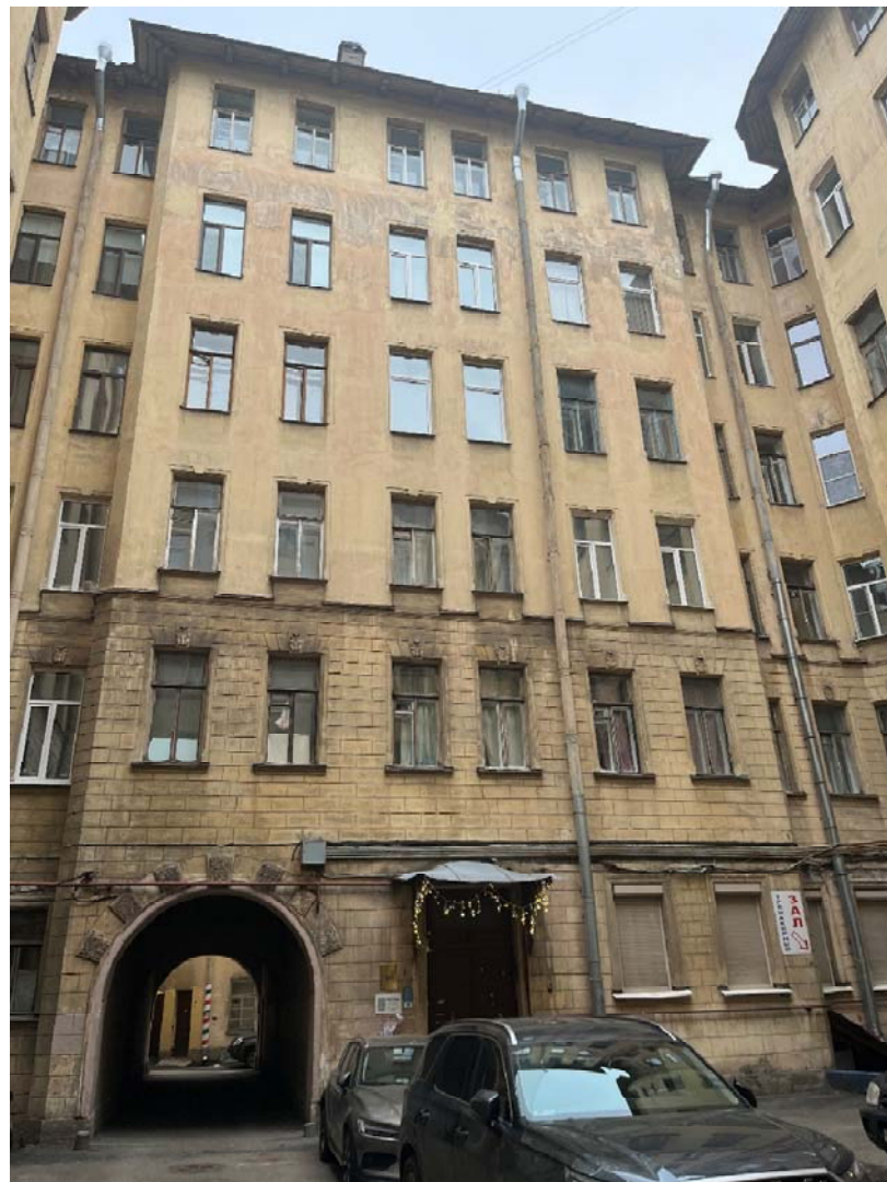
Фото №1. Дворовый фасад здания.
