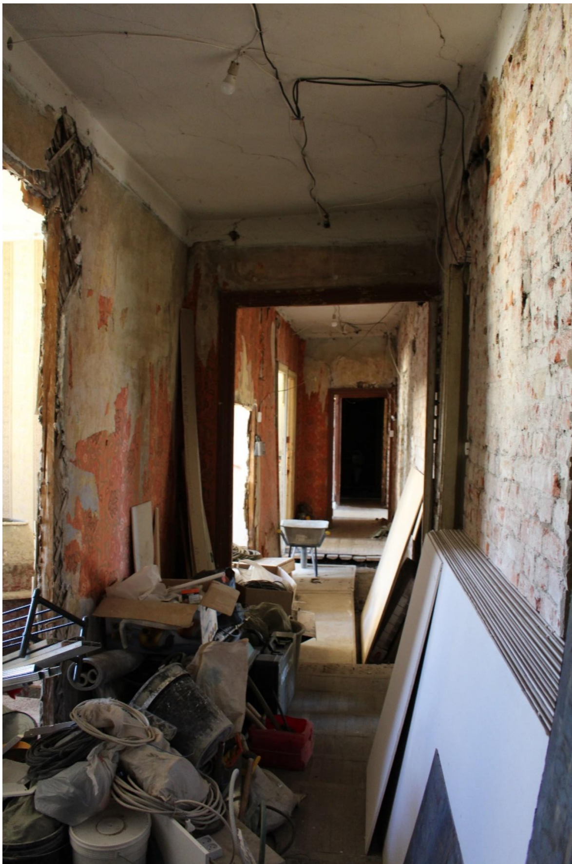
Фото 15. Вид на помещение 1.
