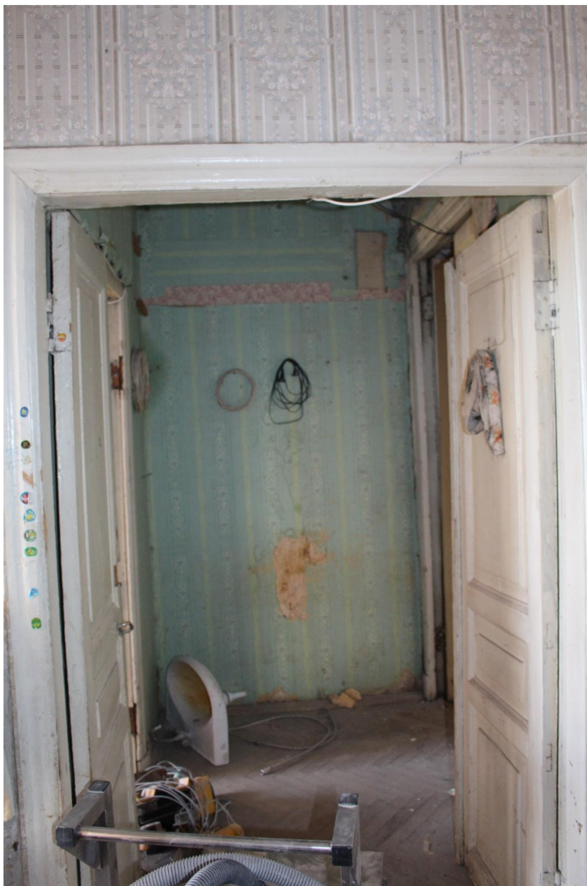
Фото 25. Вид на помещение № 18.
