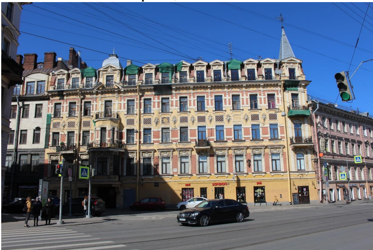
Фото 1. Вид на лицевой фасад выявленного объекта культурного наследия «Дом А.А. Кушелева» с юга.
