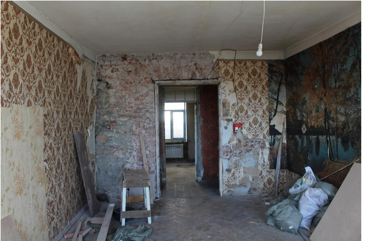
Фото 37. Вид на помещение № 14.
