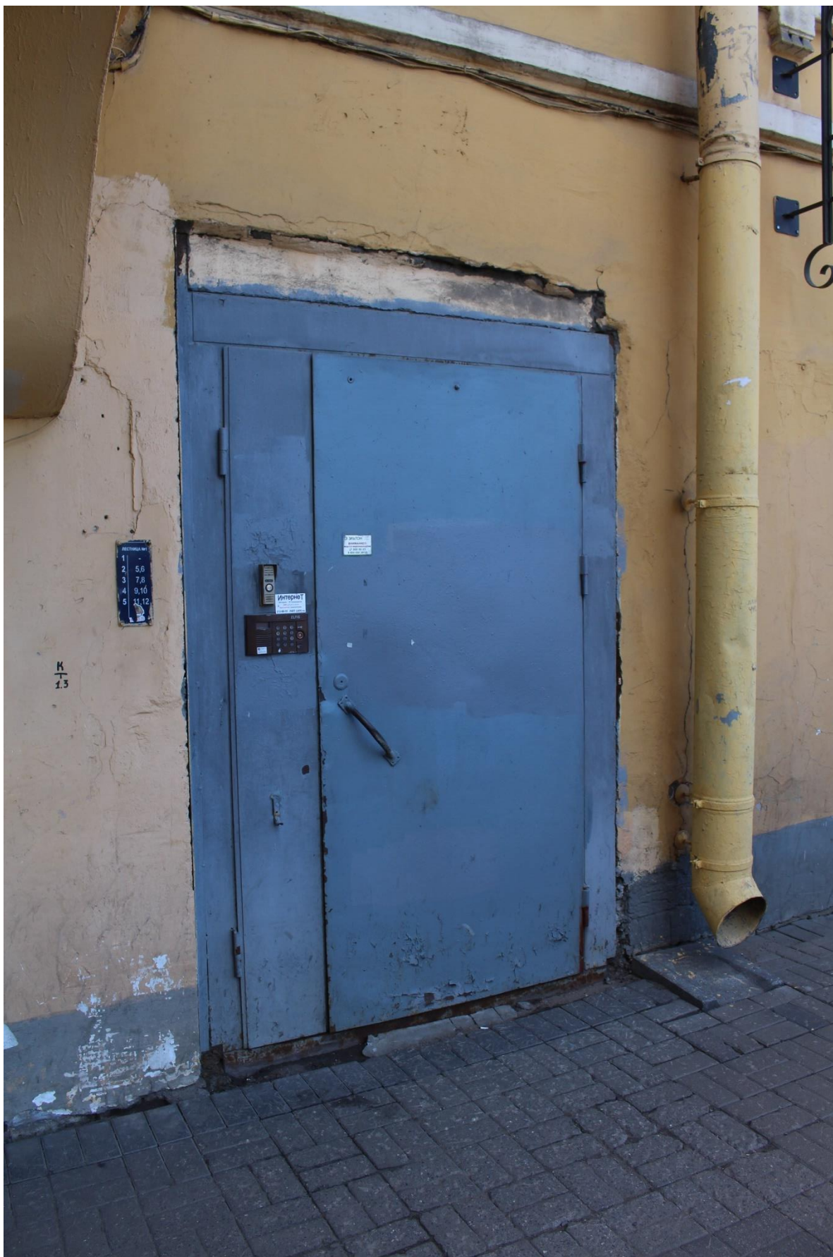
Фото 13. Вход в 1ЛК.
