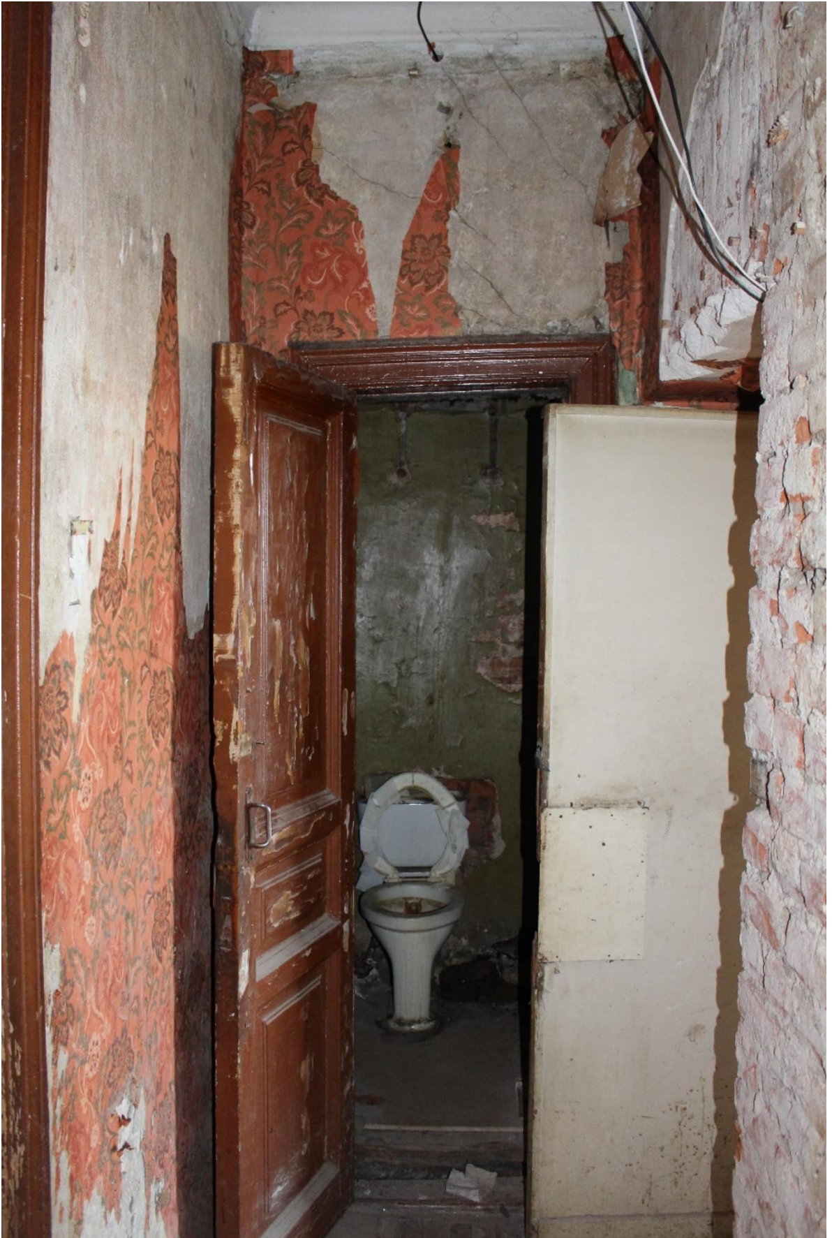
Фото 40. Вид на помещение № 12.
