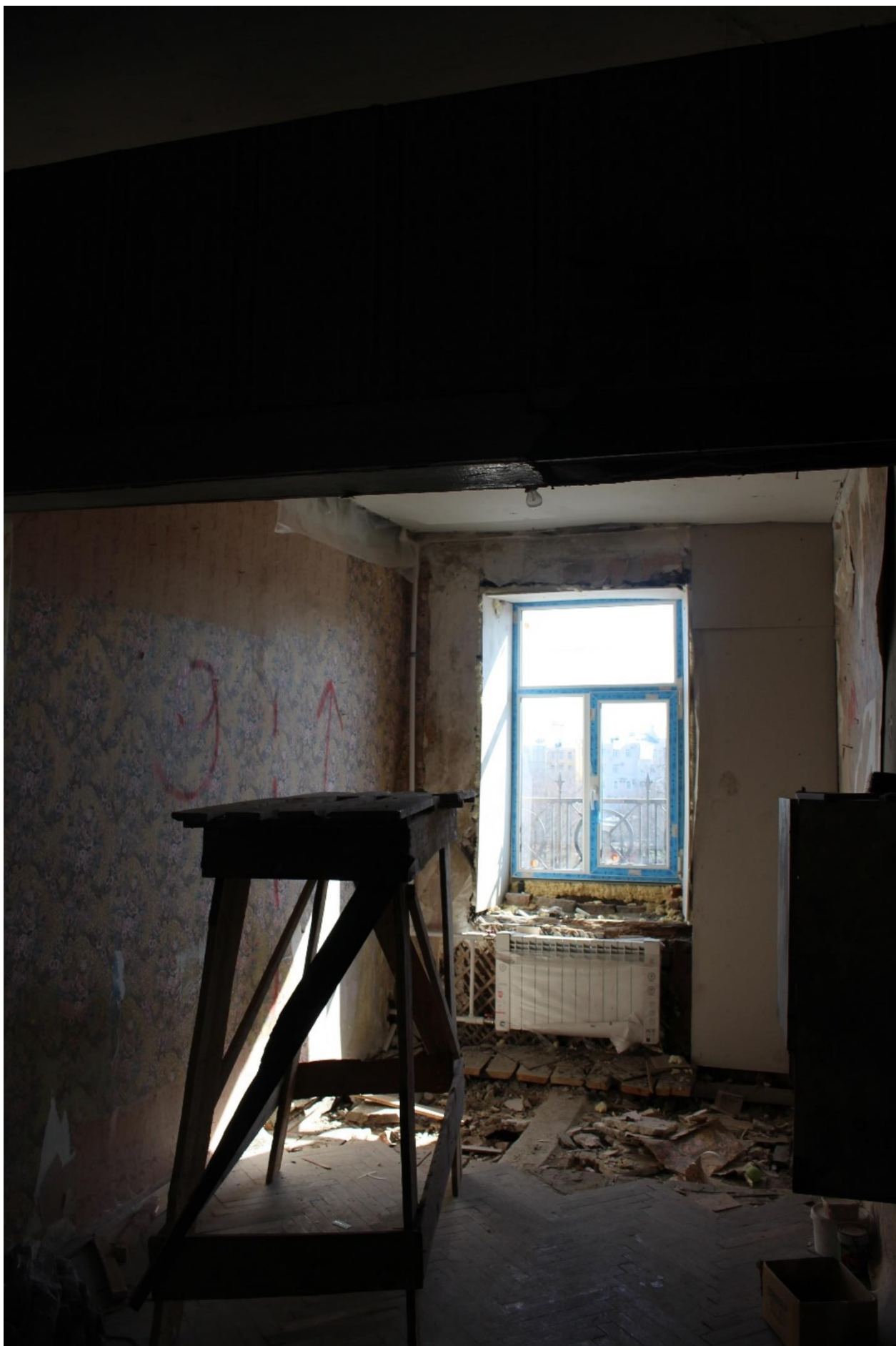
Фото 23. Вид на помещение № 16.
