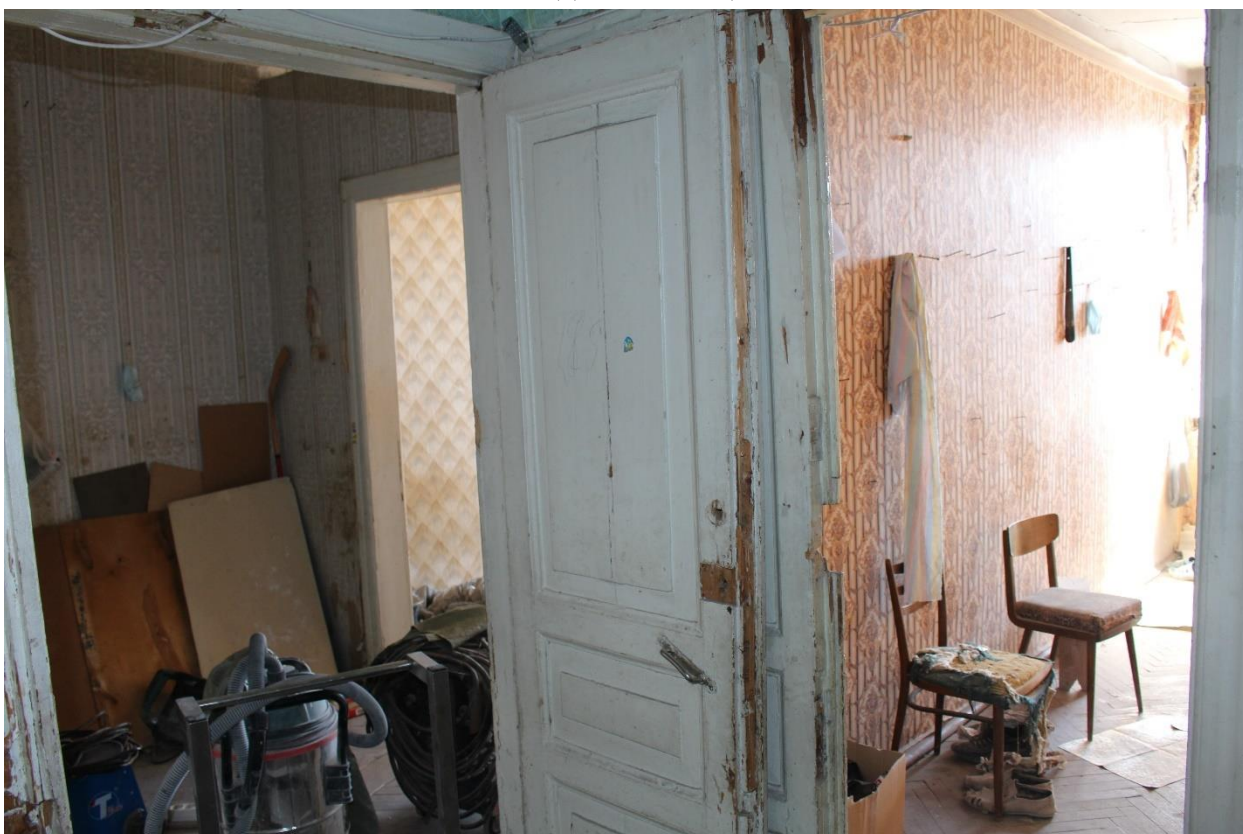
Фото 20. Вид на помещение № 18, ведущее в помещения № 16 и № 17.
