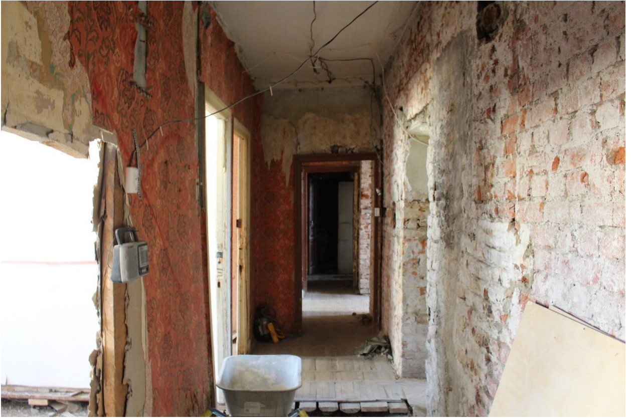
Фото 30. Вид на помещение № 19 в сторону помещения № 20.
