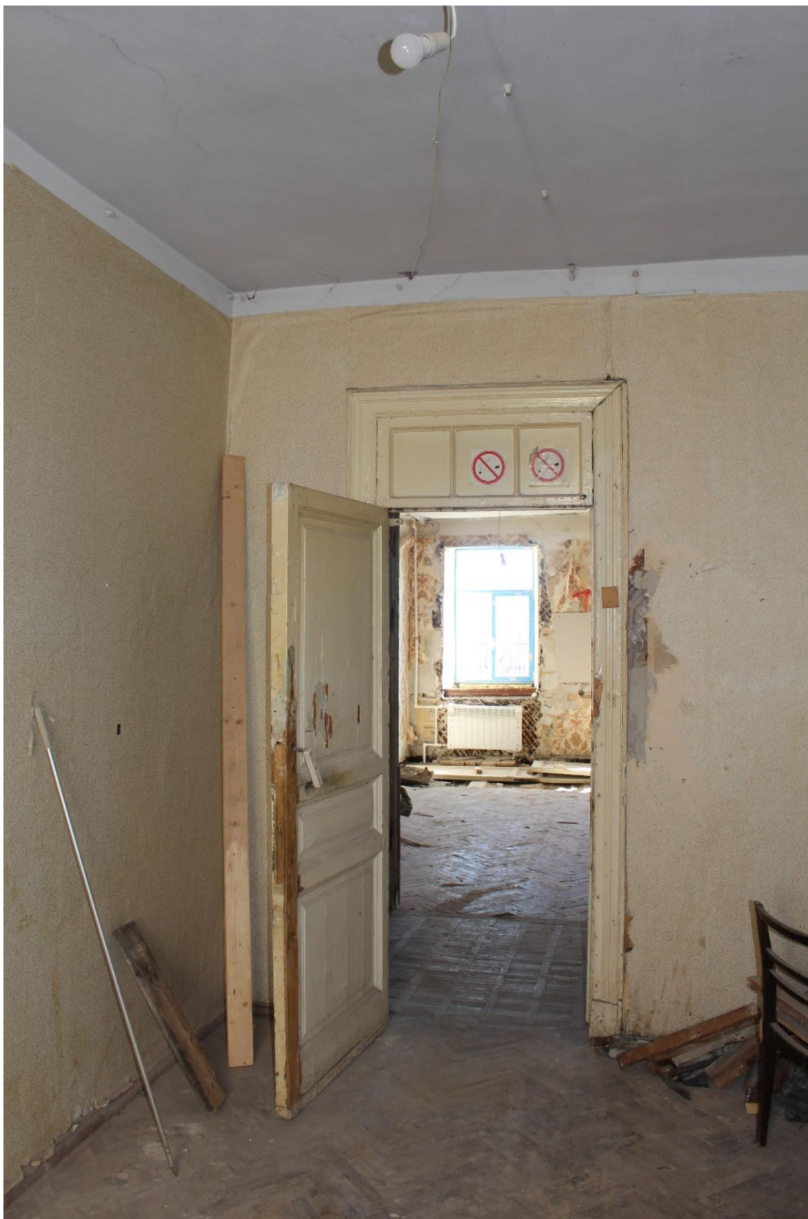
Фото 39. Вид на помещение № 6.
