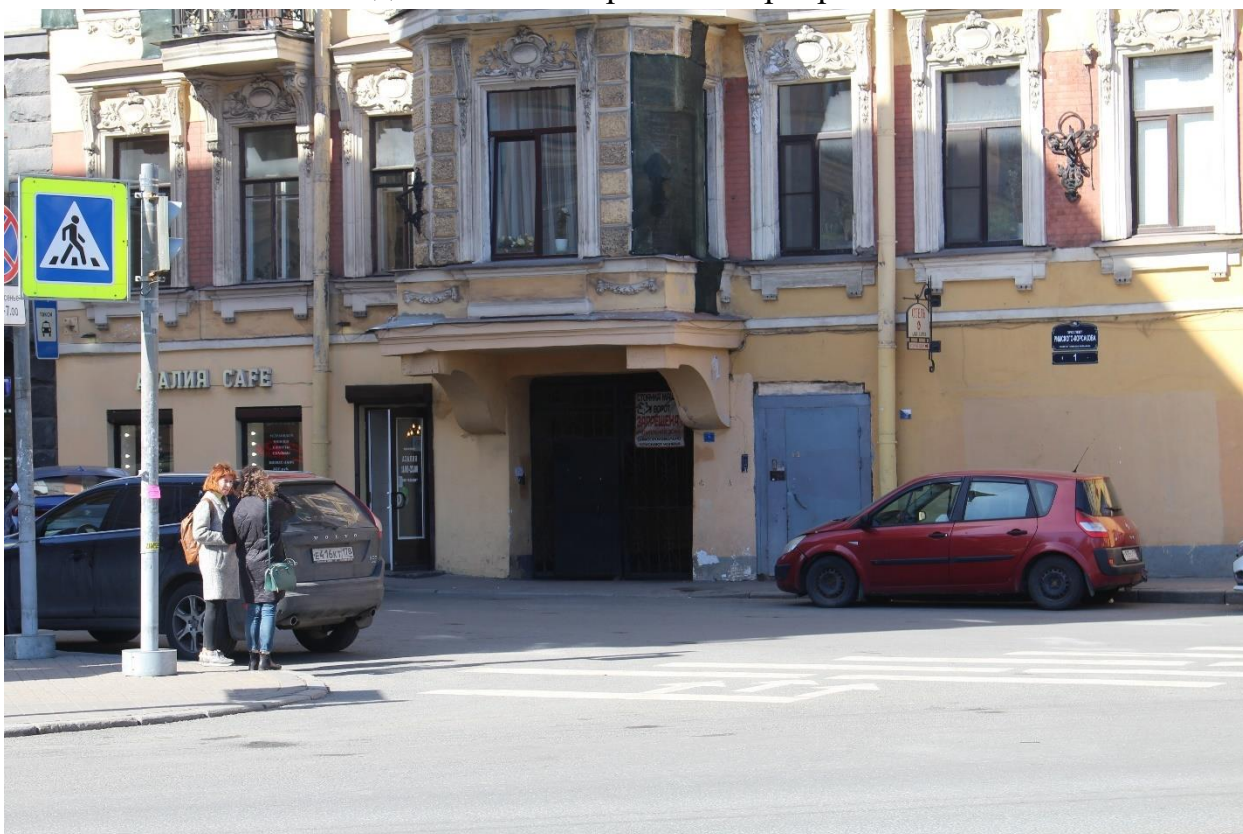
Фото 4. Вид на арку воротного проезда, ведущую во двор и вход в 1ЛК.
