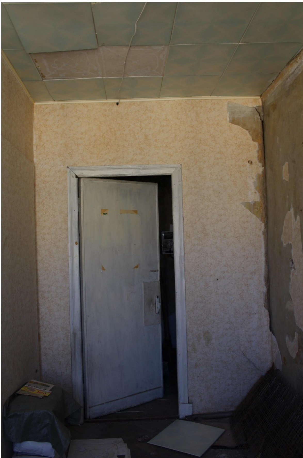
Фото 18. Вид на помещение № 2.
