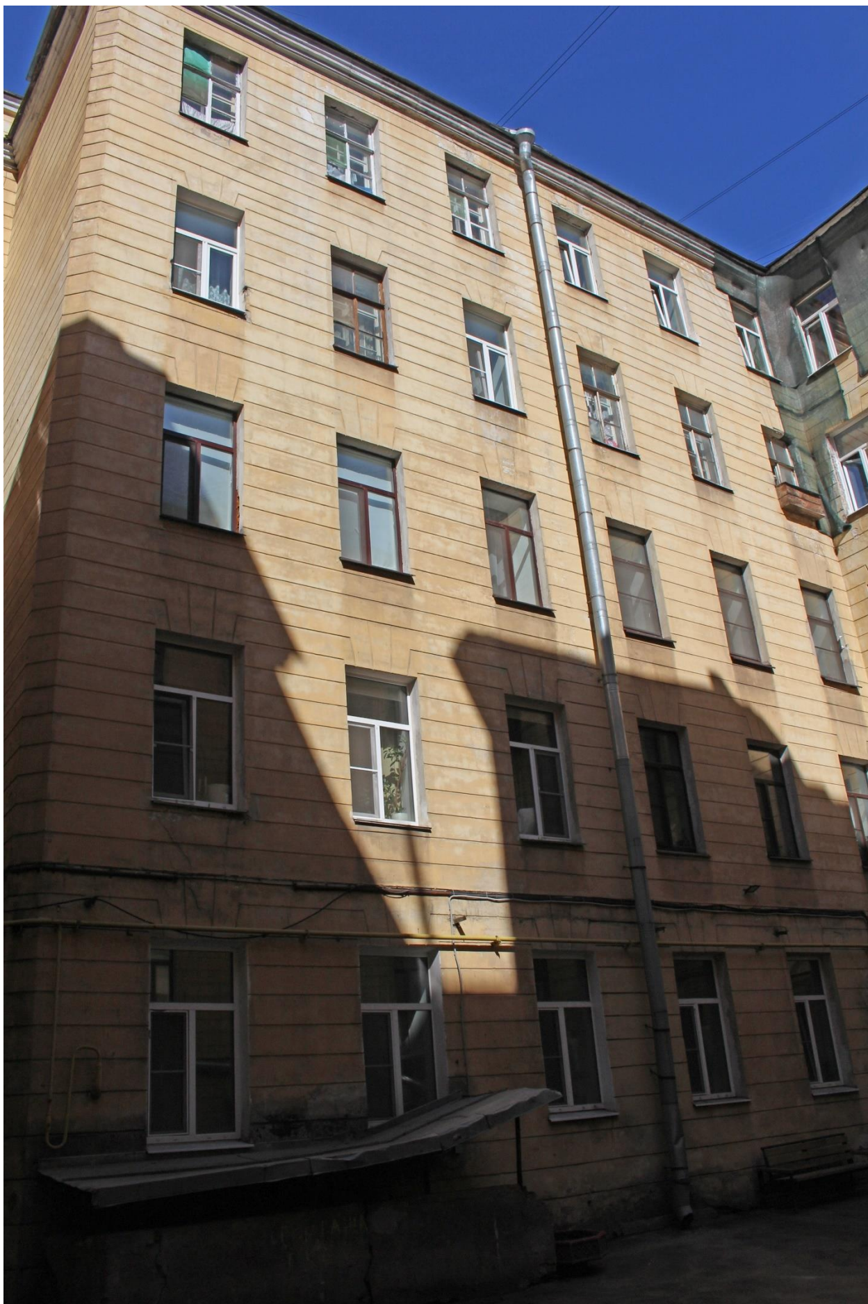
Фото 11. Вид на северный дворовый корпус южного двора.
