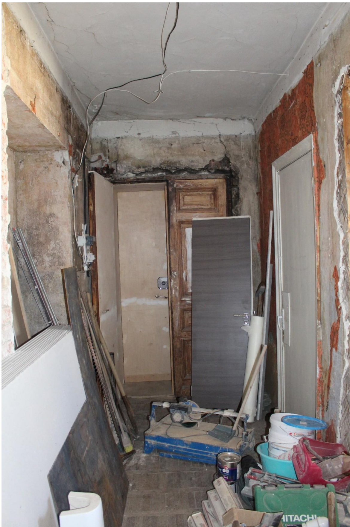
Фото 16. Вид на помещение 1.
