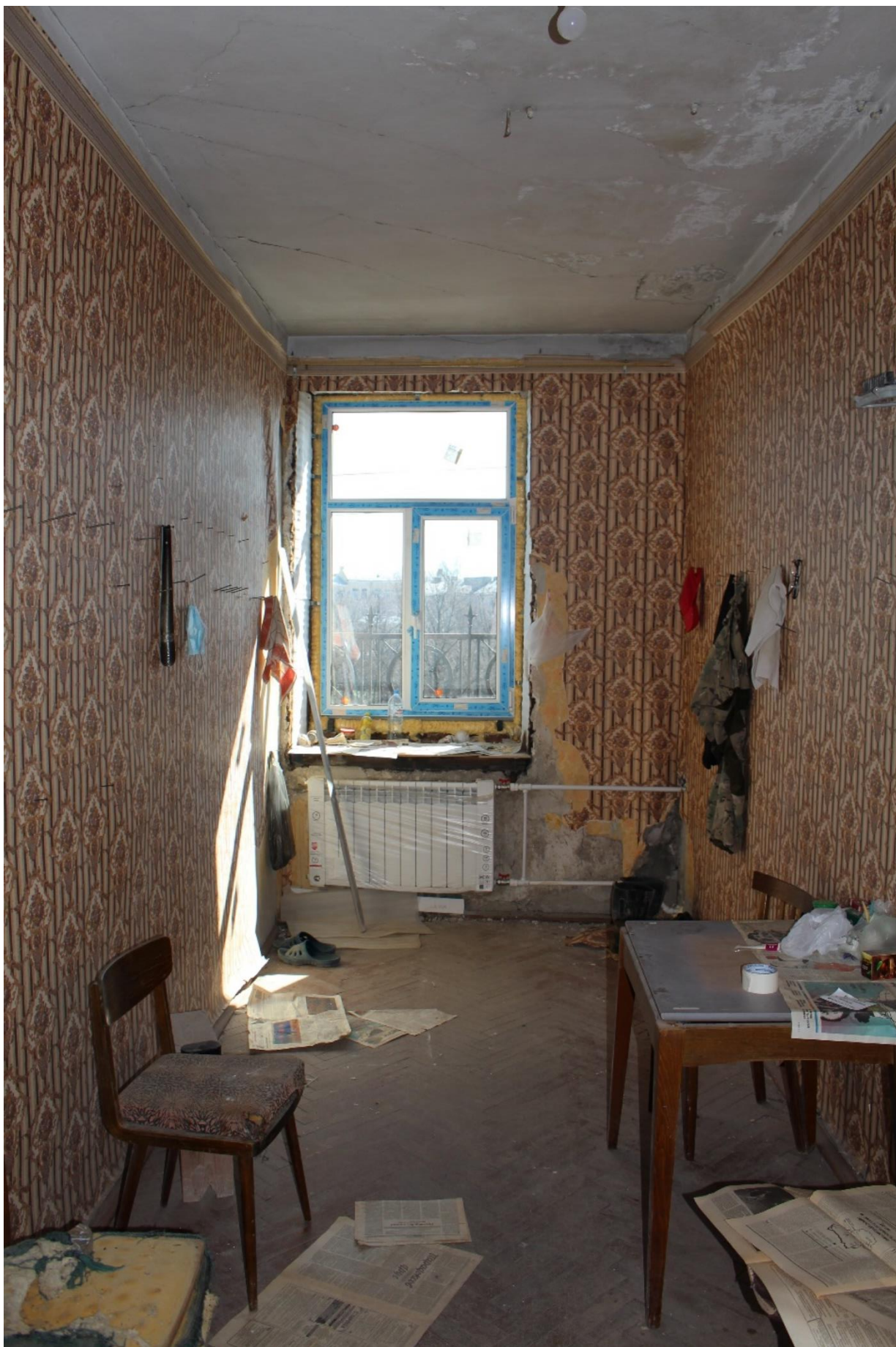
Фото 21. Вид на помещение № 17.
