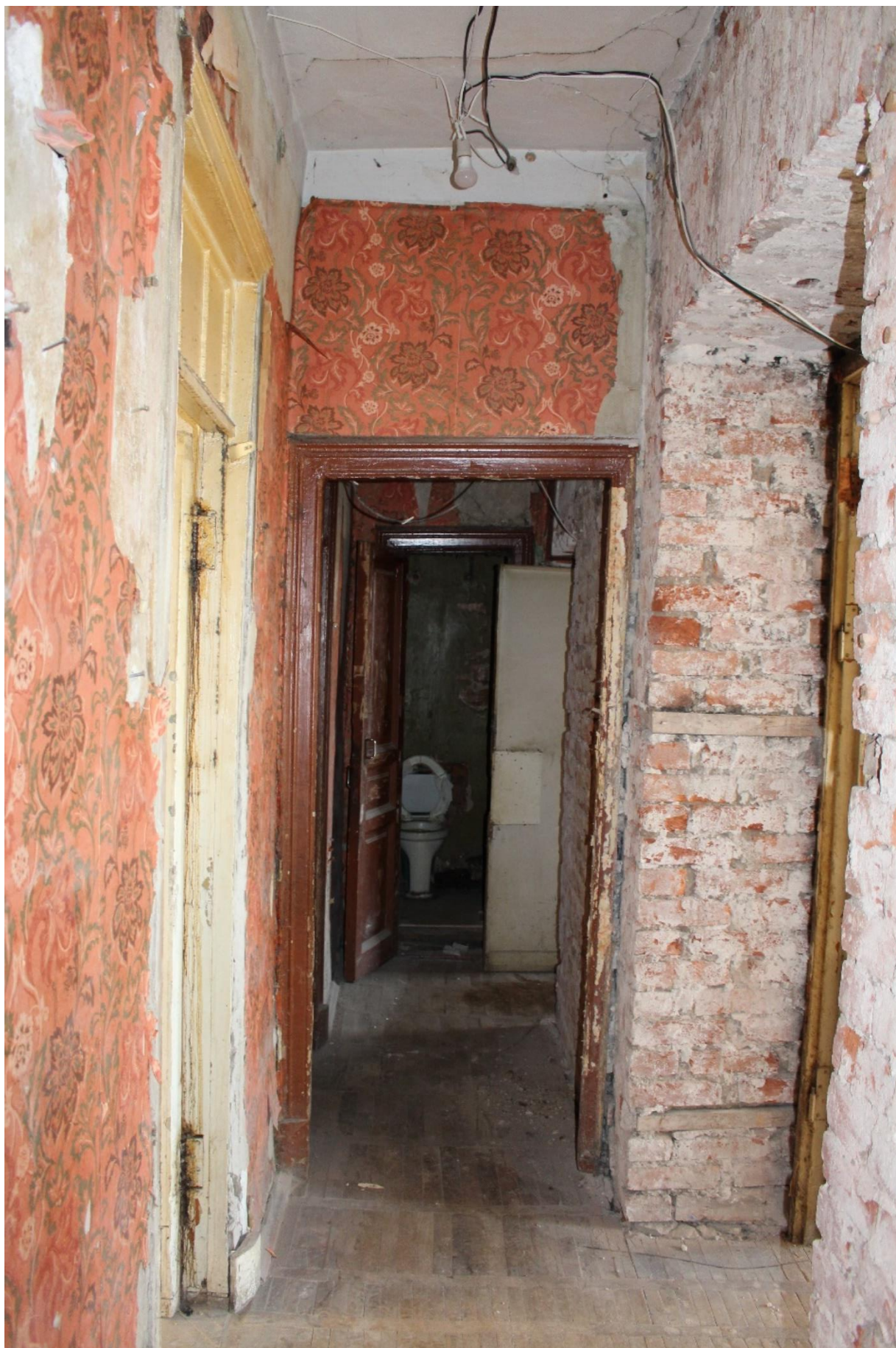
Фото 35. Вид на помещение № 20.
