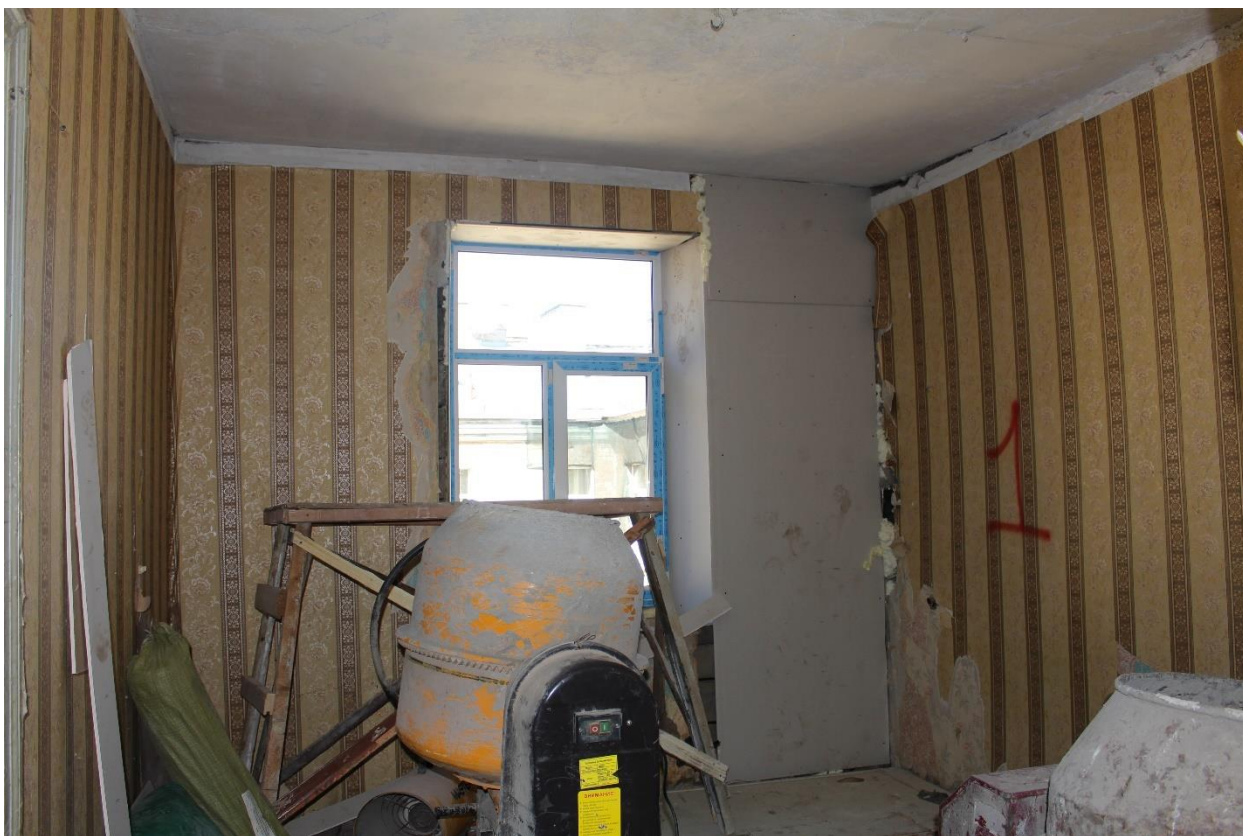
Фото 19. Вид на помещение № 3.
