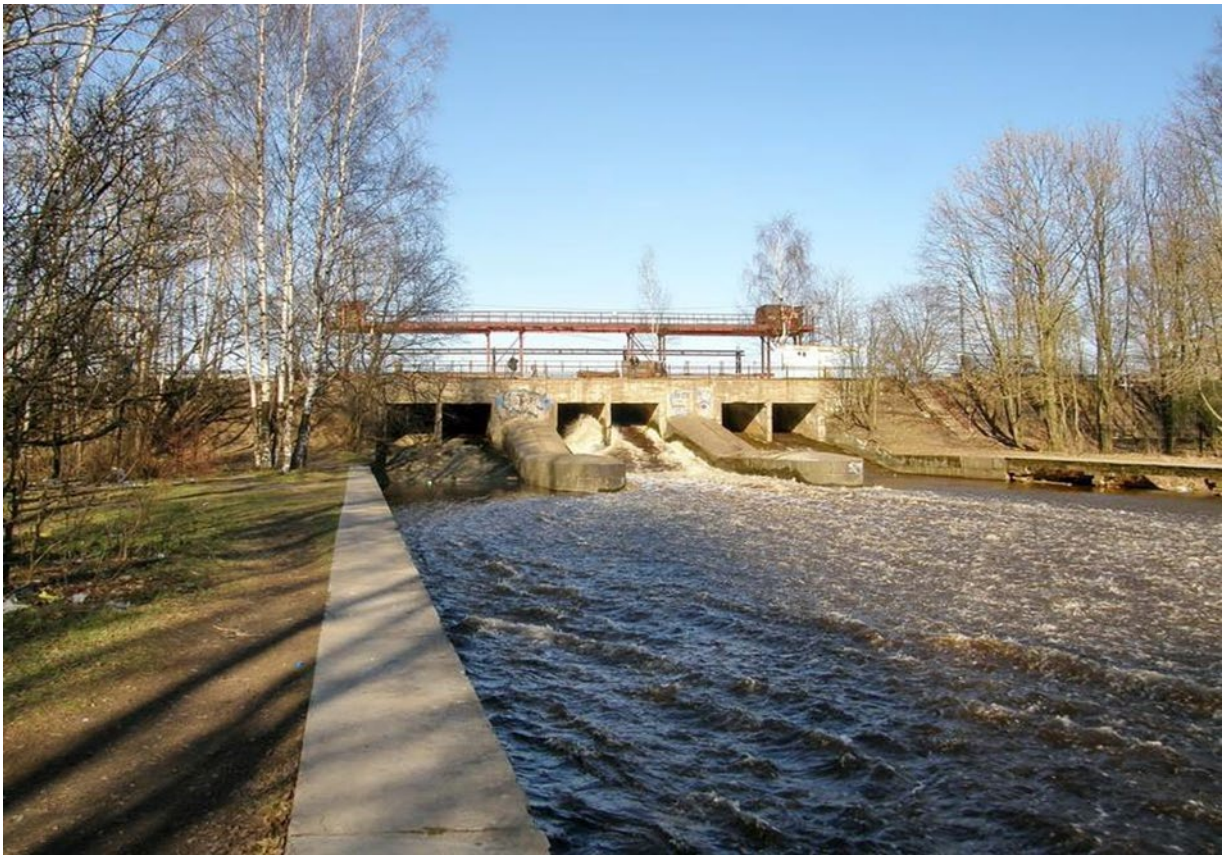
Илл. 19. Главная плотина Охтинских пороховых заводов, фото 2000-е гг.
