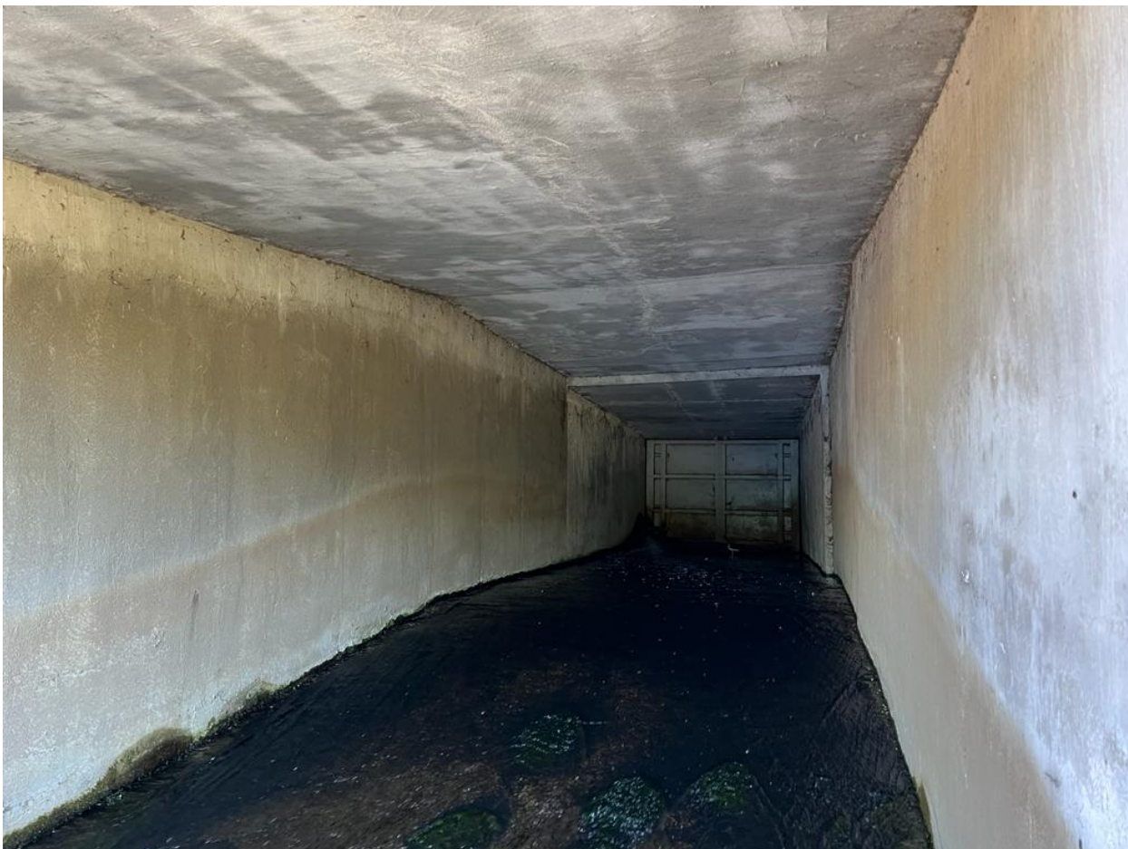
3. Внутренняя часть водослива.
