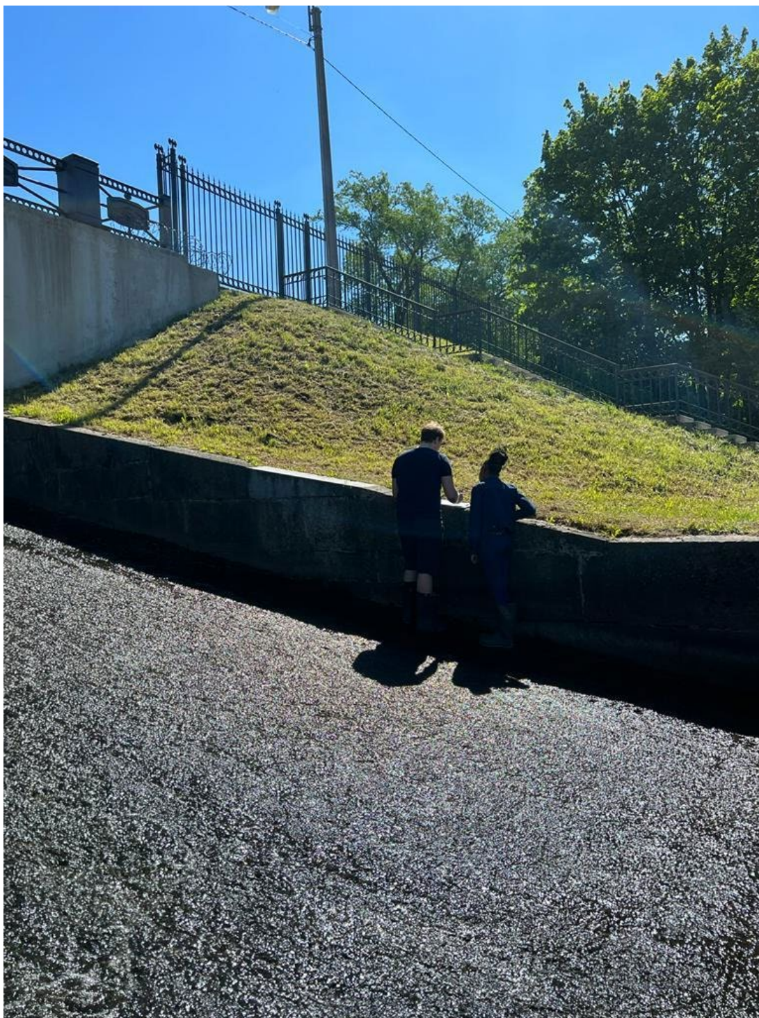
7. Ограждение верхнего бьефа и воссозданная решетка забора.
