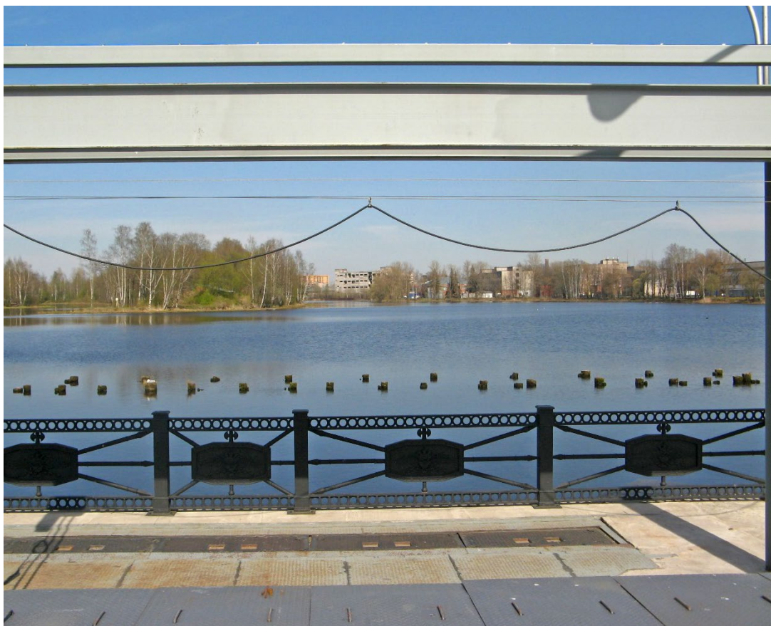
6. Вид с плотины «Гидрокомплекса б. Охтинского порохового завода» на водохранилище и восстановленное ограждение верхнего бьефа.
