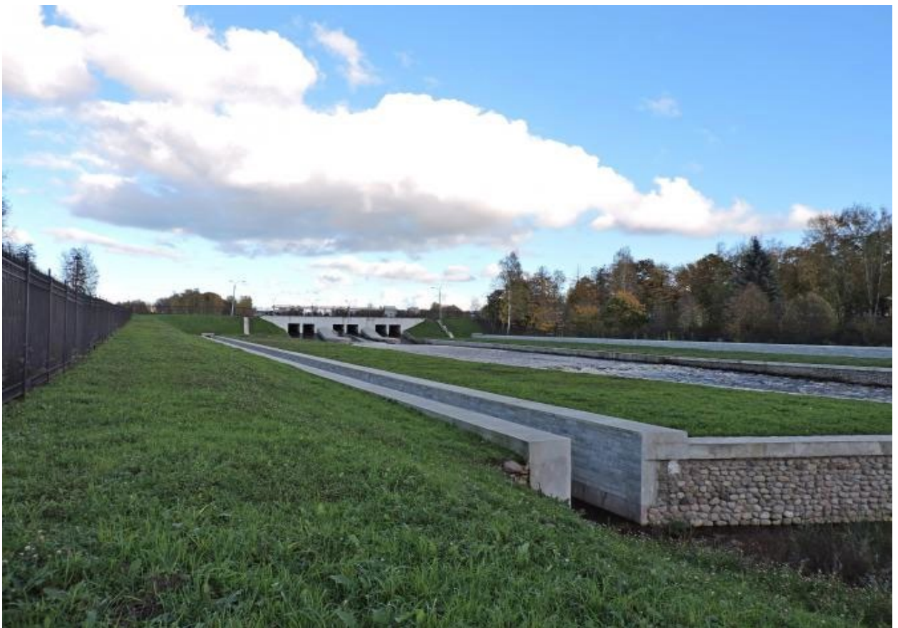
Илл. 20. Главная плотина Охтинских пороховых заводов, фото 2016 г.
