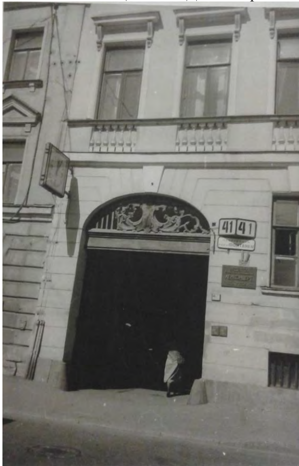
29. Дом Ильиных - О.А. Кочневой. Главный фасад. Фотография. 1988 г. Автор съемки: К.В. Овчинников. ЦГА КФФД СПб. Ар-212737.
