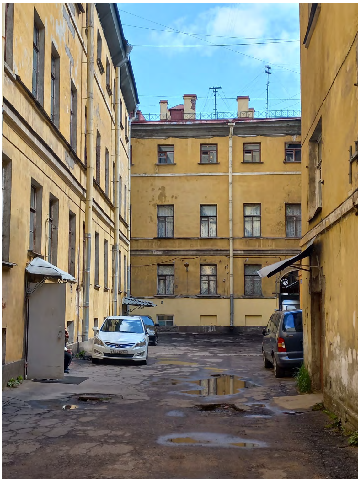
Фото 6. Территория внутреннего двора. Южная часть.
