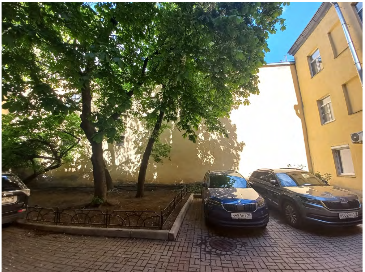
Фото 4. Фасад со стороны д. 43 по наб. р. Фонтанка.
