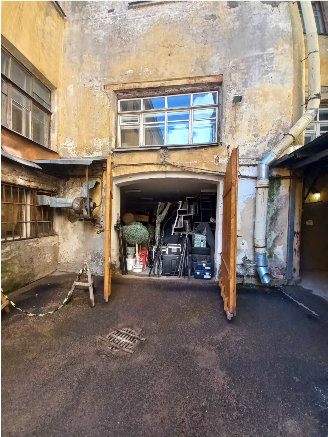
Фото 2. Здание литер Б. Северная часть дворовой территории. Вход в пом. №7 по проектной экспликации.
