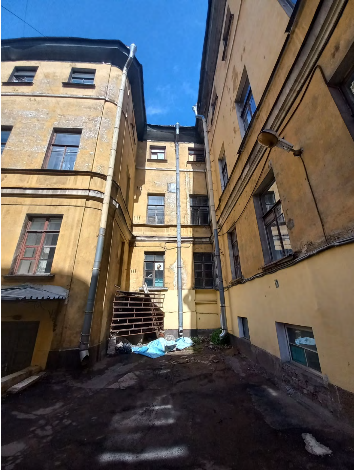
Фото 9. Фасад здания лит. А, южная часть.
