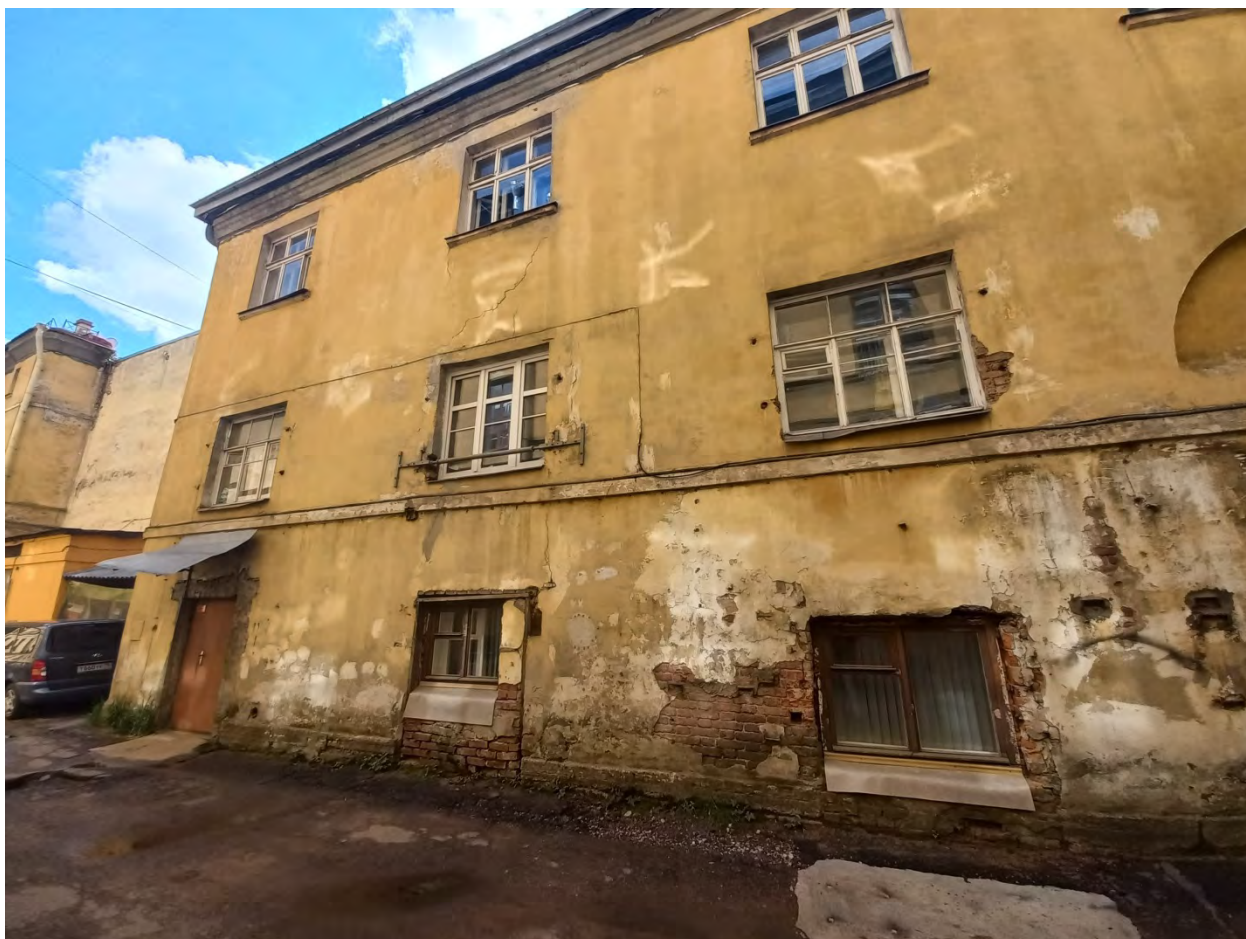
Фото 4. Фасад здания литер Б.
