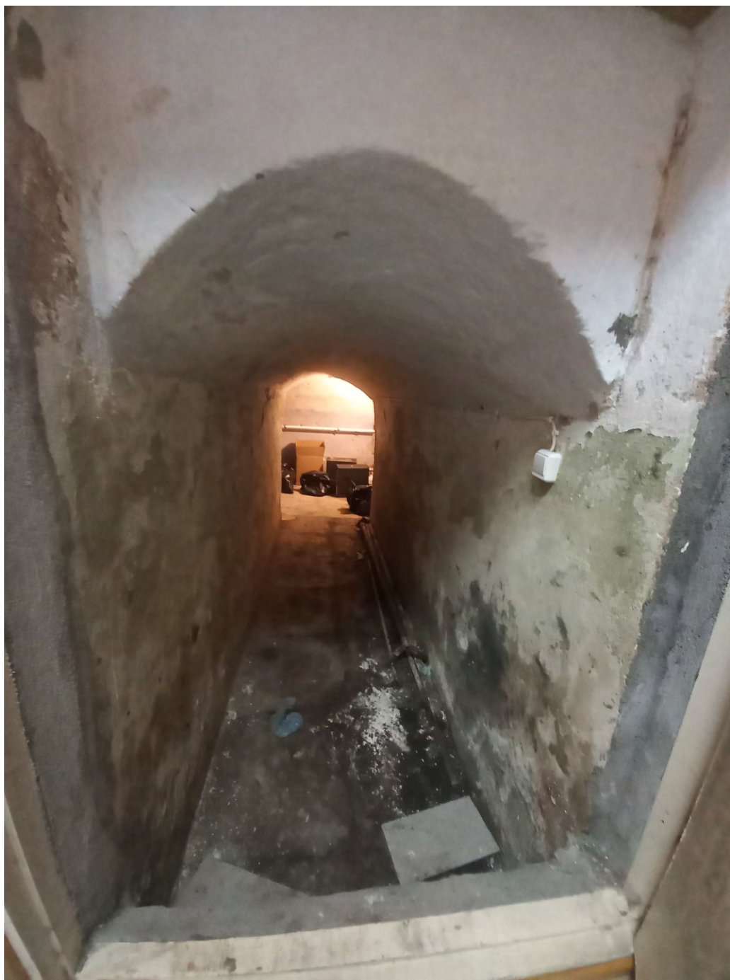
Фото 11. Вход в помещение 10.
