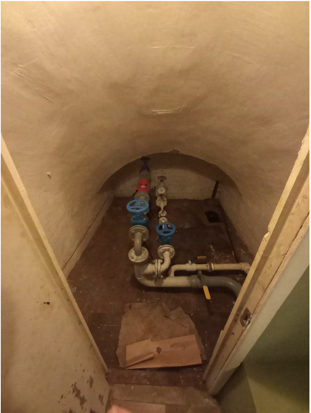
Фото 4. Помещение 6. Водомерный узел.
