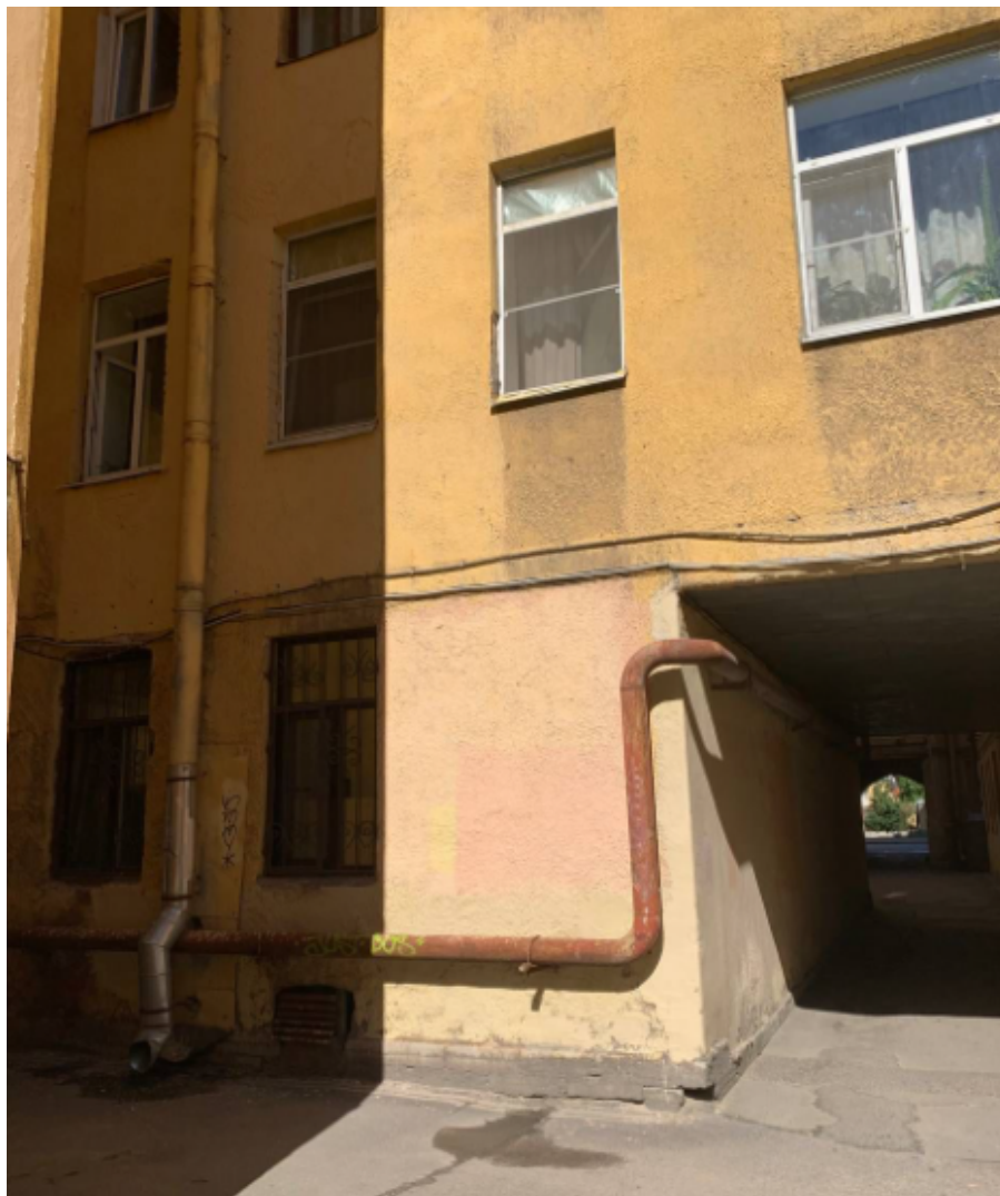
3. Фрагмент дворового фасада выявленного объекта культурного наследия «Дом Ф.В. Шеффера»
