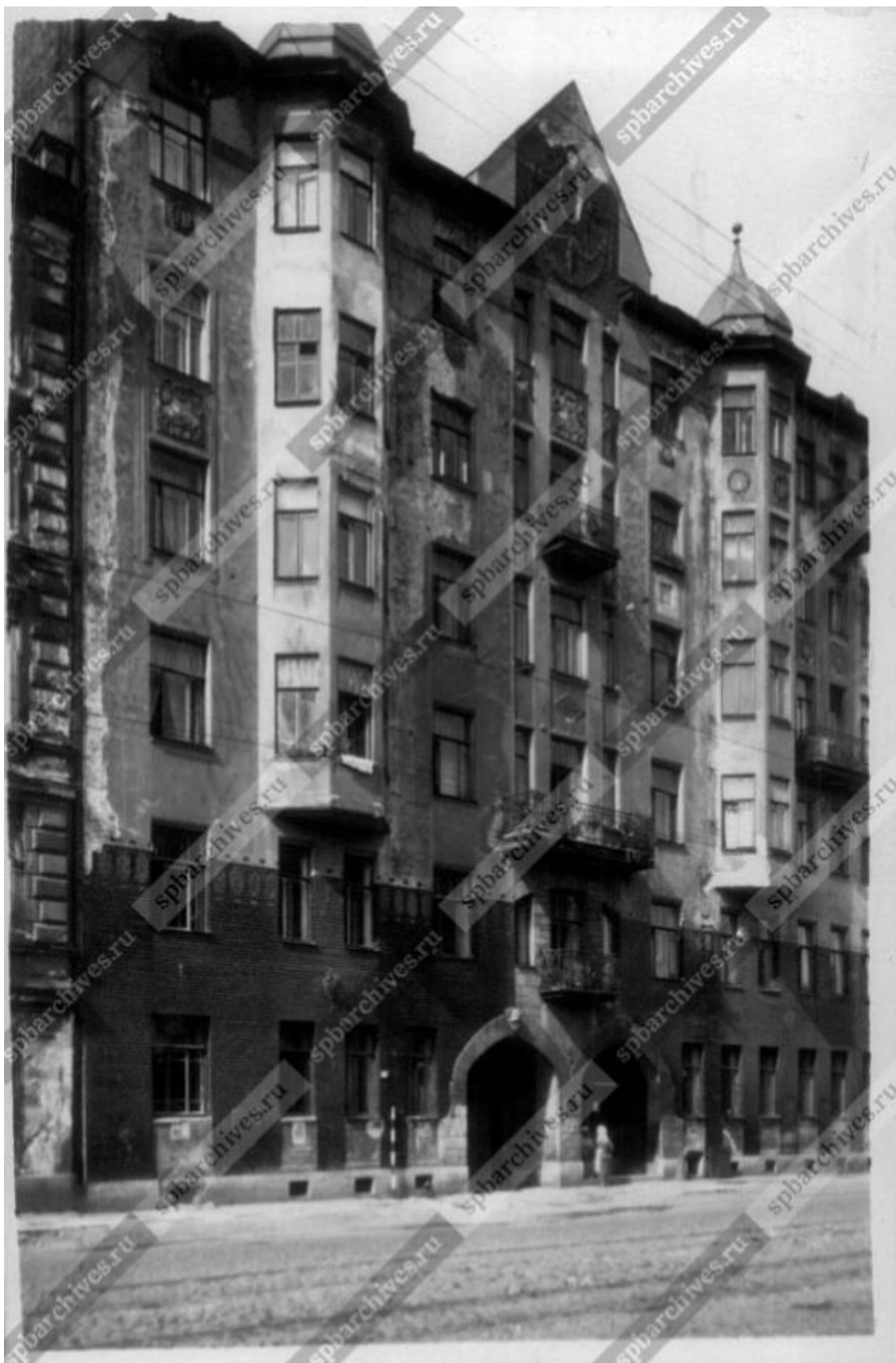
14. 9-я линия Васильевского острова. Фасад дома №58. Дата съёмки: 1960 г. ЦГАКФФД СПб Гр 74714
