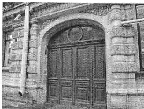
по шестой - седьмой световым осям фасада расположен воротный проезд с трехцентральной перемычкой, обрамленный профилированным наличником с волнотобразным замковым камнем с лепной гирляндой; проезд фланкирован рустованными полуколоннами; лепные композиции из виноградных листьев и витых лент - над тремя проемами;
