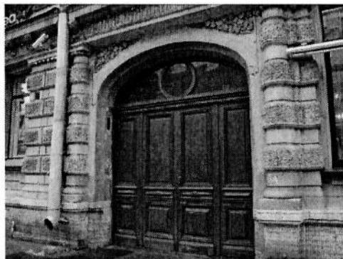
по шестой - седьмой световым осям фасада расположен воротный проезд с трехцентральной перемычкой, обрамленный профилированным наличником с волутообразным замковым камнем с лепной гирляндой; проезд фланкирован рустованными полуколоннами; лепные композиции из виноградных листьев и витых лент - над тремя проемами;
