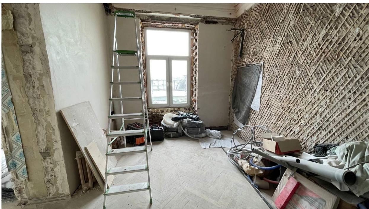
25. Фрагмент интерьера комнаты (помещение №5).
