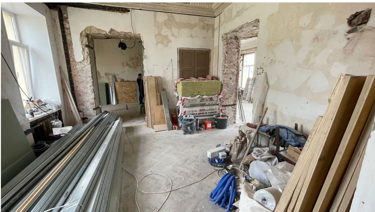
7. Фрагмент интеръера холла (помещение №2);
