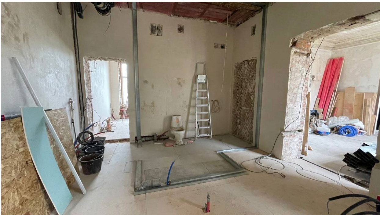
11. Фрагмент интерьера коридора и вид на санузел (помещение №9, 10 и 7);
