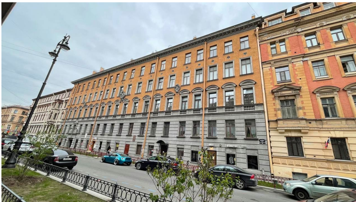
1. Фасад здания по Моховой улице;
