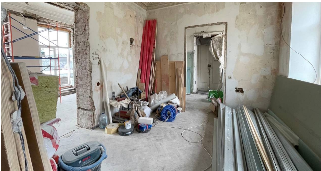
8. Фрагмент интеръера холла (помещение №2);
