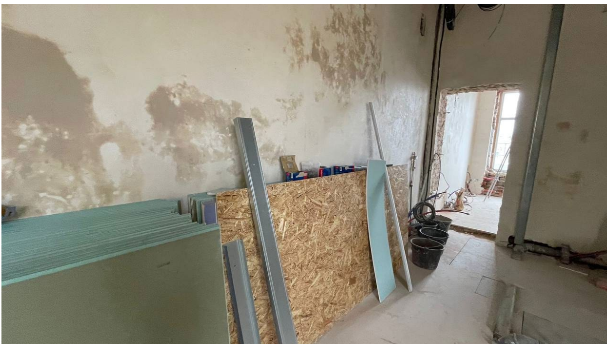
10. Вид на коридор (помещение №9);
