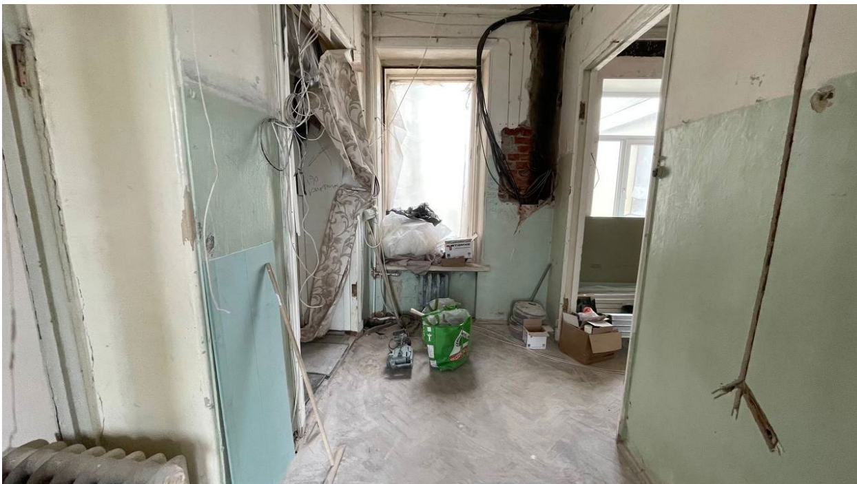
6. Фрагмент интеръера коридора (помещение №1);
