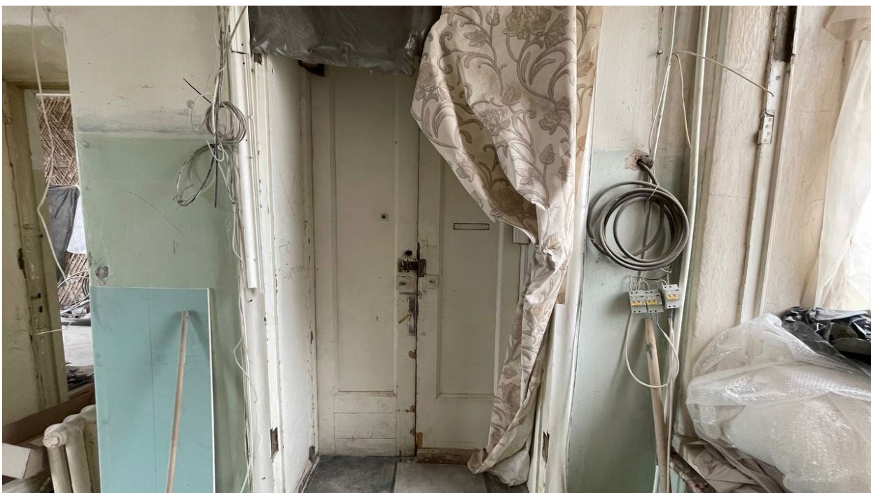
5. Вид на входную дверь в квартире №10;
