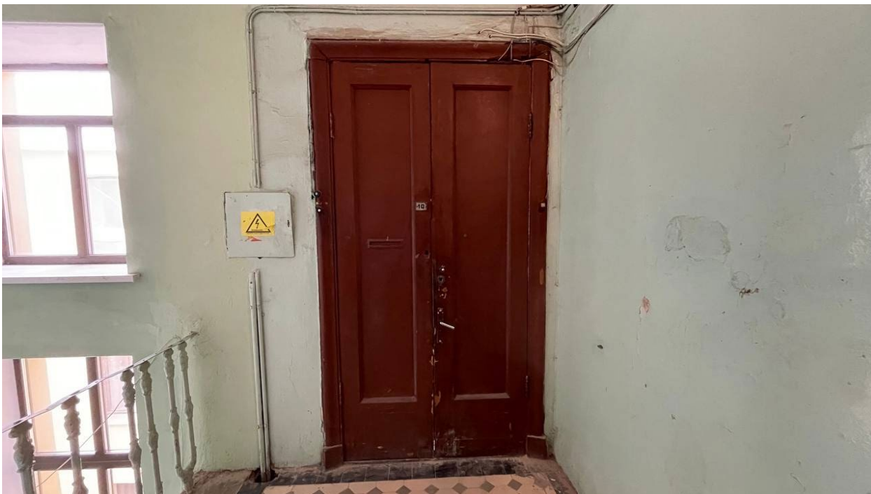
4. Вид на входную дверь квартиры №10;
