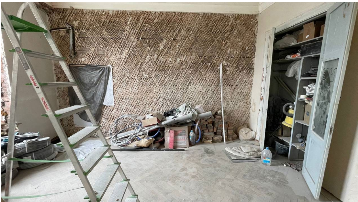
23. Фрагмент интерьера комнаты (помещение №5);
