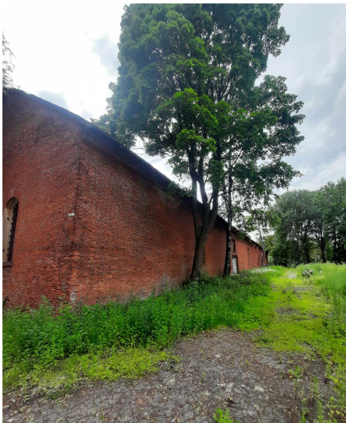
Фото 6 Фасад объекта культурного наследия федерального значения «Сарай (магазин) пенькового канатного завода»
