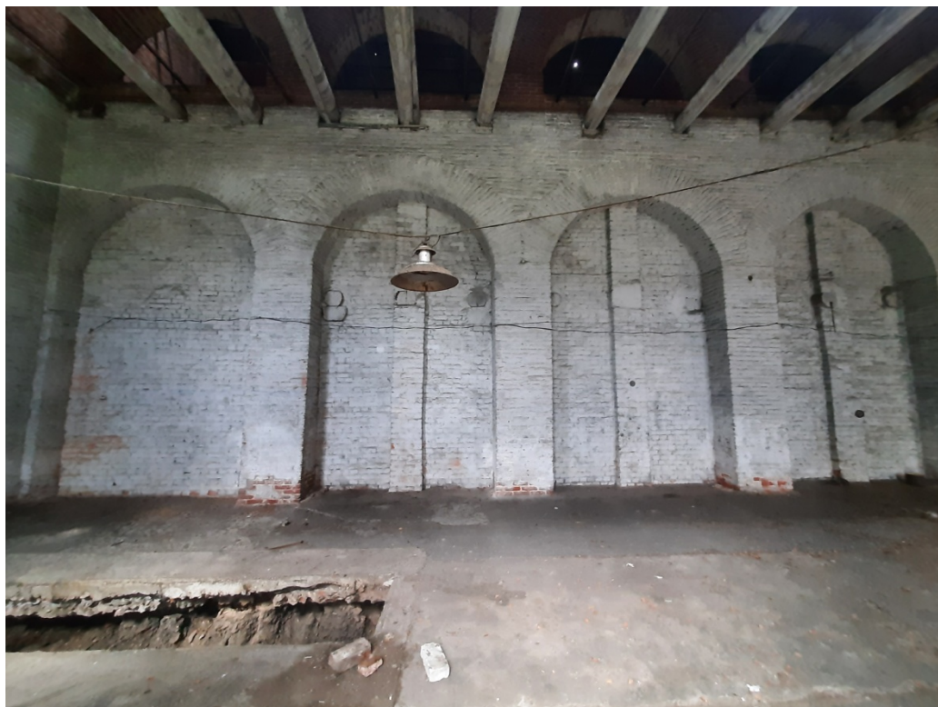
Фото 11 Интерьер объекта культурного наследия федерального значения «Сарай (магазин) пенькового канатного завода» (система кирпичных столбов и арок)
