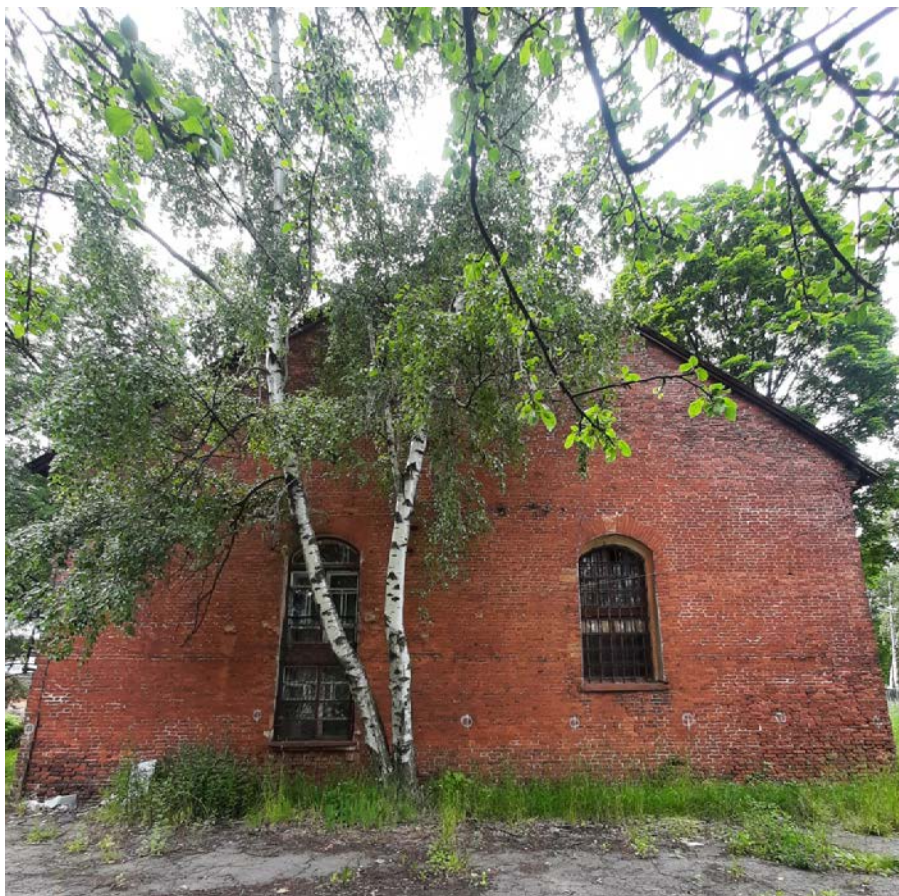
Фото 5 Фасад объекта культурного наследия федерального значения «Сарай (магазин) пенькового канатного завода»
