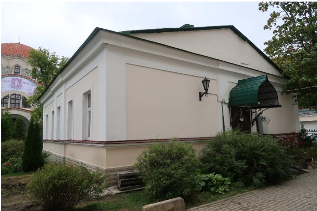
4. Объект культурного наследия федерального значения «Дом для приходящих богомольцев» по адресу: г. Санкт-Петербург, Московский проспект, д. 100, лит. Я, входящий в состав объекта культурного наследия федерального значения «Монастырь Воскресенский Новодевичий» по адресу: Санкт-Петербург, Московский проспект, дом 100, литеры А, Г, О, П, Р, С, Я, Московский проспект, дом 100, корпус 2. Вид на западный и южный фасады.
